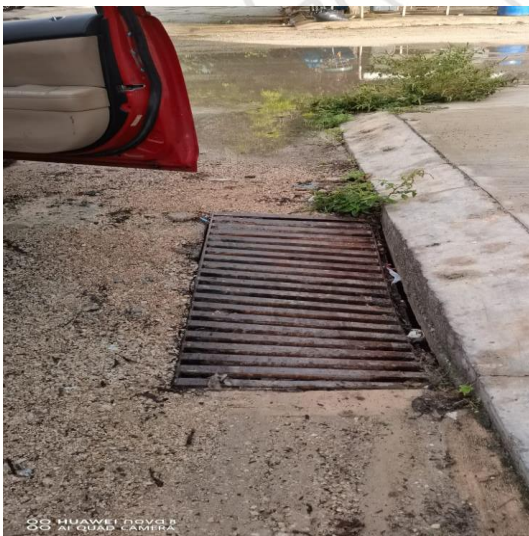
Limpieza de rejillas: Calle 7 sur entre 2 a oriente; fraccionamiento villas Tulum.
