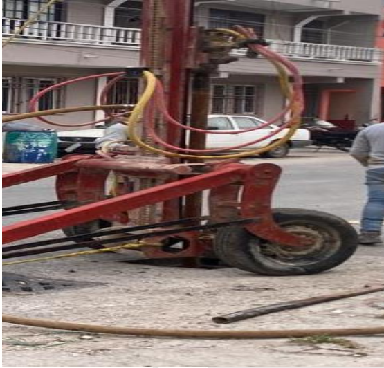
Desazolve de pozos Calle 4 oriente entre calle alfa norte; colonia centro.
