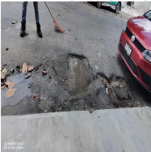
Limpeza de rejillas: Calle sol oriente entre calle centauro sur; colonia centro sur.
