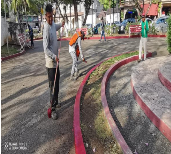
Pintura; Realización de pintura en las bases de las guarniciones del monumento de Benito Juárez parque dos aguas.
