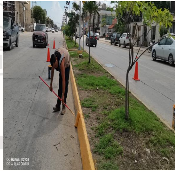
Pintura; Camellón central de la av. Tulum y sus laterales de la calle júpiter hasta calle alfa.
