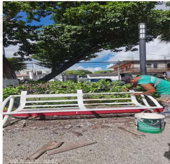
Pintura; Realización de pintura en las bases de las bancas del parque das aguas.
