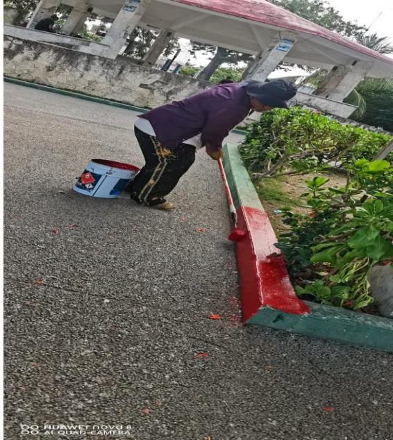
Pintura; Realización de pintura en las guarniciones del parque dos aguas.
