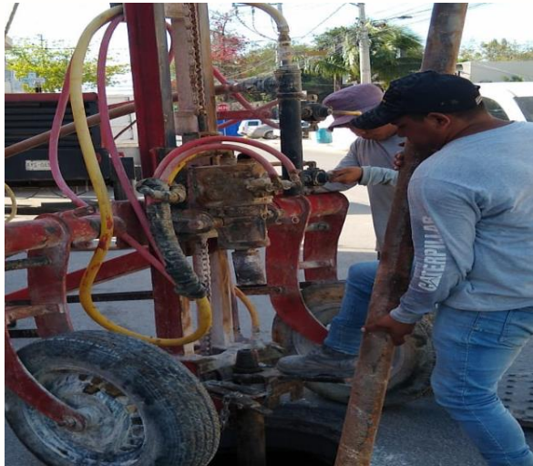
Desazolve de pozos Calle sol oriente entre calle escorpión; fraccionamiento huracanes.
