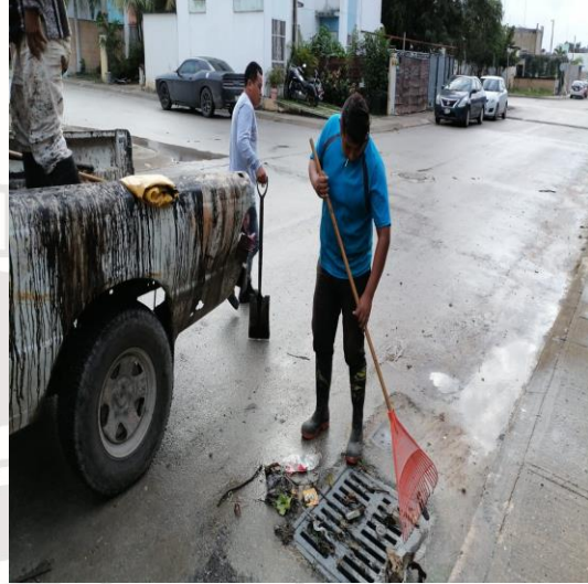
Limpieza de rejillas; Calle bulevar palmas Tulum; colonia palmas.
