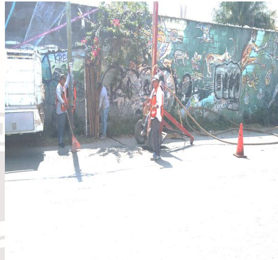
Desazolve de pozos Av. Kukulkán entre calle x-caret; colonia luna.
