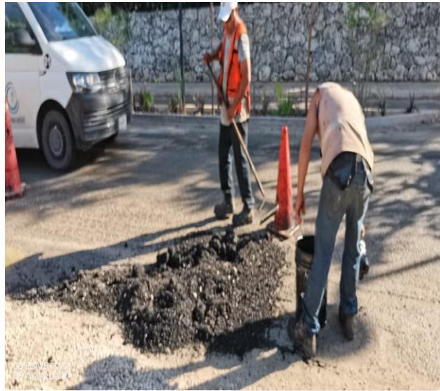
Bacheo: Av. coba entre aldea zama; fraccionamiento aldea zama.
