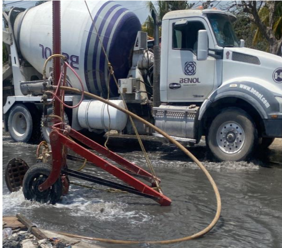
Desazolve de pozos Calle 4 oriente entre calle omega norte; colonia centro.
