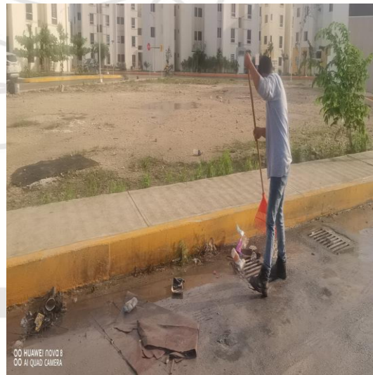
Limpieza de rejillas; Av. gema entre calle perla; fraccionamiento aldea Tulum.
