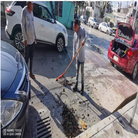
Limpieza de rejillas: Calle andrómeda oriente entre calle osiris sur; colonia centro sur.
