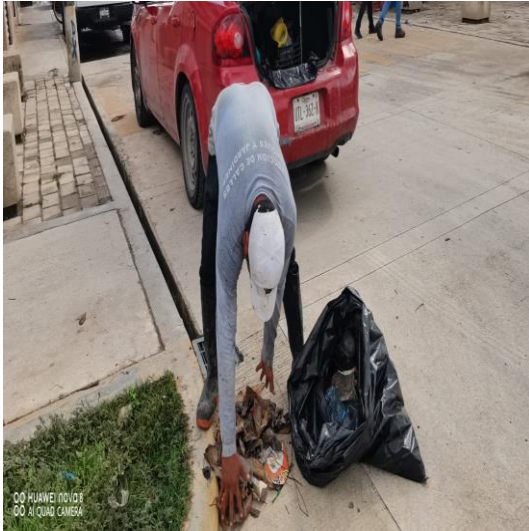
Limpieza de rejillas: Calle gama oriente entre calle osiris sur; colonia centro sur.
