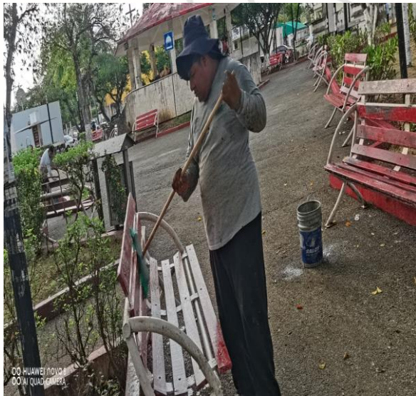
Pintura; Realización de pintura en las bases de las guarniciones del monumento de Benito Juárez parque dos aguas.
