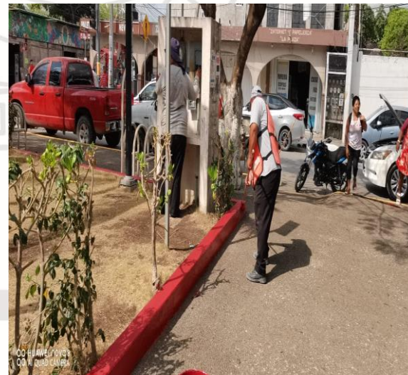
Pintura; Realización de pintura en las guarniciones del parque dos aguas.
