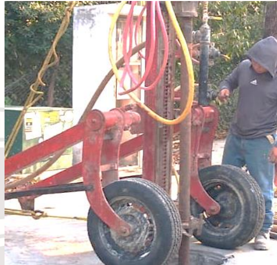
Desazolve de pozos Calle asteroides oriente entre calle centauro sur; colonia lak'iin.
