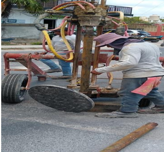
Desazolve de pozos Calle júpiter norte entre calle 2 poniente; colonia luna.
