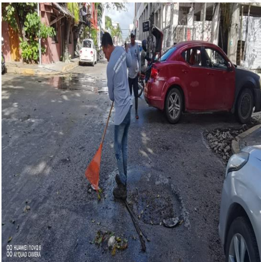
Limpieza de rejillas: Calle andrómeda oriente entre calle centauro sur; colonia centro sur.
