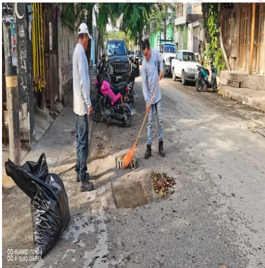
Limpieza de rejillas; Calle andrómada oriente entre la calle centauro sur; colonia centro sur.
