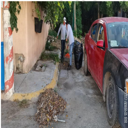
Limpeza de rejillas; Calle 2 bis oriente entre calle 2; fraccionamiento villas Tulum.
