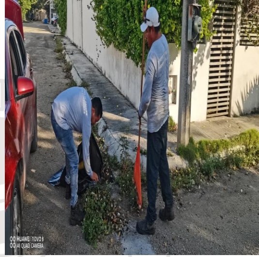
Limpeza de rejillas; Calle 5 sur entre calle 2 oriente y la calle 2; fraccionamiento villas Tulum.
