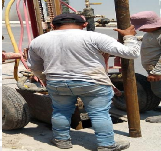
Desazolve de pozos Calle 2 oriente entre calle beta norte y calle sagitario oriente; colonia centro.
