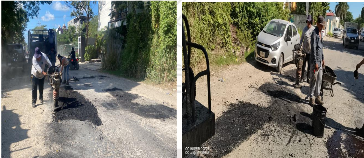
Bacheo: Calle sagitario oriente entre calle géminis norte y av. satélite norte; colonia centro.
