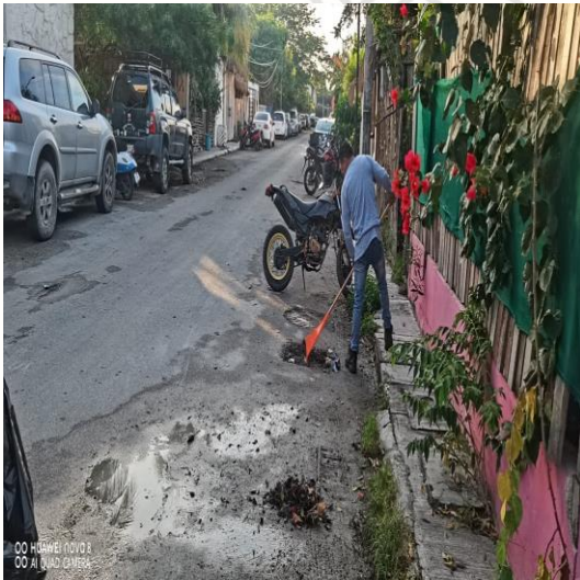
Limpieza de rejillas; Calle 15 entre calle boca paila y calle 4 oriente; colonia ejido.
