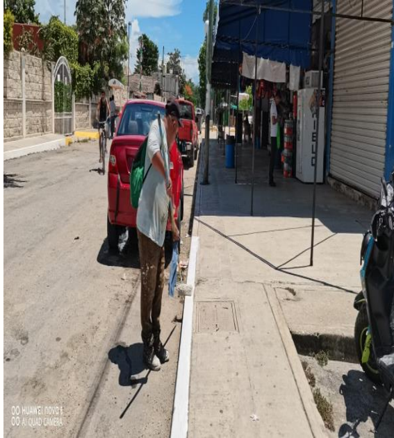
Pintura; Calle alfa entre av. Tulum y la calle mercurio.
