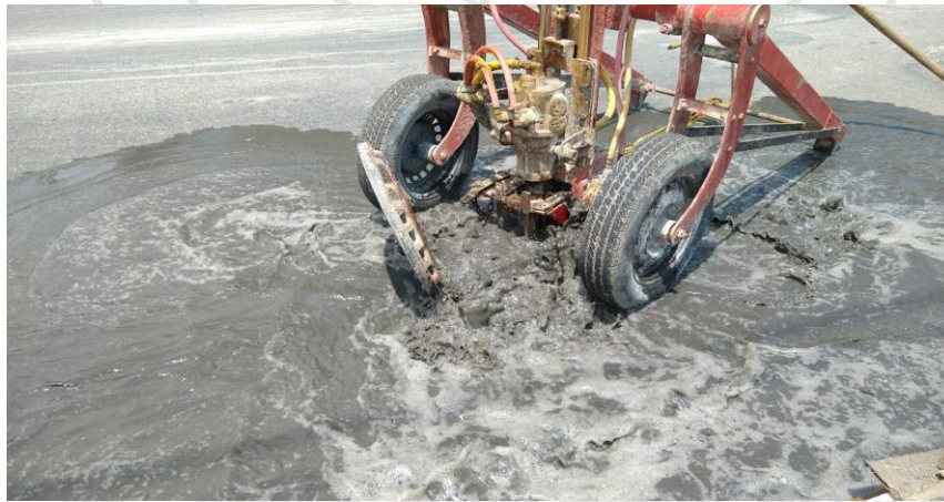
Desazolve de pozos Calle beta entre calle 2 oriente; colonia centro.
