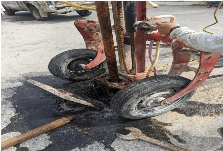
Desazolve de pozos Calle gama oriente entre calle centauro sur; colonia lak'iin.
