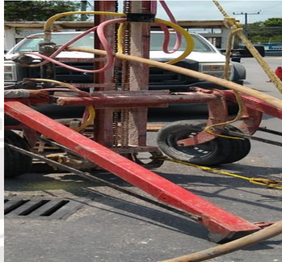
Desazolve de pozos Calle 2 poniente entre calle osiris; colonia centro.
