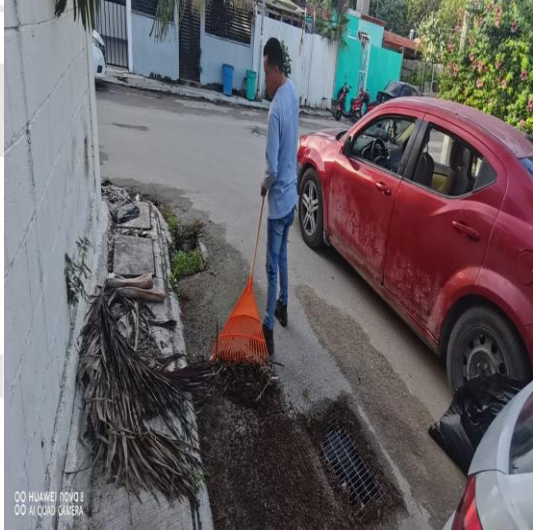
Limpeza de rejillas; Calle 17 entre calle 4 oriente y calle 2 bis oriente; fraccionamiento villas Tulum.
