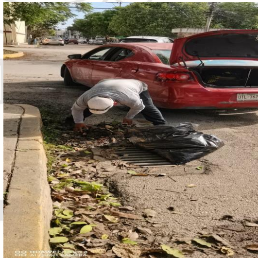
Limpieza de rejillas: Calle sol oriente entre la calle escorpión sur y la calle libra sur; fraccionamiento guerra de castas.
