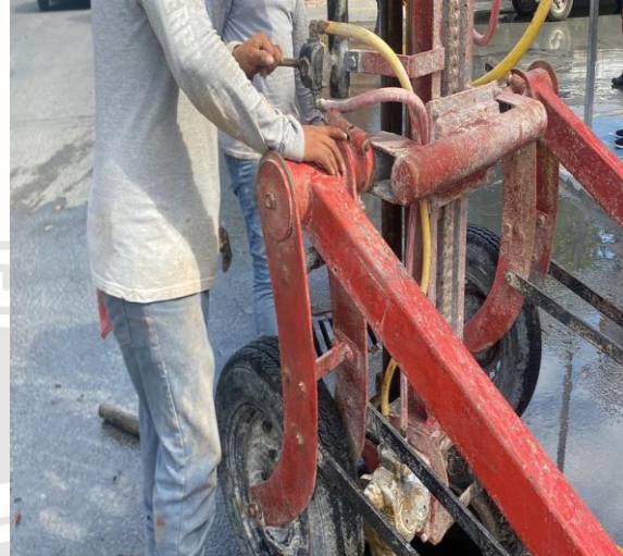
Desazolve de pozos Calle huracán paulina entre calle huracán rossana; fraccionamiento huracanes.
