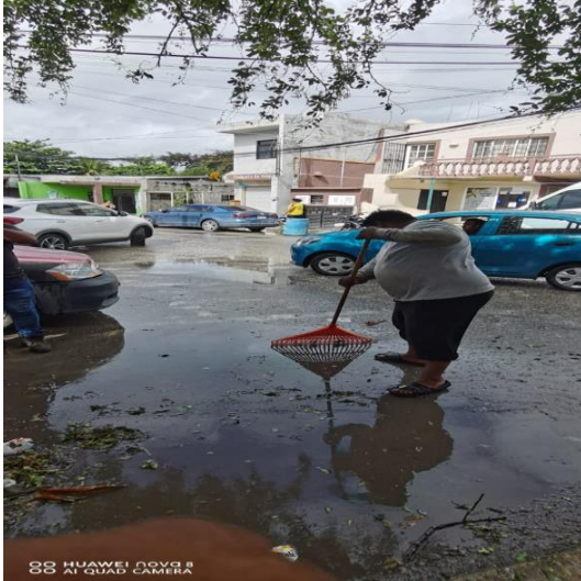
Limpieza de rejillas: Calle omega sur entre la calle sol orientado; colonia centro sur.
