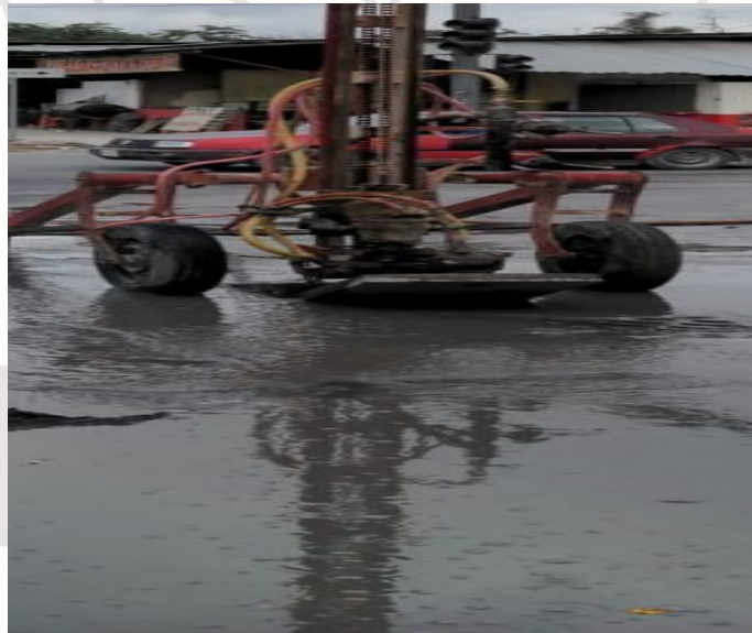
Desazolve de pozos Calle 2 oriente entre calle orión; colonia centro.
