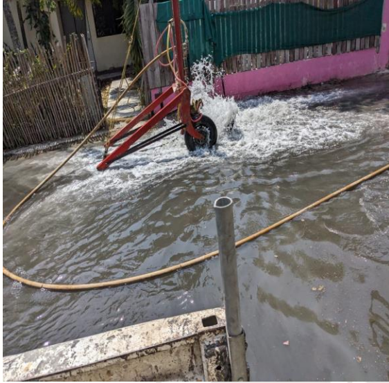
Desazolve de pozos Calle 15 entre calle 4 oriente; fraccionamiento villas Tulum.
