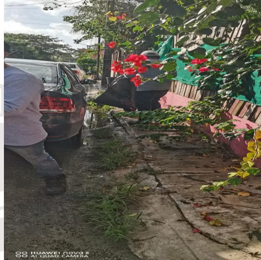
Limpieza de rejillas: Calle 4 oriente entre calle 15; fraccionamiento villas Tulum.
