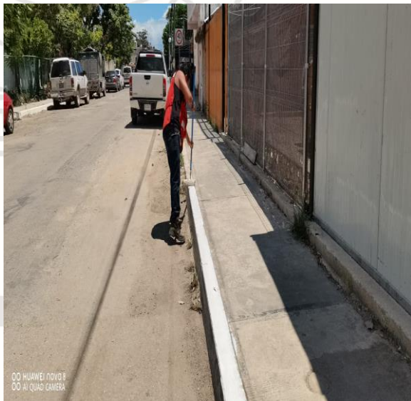
Pintura; Calle alfa entre av. Tulum y la calle mercurio.
