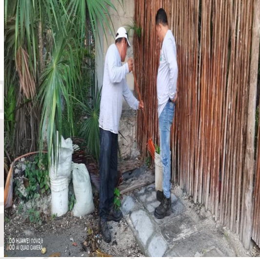
Limpieza de rejillas; Calle 11 entre xcelito entre calle 2 bis oriente; fraccionamiento villas Tulum.
