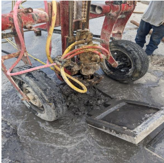
Desazolve de pozos Calle tun-k'ul entre calle beta norte y av. ook-k'ot; colonia mayapax.
