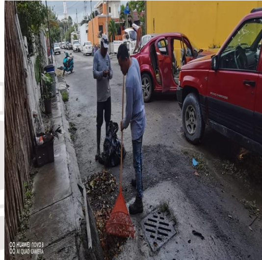
Limpieza de rejillas: Calle sol oriente entre calle libra sur; colonia centro sur.
