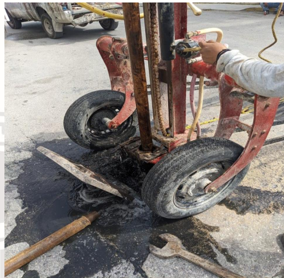
Desazolve de pozos Calle bubul-lek entre calle kii's; colonia mayapax.
