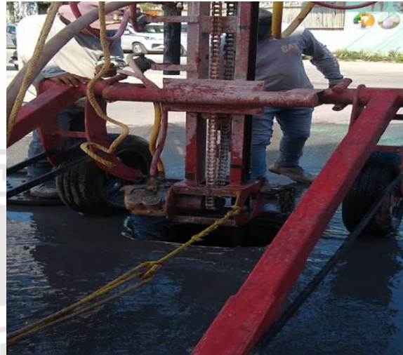
Desazolve de pozos Calle polar oriente entre calle centauro norte; colonia centro.
