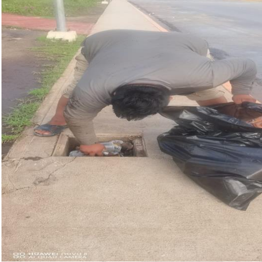
Limpieza de rejillas; Calle cuarzo entre av. gema; fraccionamiento aldea Tulum.
