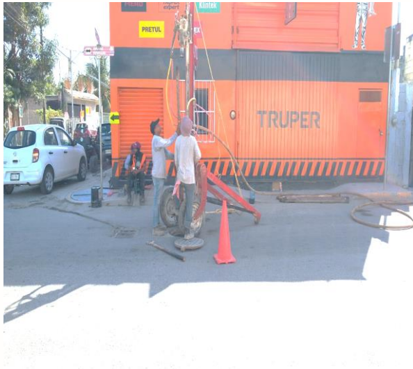
Desazolve de pozos Av. Kukulkán entre calle mercurio poniente; colonia maya.
