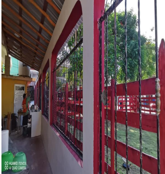
Pintura; Realización de pintura en la barda de la iglesia maya.
