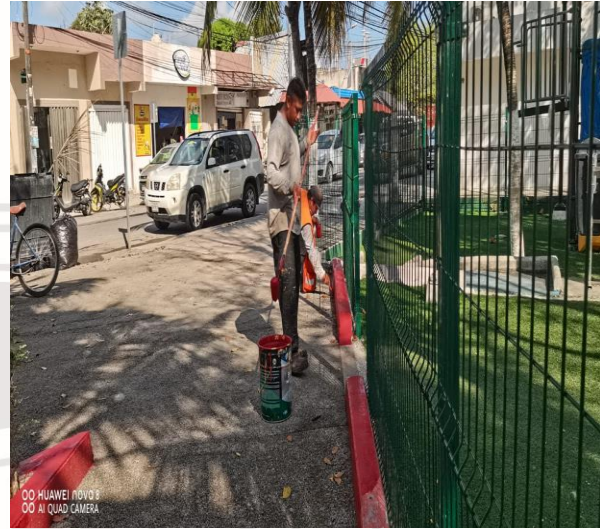
Pintura; Realización de pintura en guarniciones del parque dos aguas.
