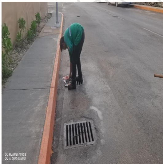
Limpieza de rejillas; Calle cuarzo entre calle la perla; fraccionamiento aldea Tulum.
