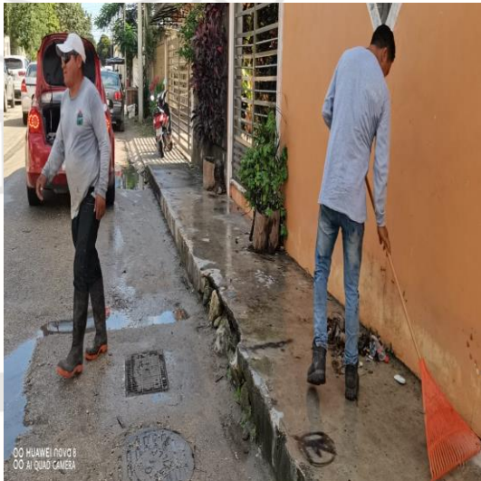
Limpieza de rejillas: Calle mercurio poniente entre la calle luna sur; colonia luna.
