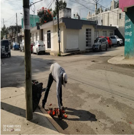
Limpieza de rejillas: Calle andrómada oriente entre la calle beta sur; colonia centro sur.
