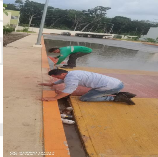
Limpieza de rejillas; Calle cuarzo; fraccionamiento aldea Tulum.
