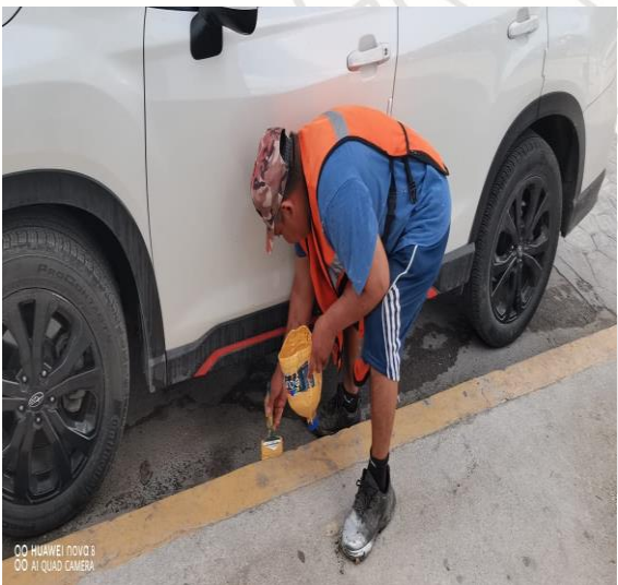
Pintura; Realización de pintura en las guarniciones del parque dos aguas.
