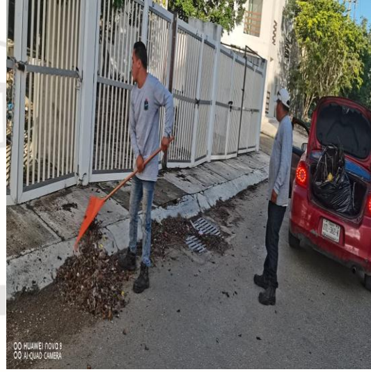
Limpieza de rejillas; Calle 5 sur entre calle 4 poniente y la calle 2 oriente; fraccionamiento villas Tulum.
