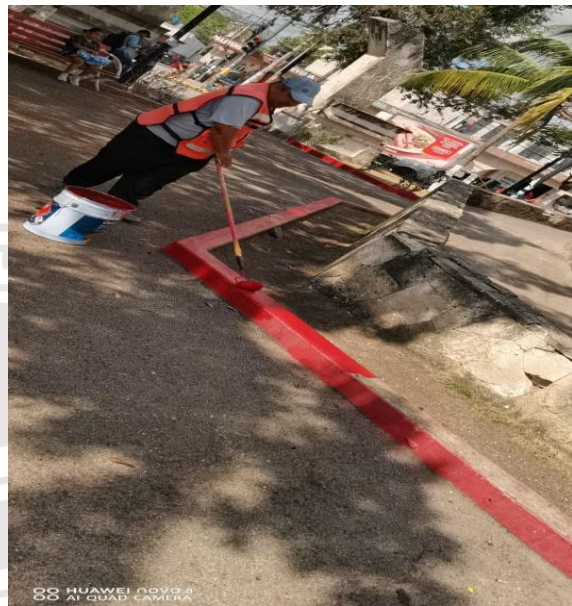
Pintura; Realización de pintura en guarniciones del parque dos aguas.
