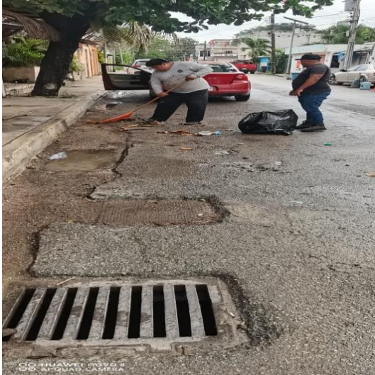
Limpieza de rejillas; Calle andrómada oriente entre calle osiris sur; colonia centro sur.
