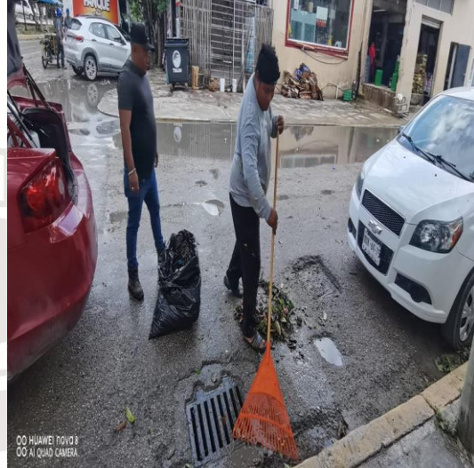
Limpieza de rejillas; Calle andrómeda oriente entre av. satélite; colonia centro sur.
