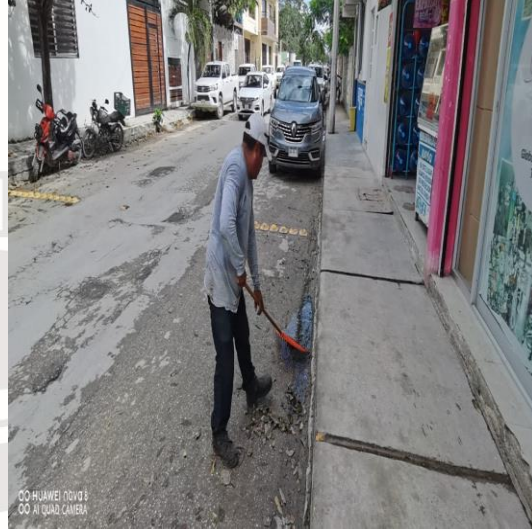
Limpieza de rejillas: Calle géminis sur entre calle 4 oriente; colonia centro norte.
