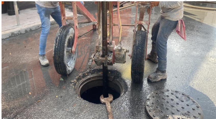
Desazolve de pozos Calle huracán irene entre calle huracán mitch; fraccionamiento huracanes.
