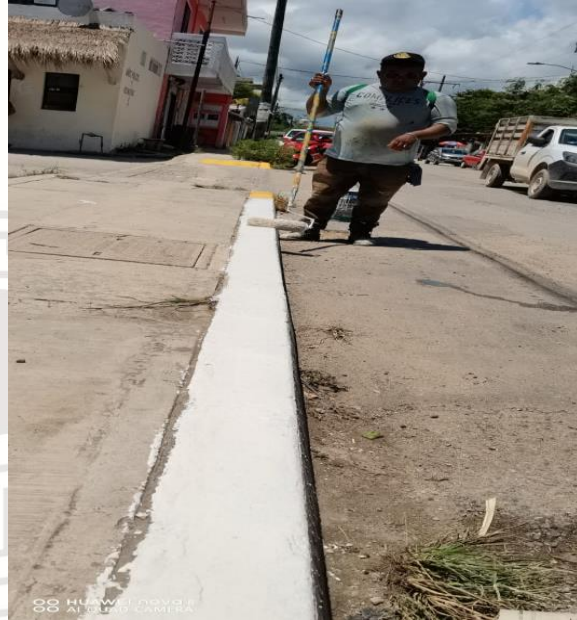
Pintura; Calle alfa entre av. Tulum y la calle mercurio.
