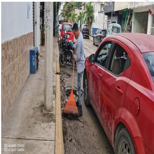
Limpieza de rejillas: Calle 4 oriente entre calle centauro sur; colonia mayapax.
