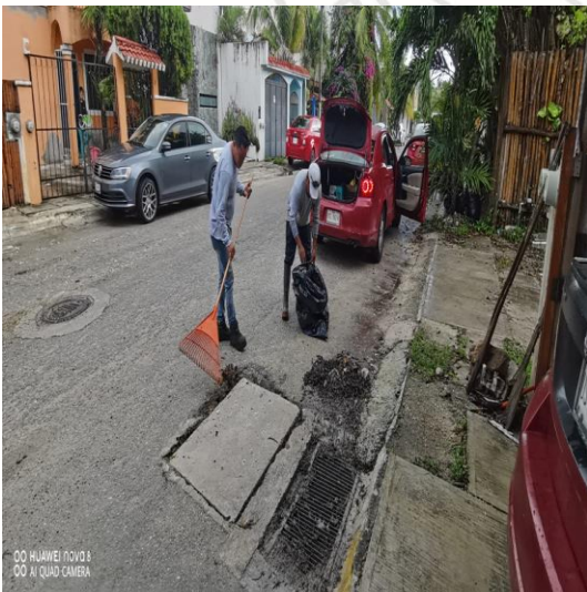
Limpieza de rejillas: Calle 2 bis oriente entre calle 3 sur; fraccionamiento villas Tulum.
