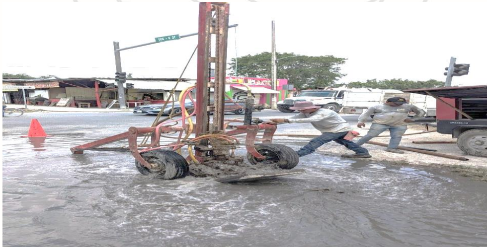
Desazolve de pozos Calle ook-k'ot entre calle osiris norte; colonia ejido norte.
