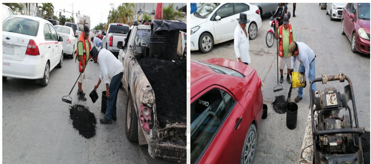
Bacheo: Av. Tulum entre av. Kukulkán; colonia centro.
