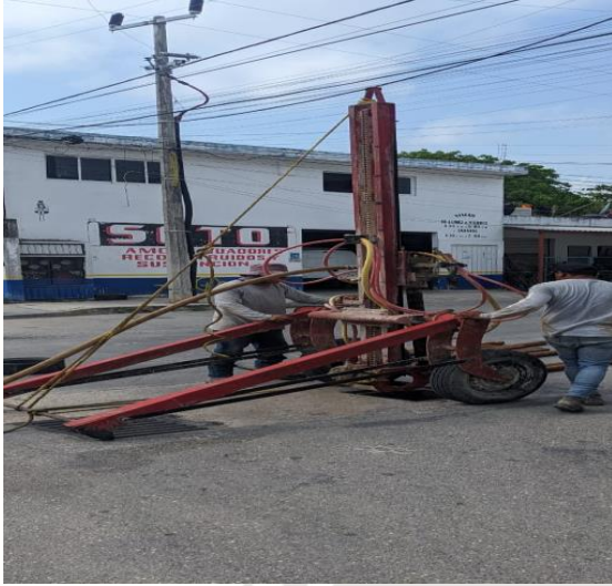
Desazolve de pozos Calle gama oriente entre calle beta sur; colonia lak'iin.
