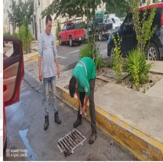
Limpieza de rejillas; Calle gema; fraccionamiento aldea Tulum.
