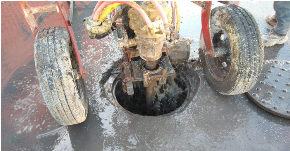
Desazolve de pozos Calle 4 oriente entre calle beta; colonia centro.
