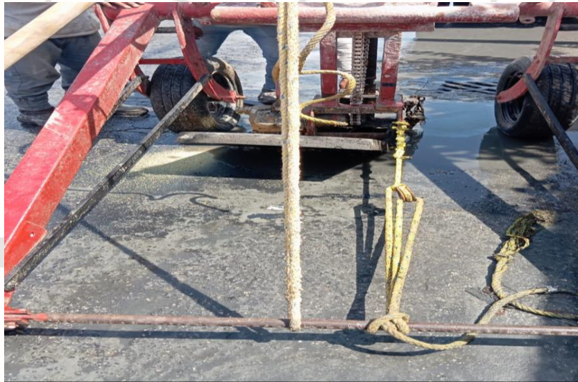
Desazolve de pozos Calle chemuyil entre calle 2 oriente; fraccionamiento villas Tulum.
