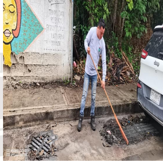
Limpieza de rejillas: Calle 3 sur entre calle 2 oriente; fraccionamiento villas Tulum.
