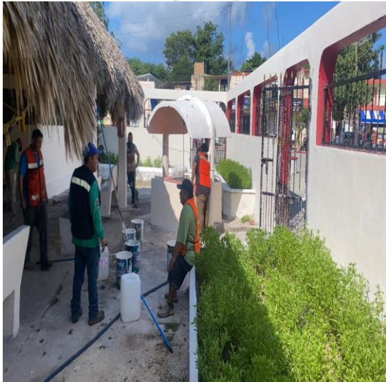
Pintura; Realización de pintura en la barda de la iglesia maya.
