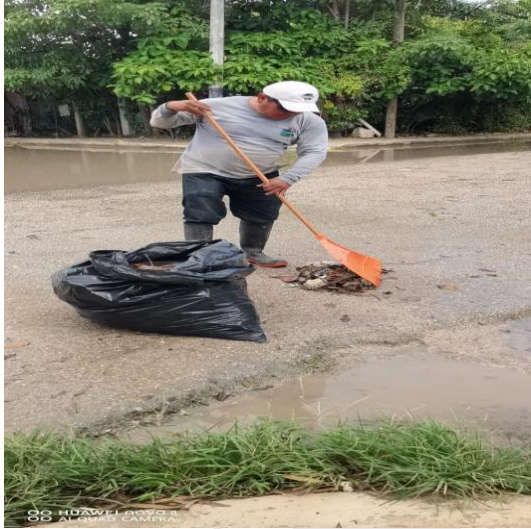
Limpeza de rejillas: Calle 17 entre calle 2 bis oriente; fraccionamiento villas Tulum.
