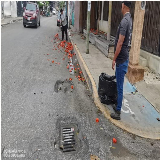
Limpieza de rejillas; Calle andrómada oriente entre calle beta sur; colonia centro sur.
