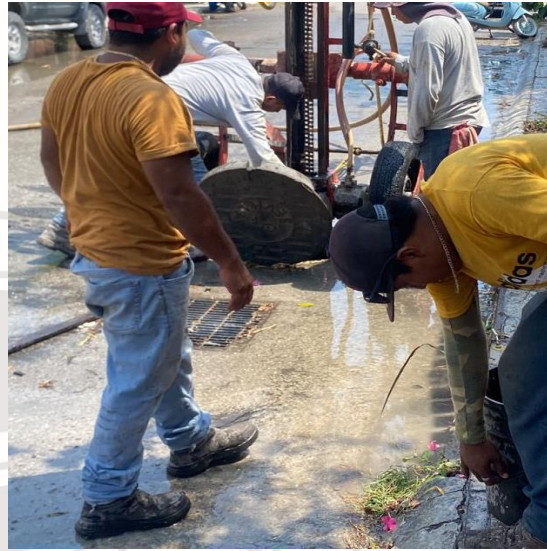
Desazolve de pozos Calle chemuyil entre calle 4 oriente; fraccionamiento villas Tulum.
