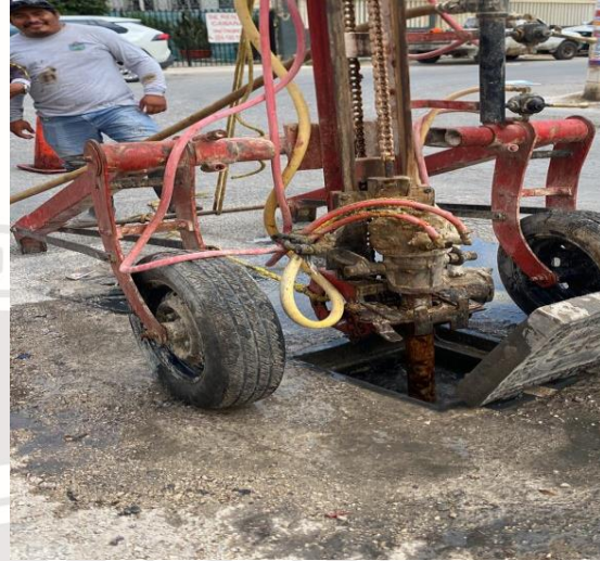
Desazolve de pozos Calle tun-kul entre calle osiris norte; colonia mayapax.
