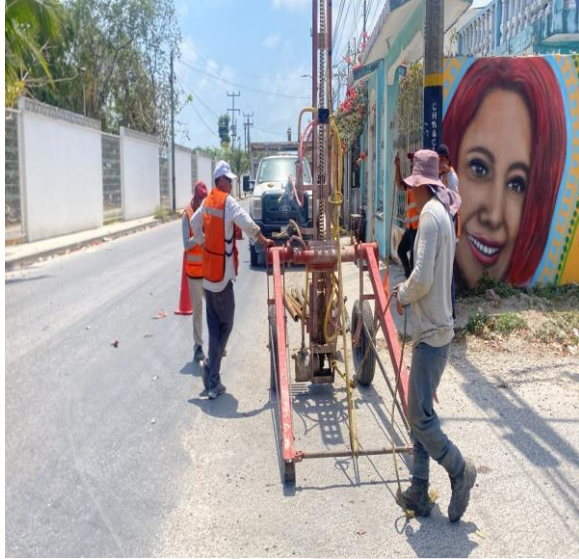
Desazolve de pozos Av. Kukulkán entre calle chacmool; colonia ejido norte.
