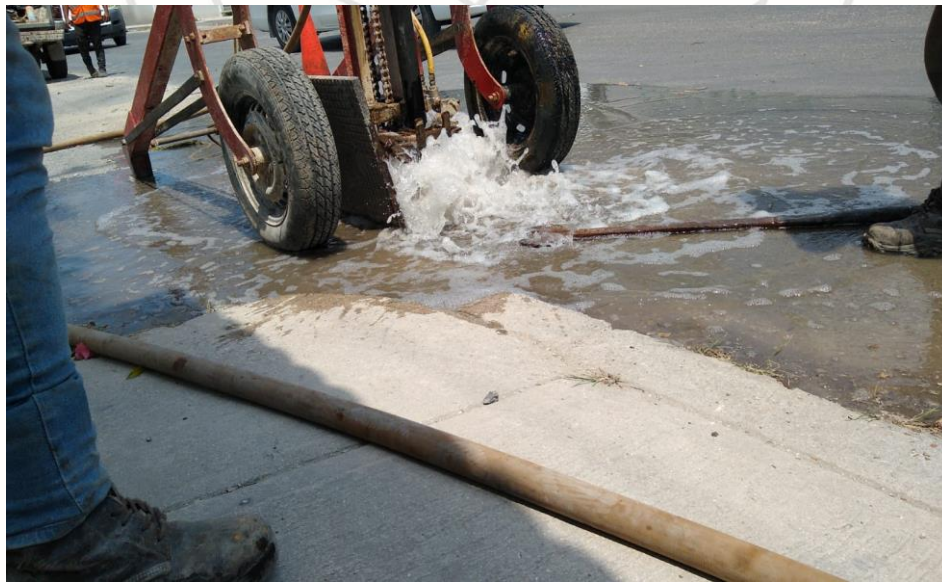
Desazolve de pozos Calle 4 oriente entre calle alfa norte y calle omega norte; colonia centro.
