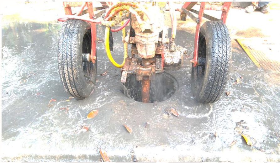
Desazolve de pozos Av. satélite entre calle polar oriente y calle sagitario; colonia cetro.
