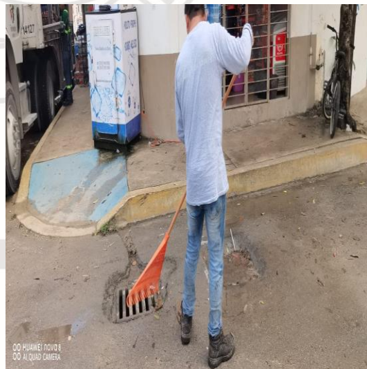
Limpieza de rejillas: Calle neptuno oriente entre la calle centauro sur; colonia centro sur.
