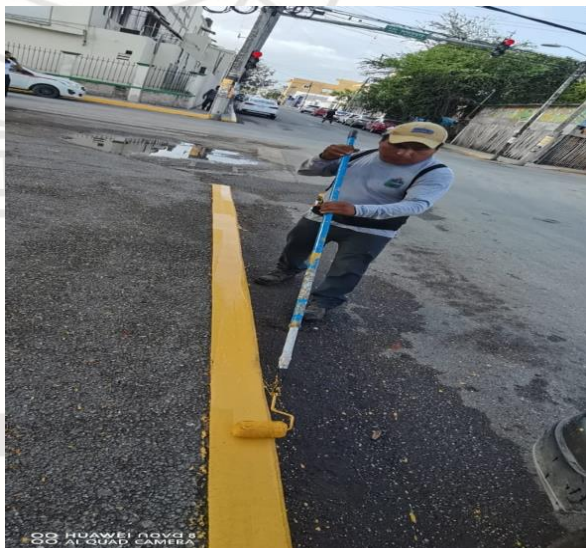
Pintura; Realización de pintura en guarniciones del parque dos aguas.
