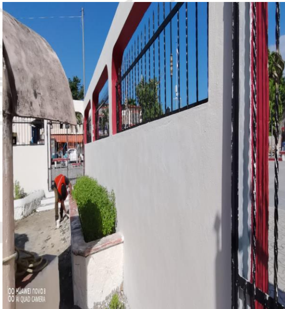
Pintura; Realización de pintura en la barda de la iglesia maya.
