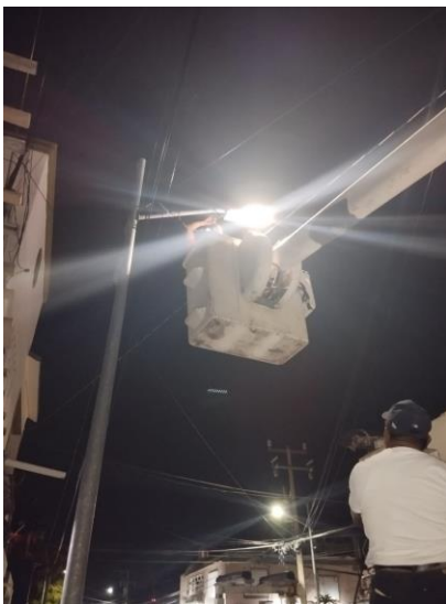
CAMBIO DE LUMINARIAS; COLONIA MAYAPAX, AV. SATELITE ESQ C. 2 OTE.
