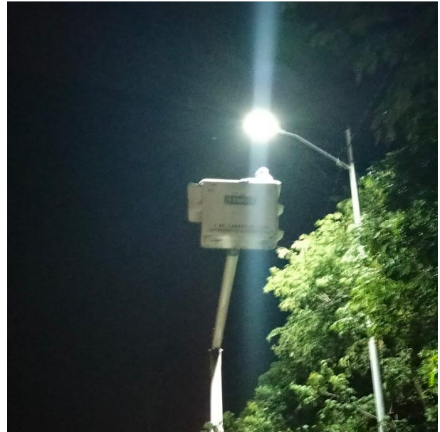
REPOSICIÓN DE 3 LUMINARIAS; CALLE 2 NORTE, FRACC. YA'AX TULUM.
