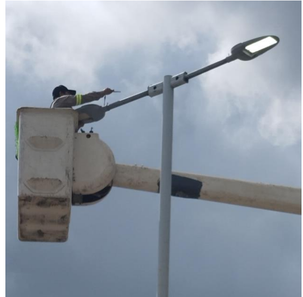
CAMBIO DE LAMPARAS OBSOLETAS POR NUEVAS TIPO LED, AV. TULUM, COL. CENTRO.
