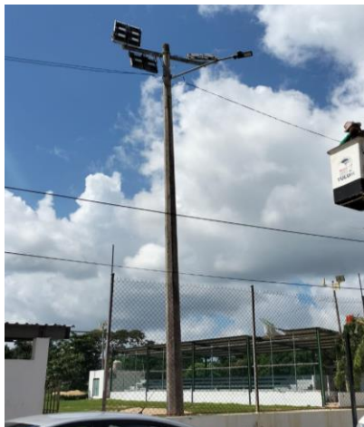
CAMBIO DE 3 LUMINARIAS; POBLADO DE CHEMUYIL (CAMPO)
