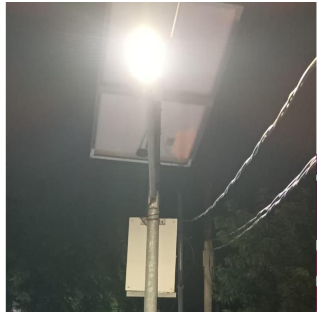
CAMBIO DE LUMINARIAS QUEMADAS POR NUEVAS; CALLE 2 PONIENTE, COL. CENTRO.
