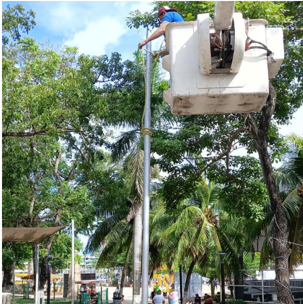
INSTALACIÓN DE POSTES Y LAMPARAS PUNTA DE POSTE; PARQUE DOS AGUAS, COL. CENTRO.
