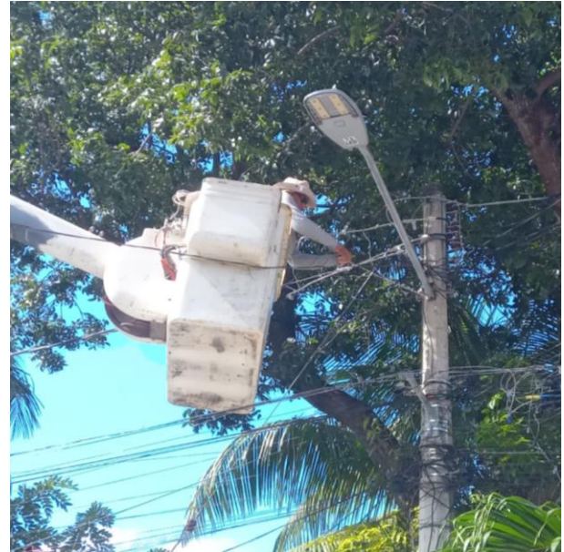
RECONEXIÓN DE LUMINARIA SULFATADA; CALLE SATURNO PONIENTE, COL. CENTRO.
