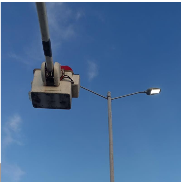
CAMBIO DE LUMINARIAS OSBOLETAS POR LED DE 160 WATTS; AV. TULUM, COL. CENTRO.
