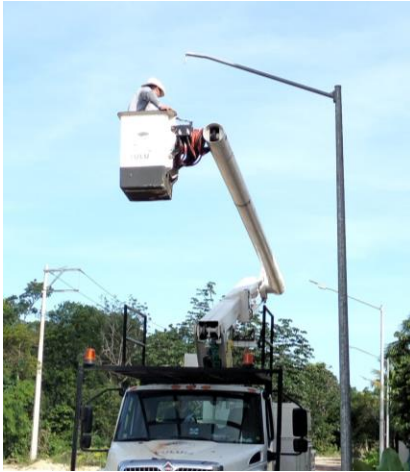
CAMBIO DE 6 LUMINARIAS; COLONIA VILLA HAVEN, CALLE VARIOS PUNTOS.
