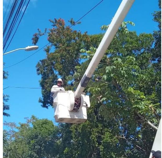
RECONEXIÓN DE LINEAS SULFATADAS; CALLE ASUNCIÓN, COL. VELETA
