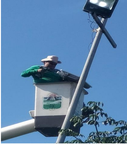
REHABILITACIÓN DE REFLECTOR; POBLADO DE CHEMUYIL
