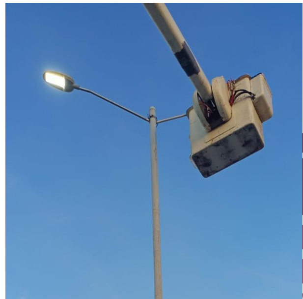
CAMBIO DE LUMINARIAS OSBOLETAS POR LED DE 160 WATTS; AV. TULUM, COL. CENTRO.
