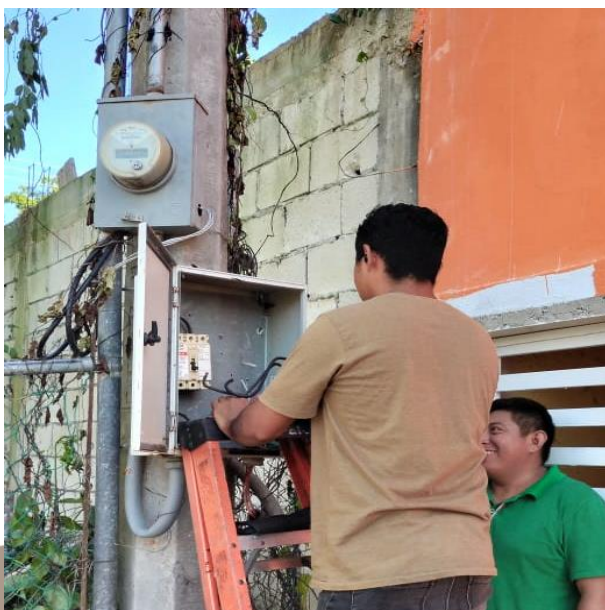
CAMBIO DE CONTACTOR PARA AUTOMATIZAR; FRACC. VILLAS TULUM
