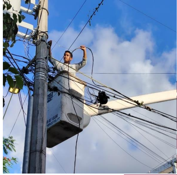
SE TENSIONAN LINEAS AEREAS PARA LIMENTAR LUMINARIAS; FRACC. VILLAS TULUM.
