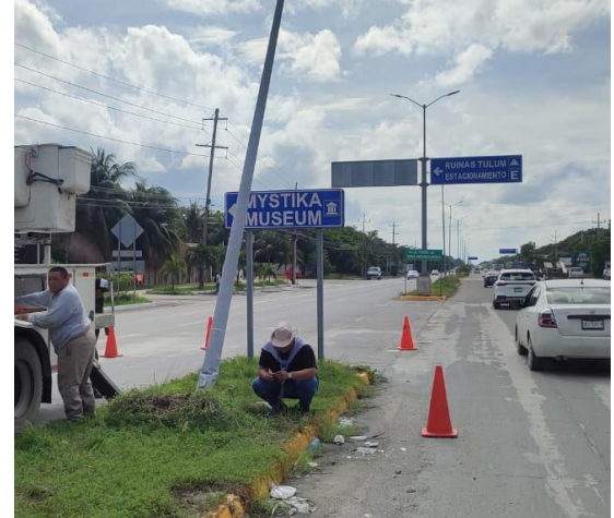
RETIRO DE POSTE CHOCADO EN AV. TULUM POR LAS RUINAS.
