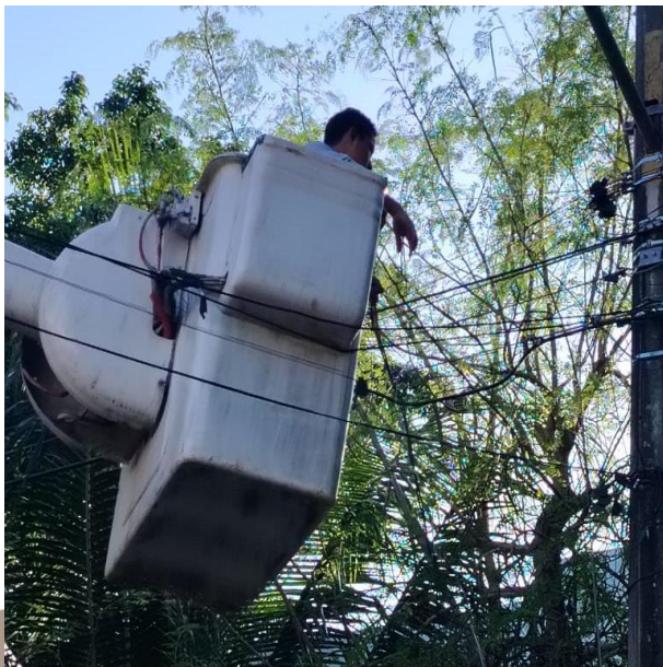
SE TENSIONAN LINEAS AEREAS PARA LIMENTAR LUMINARIAS; FRACC. VILLAS TULUM.
