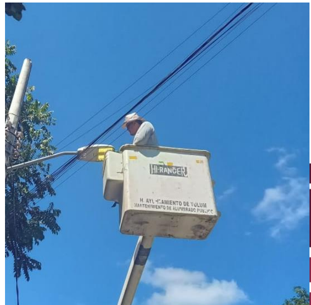
CAMBIO DE FOTOCELDAS OSBOLETAS POR NUEVAS; CALLE ASUNCIÓN, COL. VELETA.
