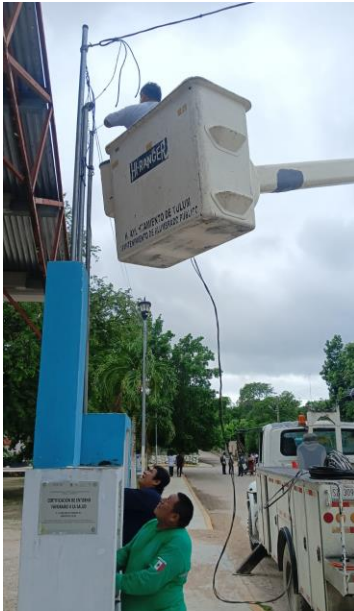
CAMBIO DE LUMINARIA Y CENTRO DE CARGA DEL DOMO DEL POBLADO DE SAHCAB MUCUY.
