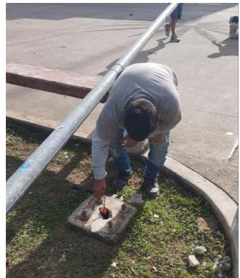
CAMBIO DE POSTE; COL. CENTRO SUR, CALLE OSIRIS SUR ENTRE AV. TULUM Y CALLE SOL OTE.
