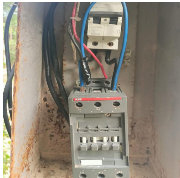
INSTALACIÓN DE CONTACTOR; COL. HEAVEN.
