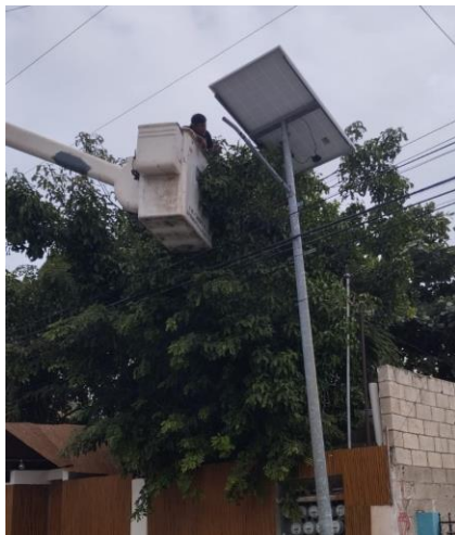
CAMBIO DE LUMINARIA; COLONIA MAYAPAX, CALLE 4 ENTRE C. CENTAURO NTE Y C. ORION NTE.
