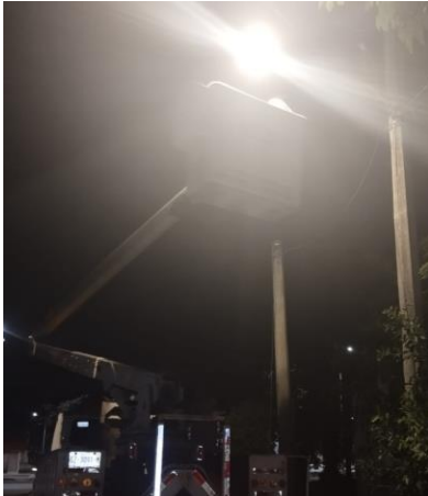
REHABILITACIÓN DE LUMINARIA; COL. EJIDO, CALLE JABALI ENTRE CHUN-YAXCHE Y AV. LA SELVA.
