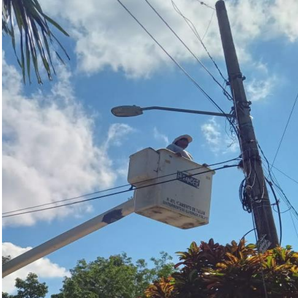
RECONEXIÓN DE LINEAS SULFATADAS; CALLE ASUNCIÓN, COL. VELETA
