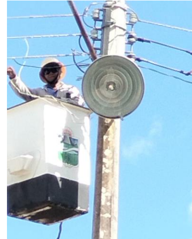
REHABILITACIÓN DE 3 REFLECTORES; POBLADO DE HONDZONOT.
