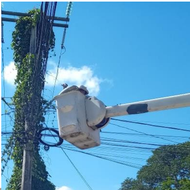
CAMBIO DE FOTOCELDAS OSBOLETAS POR NUEVAS; CALLE ASUNCIÓN, COL. VELETA.
