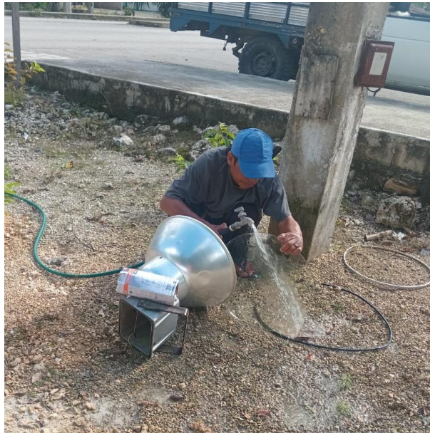
REHABILITACIÓN DE LAMPARA TIPO SOL; POBLADO DE MANUEL ANTONIO AY.
