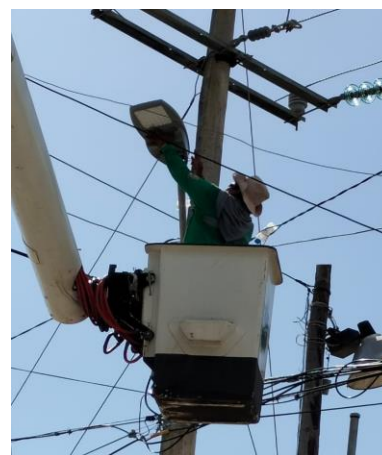
REHABILITACIÓN DE 2 LUMINARIAS; POBLADO DE CHEMUYIL (CAMPO).
