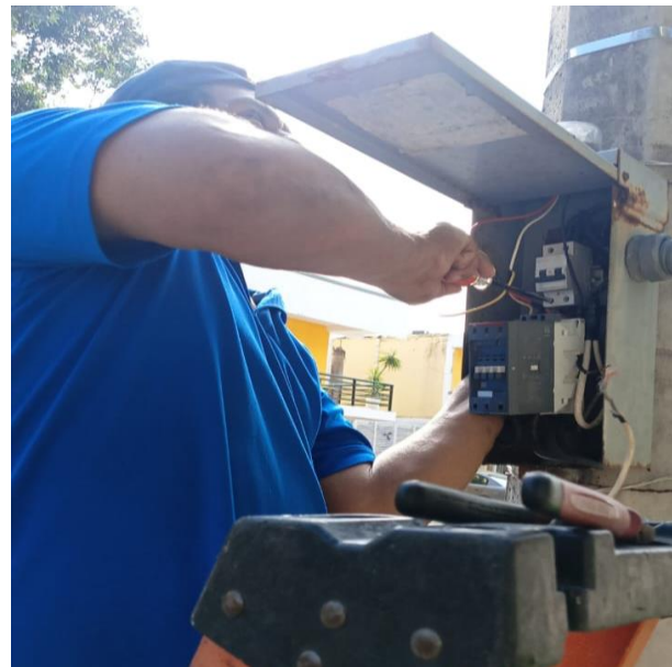
INSTALACIÓN DE BREAK Y CONTACTOR PARA AUTOMATIZAR SECTOR; CALLE 24, COL. TUMBEN-KAA.
