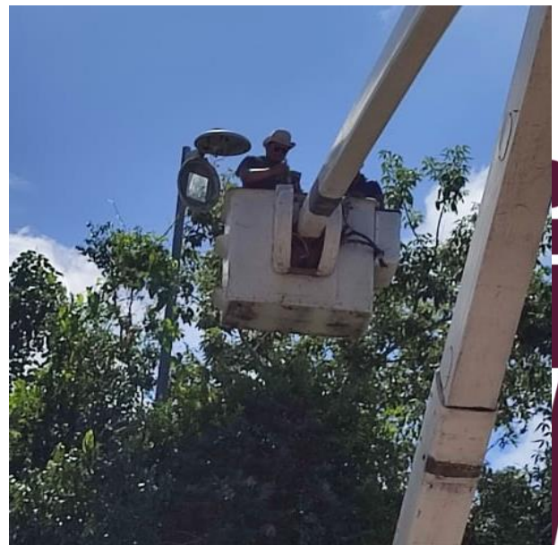
REPARACIÓN DE LAMPARAS OVNI, AV. CENTRAL; ALDEA ZAMA.
