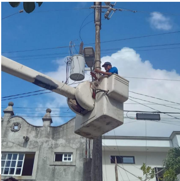
CAMBIO DE LUMINARIA POR LED NUEVA DE 100 W; CALLE MAYA BALAM, COL. EJIDO.
