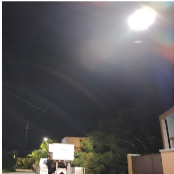
REHABILITACIÓN DE LUMINARIA; CALLE 13, COL. TUMBEN-KAA.
