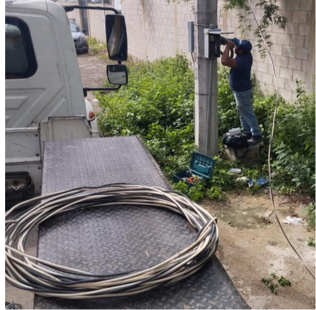
SE TENSIONA LINEAS AEREAS PARA ALIMENTAR CONTACTO, AV. 1, COL. TUMBEN-KAA.
