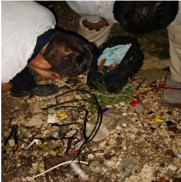
RECONEXIÓN DE LINEAS SUBTERRANEAS; CALLE KO'OH, COL. XUL KAA.
