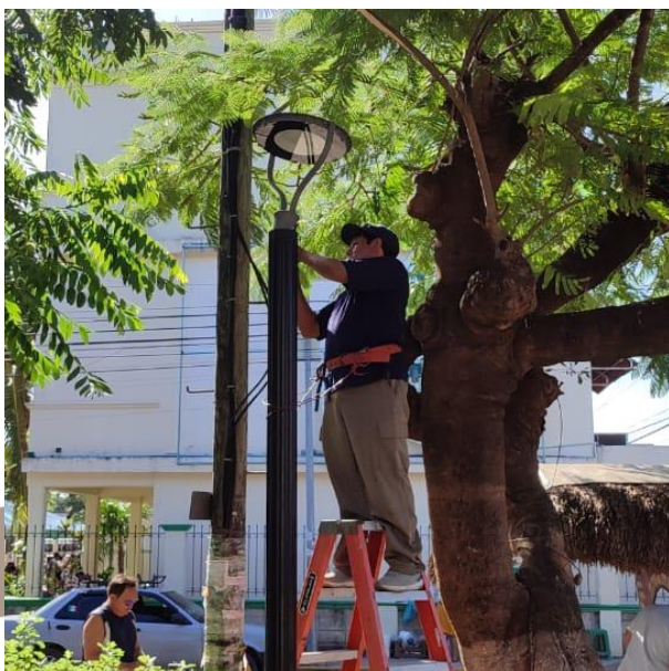
CAMBIO DE LAMPARAS OSBOLETAS POR LED NUEVAS DE 100 W PUNTA DE POSTE; CALLE ALFA, COL. CENTRO.
