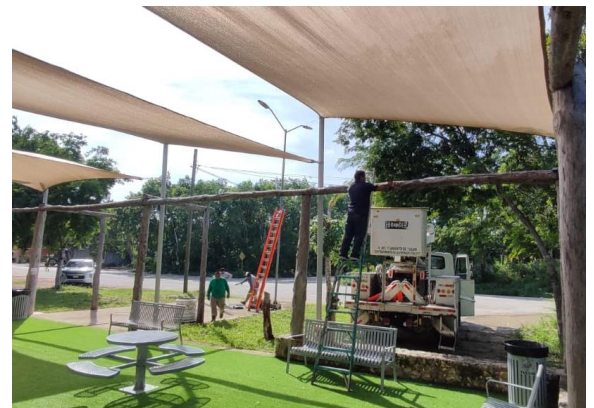
CAMBIO DE 8 LUMINARIAS; COL. TUMBEN KAA, AV. 1.
