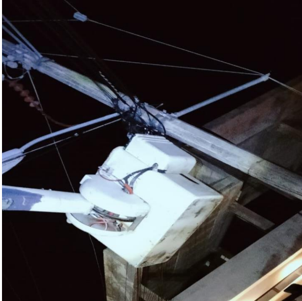
CAMBIO DE LINEA QUE ALIMENTA BRAZO DE LUMINARIA; CALLE ALFA SUR, COL. CENTRO.
