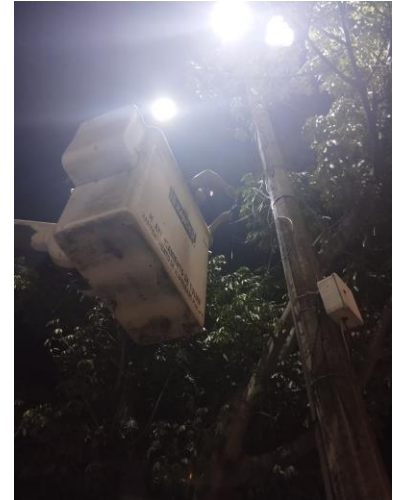
REHABILITACIÓN DE LUMINARIA; COL. EJIDO, CALLE CHUN-YAXCHE ENTRE CALLE TEJON Y GOLONDRINA.
