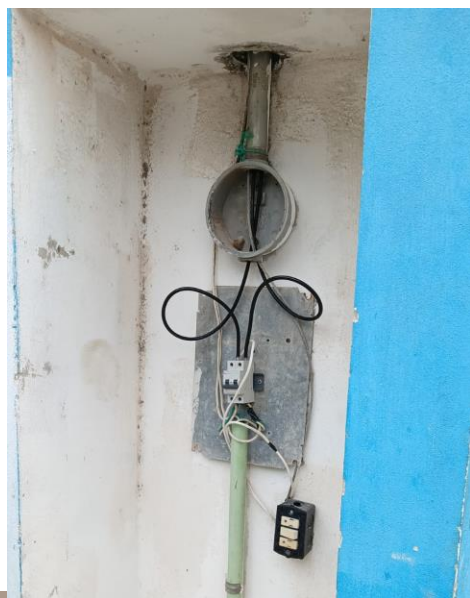
REHABILITACIÓN EN BANCO DE CONTROL; BREAK Y LINEAS DEL DOMO DEL POBLADO DE CHAN CHEN I.
