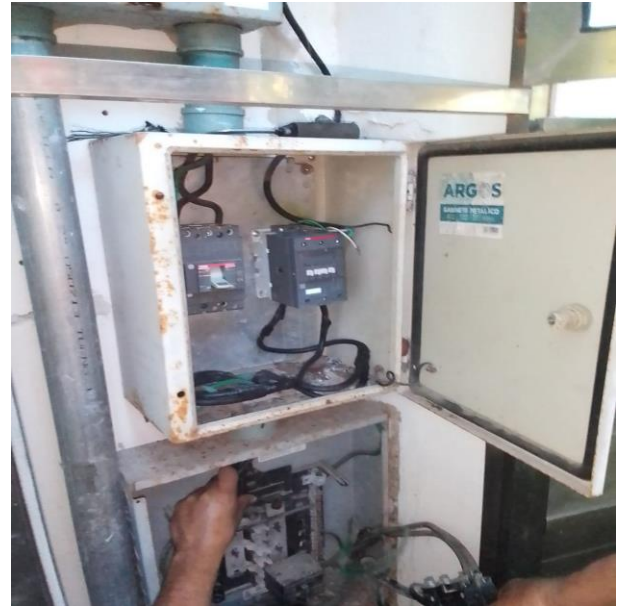
SE INSTALA CONTACTOR, PARA AUTOMATIZAR SECTOR; AV. PRINCIPAL, ALDEA ZAMA.
