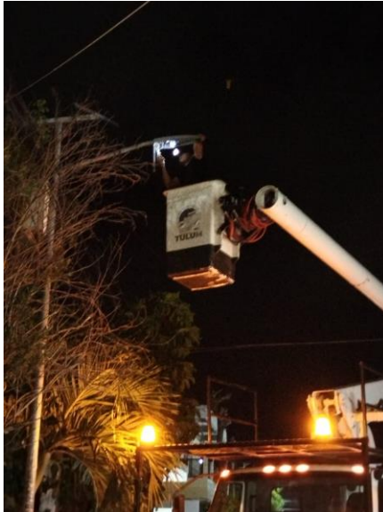
CAMBIO DE LUMINARIA; COL. CENTRO, CALLE SOL OTE Y OSIRIS SUR.
