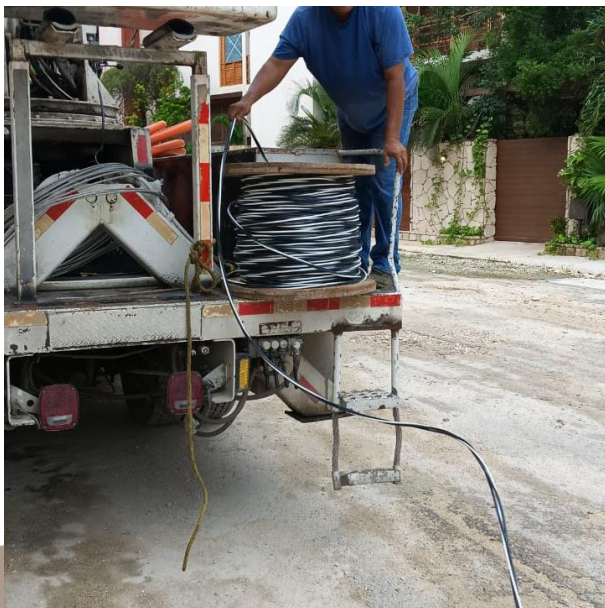
SE TENSIONAN LINEAS PARA ALIMETAR LUMINARIAS, COL. VILLAS HARMONY.
