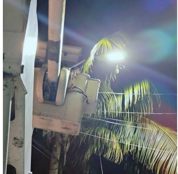
REPARACIÓN DE LUMINARIAS APAGADAS; CALLE PALENQUE, COL. VELETA.
