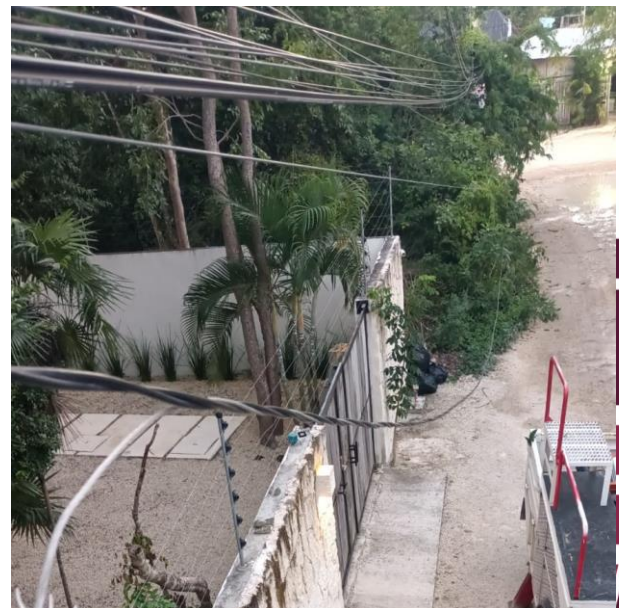
REHABILITACIÓN DE LINEAS CAIDAS; COL. TUMBEN-KAA.
