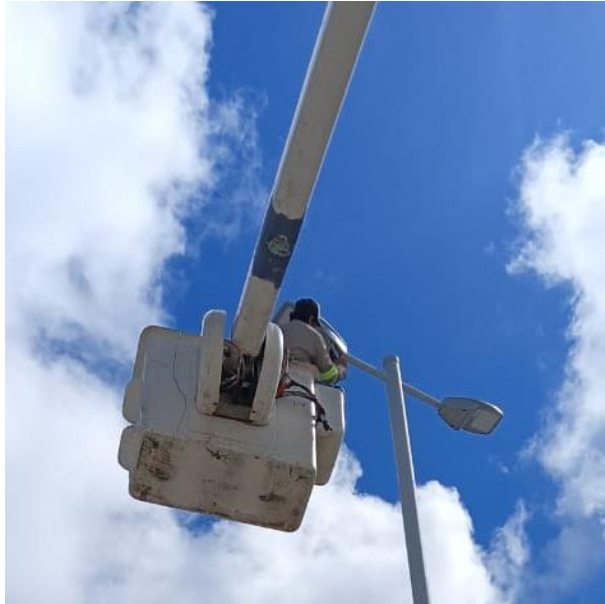
CAMBIO DE LAMPARAS OBSOLETAS POR LED DE 100 WATTS NUEVAS; AV. TULUM ENTRE AV. SATELITE, COL. CENTRO.
