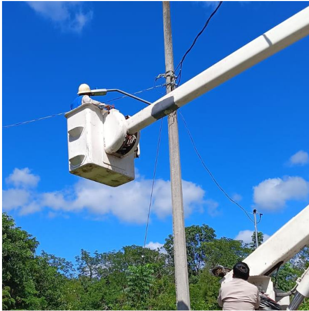
REPARACIÓN DE LUMINARIAS; POBLADO DE YAXCHE.
