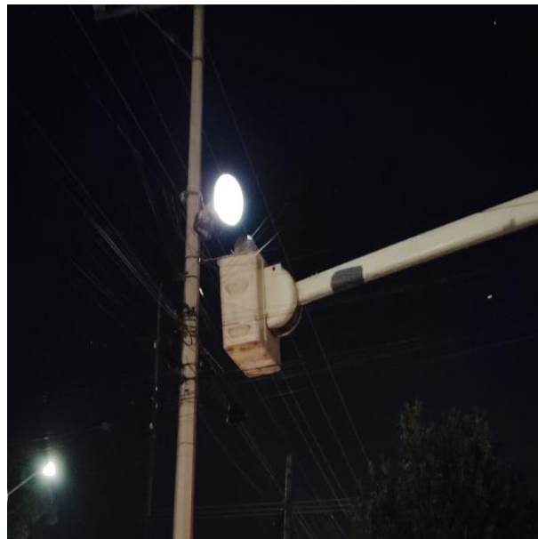
REHABILITACIÓN DE REFLECTOR; CALLE 13, COL. TUMBEN-KAA.
