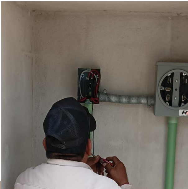
INSTALACIÓN DE BASE DE FOTOCELDA Y FOTOCELDA; CALLE AZUCENA, COL. YA'AX TULUM.
