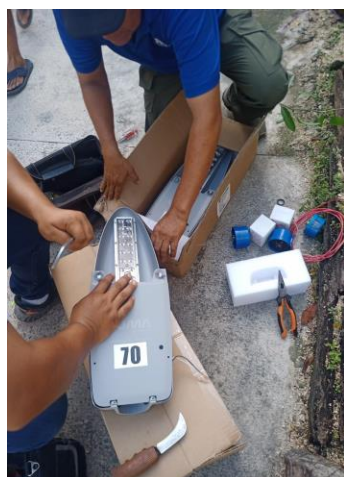
CAMBIO DE LUMINARIA; POBLADO DE CHEMUYIL (CAMPO)
