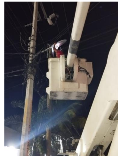
CAMBIO DE LUMINARIAS; COLONIA MAYA PAX, CALLE 4 OTE ENTRE C. CENTAURO NTE Y ORION NTE.
