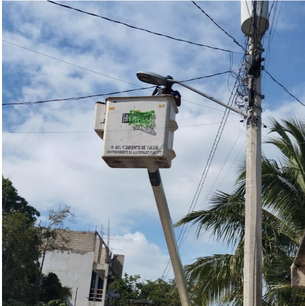
CAMBIO DE FOTOCELDA QUEMADA; CALLE CHIKIL, COL. MAYAPAX.
