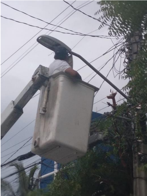
CAMBIO DE LUMINARIA; COL. EJIDO NTE, CALLE CHUN-YAXCHE ENTRE CALLE FAISAN Y TEJÓN.
