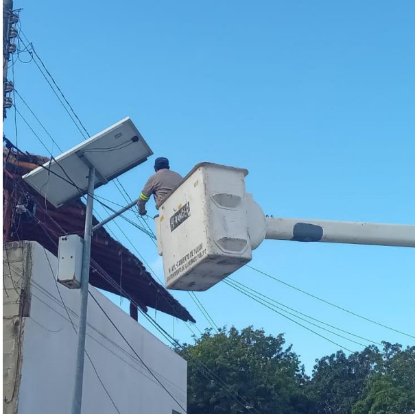
CAMBIO DE FOTOCELDA; COLONIA MAYA-PAX.
