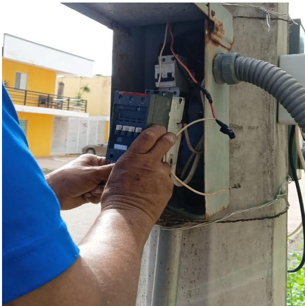
INSTALACIÓN DE BREAK Y CONTACTOR PARA AUTOMATIZAR SECTOR; CALLE 24, COL. TUMBEN-KAA.
