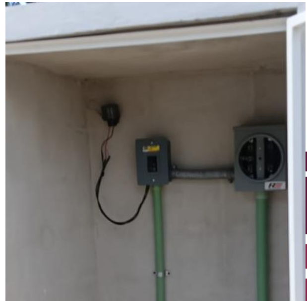
INSTALACIÓN DE BASE DE FOTOCELDA Y FOTOCELDA; CALLE AZUCENA, COL. YA'AX TULUM.
