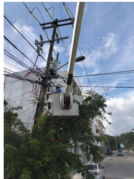
CAMBIO DE LUMINARIA; FRACCIONAMIENTO VILLAS TULUM, CALLE 3 SUR Y CALLE 2 OTE.
