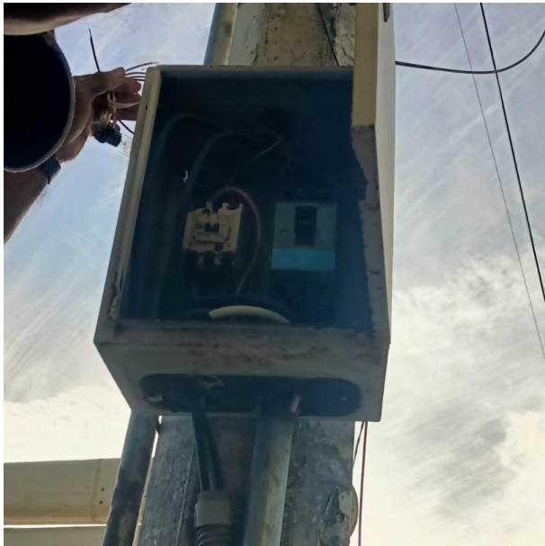
RECONEXIÓN DE BASE DE MEDIDOR; AV. SATÉLITE NORTE, COL. CENTRO.
