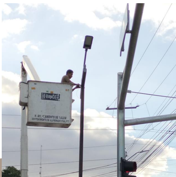
RECONEXIÓN DE LUMINARIAS POR LINEAS SULFATADAS; AV. SATELITE, COL. CENTRO.
