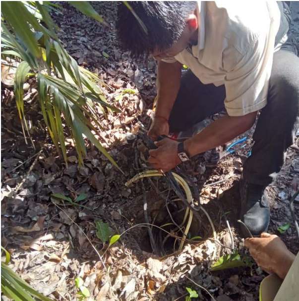
RECONECCIÓN DE LINEAS SULFATAS; AV. PRINCIPAL, ALDEA ZAMA.
