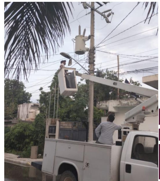
CAMBIO DE LUMINARIA; COL. EJIDO NTE, CALLE CHUN-YAXCHE ENTRE CALLE GOLONDRINA Y GALLINOLA.
