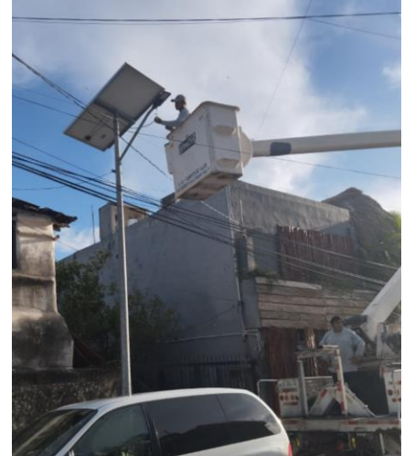
CAMBIO DE LUMINARIA; COL. MAYAPAX, CALLE 2 OTE, ENTRE CALLE ORION NTE Y CENTAURO NTE.
