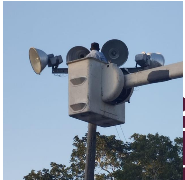
CAMBIO DE REFLECTORES CON JUEGO COMPLETO; POBLADO DE YAXCHE.
