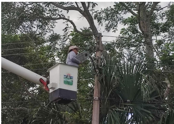
CAMBIO DE 12 LUMINARIAS; POBLADO DE COBÁ, LADO SUR.
