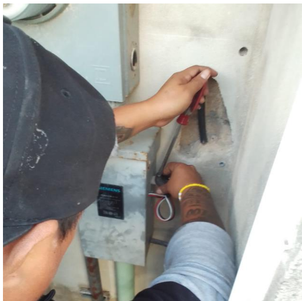
INSTALACIÓN DE BASE DE FOTOCELDA Y FOTOCELDA; FRACC. PALMAS TULUM.
