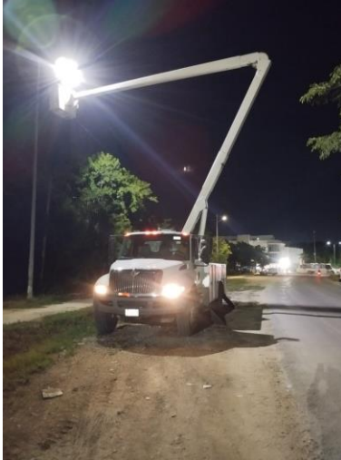
CAMBIO DE LUMINARIA; GLORIETA DE MARITES.
