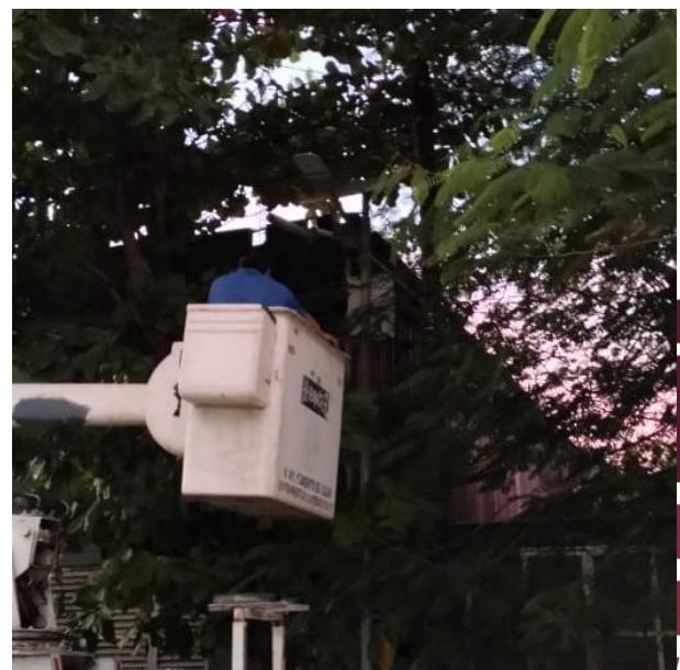
CAMBIO DE 3 LAMPARAS OBSOLETAS POR LED NUEVAS; CALLE SAGITARIO ORIENTE, COL. CENTRO.
