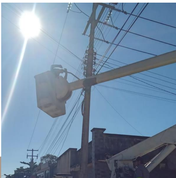
CAMBIO DE LAMPARAS LED OBSOLETAS POR LED NUEVAS DE 100 W; POBLADO DE FRANCISCO UH MAY.
