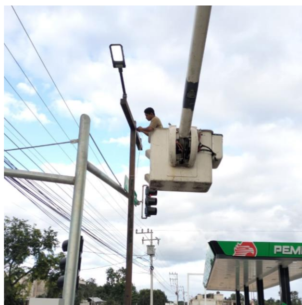
RECONEXIÓN DE LUMINARIAS POR LINEAS SULFATADAS; AV. SATELITE, COL. CENTRO.
