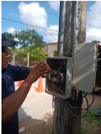
REHABILITACIÓN DE BASE DE FOTOCELDA Y FOTOCELDA; POBLADO DE COBÁ.
