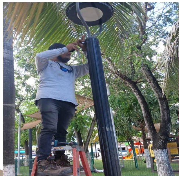
CAMBIO DE LAMPARAS OSBOLETAS POR LED NUEVAS DE 100 W PUNTA DE POSTE; CALLE ALFA, COL. CENTRO.
