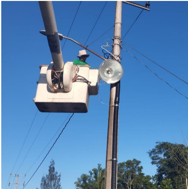
CAMBIO DE REFLECTORES CON JUEGO COMPLETO; POBLADO DE YAXCHE.
