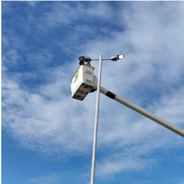
CAMBIO DE LAMPARAS OBSOLETAS POR NUEVAS TIPO LED, AV. TULUM, COL. CENTRO.
