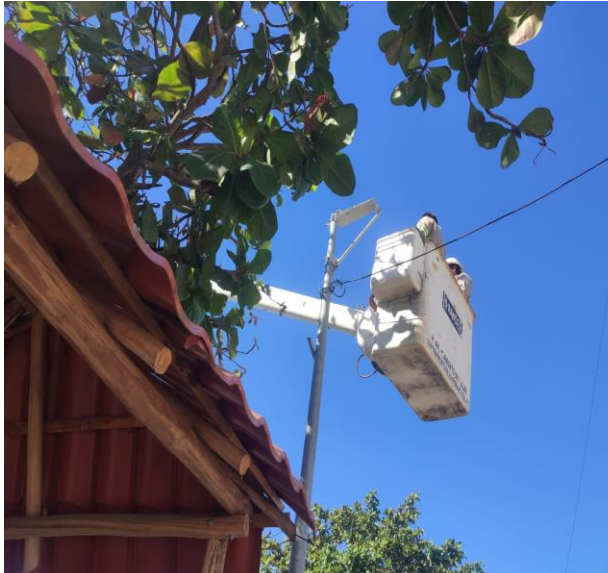
CAMBIO DE 3 LUMINARIAS OBSOLETAS POR NUEVOS TIPO LED; COL. CENTRO, AV. TULUM.
