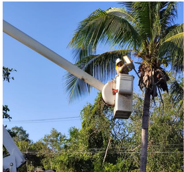
CAMBIO DE LUMINARIA OBSOLETA POR NUEVO TIPO LED; POBLADO DE AKUMAL, DEL LADO DEL ANDADOR A LA PLAYA.
