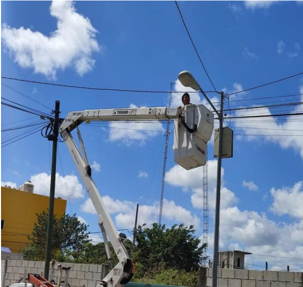
CAMBIO DE LUMINARIA OBSOLETA POR NUEVO TIPO LED; COL. CENTRO, CALLE ALFA Y VENUS OTE.
