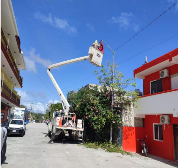
CAMBIO DE 2 LUMINARIAS OBSOLETAS POR NUEVOS TIPO LED; POBALDO DE AKUMAL.
