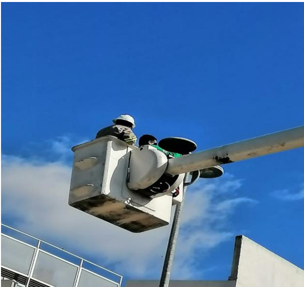
REHABILITACIÓN DE 24 LUMINARIAS; FRACCIONAMIENTO ALDEA ZAMA.
