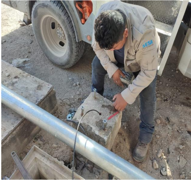
CAMBIO DE POSTE DAÑADO POR NUEVO; COL. TUMBEN-KA, CALLE 17.
