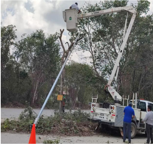
CAMBIO DE POSTE DAÑADO POR NUEVO; COL. TUMBEN KAA, CALLE RIO ZANAPA Y AV. 1.
