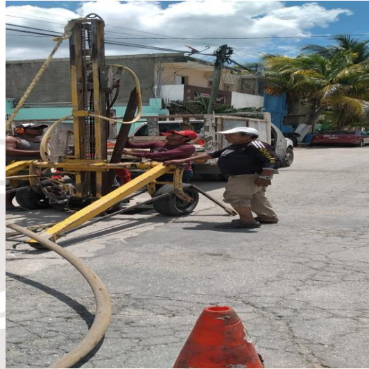
Desazolve de pozos; Calle sagitario entre osiris y calle beta, colonia centro.
