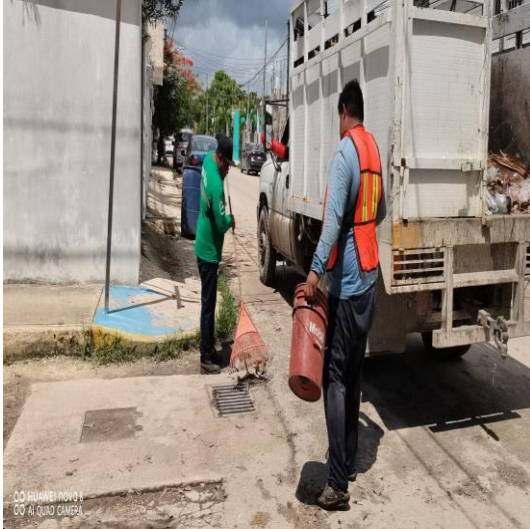
Limpeza de rejillas; Calle 2 oriente entre calle 2 bis oriente.
