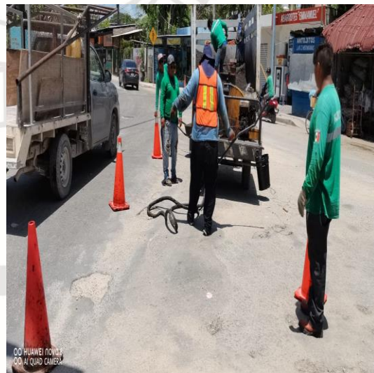
Bacheo; Av. Kukulkán entre av. ook-k'ot y calle Júpiter norte, colonia mayapax.
