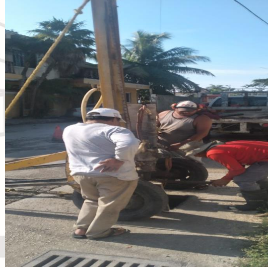
Desazolve de pozos; Calle sagitario entre calle ori3n, colonia centro.
