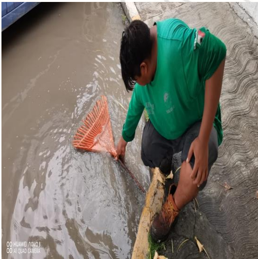
Limpeza de rejillas; Calle Venus Oriente entre la calle centauro sur y la Av. Satélite.
