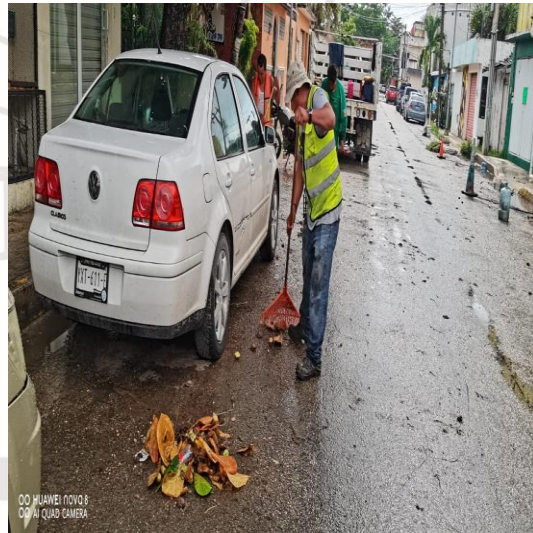
Limpieza de rejillas; Calle andrómada Oriente entre la calle y beta sur.
