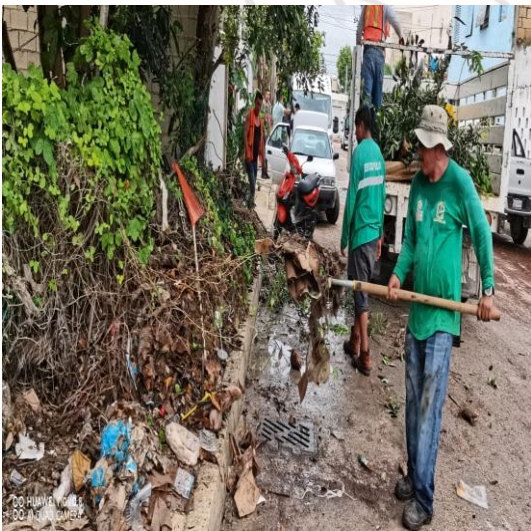
Limpieza de rejillas; Calle chikil entre la calle Tun-k'ul y la Av. ook-k'ot.
