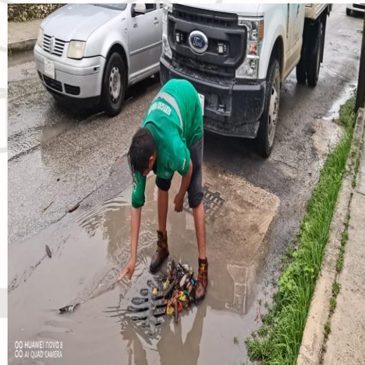
Limpieza de rejillas; Calle sagitario Oriente entre la calle Júpiter norte y la calle acuario norte.
