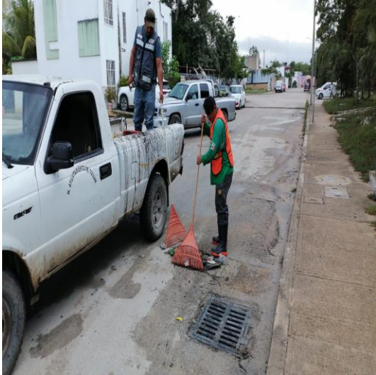
Limpeza de rejillas; Calle bulevar palmas entre palmas baru.
