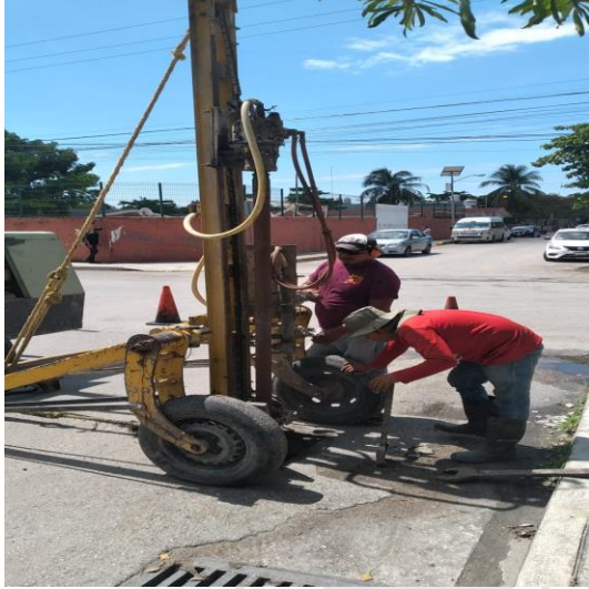
Desazolve de pozos; Calle 4 oriente entre calle bubul-lek, colonia mayapax.
