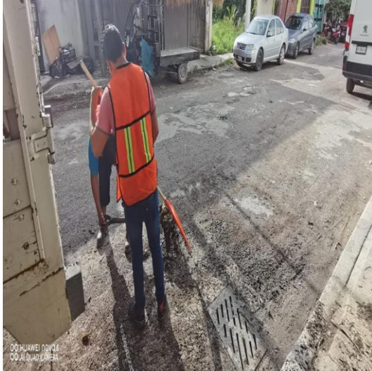
Limpieza de rejillas; Calle chikil entre calle tun-k'ul y av. ook-k'ot.
