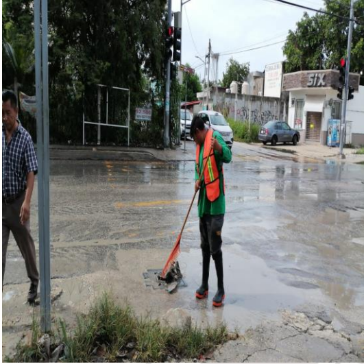
Limpeza de rejillas; Av. satélite entre ook-k'ot.
