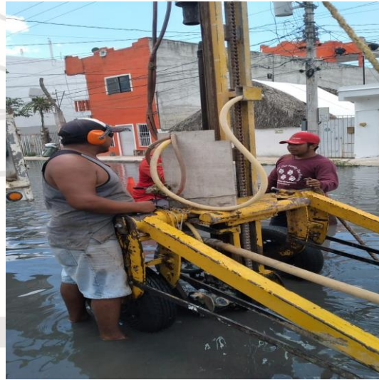
Desazolve de pozos; Calle sagitario poniente entre calle alfa norte y calle polar, colonia centro.
