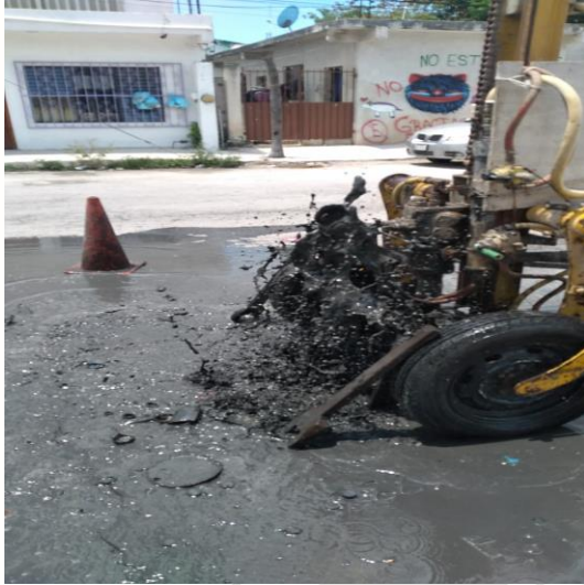
Desazolve de pozos; Calle sagitario poniente y osiris, colonia centro.
