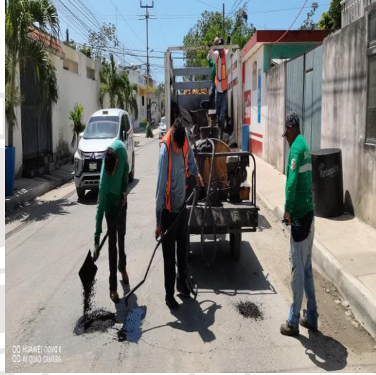
Bacheo; Calle golondrina entre calle chanchen y calle chun-yaxche, colonia ejido.
