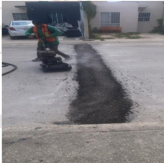
Bacheo; Calle boulevard palmas Tulum entre calle palma navidad, fraccionamiento palmas.
