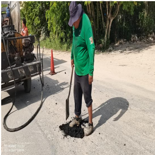
Bacheo; Calle 5 bis norte entre calle 2 norte, fraccionamiento palmas.
