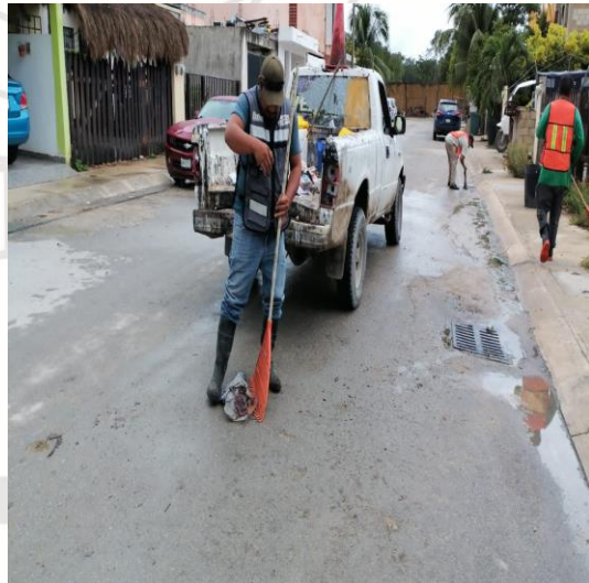
Limpeza de rejillas; Calle abanico palmas entre bulevar palma.
