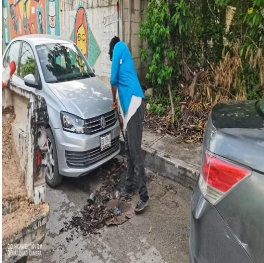
Limpieza de rejillas; Calle 3 sur entre la calle 2 bis oriente.
