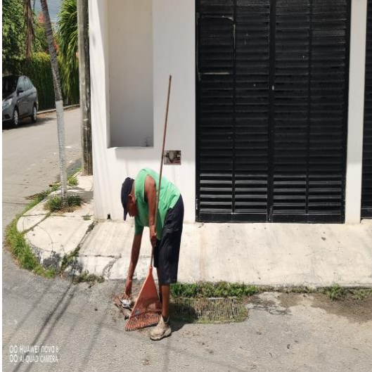
Limpieza de rejillas; Calle 2 oriente entre 3 sur.
