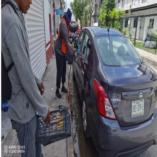
Limpeza de rejillas; Calle 2 poniente entre la calle beta norte y la calle orión norte.
