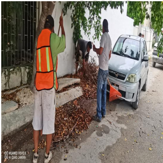
Limpieza de rejillas; Calle 5 entre la calle 4 oriente y la calle 2 a oriente.
