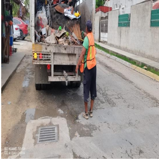
Limpeza de rejillas; Calle sagitario oriente géminis norte.
