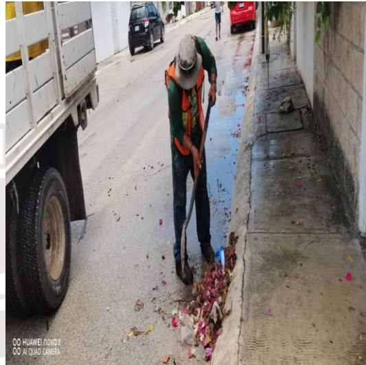
Limpieza de rejillas; Calle 3 sur entre la calle 2 oriente a.
