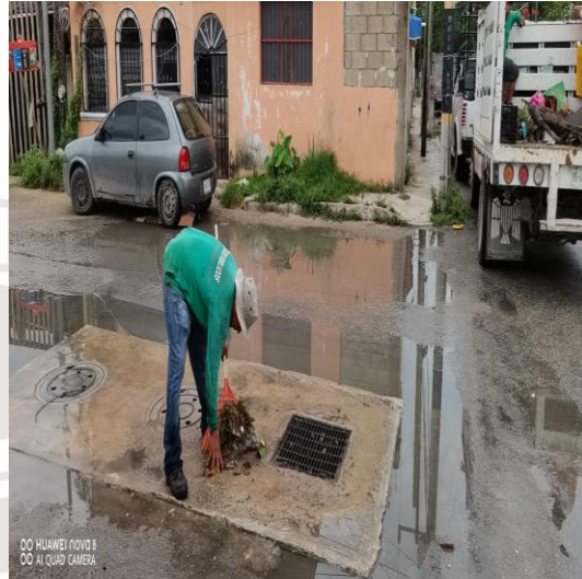
Limpieza de rejillas; Calle 4 Oriente entre la calle mega norte y la calle Júpiter norte.
