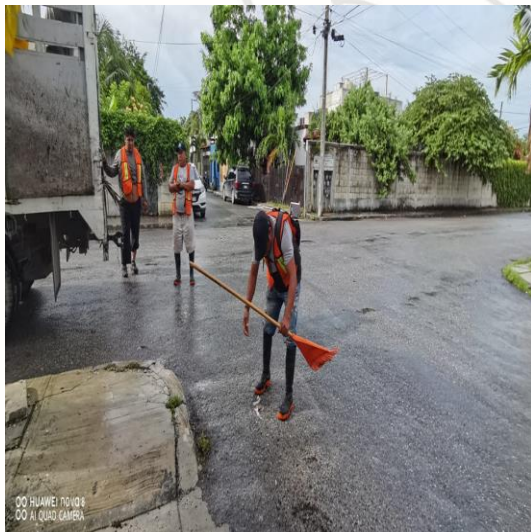
Limpieza de rejillas; Calle 11 entre 3 sur y 13.
