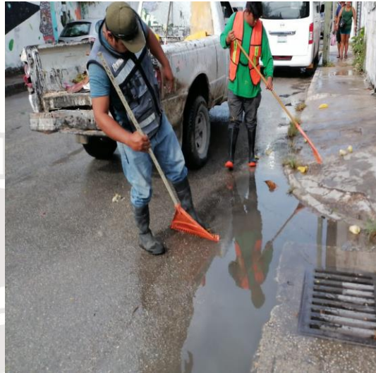
Limpeza de rejillas; Calle 4 oriente entre orión norte.
