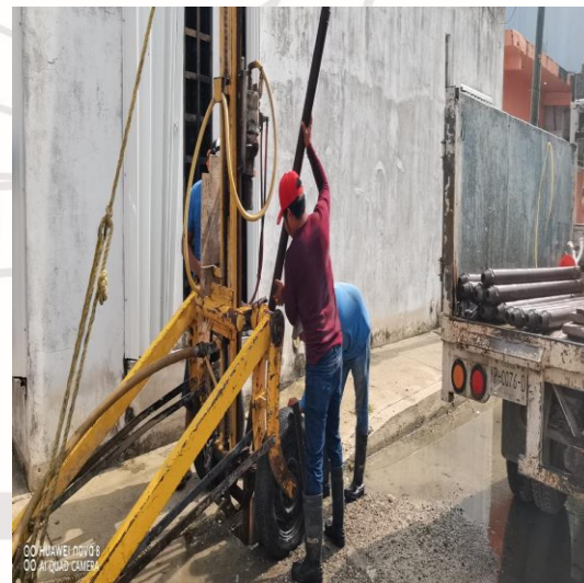
Desazolve de pozos; Calle ori3n entre le'xiu y av. Ook-k'ot, colonia maya pax.
