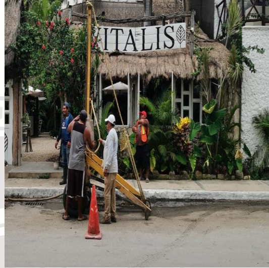
Desazolve de pozos; Av. satélite entre calle sagitario y calle polar, colonia centro.
