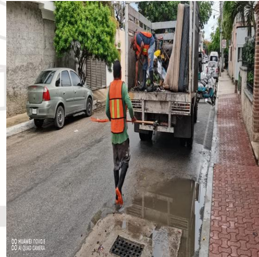
Limpeza de rejillas; Calle venus oriente entre beta sur y osiris sur.
