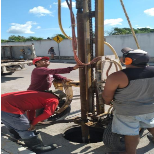
Desazolve de pozos; Calle júpiter norte entre calle tun-k'ul, colonia mayapax.
