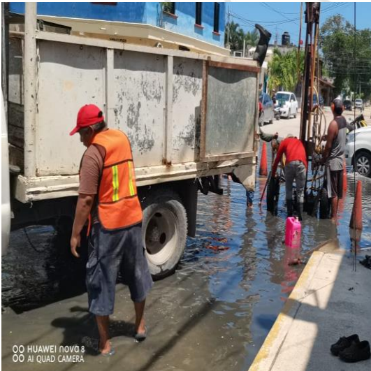
Desazolve de pozos; Calle neptuno oriente entre orión sur, colonia lak'iin.
