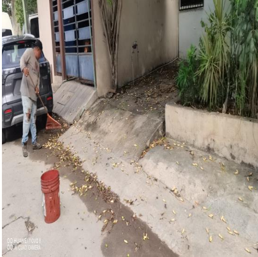
Limpeza de rejillas; Calle 4 oriente entre la calle 15.
