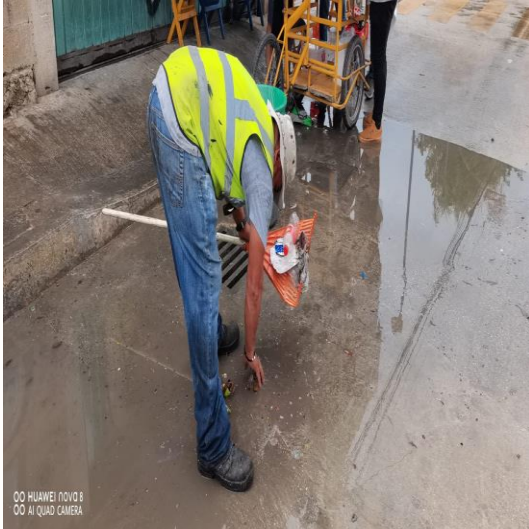
Limpeza de rejillas; Calle sol oriente entre la calle beta sur y calle Osiris.
