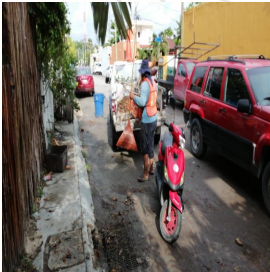
Limpieza de rejillas; Calle 2 bis Oriente y calle 11 sur.
