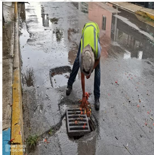
Limpieza de rejillas; Calle neptuno entre la Av. Satélite y la calle géminis.
