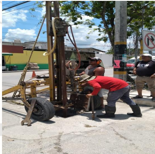
Desazolve de pozos; Calle 2 poniente entre calle sagitario, colonia centro.
