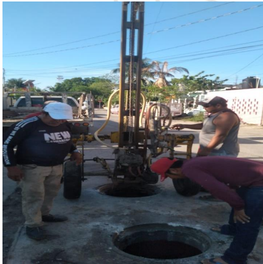
Desazolve de pozos; Calle omega norte entre 4 poniente, colonia centro.
