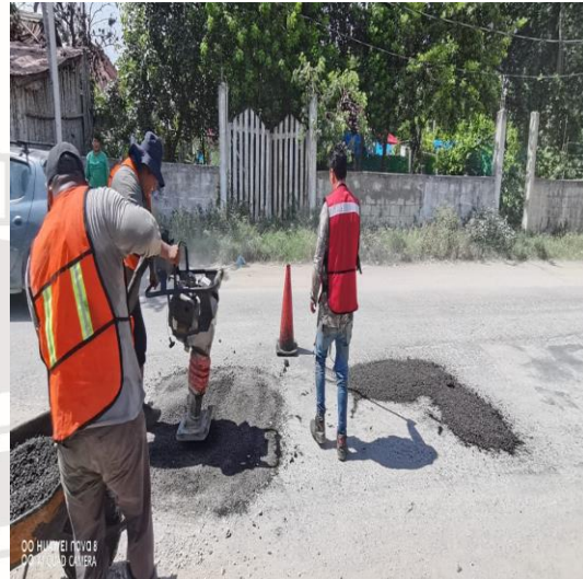
Bacheo; Calle mercurio oriente entre calle orión y calle centauro sur, colonia centro sur.
