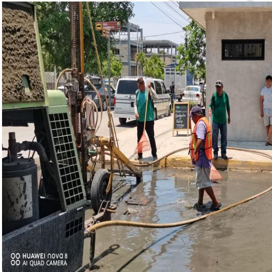
Desazolve de pozos; Calle sagitario oriente entre av. satélite y calle centauro norte, colonia centro.
