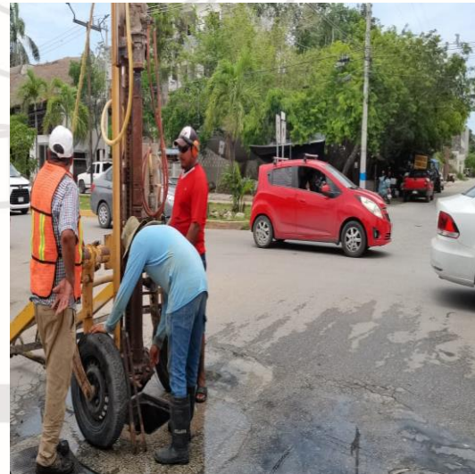
Desazolve de pozos; Av. satélite entre bubul-lek, colonia mayapax.
