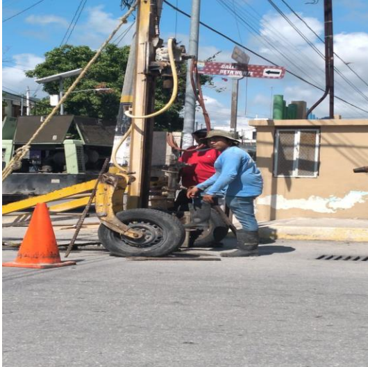
Desazolve de pozos; Calle beta norte entre 2 poniente, colonia centro.
