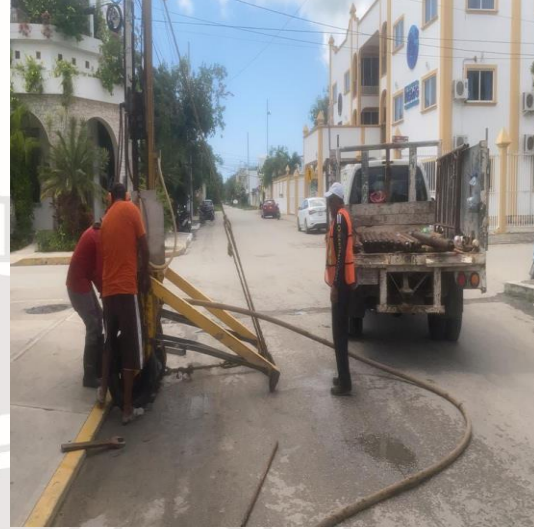
Desazolve de pozos; Calle escorpión sur entre andrómeda oriente, colonia lak'iin.
