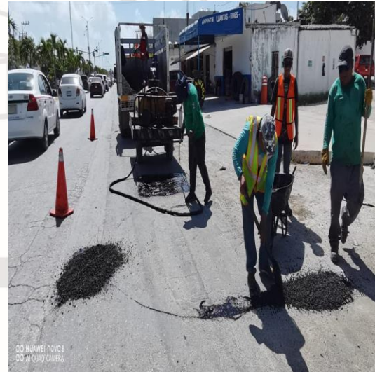
Bacheo; Av. Tulum entre calle asunción y calle palenque, colonia centro sur.
