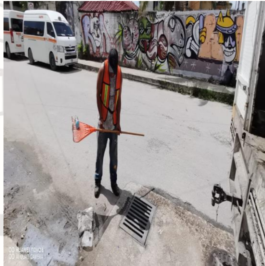
Limpeza de rejillas; Calle neptuno poniente entre la calle omega sur y mercurio oriente.
