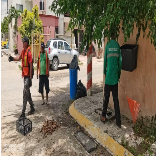
Limpeza de rejillas; Calle 2 bis oriente entre 7 sur.
