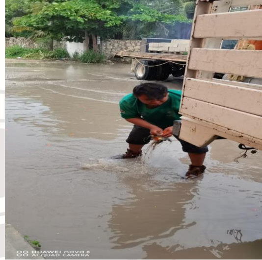
Limpeza de rejillas; Calle mercurio oriente entre la calle palenque y Av. Kukulkan.
