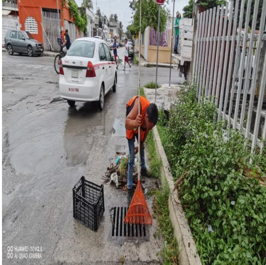
Limpieza de rejillas; Calle 4 oriente entre la calle beta norte y la calle Osiris norte.
