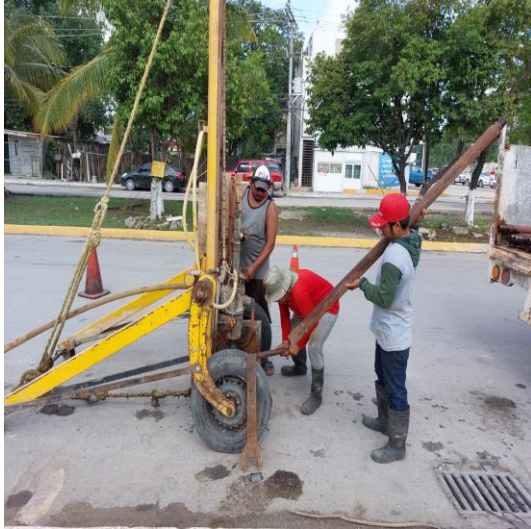
Desazolve de pozos; Av. satélite entre bubul-lek y calle centauro norte, colonia mayapax.
