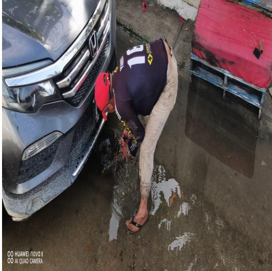
Limpeza de rejillas; Calle 17 entre la calle 15.
