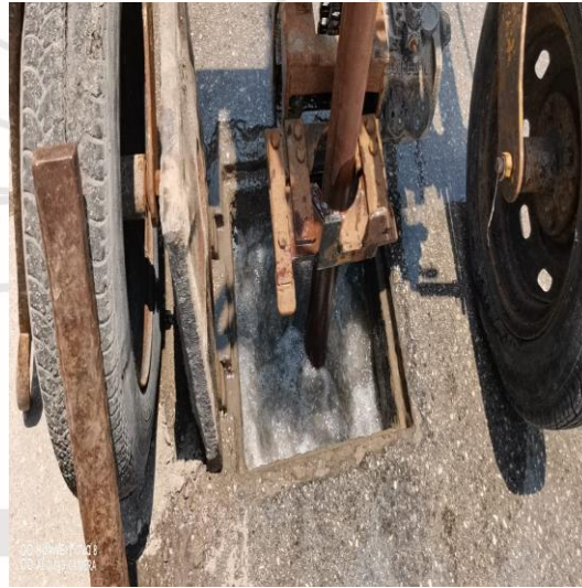
Desazolve de pozos; Calle tepich entre calle 2 oriente, fraccionamiento guerra de castas.
