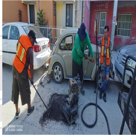
Bacheo; Calle palenque entre calle mercúrio poniente y calle ontario, colonia veleta.
