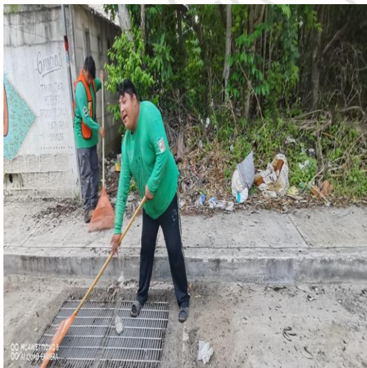
Limpeza de rejillas; Calle bubul-ek entre la calle 11.
