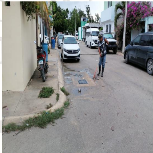
Limpeza de rejillas; Calle 2 oriente entre calle libra norte. Y calle sagitario oriente.
