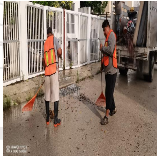
Limpieza de rejillas; Calle 5 sur entre 4 oriente y 2ª oriente.
