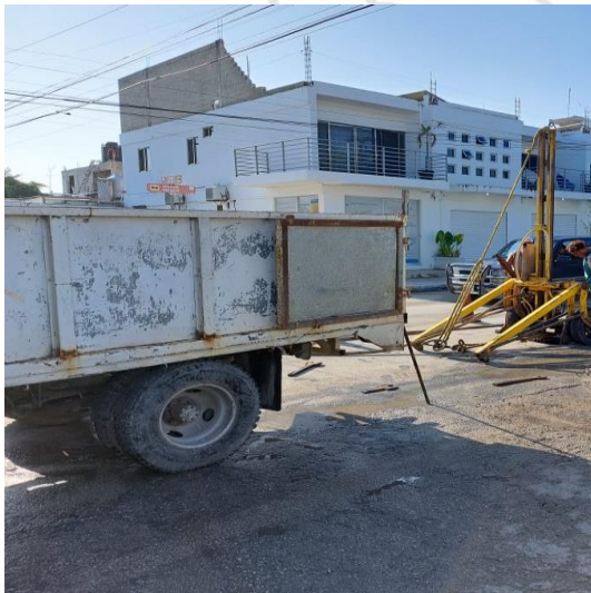
Desazolve de pozos; Av. satélite entre calle kii's y calle bubul- lek, colonia maya pax.
