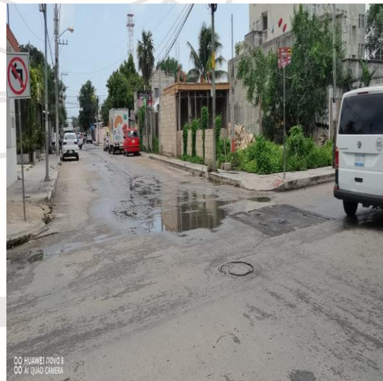
Limpieza de rejillas; Calle sagitario Oriente entre La calle Osiris norte y la alfa norte.
