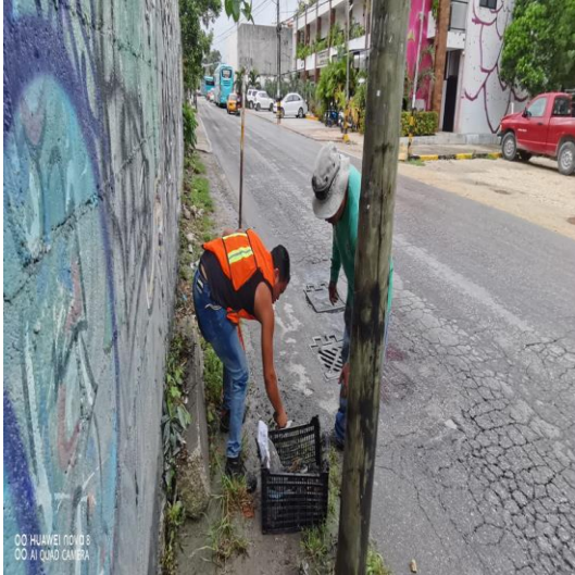
Limpeza de rejillas; Av. kulkan entre la calle xcaret y la calle polar poniente.
