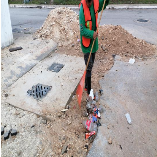
Limpeza de rejillas; Calle palma yagua entre calle bulevar palmas.
