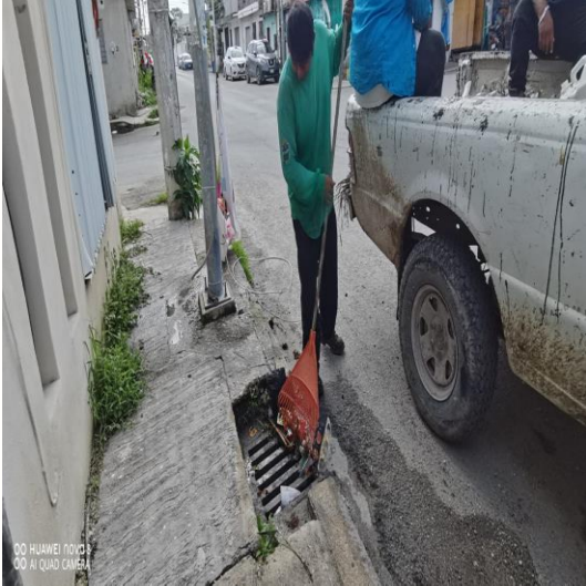
Limpieza de rejillas; Calle sagitario oriente entre la calle beta norte y la calle Osiris norte.
