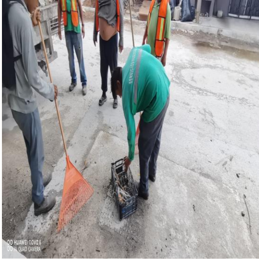
Limpeza de rejillas; Calle chikil entre calle tun-k'ul y av. ook-k'ot.
