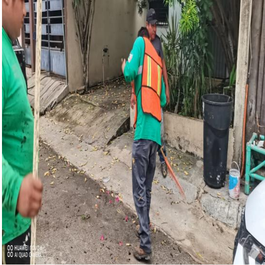
Limpieza de rejillas; Calle 3 sur entre calle 2 oriente a.
