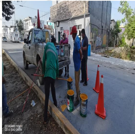
Pintura; Camellón central y guarniciones de av. satélite.
