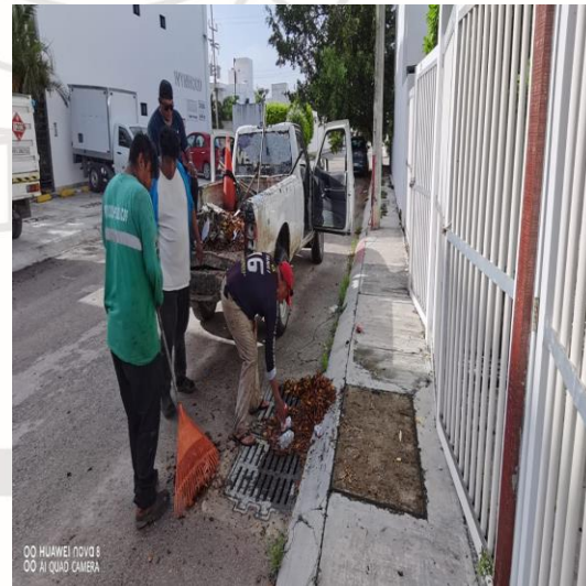
Limpieza de rejillas; Calle 5 sur entre la calle 2 oriente a.
