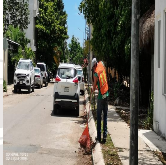
Limpeza de rejillas; Calle escorpión entre calle 4 oriente y calle Cecilio chi.
