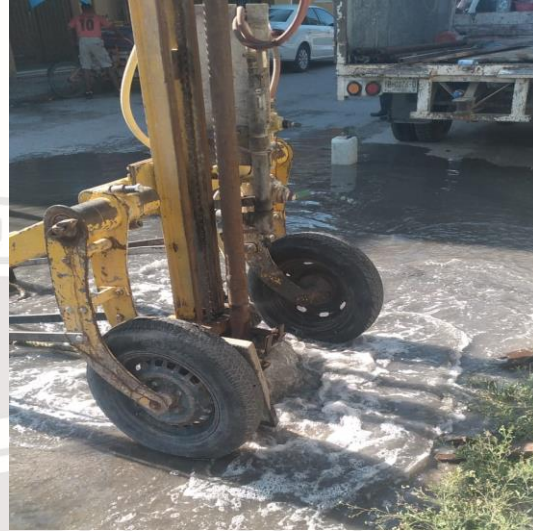
Desazolve de pozos; Calle 4 oriente entre calle omega norte entre calle 2 oriente, fraccionamiento villas Tulum.
