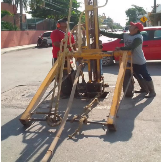
Desazolve de pozos; Calle 2 bis entre 17, fraccionamiento villas Tulum.
