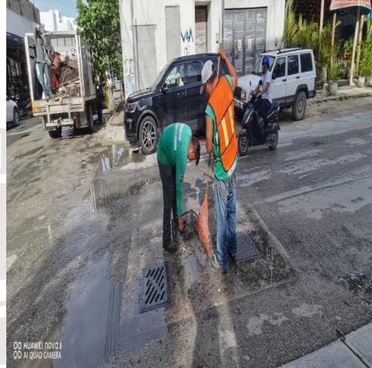
Limpieza de rejillas; Calle 7 sur entre la calle palenque y la calle asunción.
