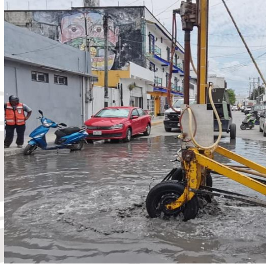
Desazolve de pozos; Calle bubul-lek entre géminis norte, colonia mayapax.
