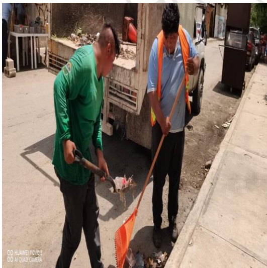
Limpeza de rejillas; Calle venus entre la calle Osiris sur y la calle beta sur.
