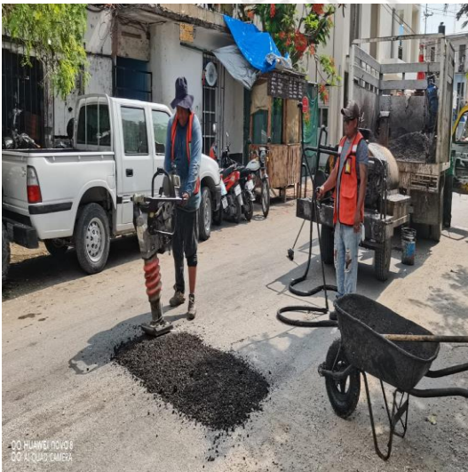
Bacheo; Calle venus oriente entre calle beta sur y calle ori3n sur, colonia centro.
