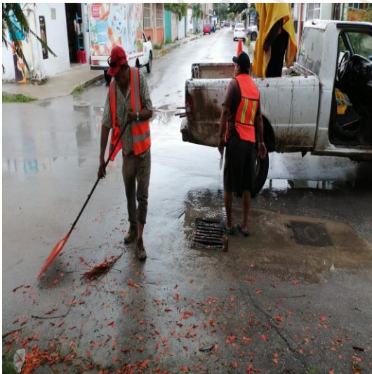
Limpieza de rejillas; Calle géminis sur y calle neptuno Oriente.
