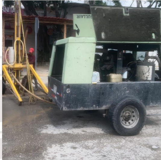
Desazolve de pozos; Calle centauro entre calle tun-k'ul colonia mayapax.
