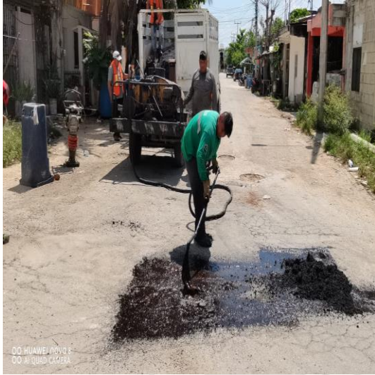
Bacheo; Calle júpiter norte entre calle le´xiu y av. Kukulkán, colonia centro.
