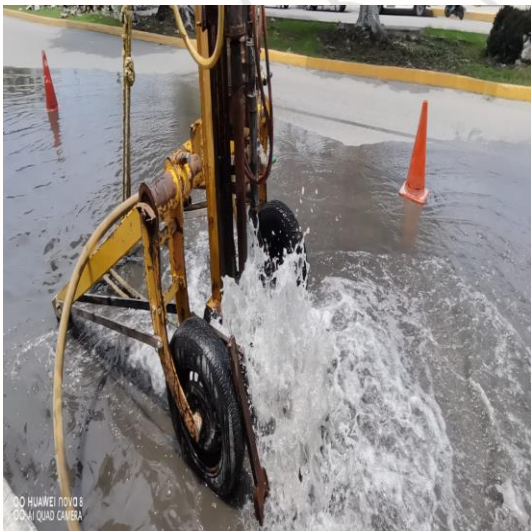
Desazolve de pozos; Av. satélite entre 4 oriente, colonia centro.
