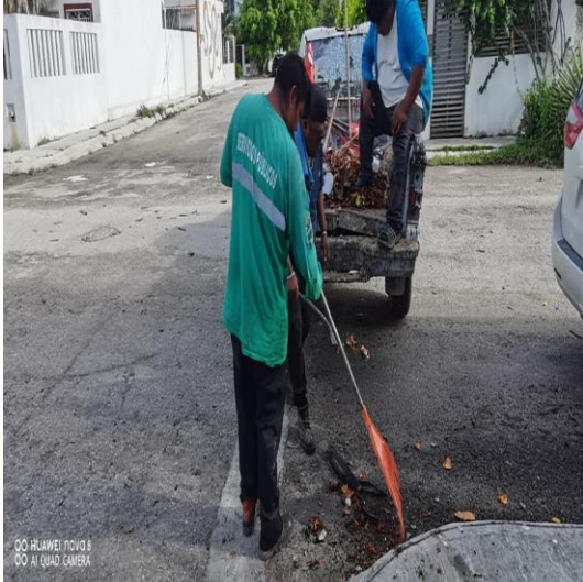
Limpieza de rejillas; Calle 5 sur entre la calle 2 oriente.
