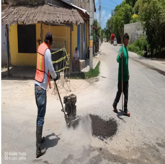
Bacheo; Av. selva entre calle chan caah y calle kohunlich, colonia tumben kaa.
