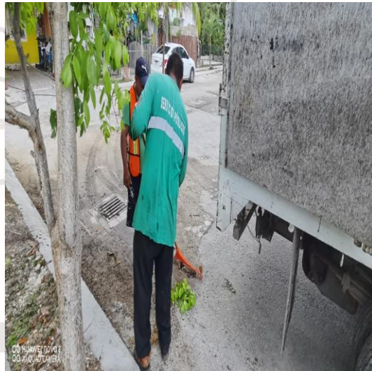
Limpeza de rejillas; Calle tepich entre 2 poniente.
