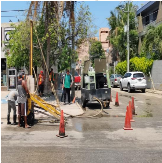
Desazolve de pozos; Calle 2 oriente entre av. satélite y calle sagitario, colonia centro.
