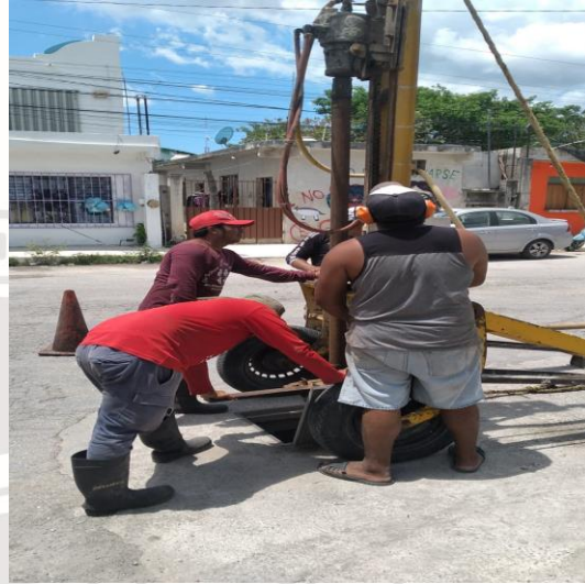
Desazolve de pozos; Calle júpiter norte entre calle2 poniente, colonia centro.
