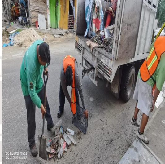
Limpeza de rejillas; Calle mercurio poniente entre la calle palenque y av. Kukulcán.
