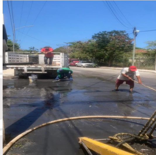
Desazolve de pozos; Calle 2 poniente entre escorpión norte, colonia centro.
