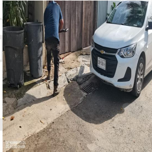
Limpieza de rejillas; Calle 4 oriente entre la calle 15.
