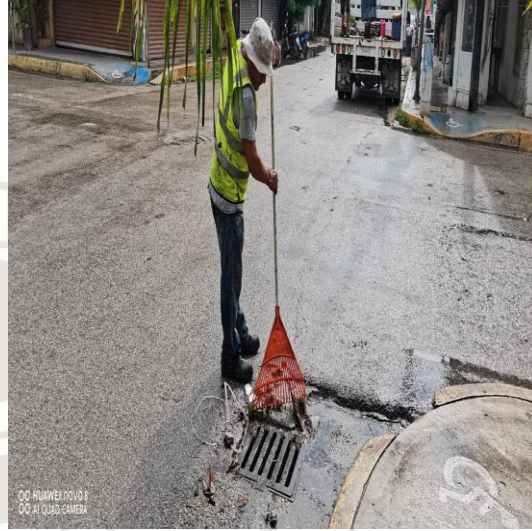
Limpieza de rejillas; Calle Andrómeda oriente entre calle centauro sur y av. Satélite.
