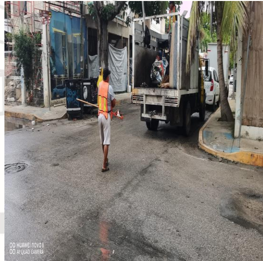
Limpeza de rejillas; Calle andrómeda oriente entre orión y centauro sur.
