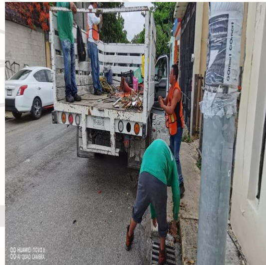
Limpieza de rejillas; Calle sagitario oriente entre calle beta norte y calle Osiris norte.
