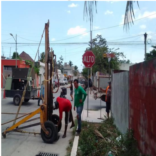
Desazolve de pozos; Calle 4 oriente entre beta, colonia centro.
