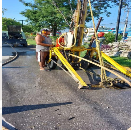
Desazolve de pozos; Av. satélite entre calle tun-k'ul y ook-k,ot, colonia mayapax.
