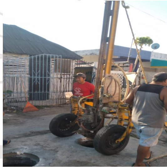
Desazolve de pozos; Calle 2 poniente entre osiris norte, colonia centro.
