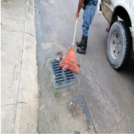
Limpeza de rejillas; Calle sagitario oriente entre calle polar poniente y calle libra norte.
