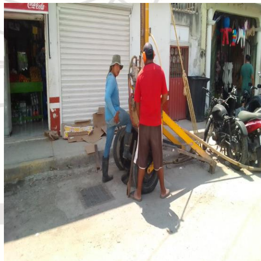
Desazolve de pozos; Calle beta entre calle 2, colonia centro.
