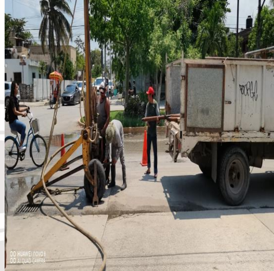
Desazolve de pozos; Calle sagitario entre av. Satélite, colonia centro.
