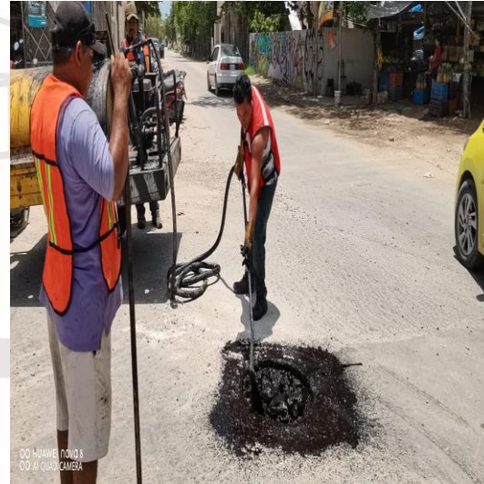
Bacheo; Calle mercúrio oriente entre av. satélite sur y calle géminis, colonia centro sur.
