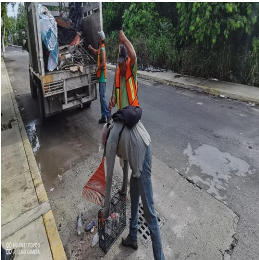
Limpieza de rejillas; Calle Kohunlich entre av. Tulum y calle akumal.
