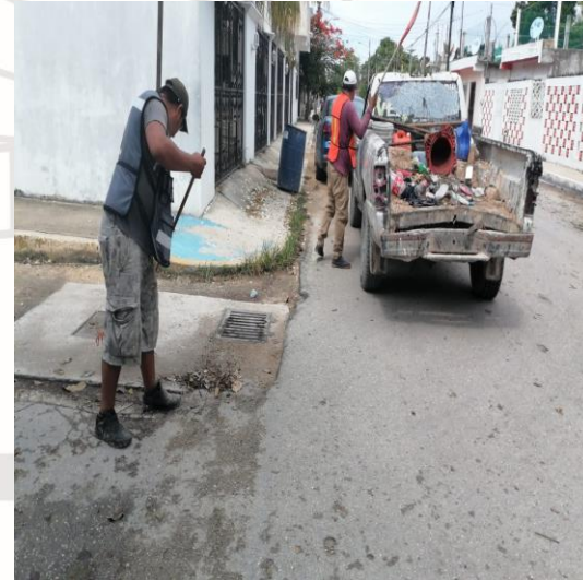
Limpeza de rejillas; Calle abanico entre calle palmas boulevard.
