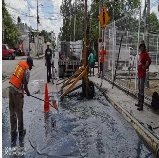
Desazolve de pozos; Calle sol oriente entre escorpión y calle libra sur, colonia lak'iin.
