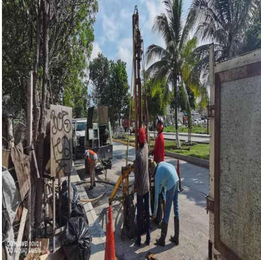
Desazolve de pozos; Av. satélite entre av. ook-k'ot y tun-k'ul, colonia mayapax.
