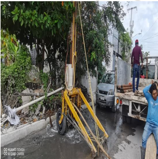
Desazolve de pozos; Calle zac-be entre calle 14 sur, colonia maya pax.
