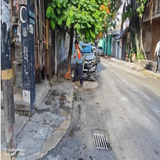
Limpieza de rejillas; Calle asteroide oriente entre gama oriente y calle mercurio poniente.
