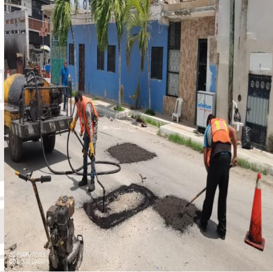
Bacheo; Calle sol oriente entre calle orión sur y calle beta sur, colonia centro.
