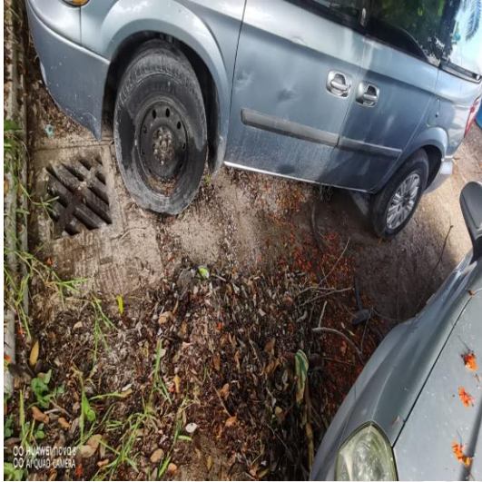
Limpeza de rejillas; Calle chemuyil entre la calle 4 oriente.
