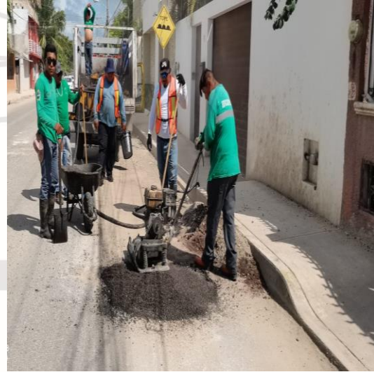
Bacheo; Calle sagitario poniente entre calle polar poniente y calle júpiter norte, colonia centro norte.
