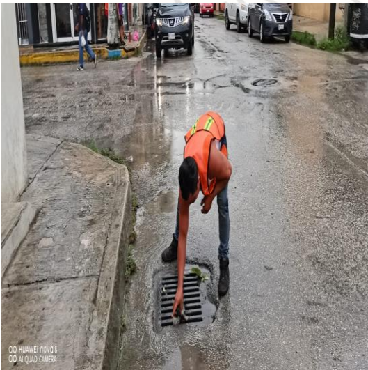
Limpieza de rejillas; Calle polar poniente entre la calle Osiris norte y la calle beta norte.
