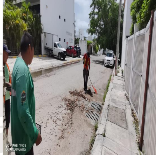
Limpieza de rejillas; Calle 5 sur entre 4 oriente y 2 oriente.
