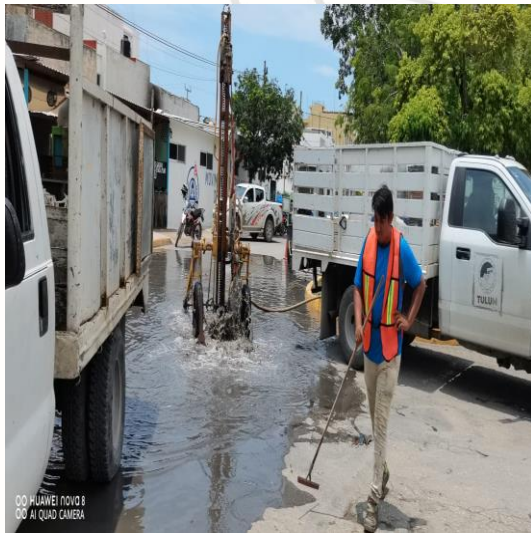
Desazolve de pozos; Av. satélite entre calle tun-k'ul y kii's, colonia mayapax.
