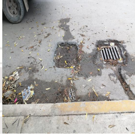
Limpieza de rejillas; Calle centauro sur y calle neptuno oriente.
