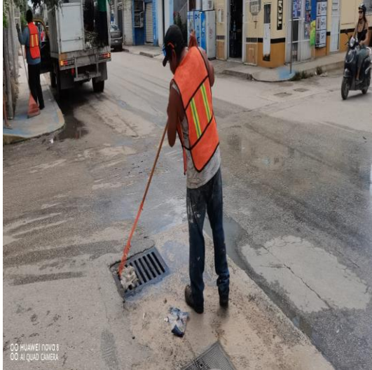
Limpeza de rejillas; Calle gama oriente entre la calle orión y la calle sur y la calle centauro sur.
