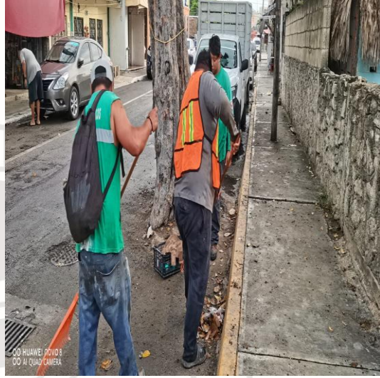
Limpeza de rejillas; Calle mercurio sur entre la av. Tulum y calle 2 poniente.
