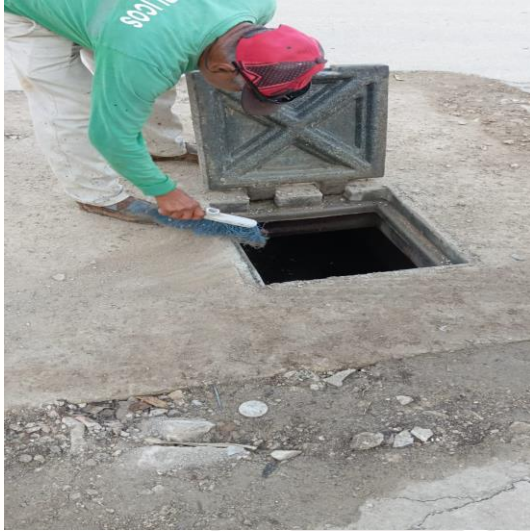
Limpeza de pozos; Calle mercurio poniente entre calle aurora sur.
