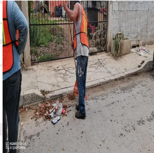
Limpieza de rejillas; Calle 11 entre calle 13.
