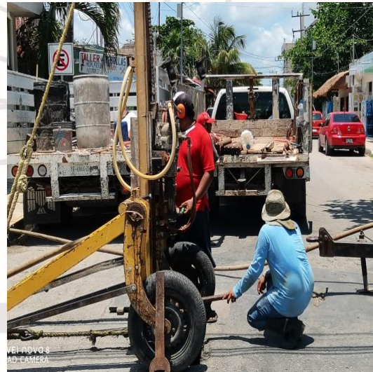
Desazolve de pozos; Calle kii's entre géminis norte, colonia mayapax.
