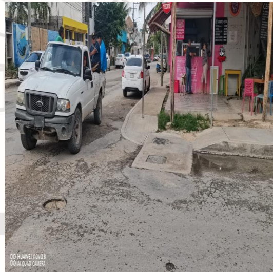
Limpieza de rejillas; Calle tun-k'ul entre calle centauro norte y calle le'xiu.
