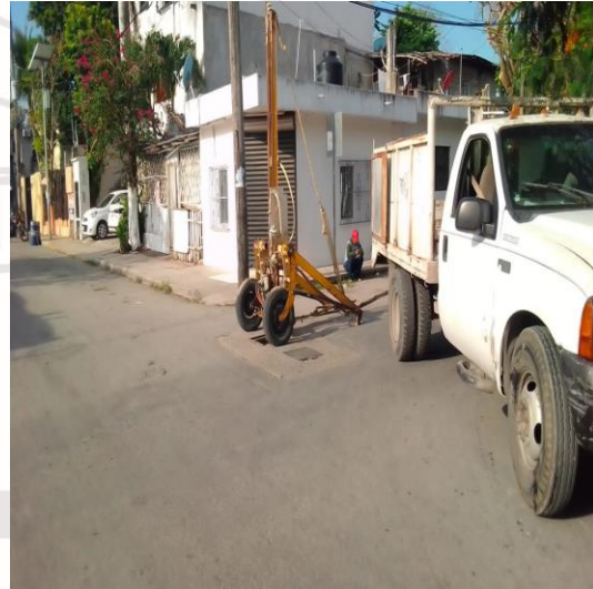
Desazolve de pozos; Calle 2 poniente entre calle Osiris, colonia centro.
