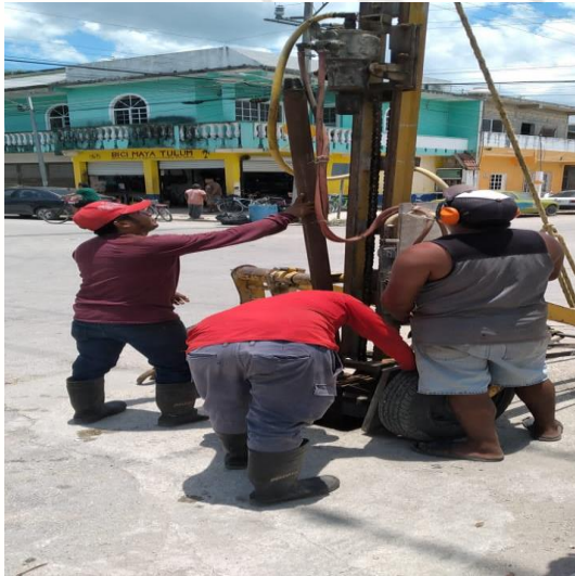
Desazolve de pozos; Calle 2 poniente entre calle orión norte, colonia centro.
