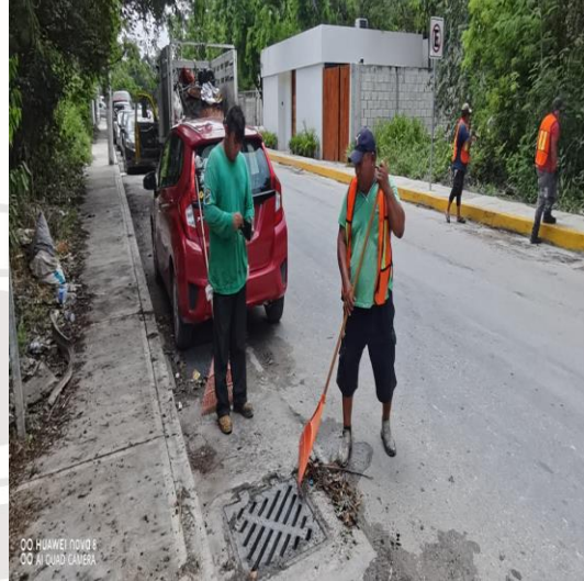
Limpeza de rejillas; Calle 3 sur entre 2 bis y av tulum.
