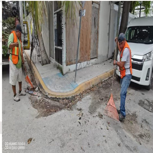
Limpieza de rejillas; Calle andrómada oriente entre la calle orión sur y la calle centauro sur.
