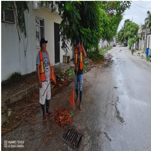
Limpeza de rejillas; Calle géminis sur entre neptuno oriente y venus oriente.
