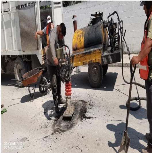
Bacheo; Calle 4 oriente entre calle alfa norte y calle júpiter norte, colonia centro.
