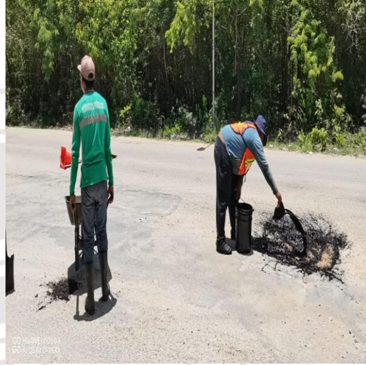
Bacheo; Av. selva entre calle chan caah y calle kohunlich, colonia tumben kaa.
