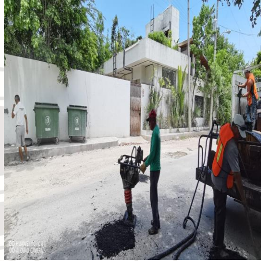
Bacheo; Calle chemuyil entre calle chichen Itzá y akumal, colonia ejido norte.
