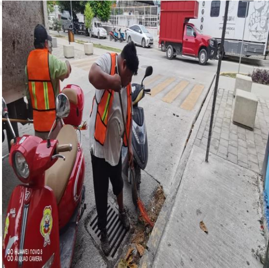
Limpieza de rejillas; Calle andrómeda oriente entre la calle osiris sur y beta sur.
