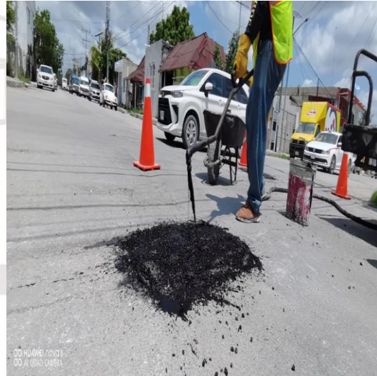
Bacheo; Calle 2 poniente entre calle alfa norte y calle osiris norte, colonia centro.
