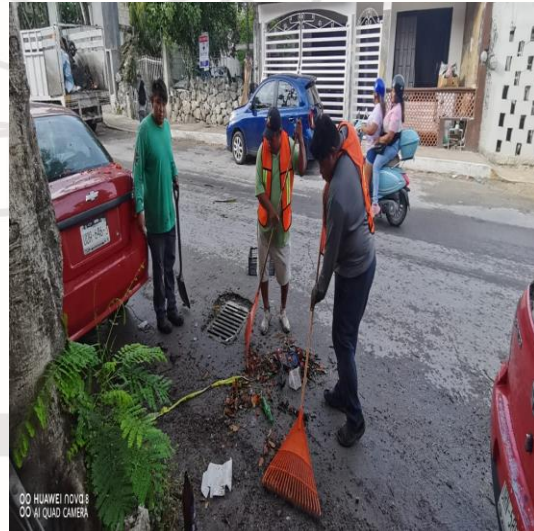
Limpeza de rejillas; Calle mega sur entre la calle sol poniente y neptuno poniente.
