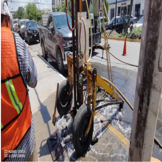
Desazolve de pozos; Av. satélite entre calle 4 oriente y calle 2 poniente, colonia mayapax.
