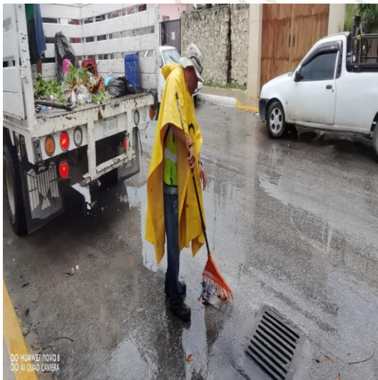
Limpeza de rejillas; Calle acuario poniente entre la calle Luna sur y calle saturno sur.
