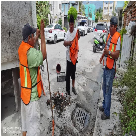
Limpeza de rejillas; Calle huracanes Beulah entre la calle huracanes mitch.
