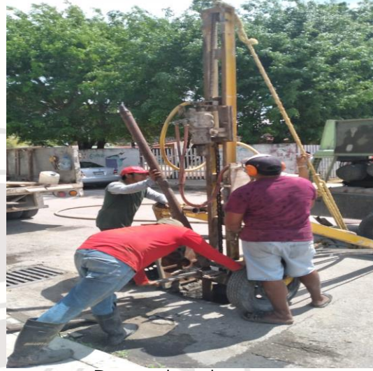
Desazolve de pozos; Calle 4 oriente entre orión norte y calle bubul-lek, colonia mayapax.
