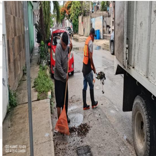
Limpeza de rejillas; Calle géminis sur entre venus oriente y sol oriente.
