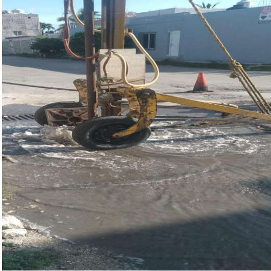
Desazolve de pozos; Calle 4 oriente entre calle 15, colonia centro.
