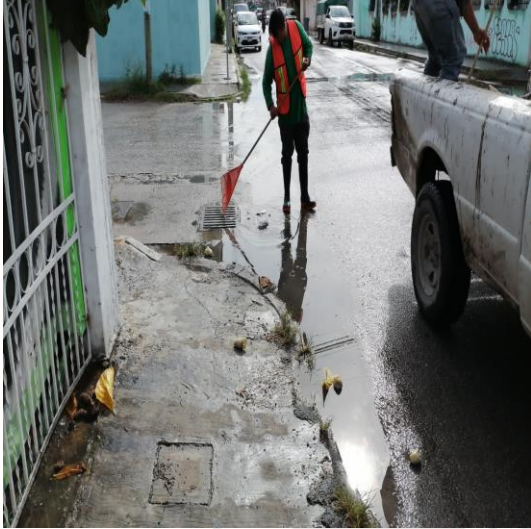
Limpeza de rejillas; Calle 2 oriente y júpiter norte.
