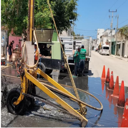
Desazolve de pozos; Calle gama oriente entre calle géminis sur, colonia lak'iin.
