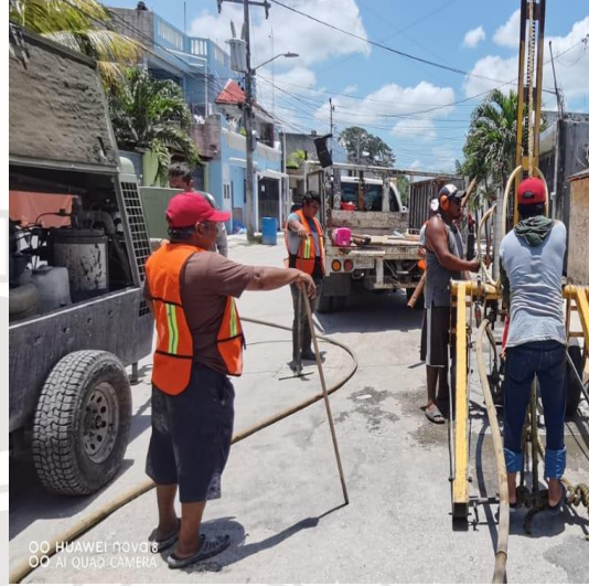
Desazolve de pozos; Calle gama oriente entre ori3n sur, colonia lak'iin.
