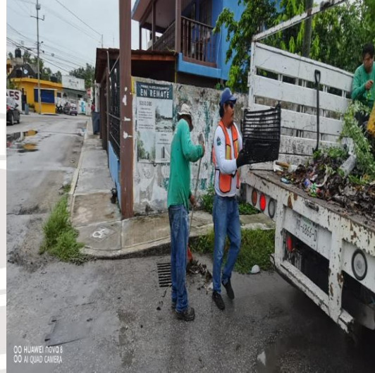
Limpeza de rejillas; Calle Polar poniente entre la calle saturno y la calle luna norte.
