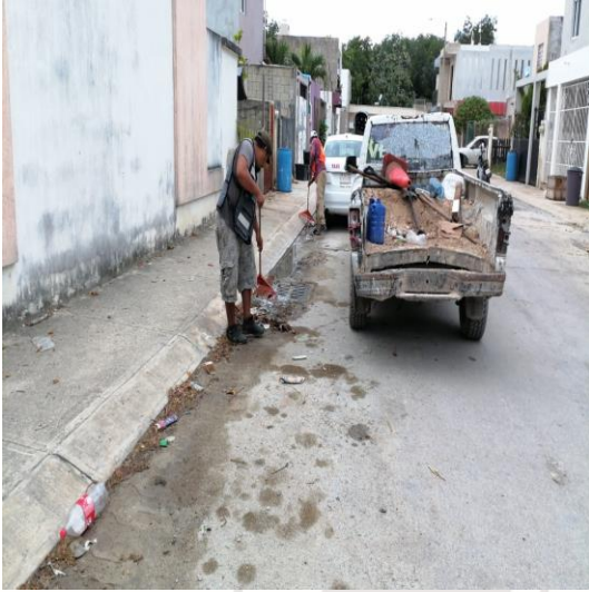
Limpeza de rejillas; Calle palmas chat entre la calle palmas guinea.
