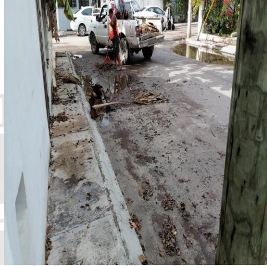
Limpieza de rejillas; Calle 17 sur y calle 2 bis oriente.
