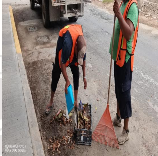
Limpeza de rejillas; Calle sagitario oriente géminis norte y av. satélite.
