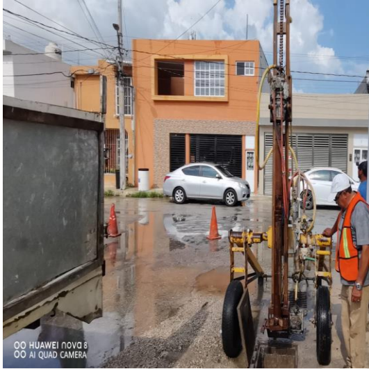
Desazolve de pozos; Calle 2 bis entre calle 11, fraccionamiento villas Tulum.
