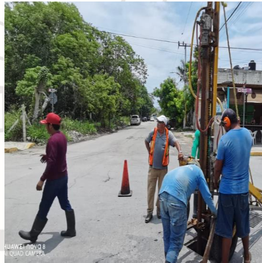
Desazolve de pozos; Calle escorpión norte entre calle 4 oriente, fraccionamiento guerra de castas.
