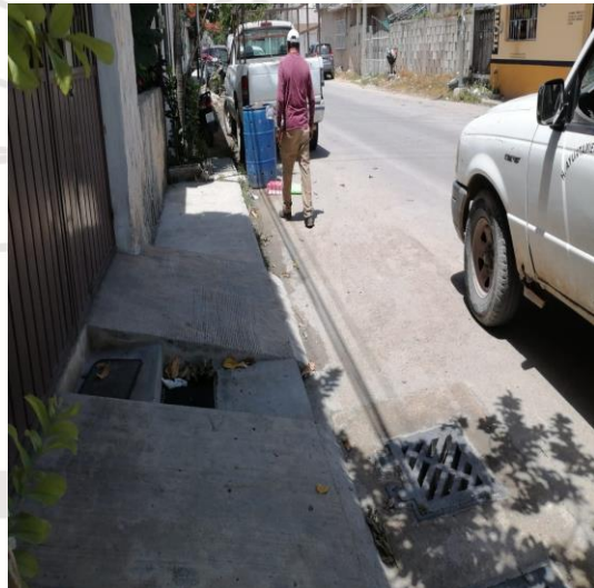
Limpieza de rejillas; Calle sagitario poniente y calle ori3n.
