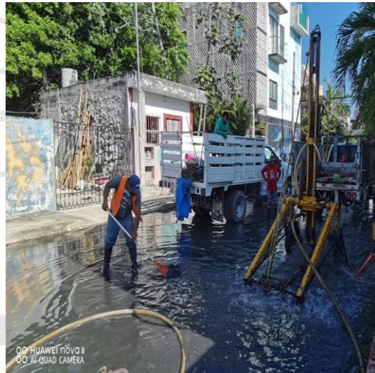
Desazolve de pozos; Calle géminis sur entre venus oriente y calle sol oriente, colonia lak'iin.
