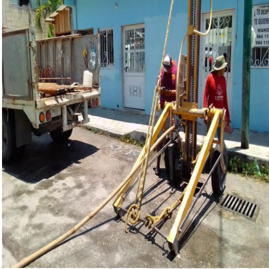
Desazolve de pozos; Calle 4 oriente entre calle alfa y calle 2 poniente, colonia centro.
