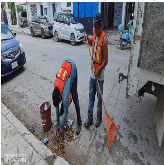
Limpeza de rejillas; Calle andrómada oriente entre calle orión sur y la av. Tulum.
