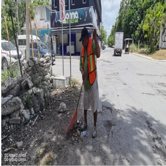
Limpeza de rejillas; Calle géminis norte entre la calle 2 poniente y sagitario oriente.
