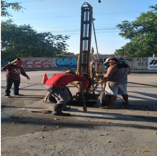
Desazolve de pozos; Calle 2 poniente entre calle sagitario y calle beta, colonia centro.
