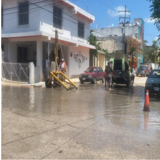
Desazolve de pozos; Calle centauro sur entrecalle asteroides oriente, colonia lak'iin.
