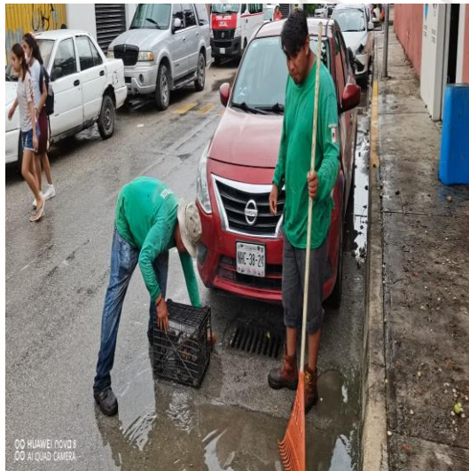
Limpieza de rejillas; Calle 2 poniente entre la calle Osiris norte y la calle beta norte.
