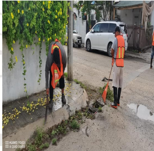
Limpieza de rejillas; Calle 5 sur entre 2a oriente y 2 oriente.
