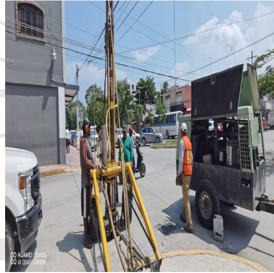
Desazolve de pozos; Av. satélite entre calle 4 oriente y calle bubul-lek, colonia mayapax.
