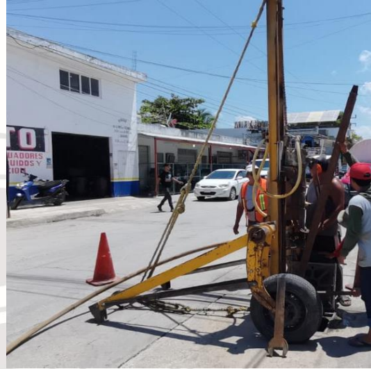
Desazolve de pozos; Calle neptuno oriente entre calle centauro sur, colonia lak'iin.
