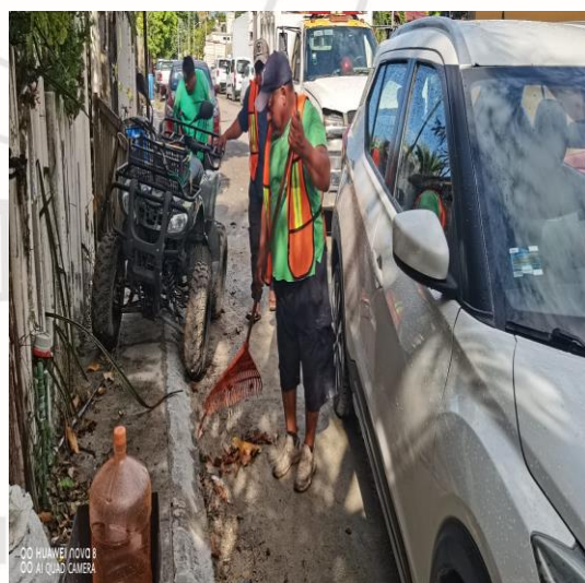
Limpeza de rejillas; Calle 2 bis oriente entre 11.
