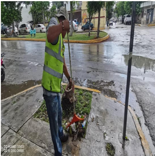
Limpieza de rejillas; Calle andrómada Oriente y av. Satélite.
