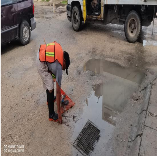
Limpieza de rejillas; Calle 2 bis oriente entre 5 sur y 7 sur.
