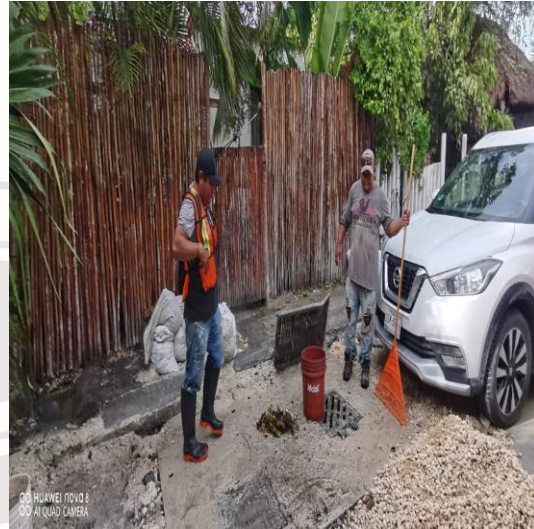
Limpieza de rejillas; Calle 2 bis oriente entre 11.
