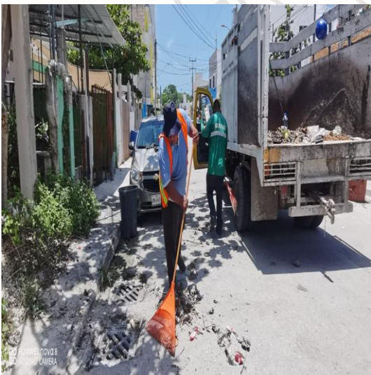
Limpeza de rejillas; Calle belulah entre la calle huracán mitch.
