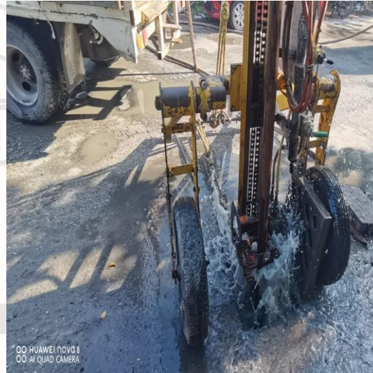
Desazolve de pozos; Av. satélite entre calle 2 oriente, colonia centro.
