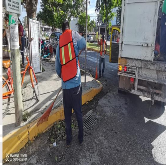
Limpeza de rejillas; Calle andrómeda oriente entre la calle géminis sur y la av. satélite.
