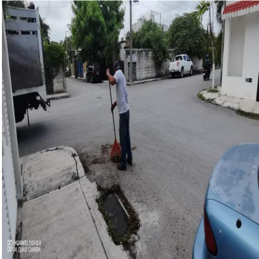
Limpieza de rejillas; Calle 2 oriente entre la calle 3 sur y la calle 11.
