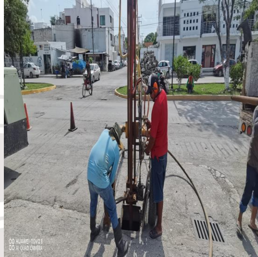
Desazolve de pozos; Av. satélite entre kii's y bubul-lek, colonia mayapax.
