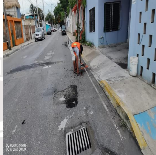
Limpeza de rejillas; Calle asteroides oriente entre beta y ori3n sur.
