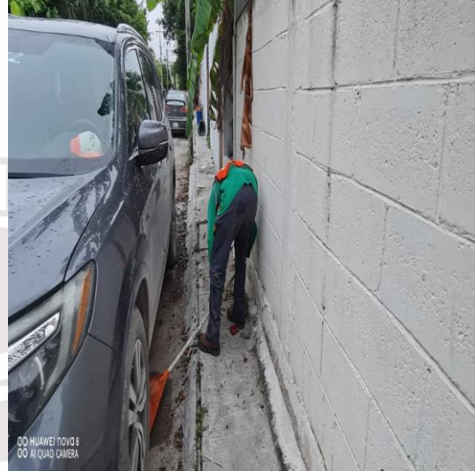
Limpeza de rejillas; Calle 4 oriente entre la calle 17.
