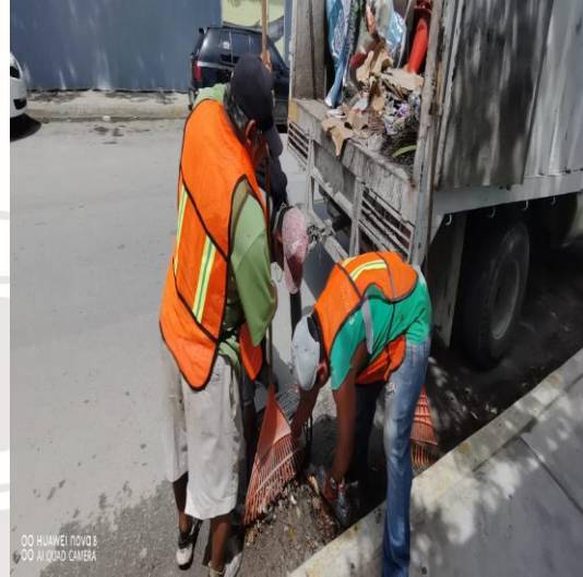
Limpeza de rejillas; Calle júpiter norte entre la calle 4 oriente y la calle tun-k'ul.
