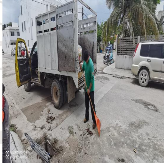
Limpieza de rejillas; Calle 7 sur entre 2 a oriente bis y 2 oriente.
