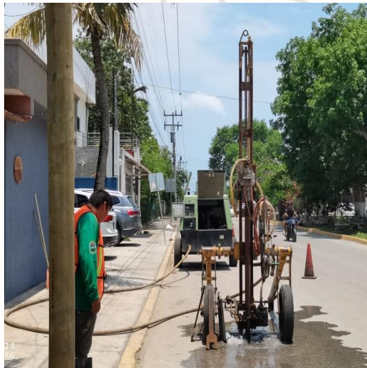
Desazolve de pozos; Av. satélite entre sagitario oriente y calle 2 poniente, colonia centro.
