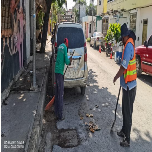
Limpeza de rejillas; Calle Andrómeda oriente entre la calle Osiris sur y la calle beta sur.
