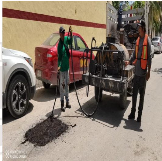
Bacheo; Calle andrómada oriente entre av. Satélite y calle géminis sur, colonia centro sur.
