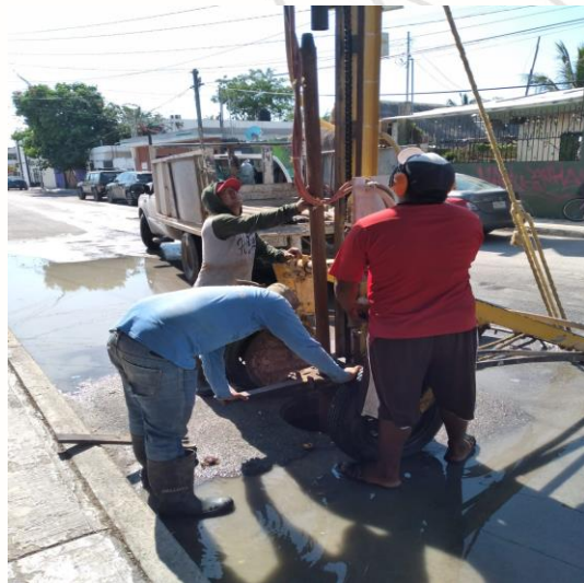
Desazolve de pozos; Calle 4 oriente entre calle chemuyil, fraccionamiento villas Tulum.
