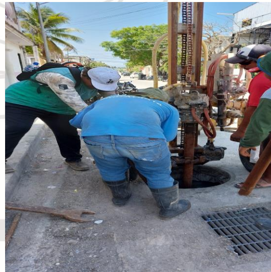
Desazolve de pozos; Calle 4 oriente entre calle alfa norte, colonia centro.
