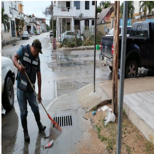
Limpeza de rejillas; Calle centauro norte entre tun-kul.
