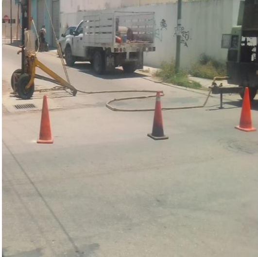
Desazolve de pozos; Calle tun-k'ul entre calle beta norte y ook-k'ot, colonia mayapax.
