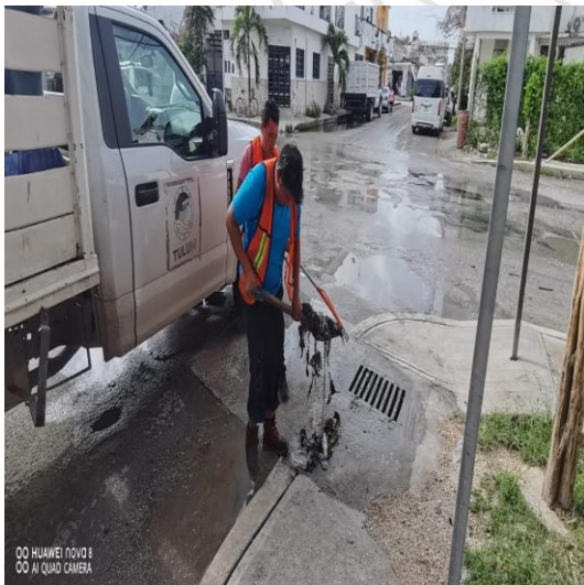
Limpieza de rejillas; Calle tun-k'ul entre calle centauro y calle le'xiu.
