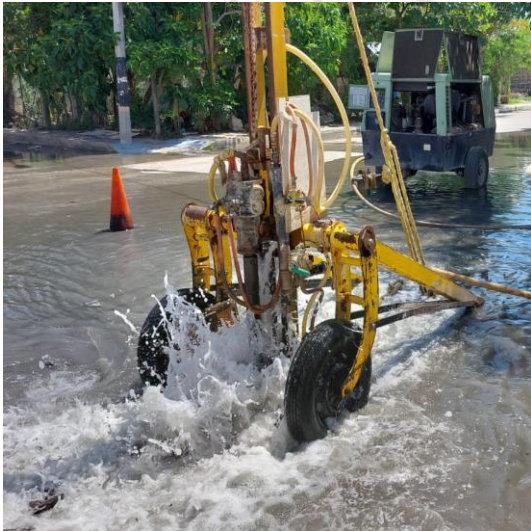
Desazolve de pozos; Calle Cecilio chi entrecalle libra, fraccionamiento guerra de castas.
