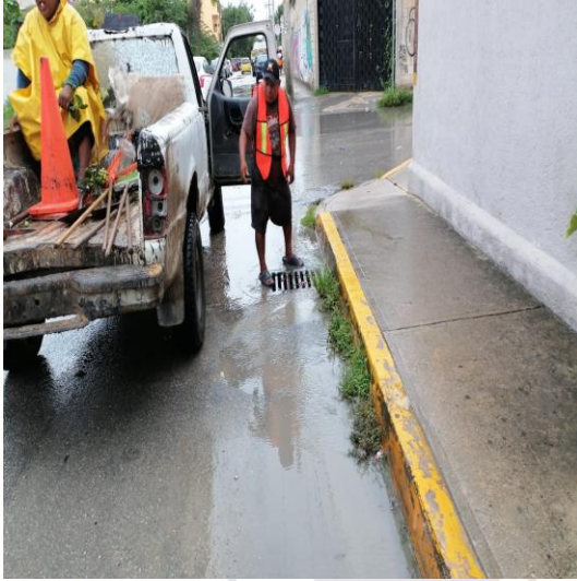
Limpieza de rejillas; Calle Andrómeda oriente y la calle géminis sur.
