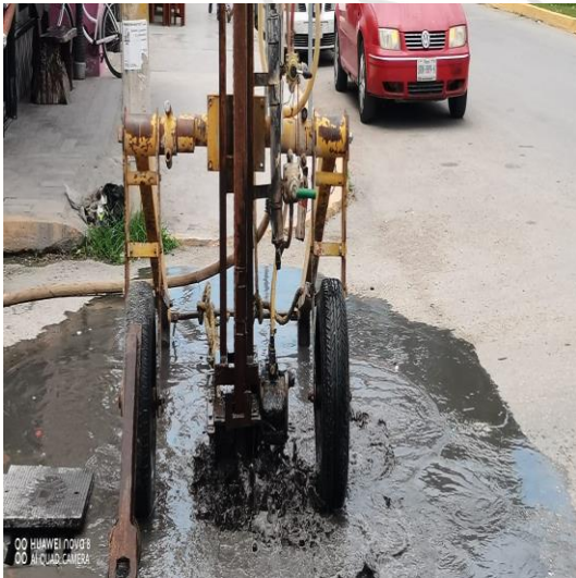
Desazolve de pozos; Av. satélite entre kii's, colonia mayapax.
