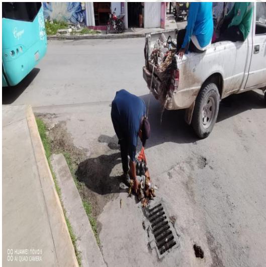
Limpeza de rejillas; Calle polar poniente entre la calle Júpiter norte y la calle alfa norte.
