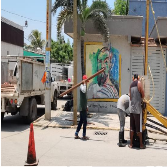
Desazolve de pozos; Av. satélite entre calle polar oriente, colonia centro.
