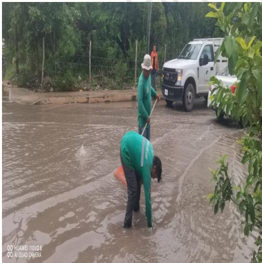
Limpeza de rejillas; Calle faisán entre la calle boca paila y calle chun-yaxche.
