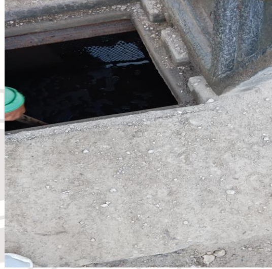
Limpieza de pozos; Calle palma reina entre boulevard palmas Tulum.
