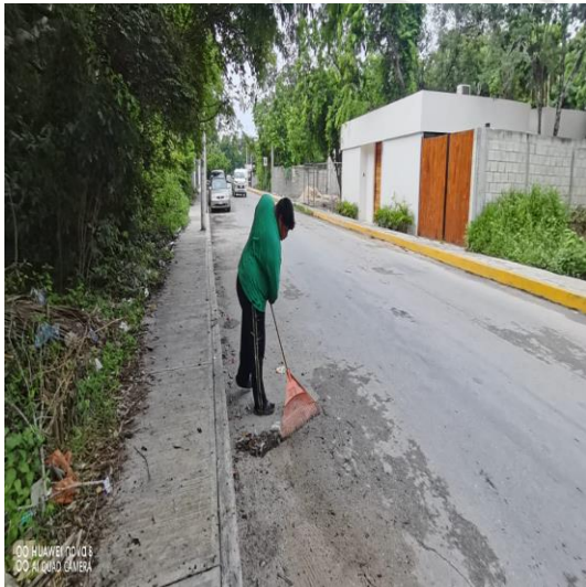
Limpieza de rejillas; Calle 2 oriente entre la calle 5 sur y la calle 2 bis oriente.
