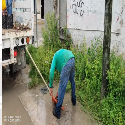
Limpieza de rejillas; Calle 2 poniente entre acuario norte y calle Júpiter norte.
