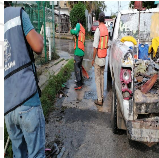
Limpieza de rejillas; Calle sagitario poniente entre calle acuario norte.
