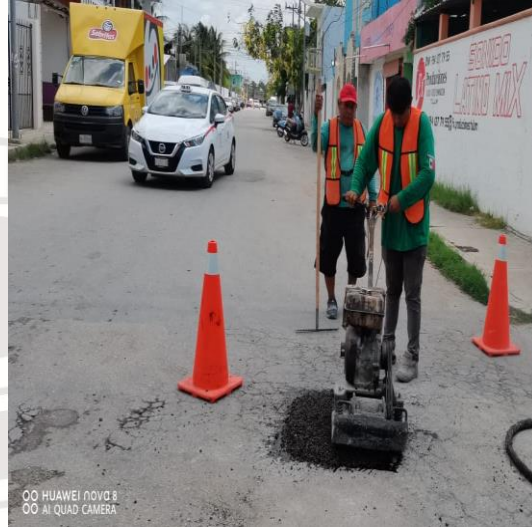
Bacheo; Calle 2 poniente entre calle alfa norte y calle osiris norte, colonia centro.
