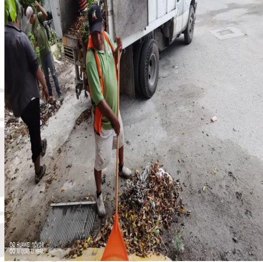
Limpieza de rejillas; Calle 2 bis oriente entre la calle 7 sur.
