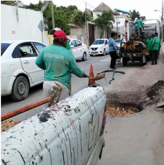
Bacheo; Calle sagitario poniente entre calle polar poniente y calle júpiter norte, Colonia centro norte.
