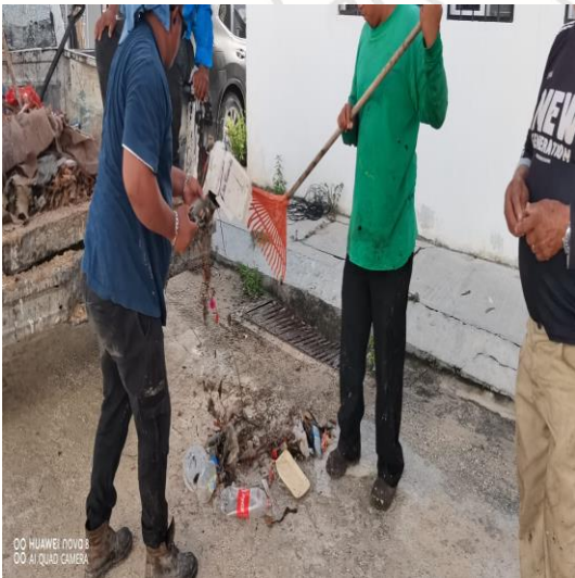
Limpieza de rejillas; Calle 7 sur entre la calle 2 oriente.
