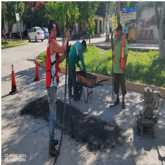
Bacheo; Av. satélite sur entre calle venus oriente y calle neptuno oriente, colonia centro.
