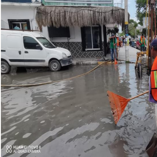
Desazolve de pozos; Calle polar poniente entre av. Satélite, colonia centro.
