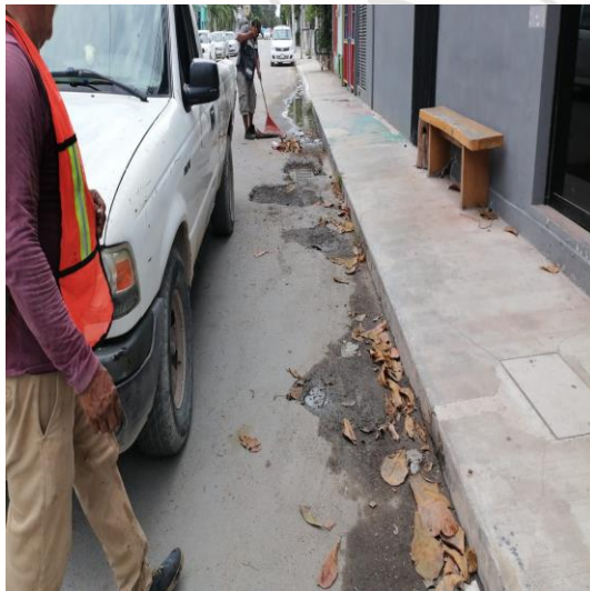
Limpieza de rejillas; Calle sol oriente y calle beta sur.
