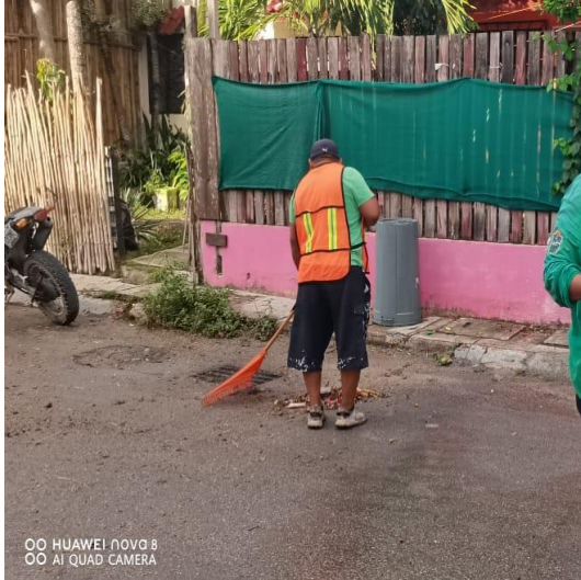
Limpeza de rejillas; Calle 4 oriente entre 15.
