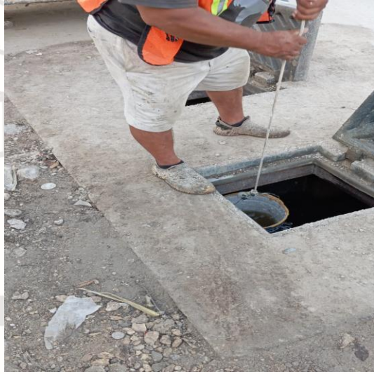
Limpieza de pozos; Calle palma guinea entre calle palma yagua y calle palma rapis.
