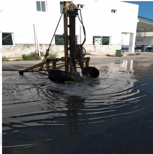
Desazolve de pozos; Av. coba (transito).
