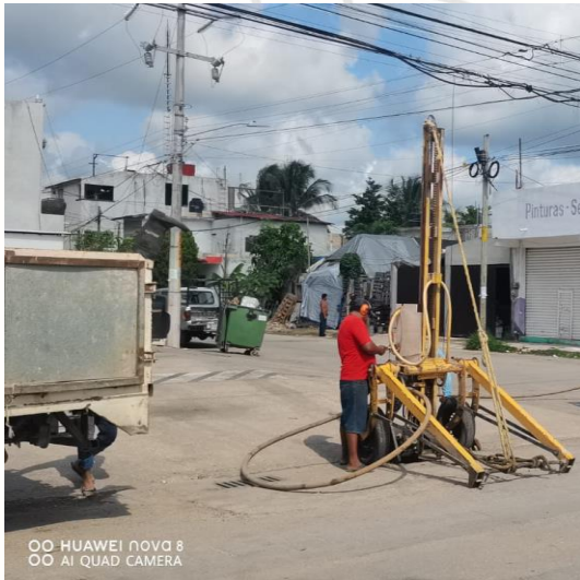
Desazolve de pozos; Calle libra norte entre 4 oriente, fraccionamiento guerra de castas.
