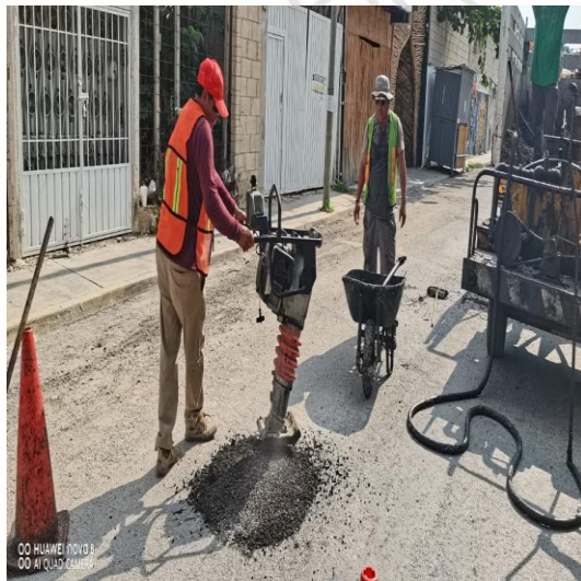
Bacheo; Calle venus oriente entre la calle av. osiris sur y calle beta sur, colonia centro.
