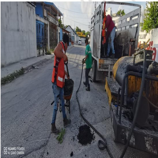
Bacheo; Av. Kukulcán entre calle saturno norte y calle polar poniente, colonia luna.
