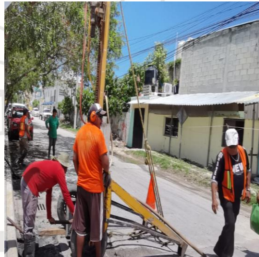
Desazolve de pozos; Calle neptuno entre calle beta sur, colonia lak'iin.
