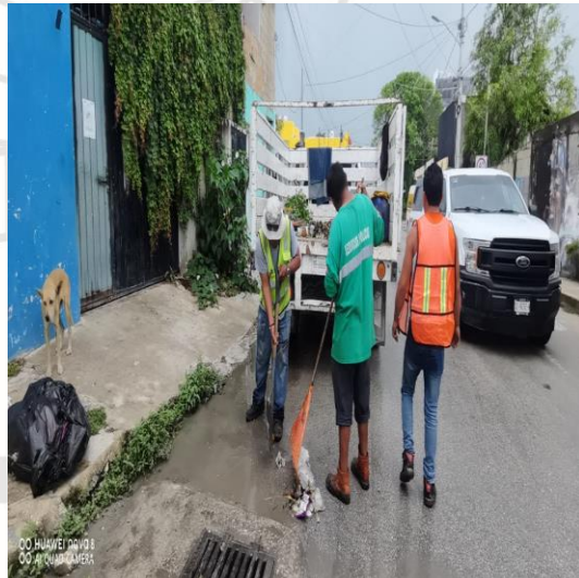
Limpeza de rejillas; Calle neptuno poniente entre la calle omega sur y calle aurora sur.
