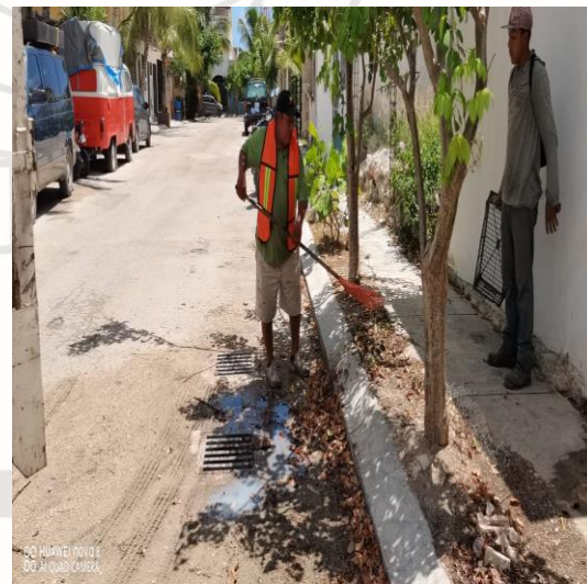
Limpeza de rejillas; Calle tepich entre calle 2 poniente.
