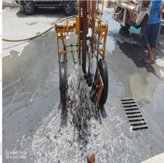
Desazolve de pozos; Calle le'xiu entre calle tun-k'ul, colonia mayapax.
