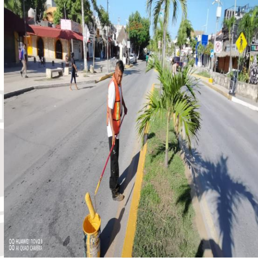
Pintura; Av. Tulum entre la calle centauro y av. coba.
