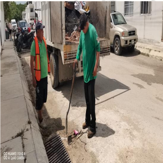
Limpieza de rejillas; Calle 7 sur entre 2 a oriente.
