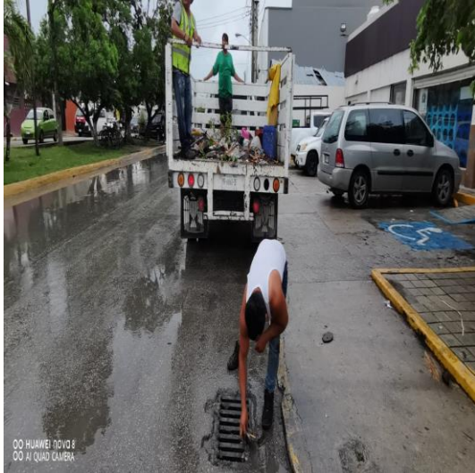
Limpieza de rejillas; av. Satélite entre calle 2 poniente y calle 4 oriente.
