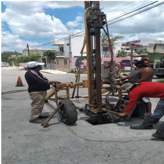
Desazolve de pozos; Calle sagitario poniente entre calle alfa norte, colonia centro.
