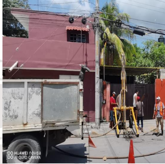
Desazolve de pozos; Calle géminis norte entre calle 2 oriente, fraccionamiento guerra de castas.
