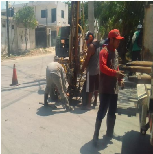
Desazolve de pozos; Calle júpiter norte entre calle 2 poniente, colonia luna.
