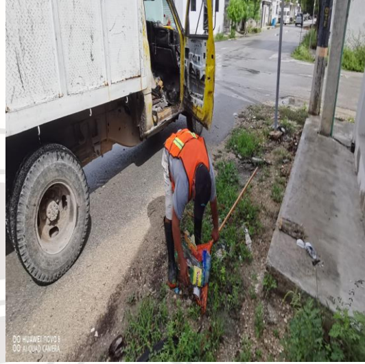
Limpeza de rejillas; Calle géminis sur entre asteroides y gama oriente.
