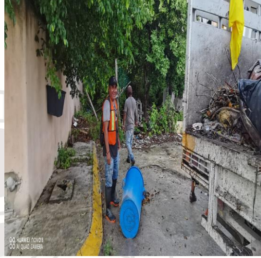
Limpieza de rejillas; Calle 2 bis oriente entre 7 sur y 5 sur.
