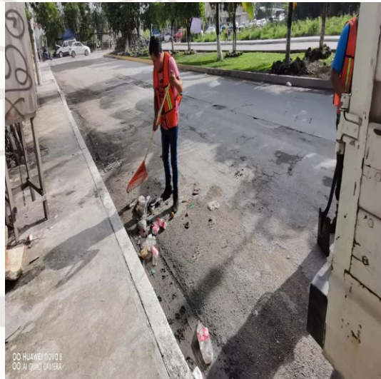
Limpieza de rejillas; Av. Satélite entre av. ook-k'ot y calle tun-k'ul.
