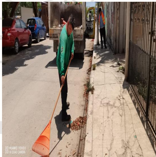
Limpeza de rejillas; Calle gama oriente entre la calle centauro sur y Av. Satélite.
