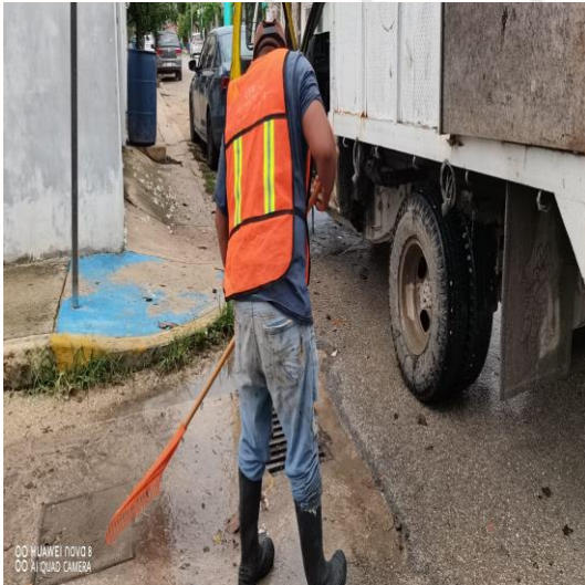
Limpeza de rejillas; Calle asteroides oriente entre centauro y ori3n sur.
