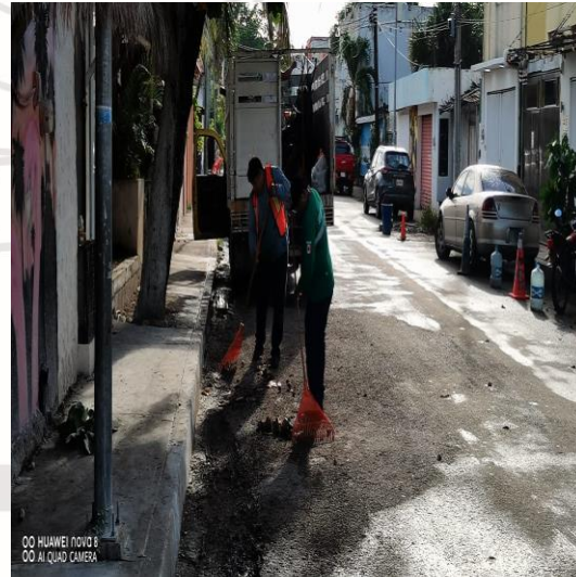
Limpieza de rejillas; Calle andrómeda oriente entre calle orión sur.
