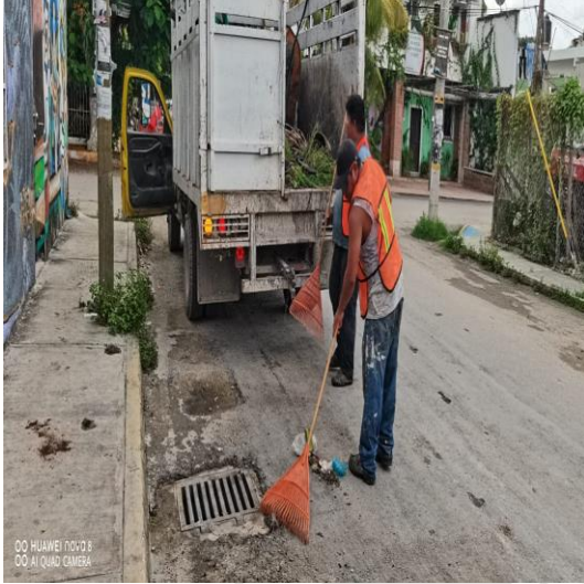
Limpeza de rejillas; Calle venus oriente entre la calle osiris sur y la calle beta sur.
