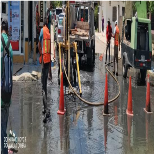
Desazolve de pozos; Calle gama oriente entre ori3n sur y calle centauro, colonia lak'iin.
