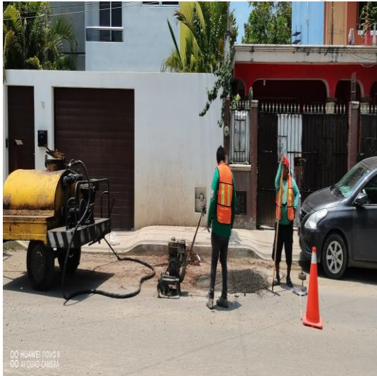
Bacheo; Calle golondrina entre calle chanchen y calle sian ka´an, colonia ejido.
