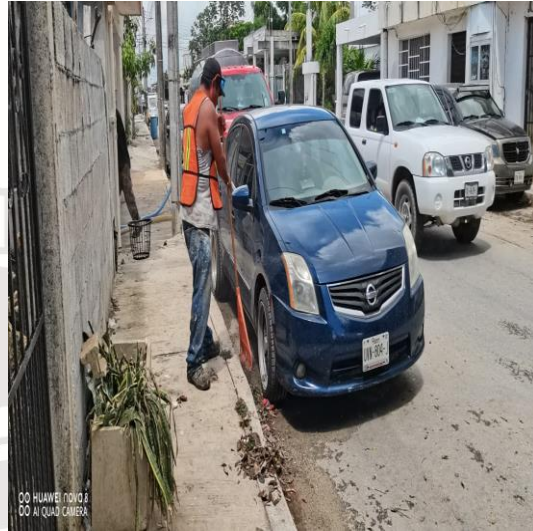
Limpeza de rejillas; Calle gama oriente entre la calle centauro sur y la av. satélite.
