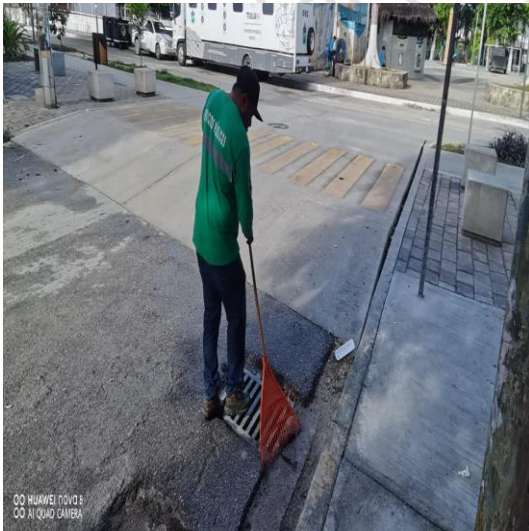
Limpeza de rejillas; Calle andr6meda oriente entre la calle osiris sur y la calle beta sur.
