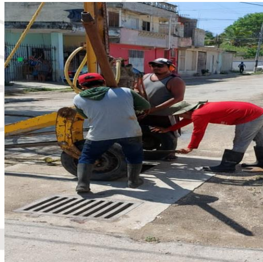
Desazolve de pozos; Calle géminis norte entre calle tun-k'ul, colonia mayapax.
