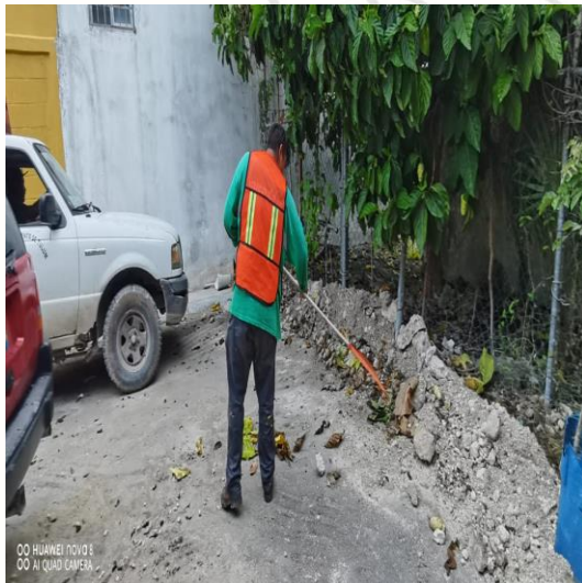
Limpeza de rejillas; Calle 3 sur entre la calle 2 bis oriente y la av. Tulum.
