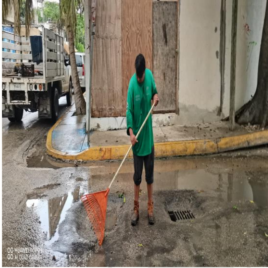
Limpieza de rejillas; Calle Andrómeda oriente entre calle Orión sur y calle centauro sur.
