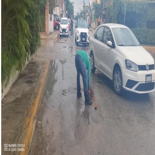
Limpieza de rejillas; Calle polar poniente entre la calle beta norte y la calle Osiris norte.
