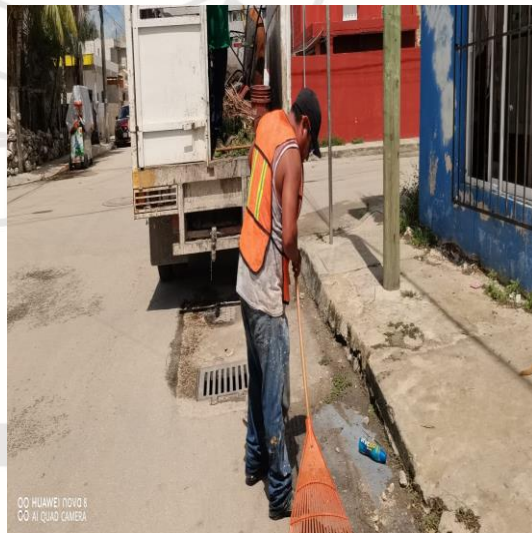
Limpeza de rejillas; Calle neptuno oriente entre calle centauro sur y calle gama oriente.
