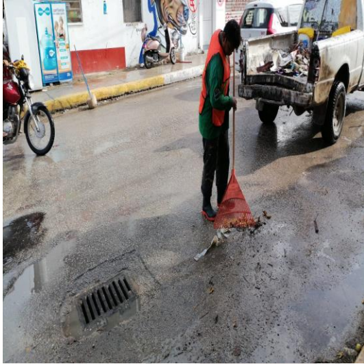
Limpieza de rejillas; Calle polar oriente entre beta norte.
