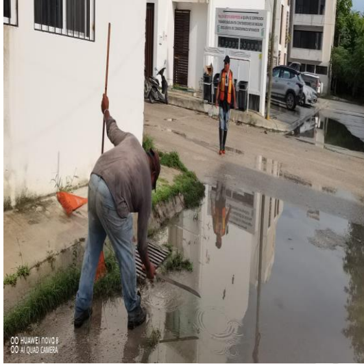
Limpieza de rejillas; Calle 7 sur entre 2a oriente y 2 oriente.
