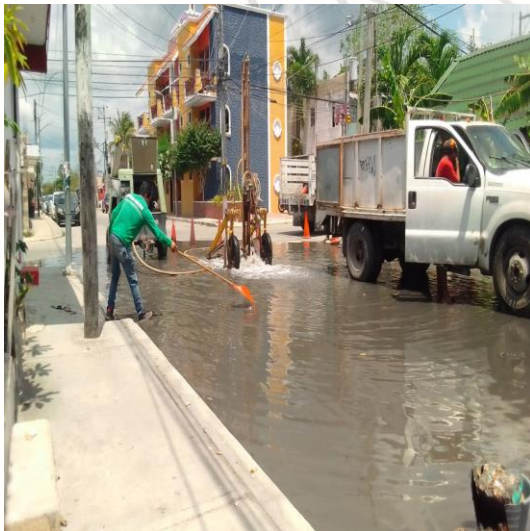
Desazolve de pozos; Calle 2 oriente entre calle orión, colonia centro.
