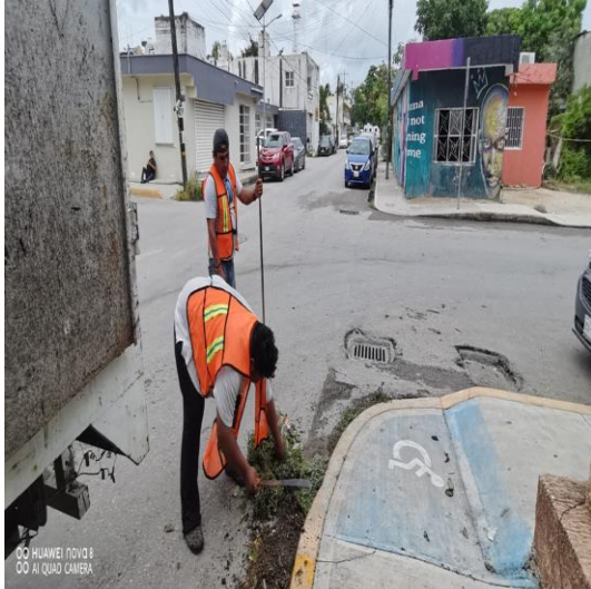
Limpieza de rejillas; Calle andrómada oriente entre la calle beta sur y la calle orión sur.
