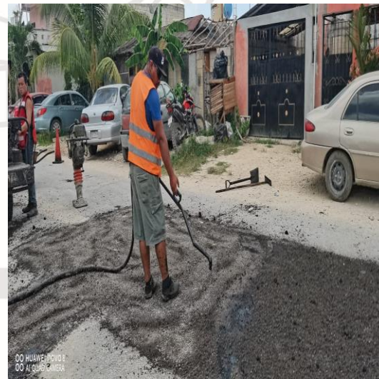
Bacheo; Calle Jaaleeb entre calle Tz'uib, fraccionamiento xul kaa.
