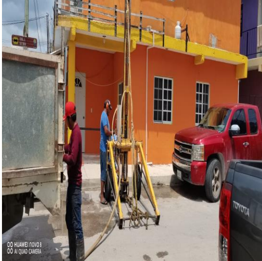
Desazolve de pozos; Calle Jacinto Pat entre calle 2 oriente, fraccionamiento guerra de castas.
