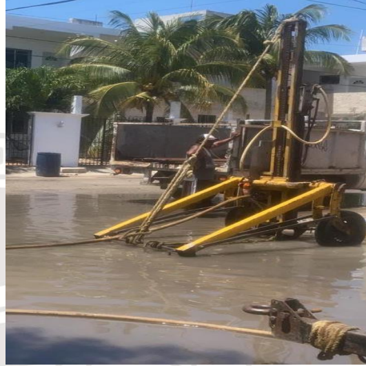
Desazolve de pozos; Calle ori3n sur entre calle asteroides oriente, colonia lak'iin.
