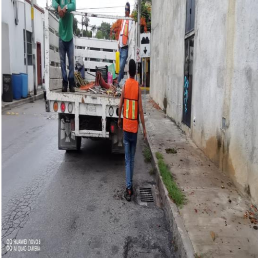
Limpieza de rejillas; Calle sagitario oriente entre calle Osiris norte y calle alfa norte.
