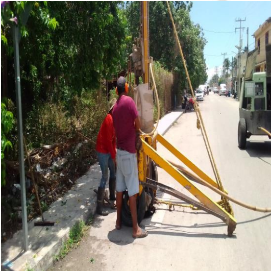
Desazolve de pozos; Calle 4 oriente entre calle alfa y osiris, colonia mayapax.
