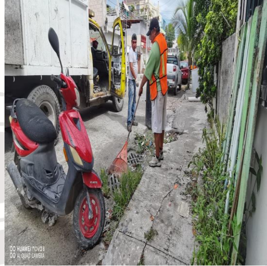
Limpeza de rejillas; Calle huracanes Rossana entre la calle huracanes paulina.
