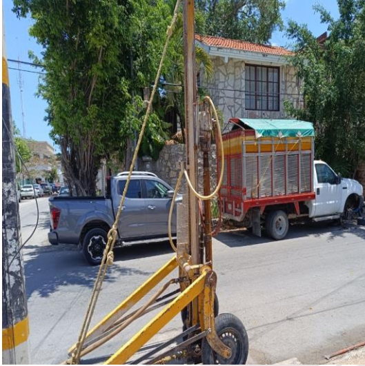
Desazolve de pozos; Calle sagitario oriente entre géminis norte, colonia centro.
