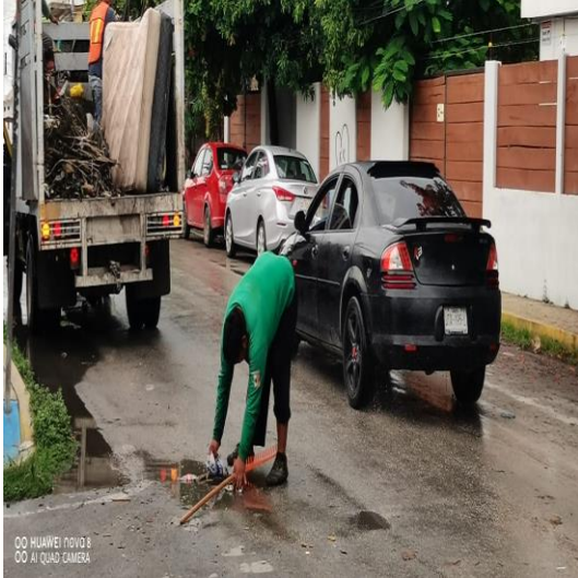
Limpeza de rejillas; Calle neptuno oriente entre centauro y ori3n sur.
