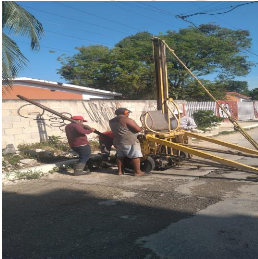
Desazolve de pozos; Calle kii's entre calle tun-ku'l, colonia mayapax.
