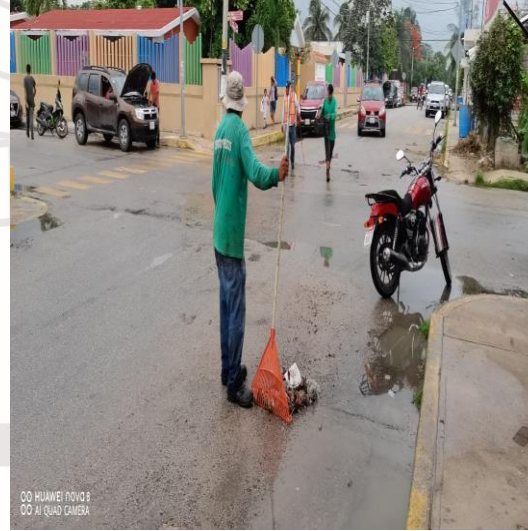
Limpieza de rejillas; Calle 2 poniente entre calle beta norte y calle Orión norte.
