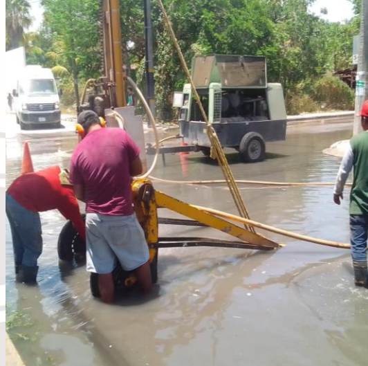
Desazolve de pozos; Calle 2 poniente entre calle alfa norte, colonia centro.
