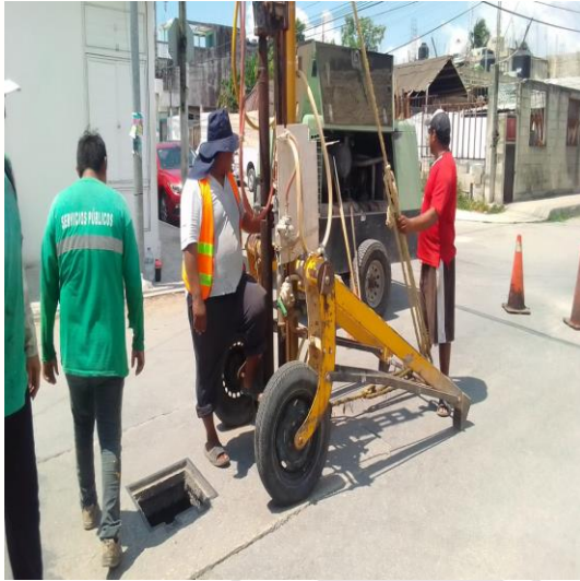
Desazolve de pozos; Calle 4 oriente entre calle omega norte, colonia centro.
