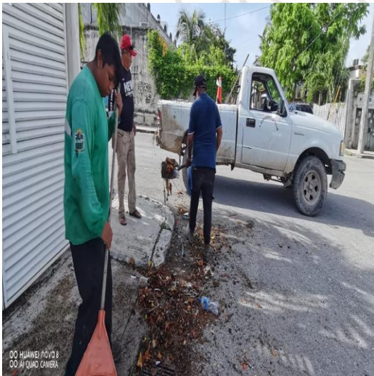
Limpieza de rejillas; Calle 11 entre la calle 3 sur y la calle 13.
