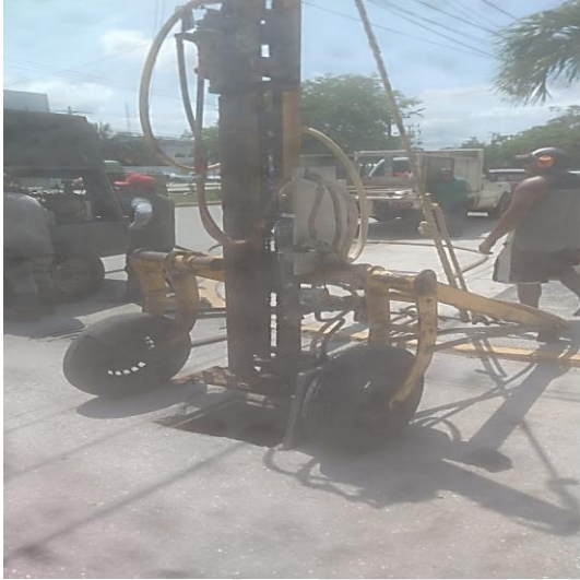
Desazolve de pozos; Av. satélite entre calle tun-k'ul, colonia mayapax.
