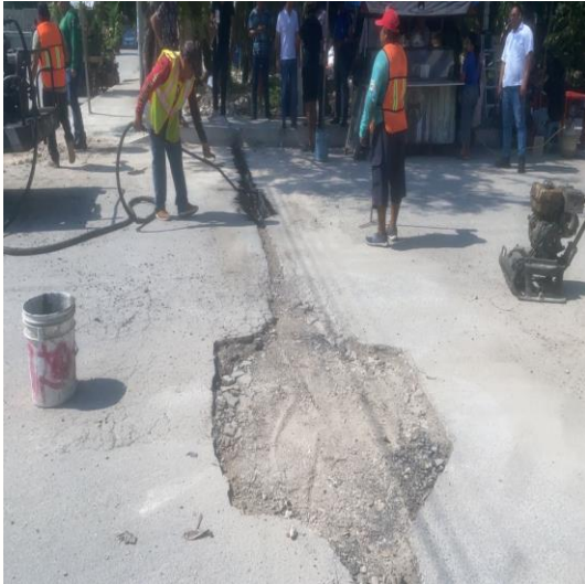
Bacheo; Calle tun-k'ul entre calle osiris norte y calle alfa norte, colonia centro.
