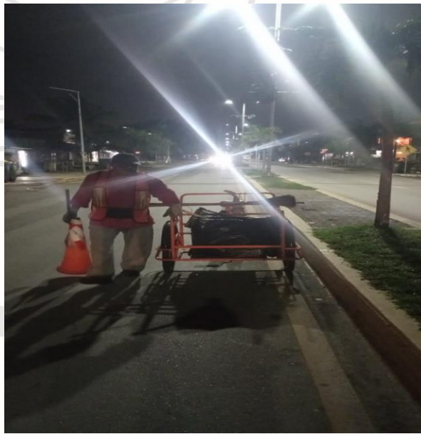
Camellón central de la av. Tulum entre calle acuario y av. satélite; otras calles.
