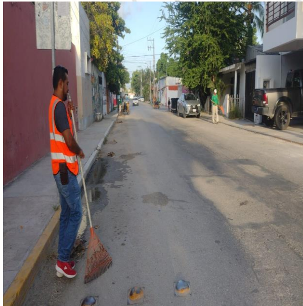
Calle polar poniente entre av. Satélite y calle acuario norte; sector 2.
