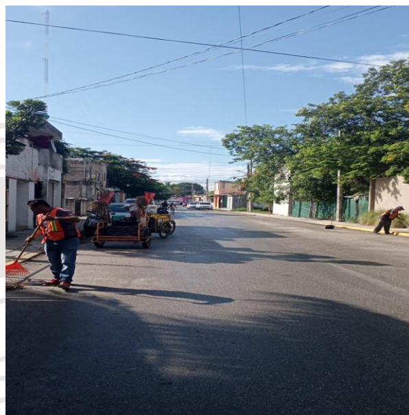
Calle júpiter sur entre av. Tulum y av. ook-k'ot (altura del cárcamo).
