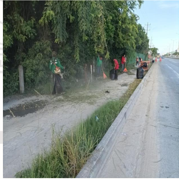
Poda de césped; caseta de filtro Tulum-playa del Carmen.
