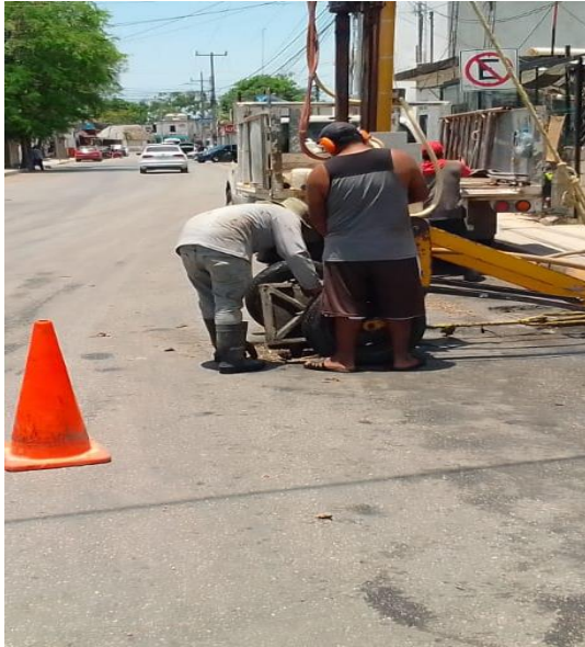
Desazolve de pozos; Calle lexiu entre ori3n norte.
