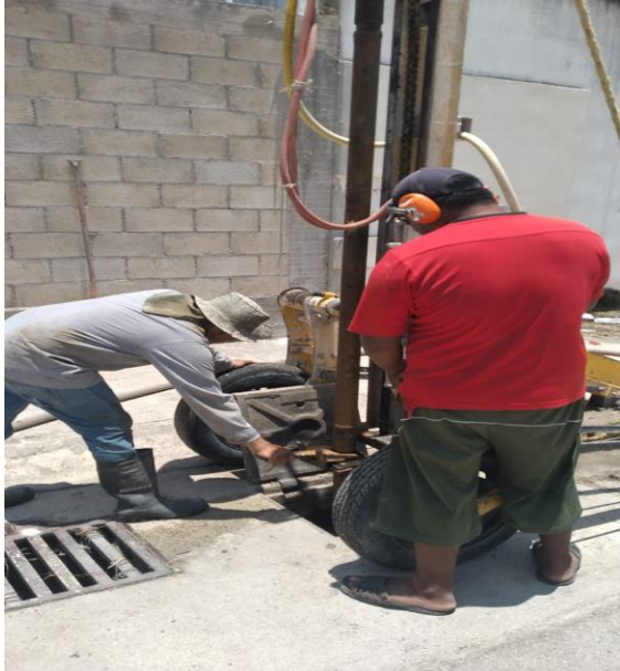
Desazolve de pozos; Calle júpiter norte entre polar poniente.
