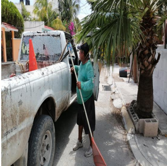
Limpeza De Rejillas: Calle 2 bis oriente y la calle 3 sur
