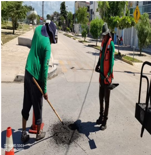
Bacheo; Calle mercurio poniente entre calle Osiris sur y calle beta sur
