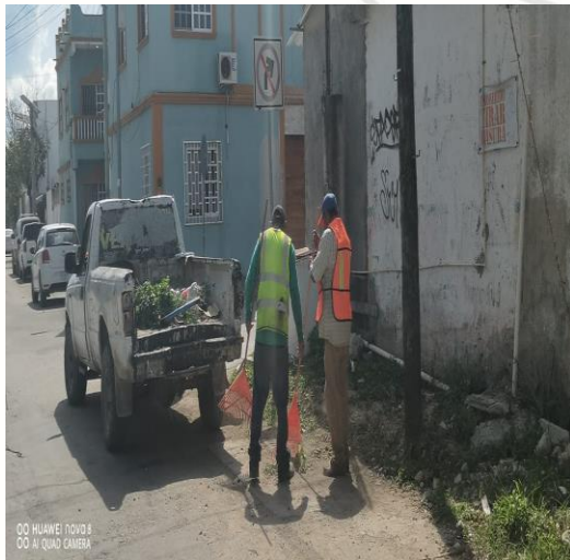
Limpeza de rejillas; Calle 2 poniente entre calle júpiter y calle mega norte.
