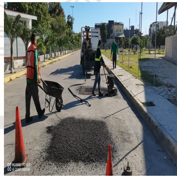
Bacheo; calle gama oriente entre alfa sur y osiris sur.
