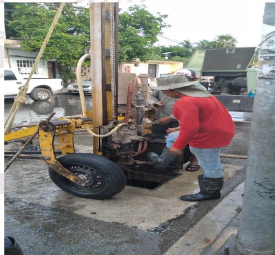
Desazolve de pozos; Calle centauro norte entre sagitario oriente.
