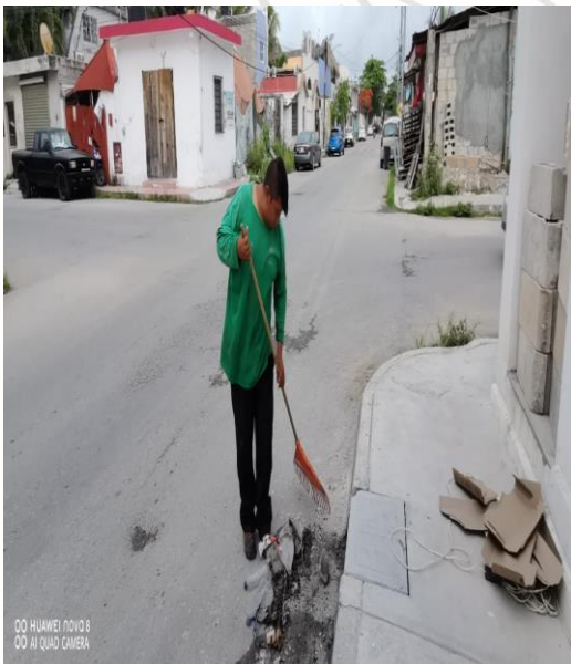
Limpeza De Rejillas: Calle sagitario oriente entre la calle Orión norte y la calle beta norte
