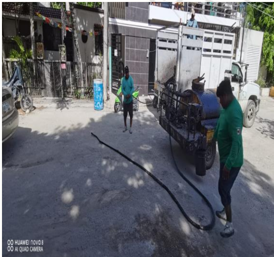
Bacheo; Fraccionamiento Villas Tulum. Calle chemuyil entre la calle 4 oriente y la calle 17
