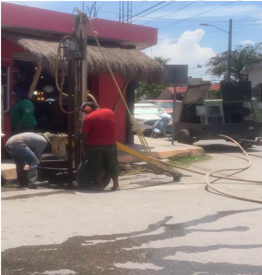
Desazolve de pozos; Calle Ontario poniente entre saturnino sur.
