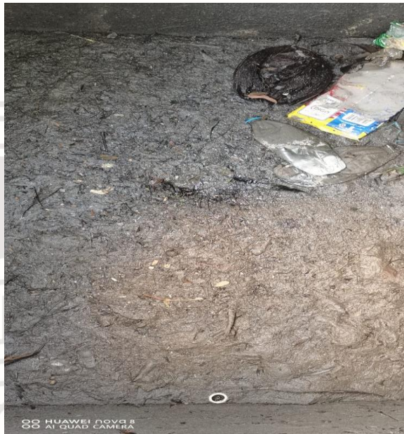
Limpieza de pozos; Calle osiris norte / 2 oriente.
