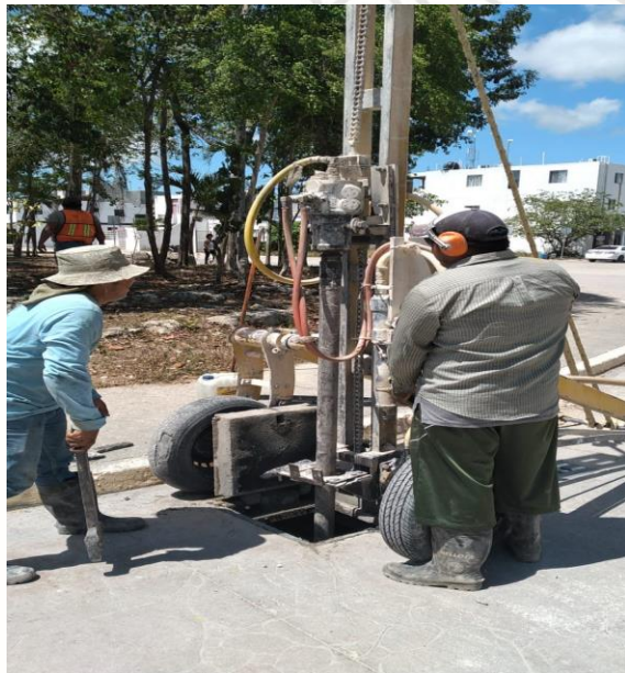
Desazolve de pozos; Calle bulevar entre palmas reina.
