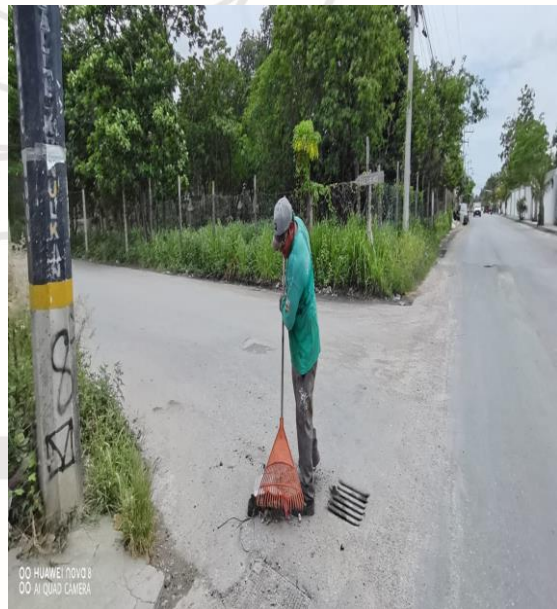
Limpeza De Rejillas: Av. kukulkan entre la calle chac-mool y calle crocodilo
