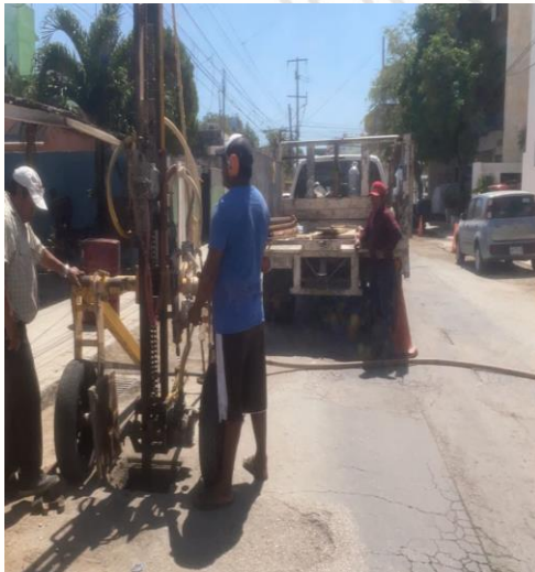
Desazolve de pozos; Calle omega sur entre saturno poniente.
