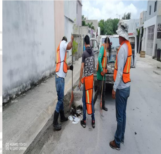
Limpeza De Rejillas: Calle palmas chat y la calle palma guinea
