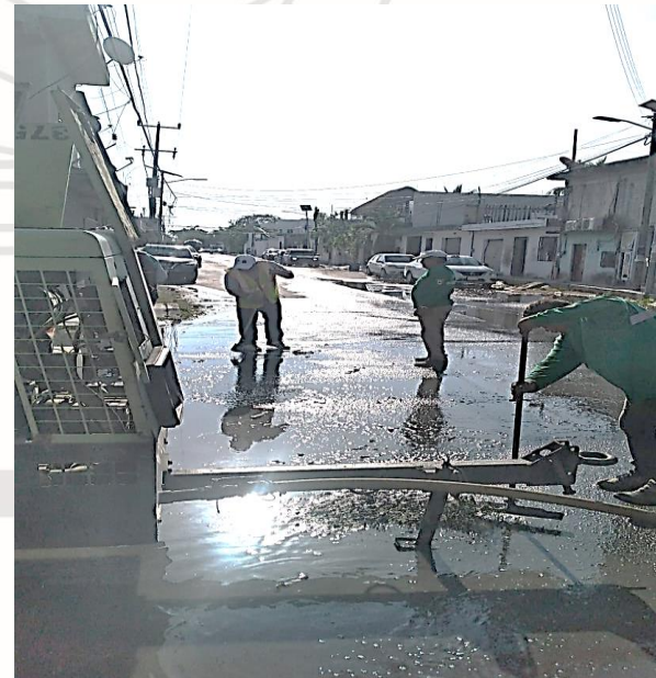
Desazolve de pozos; Calle sagitario oriente entre acuario norte.
