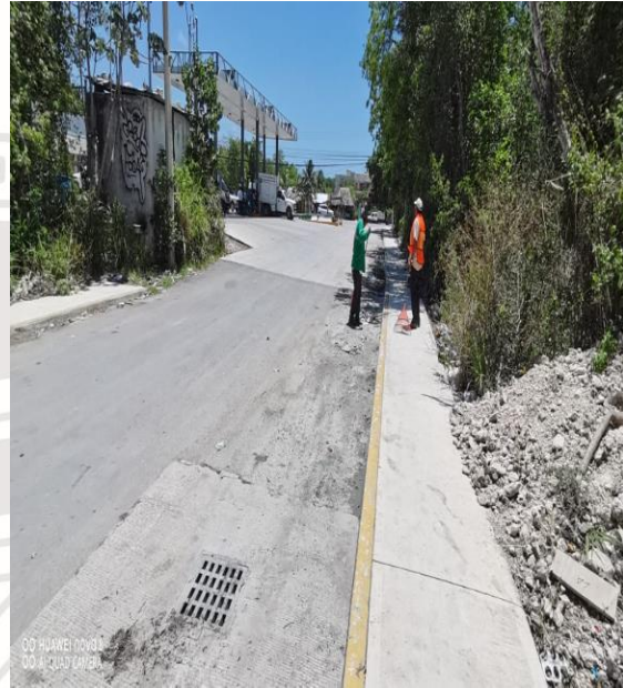
Limpieza de rejillas; Av. La selva entre calle conhunlich y av. Tulum.
