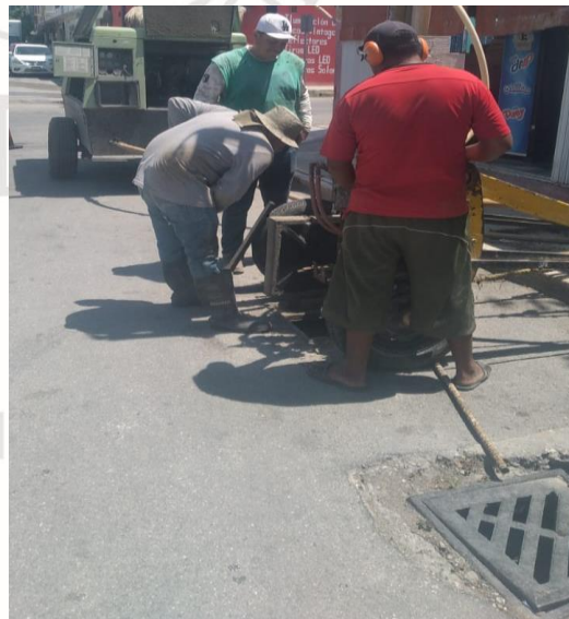
Desazolve de pozos; Calle mercurio poniente entre júpiter sur.
