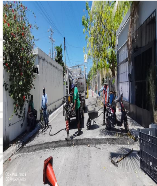
Bacheo; Calle 2 bis oriente entre calle 15 y calle 13
