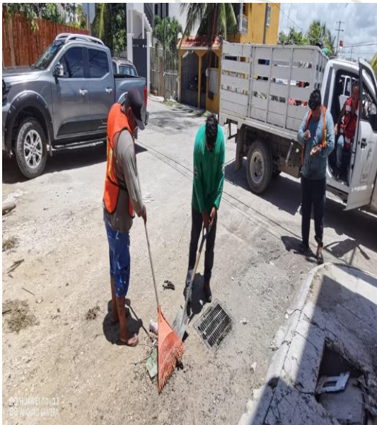
Limpeza De Rejillas: Calle bis 2 oriente entre la calle 3 sur y calle 5 sur
