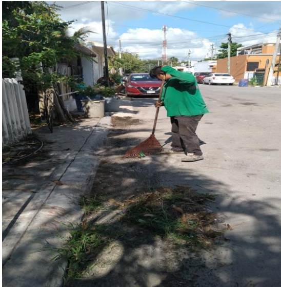
Limpeza de rejillas; Calle 7 entre calle 2 bis.
