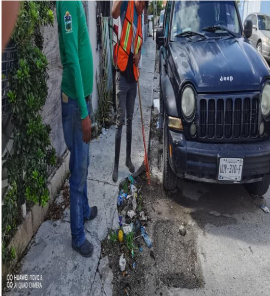
Limpieza de rejillas; Calle Rossana entre la calle huracán Mitch
