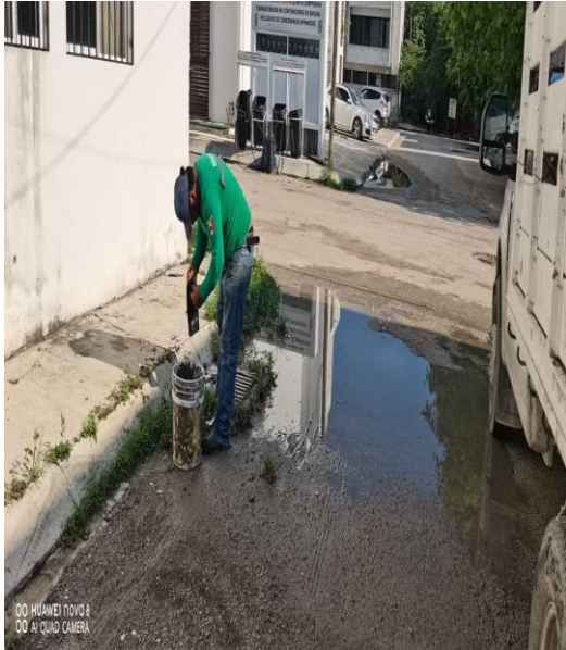
Limpeza de rejillas; Calle 7 sur entre la calle 2 a oriente y calle 2 oriente
