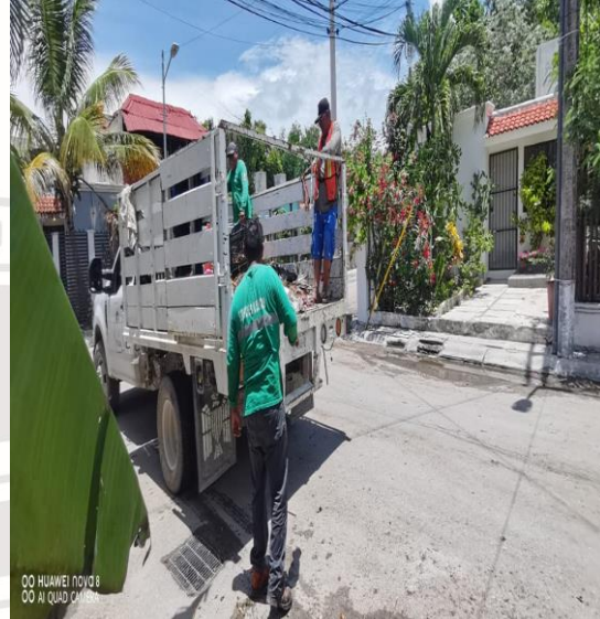
Limpeza De Rejillas: Calle 17 entre 2 bis oriente
