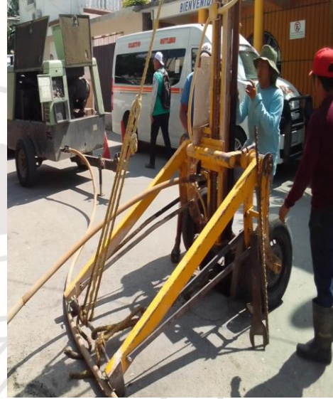
Desazolve de pozos; Calle mercurio poniente entre omega sur.
