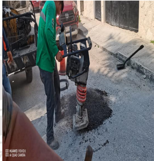
Bacheo; Calle 11 entre la calle 6 oriente y la calle 6 oriente y la calle 2 oriente
