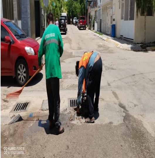
Limpeza De Rejillas: Calle 2 poniente entre la calle escorpión norte y la calle tepich
