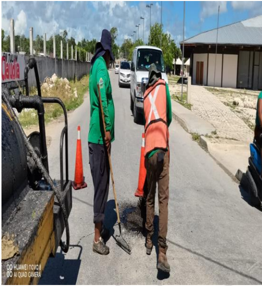
Bacheo; Calle mercurio poniente entre calle Osiris sur y calle beta sur
