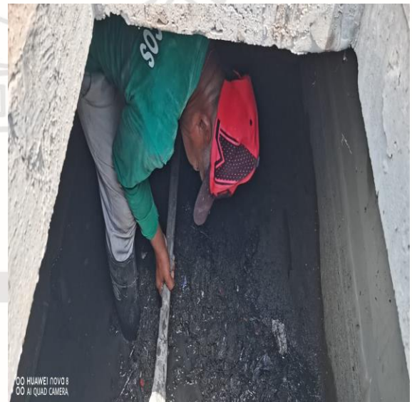
Limpeza de pozos; alle tun-kul / beta norte y 2 oriente.
