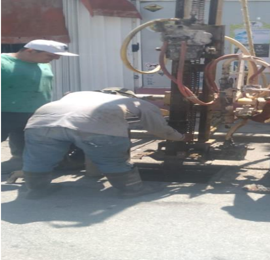
Desazolve de pozos; Calle sol poniente entre acuario sur.
