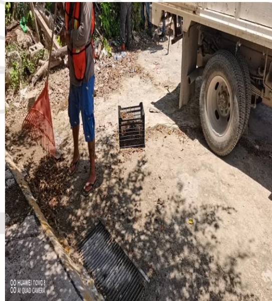
Limpeza De Rejillas: Calle 2 bis oriente entre la calle 5 sur y 7 sur
