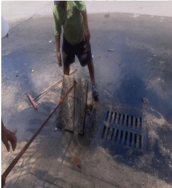
Desazolve de pozos; Calle palmas rapiz entre palmas guineas.
