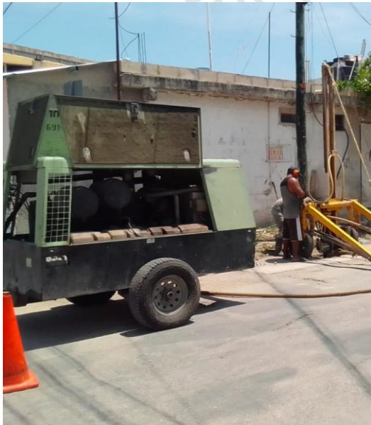
Desazolve de pozos; Calle 7 sur entre 16 sur.
