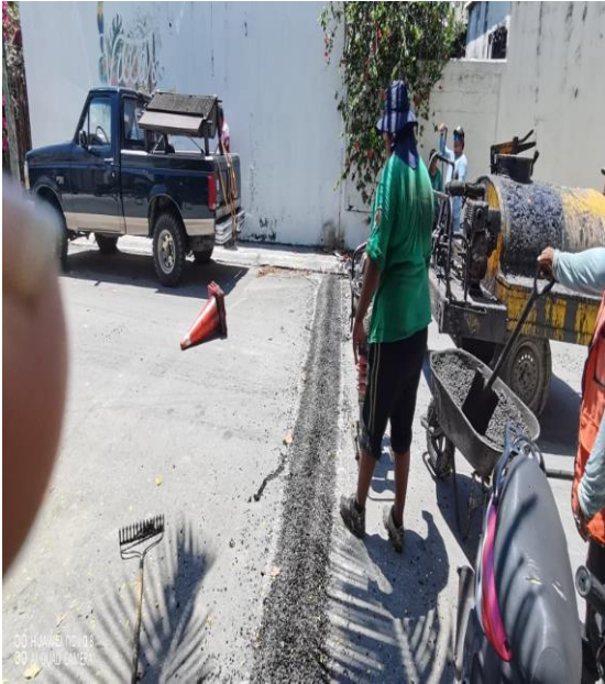
Bacheo; Calle 2 bis oriente entre calle 15 y calle 13
