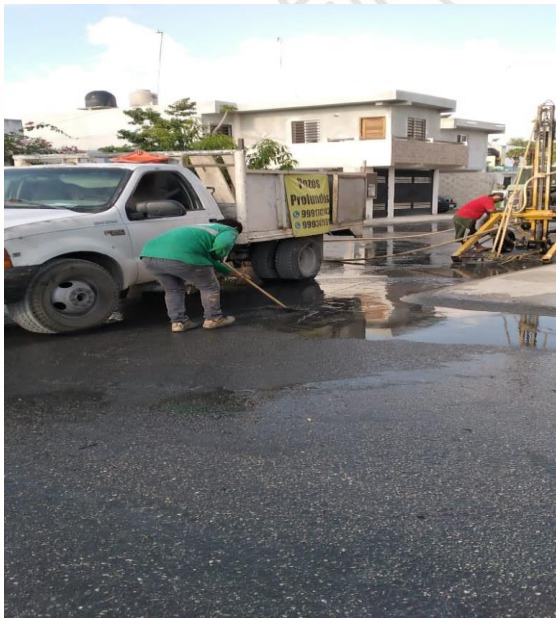
Desazolve de pozos; Calle palma Navidad entre boulevard palmas.
