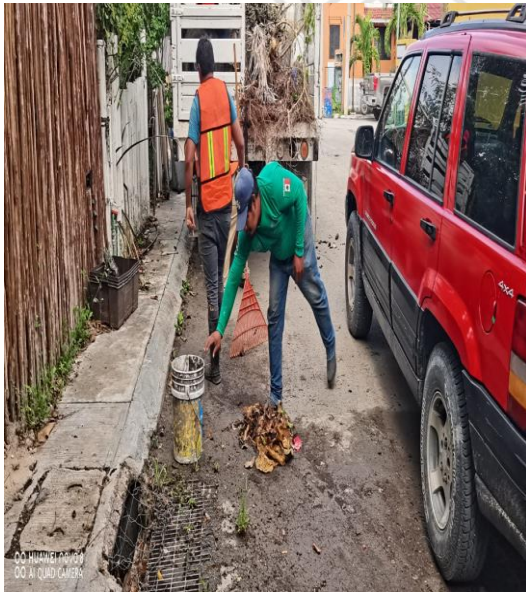
Limpeza de rejillas; Calle 2 bis oriente y Calle 11
