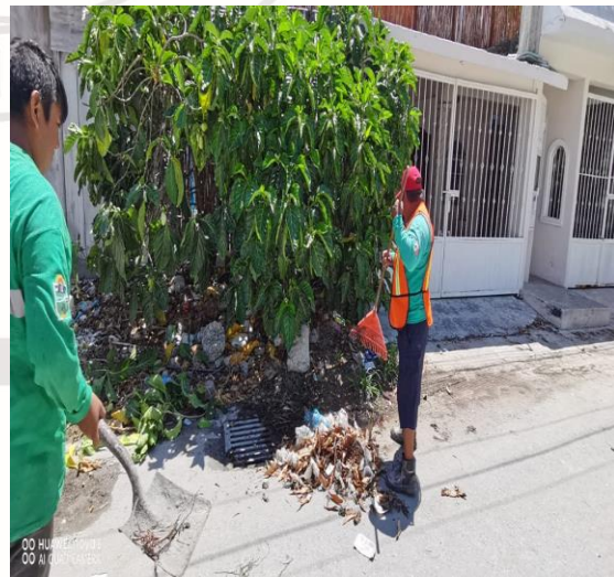
Limpieza de rejillas; Calle géminis sur entre calle gama oriente y asteroides.
