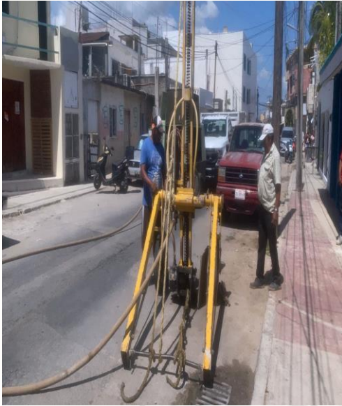
Desazolve de pozos; Calle omega sur entre saturno poniente.
