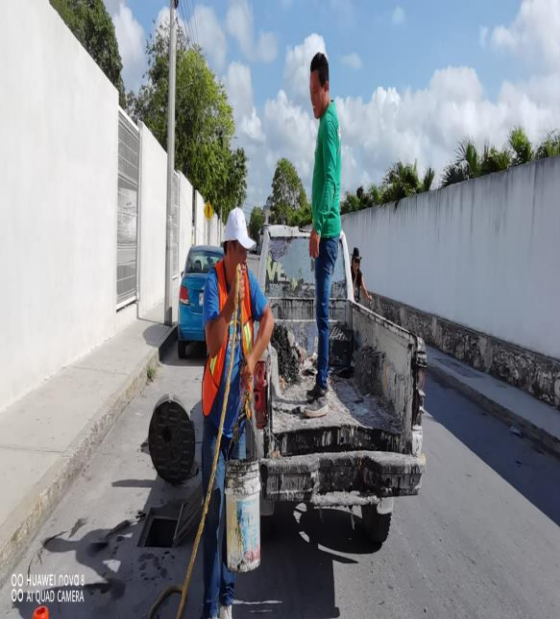
Limpeza de pozos; Calle júpiter norte / 4 oriente y tun-kul.
