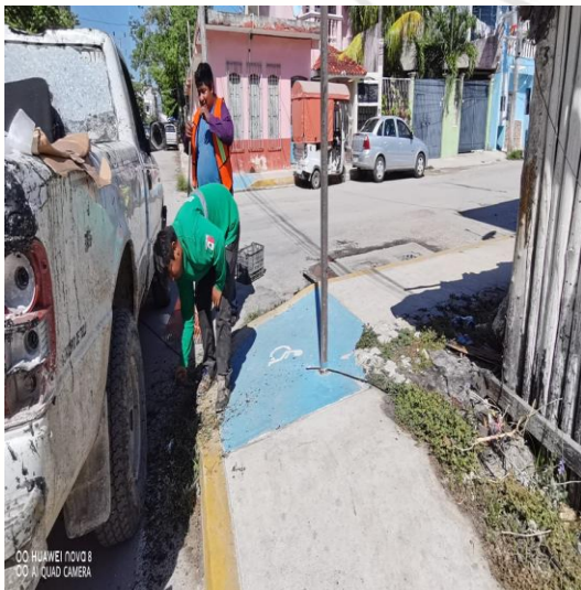
Limpieza de rejillas; Calle asteroides oriente entre calle Órion sur y calle beta sur.
