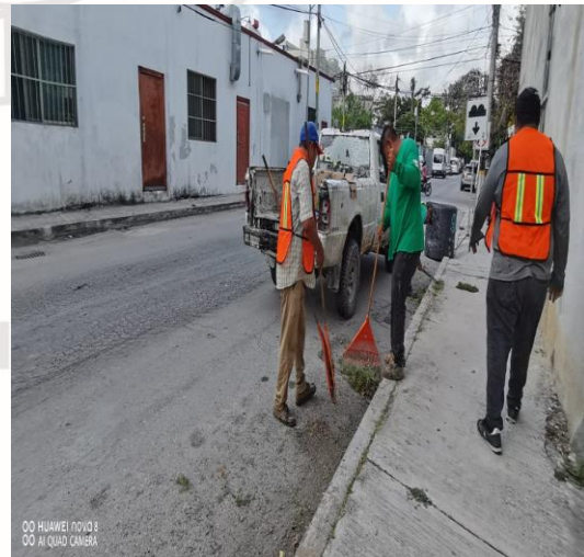
Limpieza de rejillas; Calle sagitario oriente entre calle alfa norte y júpiter norte.
