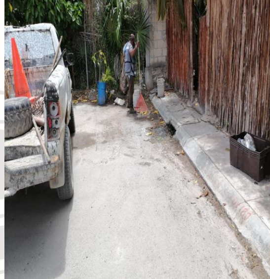
Limpeza De Rejillas: Calle 2 bis y la calle 11
