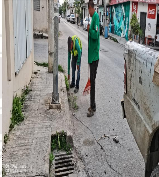
Limpieza de rejillas; Calle sagitario oriente entre calle beta norte y calle osiris norte.
