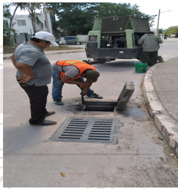
Desazolve de pozos; Calle reina entre palmas Tulum.
