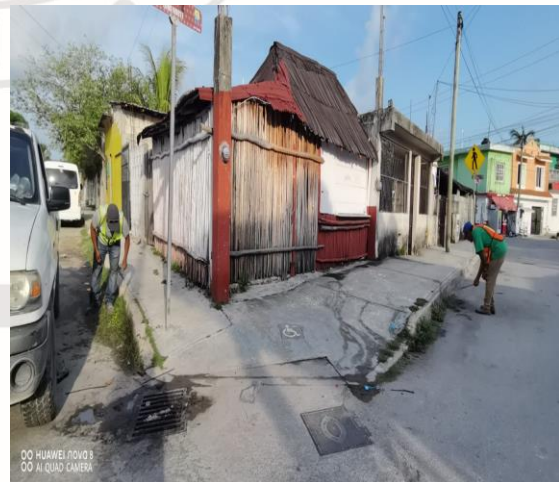
Limpieza de rejillas; Calle luna norte entre calle polar poniente y tauro.
