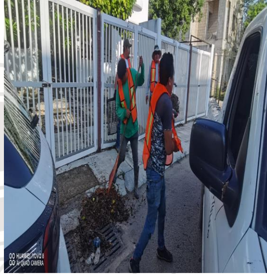
Limpeza De Rejillas: Calle 5 entre la calle 2 oriente y la calle 4 oriente
