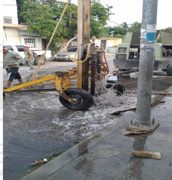
Desazolve de pozos; Calle centauro norte entre polar poniente.
