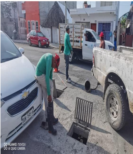
Limpeza de pozos; Calle tun-kul / júpiter norte y 4 oriente.
