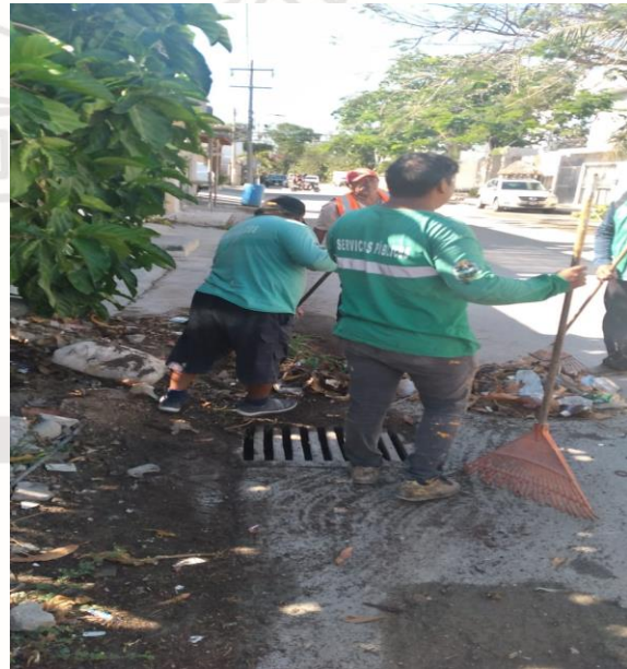
Limpieza de rejillas; Calle gama entre calle géminis sur.
