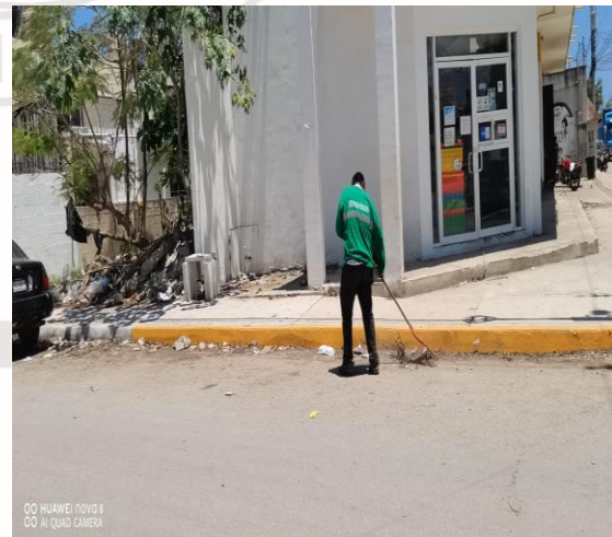
Limpieza de rejillas; Calle golondrina entre calle chanchen y av. kukulkan.
