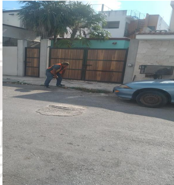
Limpieza de rejillas; Calle 2 bis entre calle 11.
