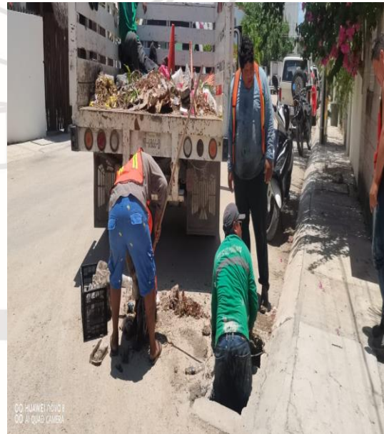
Limpeza De Rejillas: Calle 2 oriente entre la calle 3 sur y calle 5 sur
