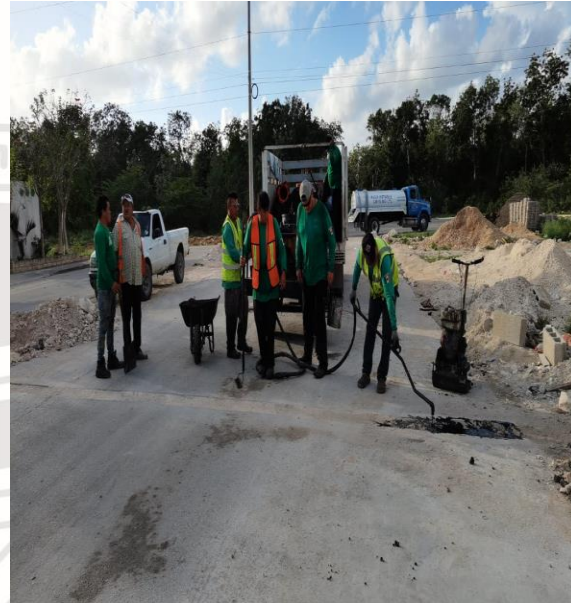
Bacheo; Av Tulum entre av kulkan.
