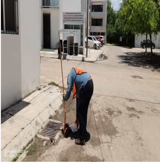
Limpeza De Rejillas: Calle 7 sur entre calle 2 bis oriente y calle 2 a oriente
