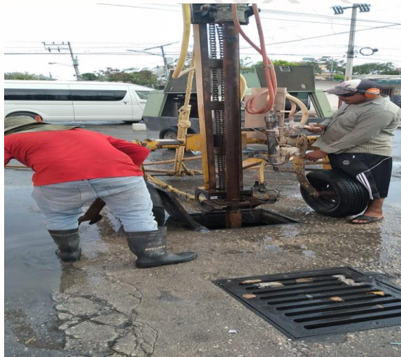
Desazolve de pozos; Calle polar oriente entre centauro norte.
