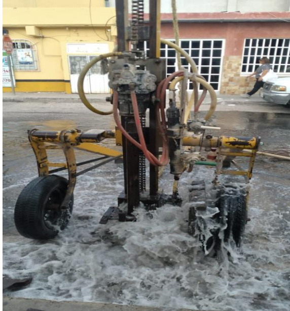
Desazolve de pozos; Calle polar poniente entre centauro norte.
