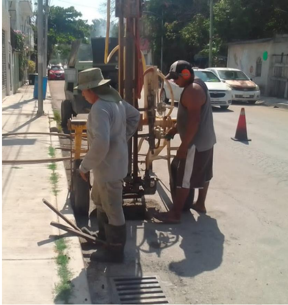
Desazolve de pozos; Calle 5 sur entre 2 oriente.
