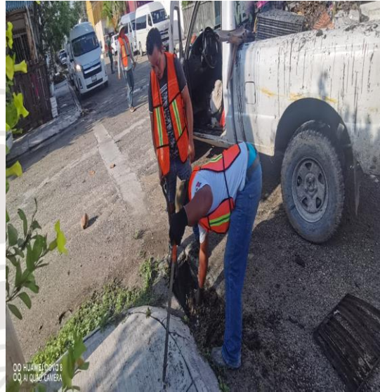
Limpeza De Rejillas: Calle 2 bis entre la calle 7 sur
