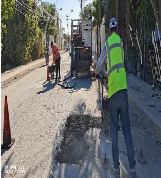
Bacheo; Calle golondrina entre sian ka'an y chan-chen.
