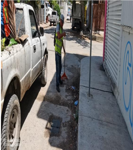
Limpieza de rejillas; Calle géminis sur entre calle venus oriente y sol oriente.
