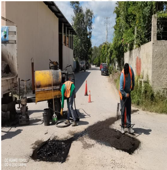
Bacheo; Calle gavilanes entre codorniz y gallinolas.
