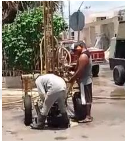
Desazolve de pozos; Calle chikil entre calle tun-kul.
