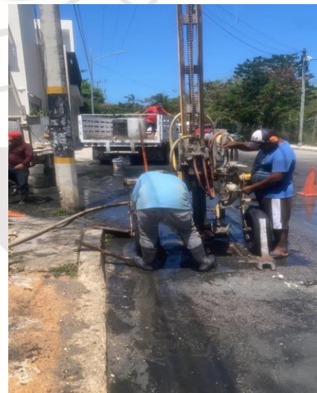
Desazolve de pozos; Calle aurora sur entre luna poniente.
