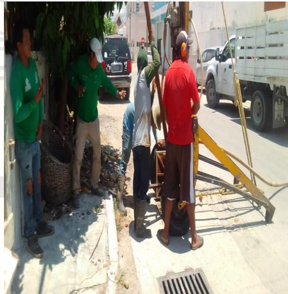
Desazolve de pozos; Boulevard palmas entre palma astil.
