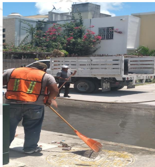
Desazolve de pozos; Calle palma kerpis entre boulevard palmas.
