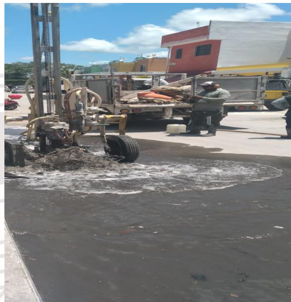
Desazolve de pozos; Calle palmas abanico entre boulevard palmas.
