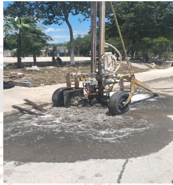
Desazolve de pozos; Calle palma cariota entre palma astil.
