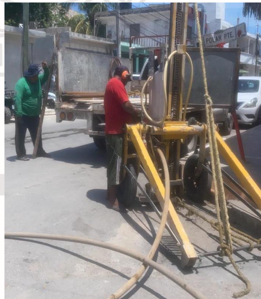
Desazolve de pozos; Calle 9 entre 2 bis oriente.
