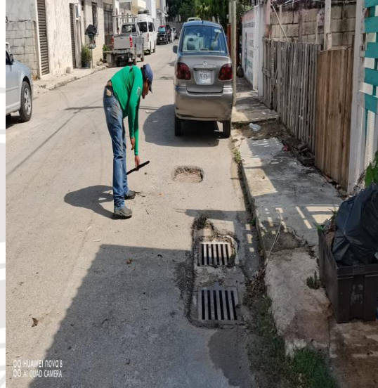
Limpieza de rejillas; Calle huracanes Irene entre calle huracanes Mitch
