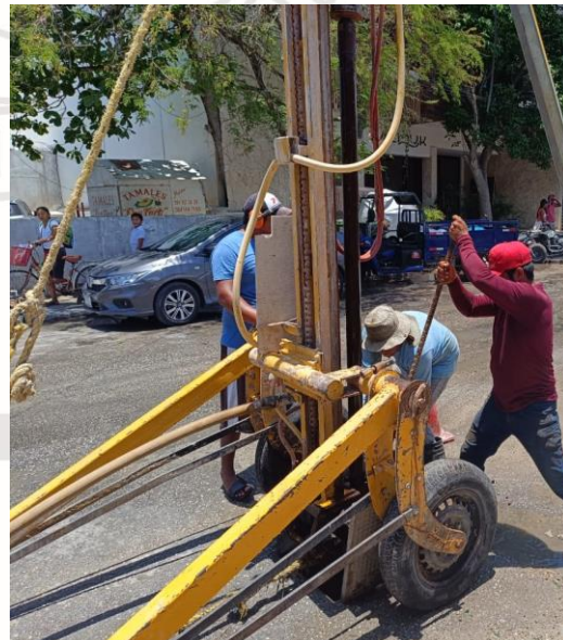
Desazolve de pozos; Calle beta entre polar oriente.
