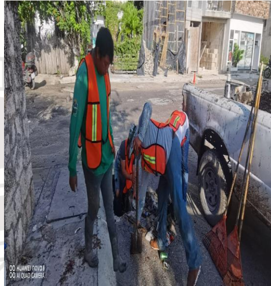
Limpeza De Rejillas: Calle 3 sur entre la calle 2 oriente a y calle 2 oriente
