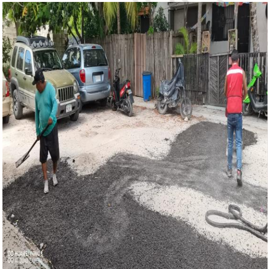
Bacheo; Fraccionamiento Villas Tulum. Calle chemuyil entre la calle 4 oriente y la calle 17
