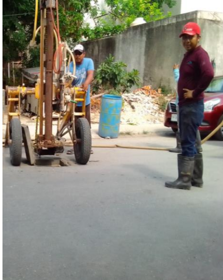
Desazolve de pozos; Calle Neptuno poniente entre omega sur.
