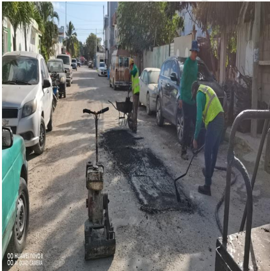
Bacheo; Calle abal entre oom y calle naal.
