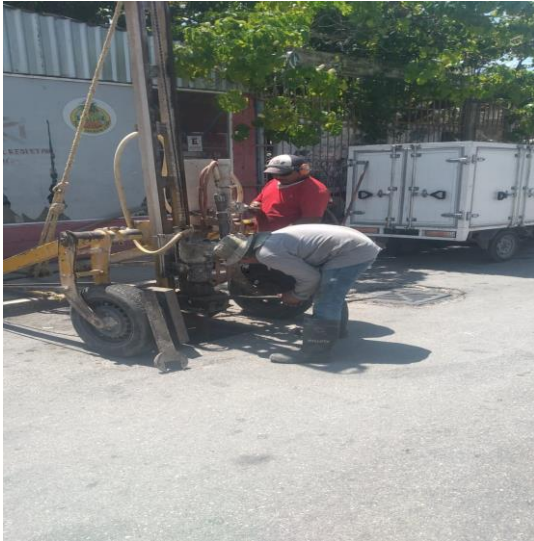
Desazolve de pozos; Calle luna poniente entre acuario sur.
