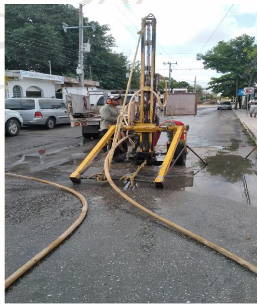
Desazolve de pozos; Calle mercurio poniente entre privada.
