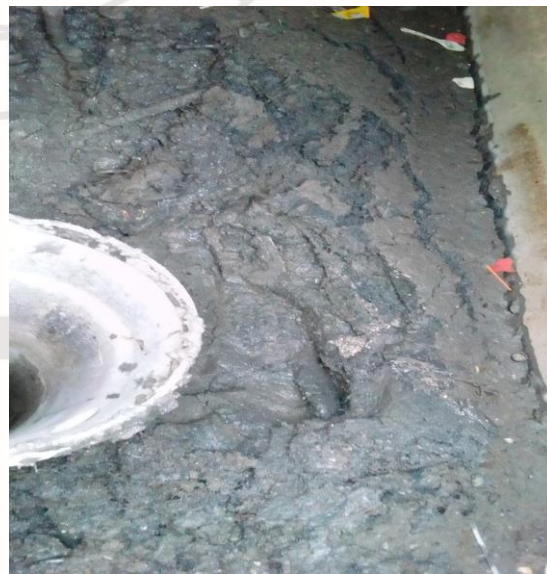
Limpeza de pozos; Calle tun-kul / centauro norte y calle kii's.
