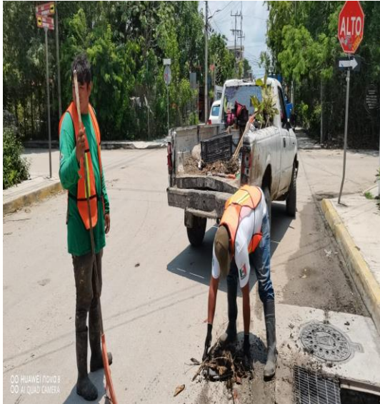
Limpeza de rejillas; Calle libra sur entre la calle andromeda Oriente y escorpión sur
