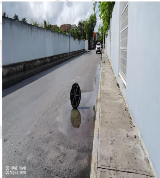
Limpeza De Rejillas: Calle júpiter norte entre la calle 4 oriente y calle tun-I'ul
