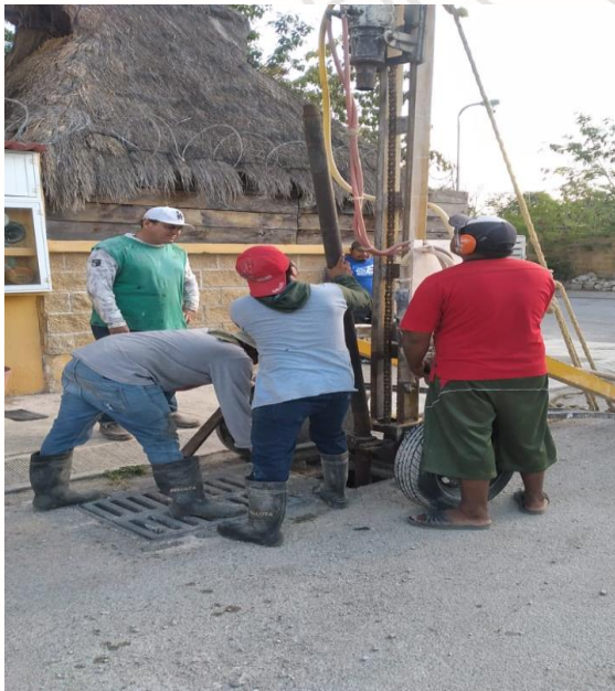
Desazolve de pozos; Calle palmas Navidad entre bulevar.
