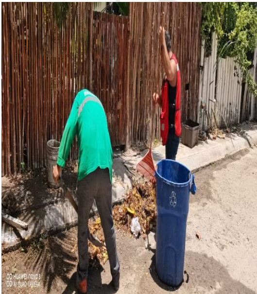
Limpeza De Rejillas: Calle 2 bis oriente y calle 11
