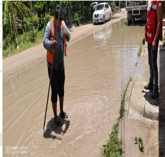
Limpeza De Rejillas: Calle mercúrio oriente entre la calle alfa sur y calle luna poniente
