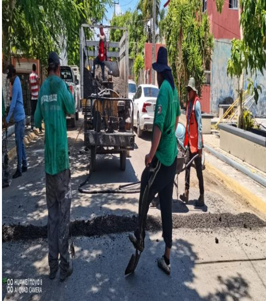
Bacheo; Calle 17 entre la calle 4 oriente y calle 2 bis oriente
