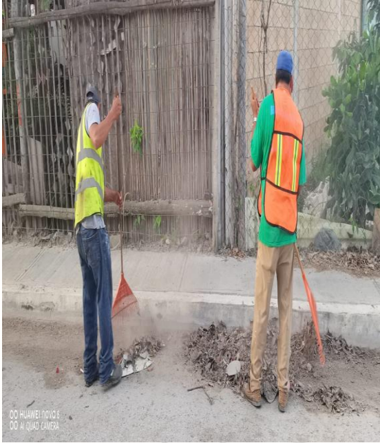
Limpieza de rejillas; Calle faisán entre av. la selva y calle poot.
