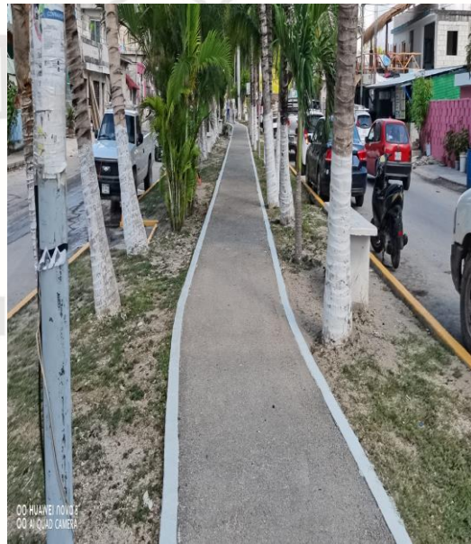
Pintura; Akumal Pueblo.
