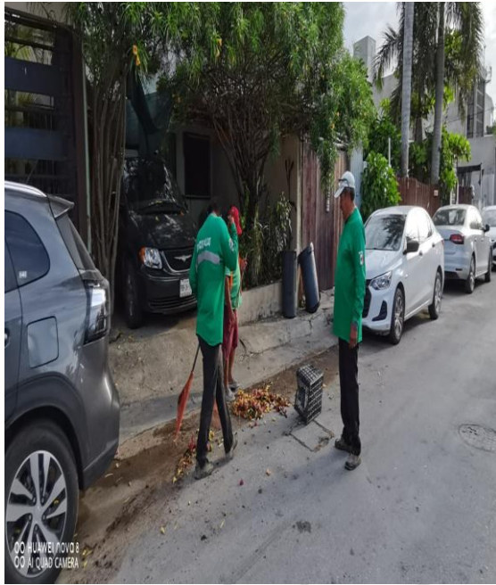
Limpeza de rejillas; Calle 4 oriente entre calle 15.
