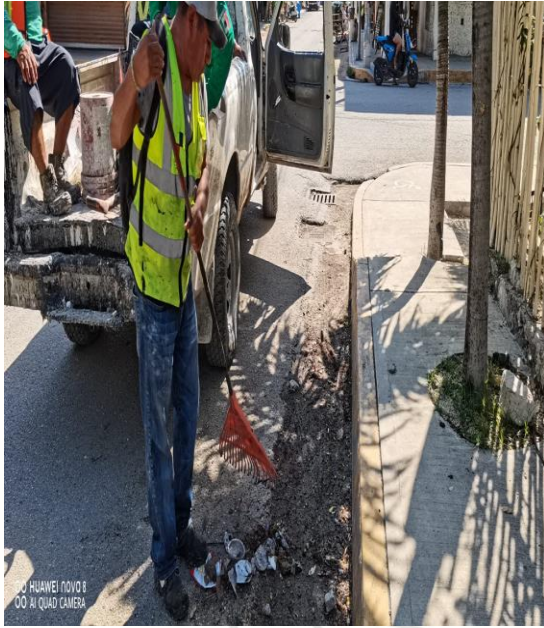
Limpieza de rejillas; Calle andrómeda oriente entre av. satélite sur.
