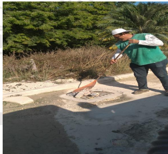
Limpieza de rejillas; Calle 17 oriente entre 2 bis oriente.
