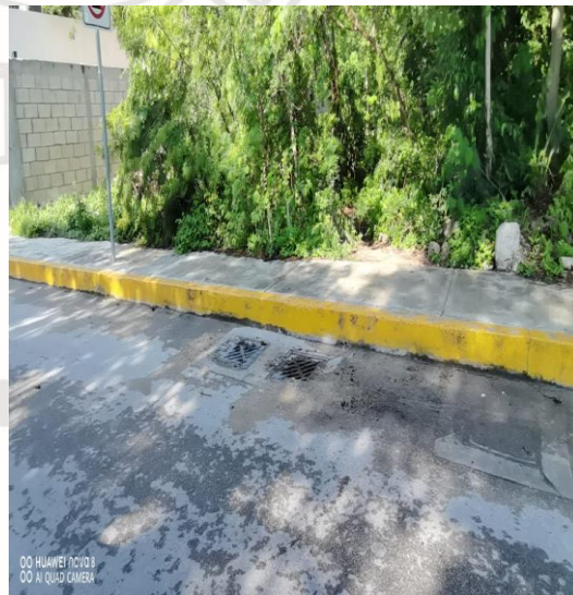
Limpeza De Rejillas: Calle 3 sur entre la calle 2 bis oriente y la avenida Tulum
