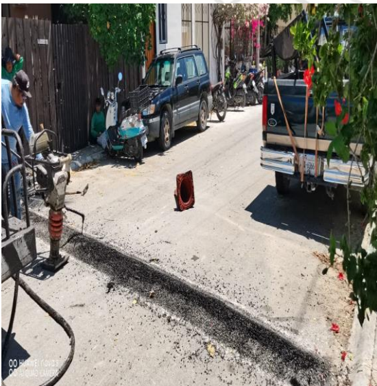
Bacheo; Calle 2 bis oriente entre calle 15 y calle 13
