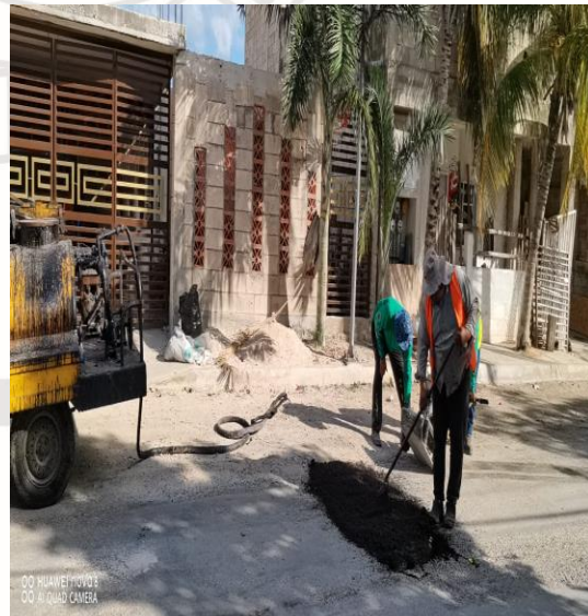
Bacheo; Calle abal entre oom y calle naal.
