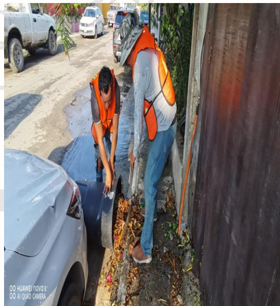
Limpeza De Rejillas: Calle 15 entre la calle 4 oriente
