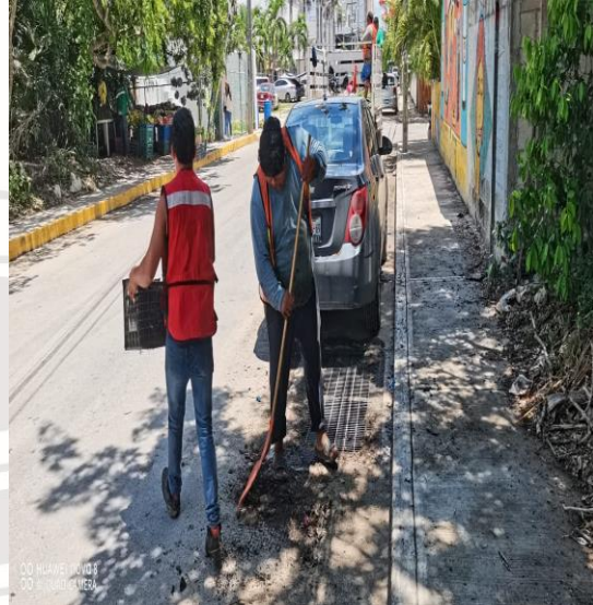
Limpeza De Rejillas: Calle 3 sur entre la calle 2 bis oriente
