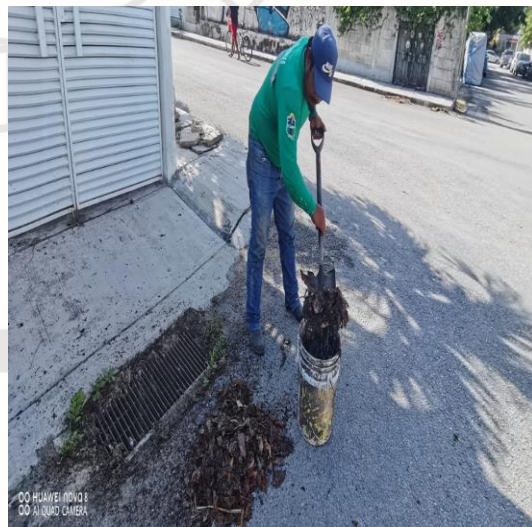
Limpeza de rejillas; Calle 11 entre la 2 oriente y la calle 13 villas Tulum
