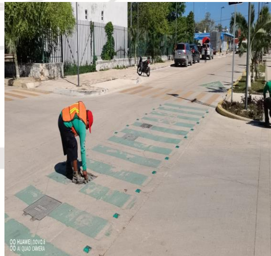
Limpieza de rejillas; Calle gama oriente entre calle Osiris sur y beta sur.
