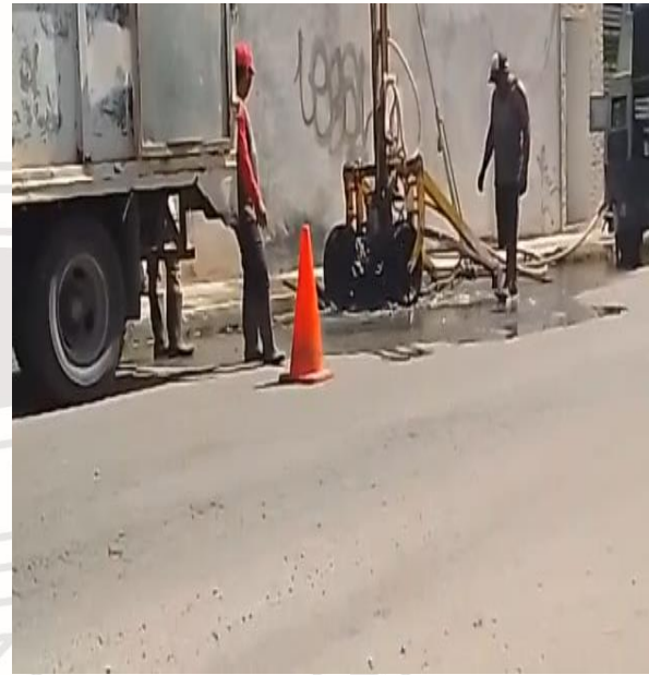
Desazolve de pozos; Calle 7 sur entre 2a oriente.
