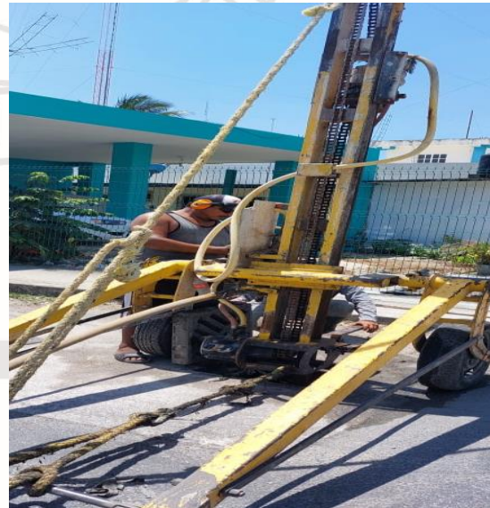
Desazolve de pozos; Calle 9 entre 2a oriente.
