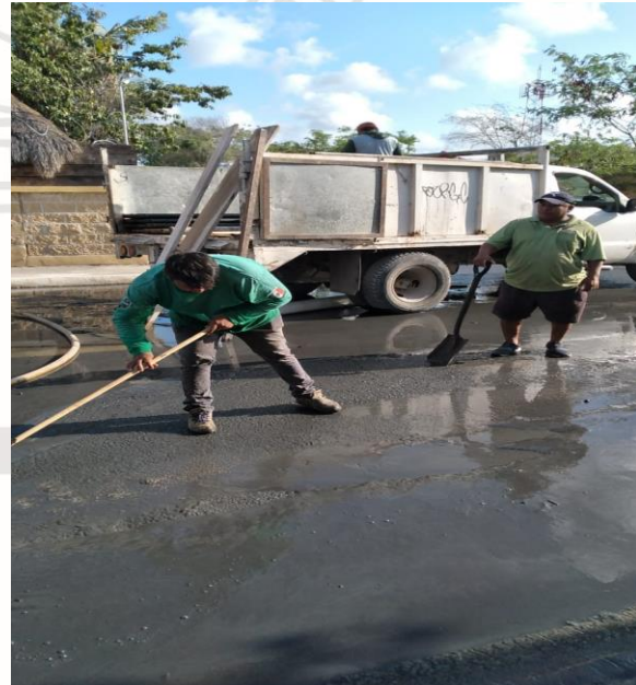
Desazolve de pozos; Calle palmas Navidad entre bulevar.
