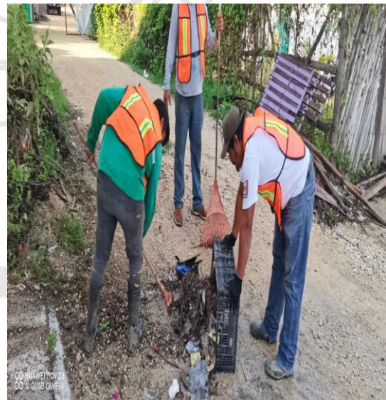
Limpeza De Rejillas: Calle 2 bis oriente entre la calle 5 sur y la calle 7 sur
