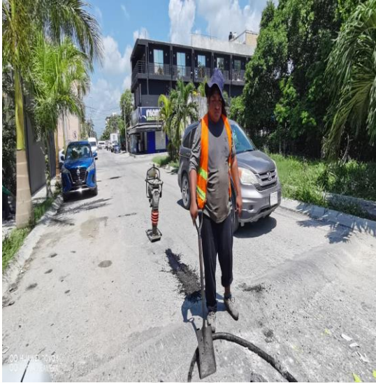
Bacheo; Calle 2 poniente entre la calle géminis
