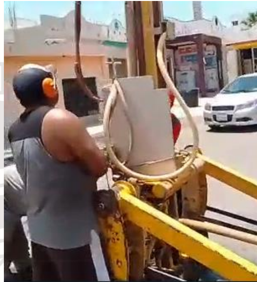
Desazolve de pozos; Calle 7 sur entre 14 sur.
