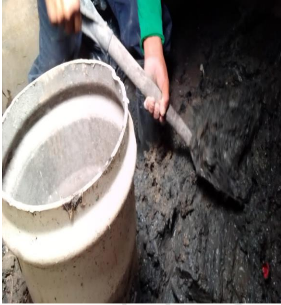
Limpeza de pozos; Calle tun-kul / omega norte y alfa norte.
