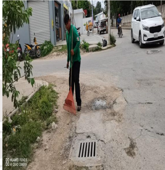
Limpeza De Rejillas: Calle faisán entre la calle boca paila y la calle Chun-yaxche
