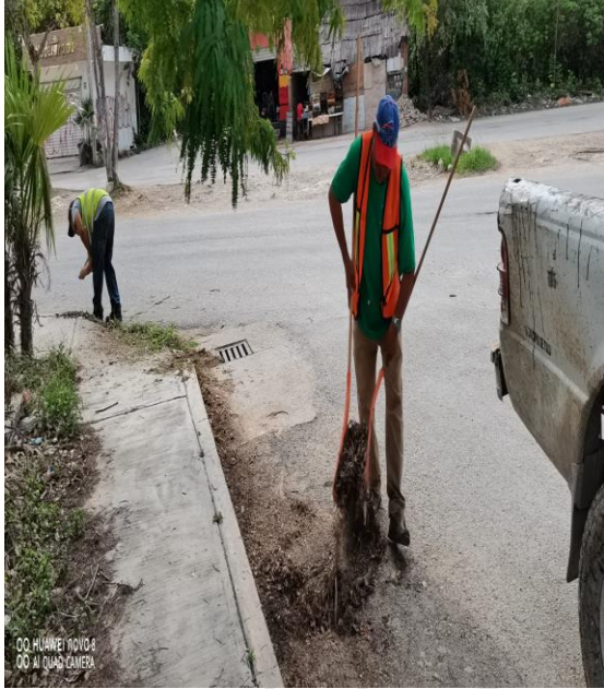
Limpieza de rejillas; Av la selva entre calle omm y chunyaxche.
