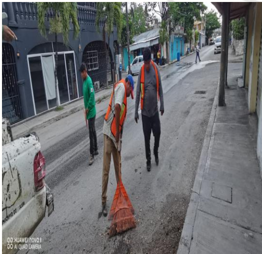
Limpieza de rejillas; Calle sagitario oriente entre calle osiris norte y alfa norte.
