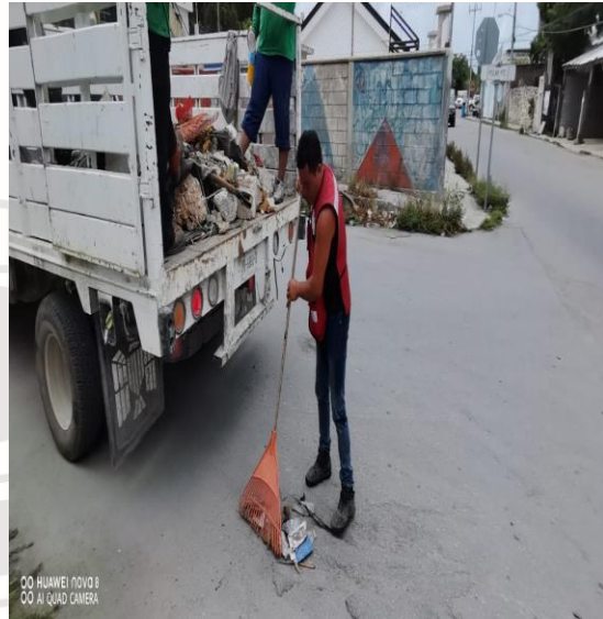
Limpeza De Rejillas: Calle saturno poniente entre la calle polar poniente y la calle Luna Norte
