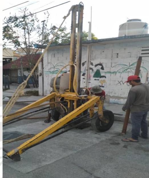
Desazolve de pozos; Calle osiris norte entre polar poniente.
