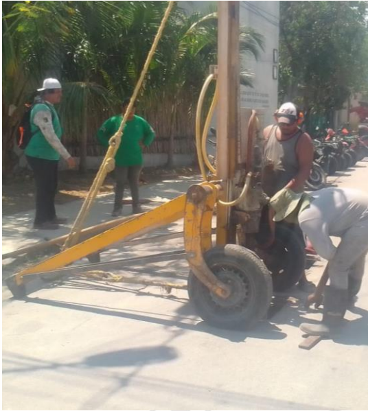
Desazolve de pozos; Calle mercurio poniente entre saturnino sur.
