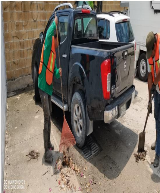
Limpeza De Rejillas: Calle palmas navidad y la calle palmas abanico
