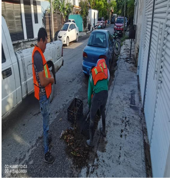
Limpeza De Rejillas: Villas Tulum entre calle 3 sur y la calle 13
