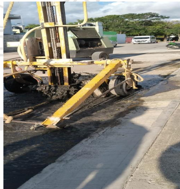
Desazolve de pozos; Calle palma Navidad entre boulevard palmas.
