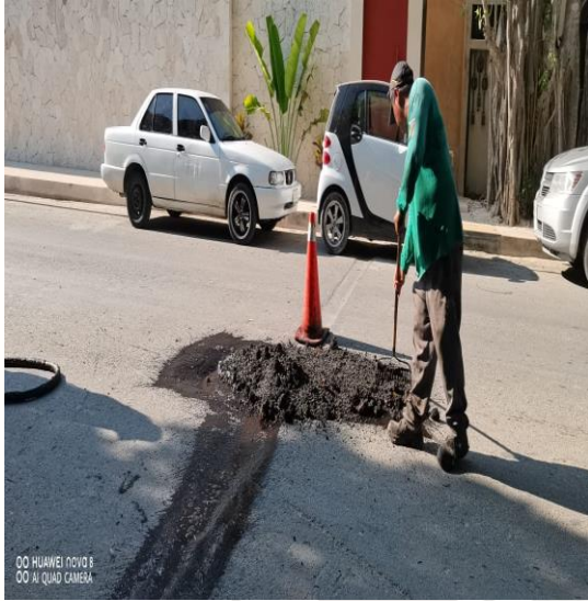
Bacheo; Calle bubul-ek entre la Av. Coba y la calle 11
