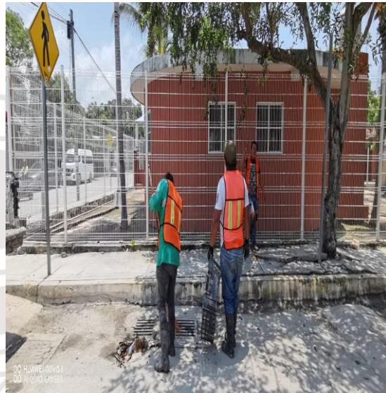
Limpeza de rejillas; Calle sol oriente entre la calle escorpión y la calle libra sur
