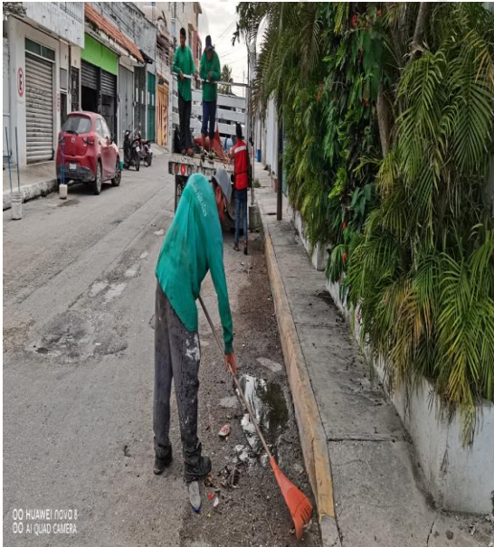
Limpeza De Rejillas: Calle polar oriente entre la calle beta norte y la calle Orión Norte
