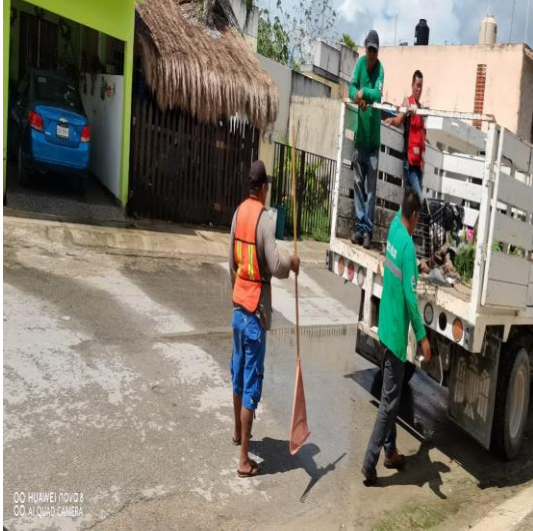
Limpeza De Rejillas: Calle palmas abanico entre la calle bulevar palmas
