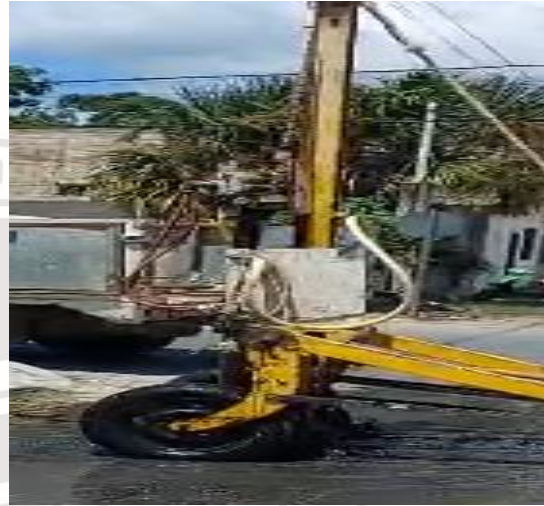
Desazolve de pozos; Calle tun-kul entre omega norte.
