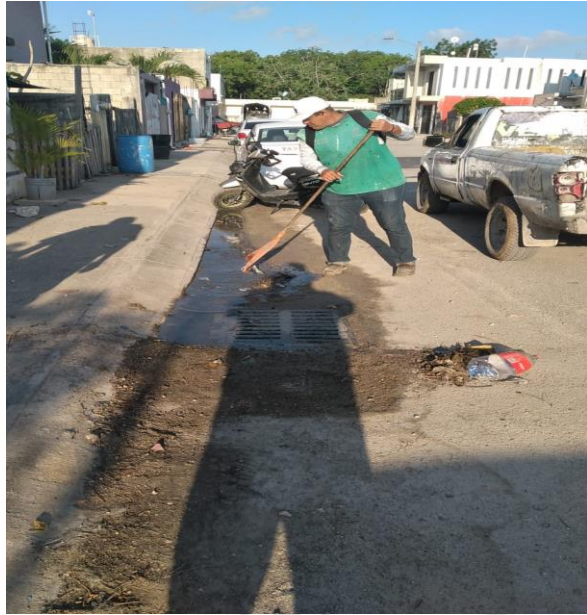
Limpieza de rejillas; Calle palmas bulevar entre calle rapiz.
