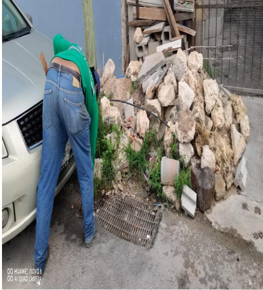
Limpeza de rejillas; Calle huracanes Mitch entre la calle huracanes Rossana y la calle belulah
