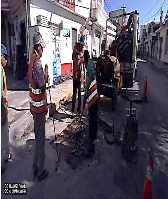
Bacheo; Calle polar oriente entre beta norte y orión norte.
