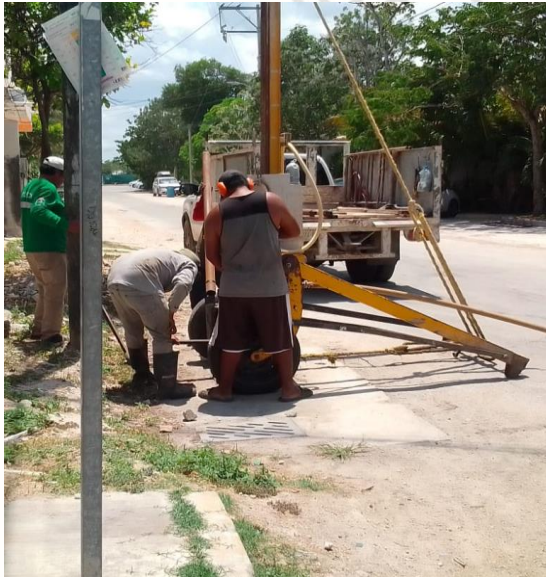
Desazolve de pozos; Calle tumben-ha entre chan-chen.
