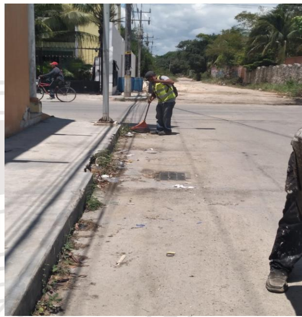
Limpeza de rejillas; Calle polar poniente entre calle alfa.
