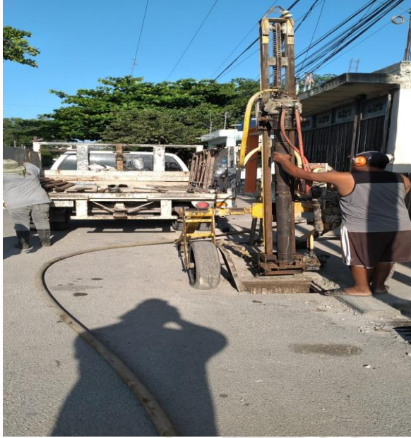
Desazolve de pozos; Calle sagitario oriente entre beta norte.
