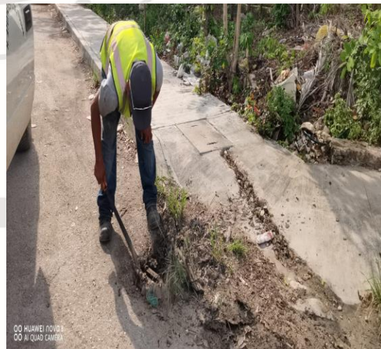
Limpieza de rejillas; Calle guut entre calle tumben-ha y caalche.
