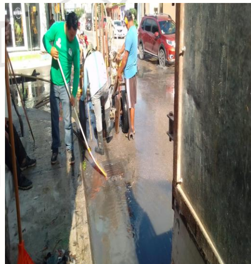
Desazolve de pozos; Calle sol poniente entre alfa sur y omega sur.
