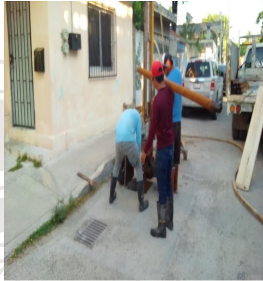
Desazolve de pozos; Calle júpiter entre sol poniente.
