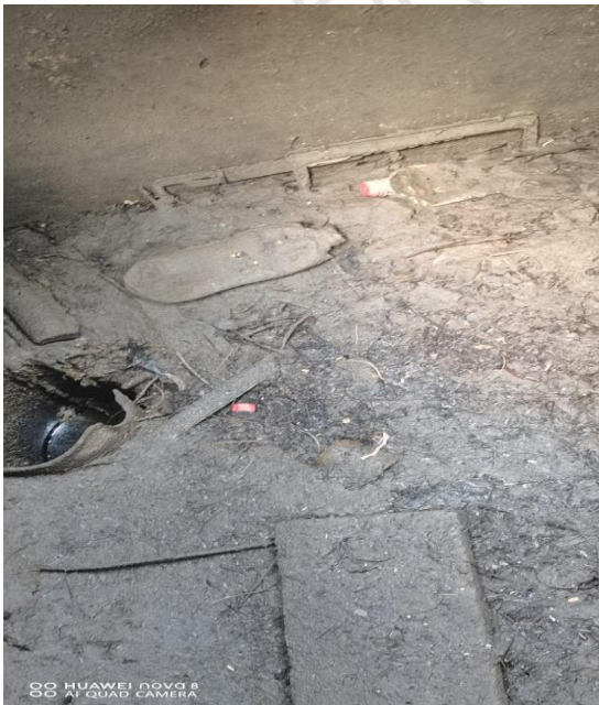
Limpieza de pozos; Calle osiris norte / 2 oriente.
