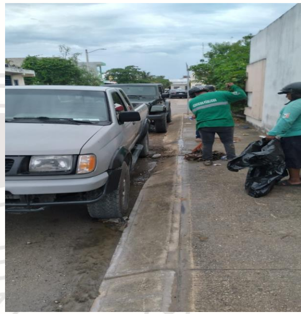
Limpieza de rejillas; Calle bulevar / calle rapiz.
