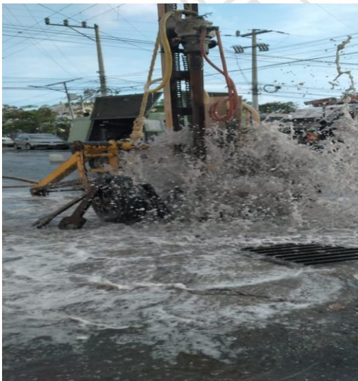
Desazolve de pozos; Calle júpiter sur entre luna poniente.
