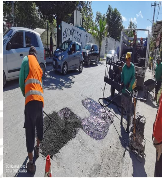
Bacheo; Av. kukulkan entre av ook-k'ot y júpiter norte.
