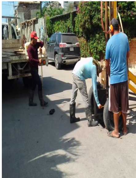
Desazolve de pozos; Calle omega sur entre luna poniente.
