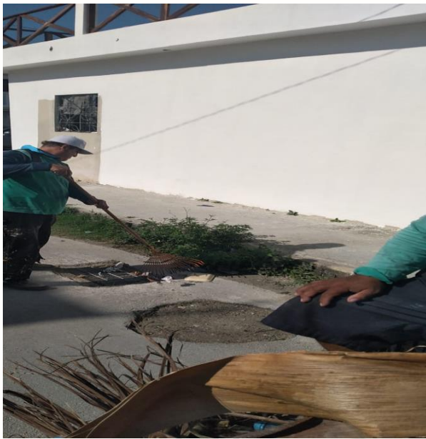
Limpeza de rejillas; Calle sol oriente entre calle centauro.
