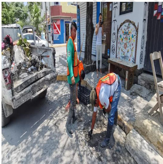
Limpeza de rejillas; Avenida satellite entre la calle sol Oriente y andromeda Oriente
