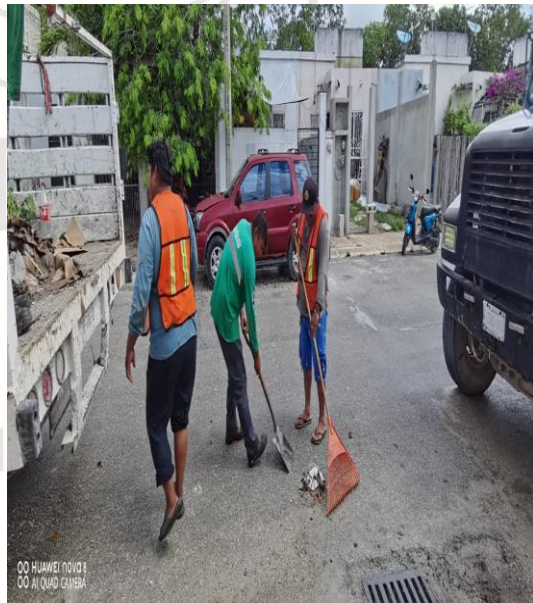
Limpeza De Rejillas: Calle palmas chat y calle palmas bulevar y calle guinea
