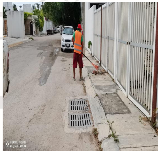
Limpeza de rejillas; Calle 5 sur entre calle 2 oriente y 4 oriente.
