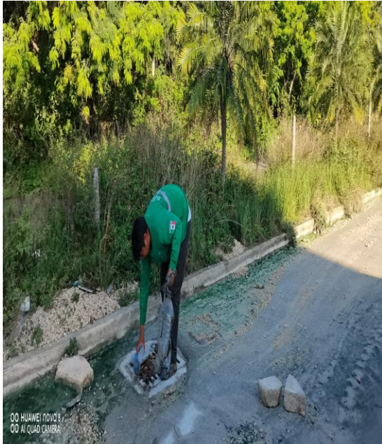
Limpieza de rejillas; Calle palmas entre calle 2 oriente.
