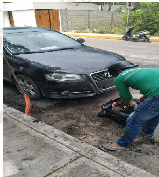
Limpieza de rejillas; 2 bis oriente / 3 sur.
