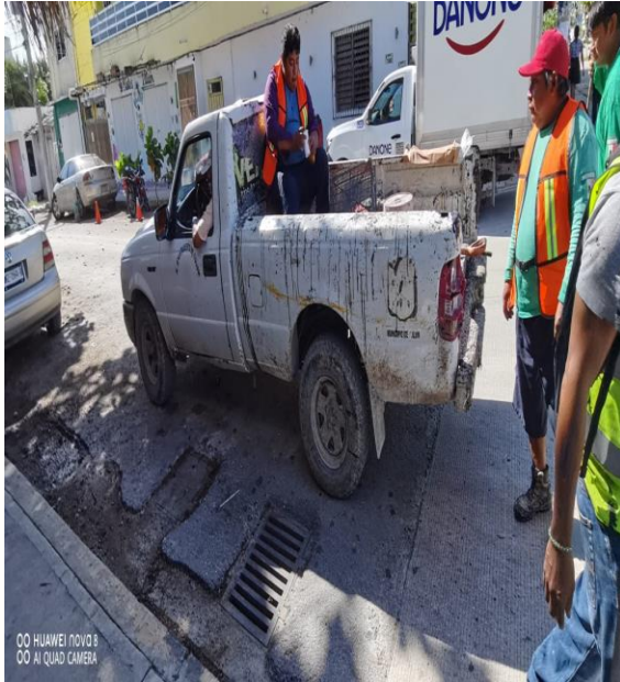
Limpieza de rejillas; Calle andromeda oriente entre calle osiris sur y beta sur.
