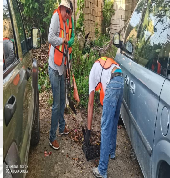
Limpeza De Rejillas: Calle chemuyil entre la calle 4 oriente
