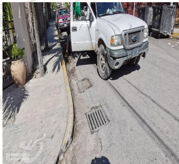
Limpieza de rejillas; Calle andrómada oriente entre calle centauro sur y av. satélite sur.
