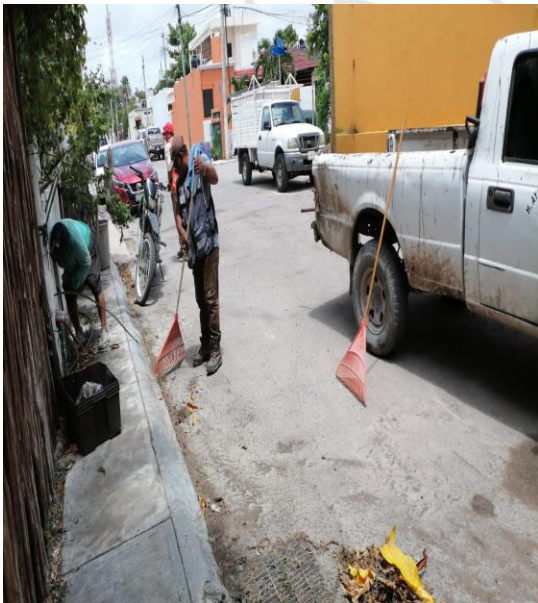
Limpeza De Rejillas: Calle 4 oriente y la calle 15
