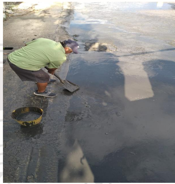
Desazolve de pozos; Calle bulevar entre palmas rapiz.
