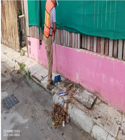
Limpeza de rejillas; Calle 4 oriente entre la calle 15 y calle 2 bis oriente y la calle 17
