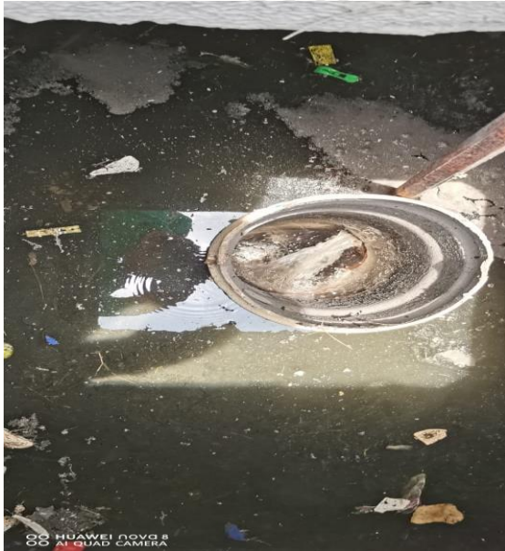
Limpeza de pozos; Calle tun-kul / omega y alfa norte
