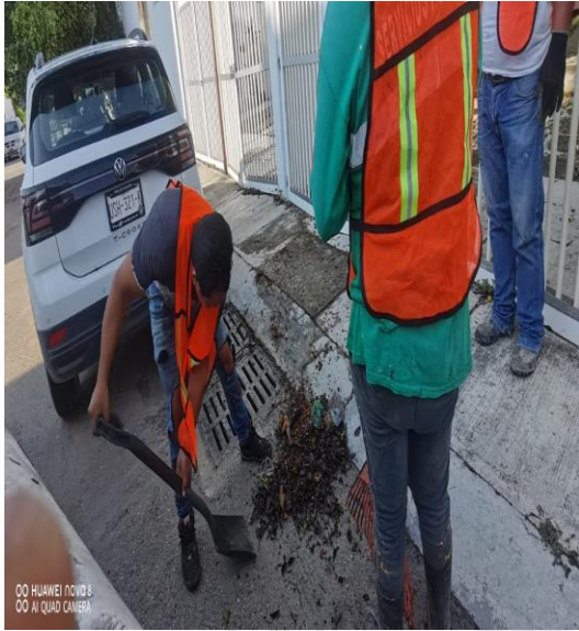
Limpeza De Rejillas: Calle 5 sur entre la calle 2 oriente
