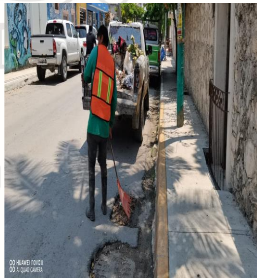
Limpeza de rejillas; Calle sol Oriente entre la calle centauro sur y la calle centauro sur
