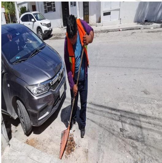
Limpieza de rejillas; Calle gama oriente entre calle centauro sur y av. satélite sur.
