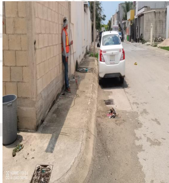
Limpeza De Rejillas: Calle palmas guinea entre la calle palmas rapis y palmas reina
