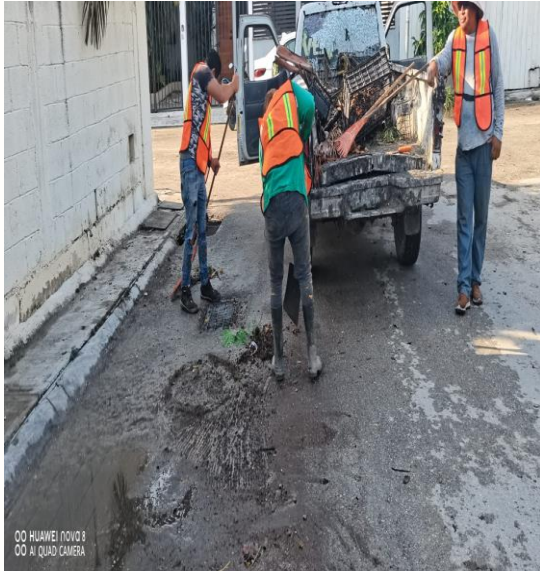
Limpeza De Rejillas: Calle 17 entre la calle 2 bis oriente
