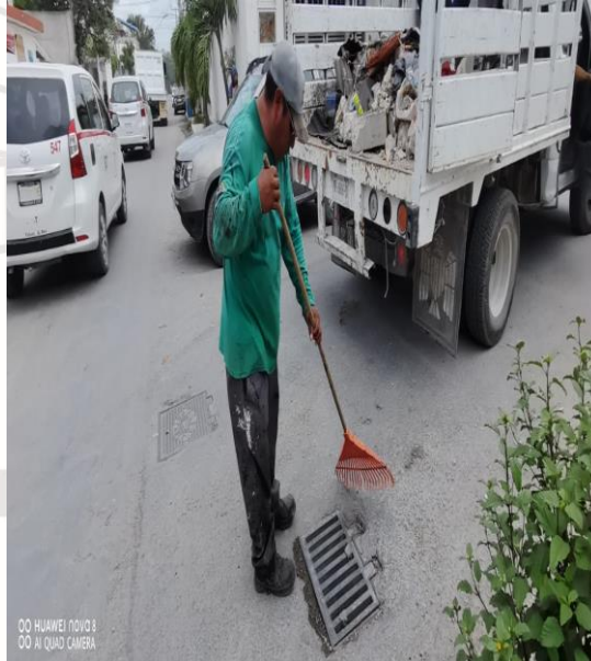
Limpeza De Rejillas: Calle Golondrina entre la calle chan- chen y la Av. kukulcan
