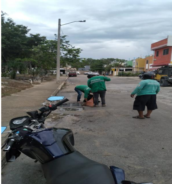
Limpieza de rejillas; Calle bulevar / calle rapiz.
