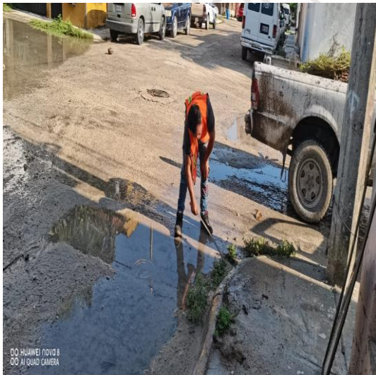
Limpeza De Rejillas: Calle 2 bis oriente entre la calle 5 sur y la calle 7 sur
