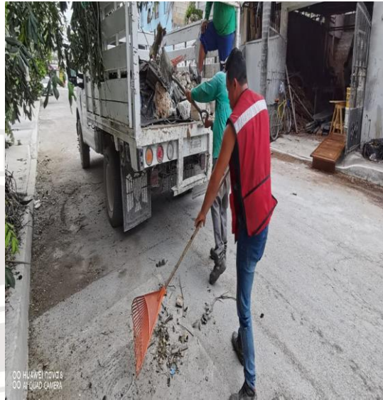
Limpeza De Rejillas: Calle chikil entre la calle tunk'ul u la Av. ook-k'ot
