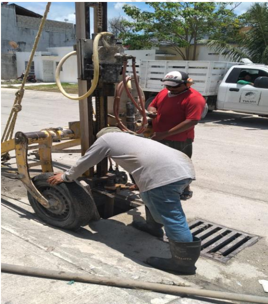
Desazolve de pozos; Calle Júpiter norte entre polar poniente.
