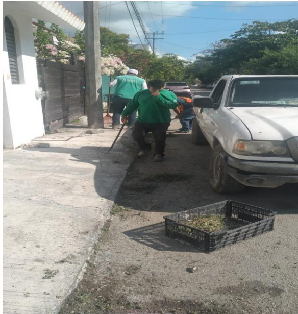
Limpieza de rejillas; Calle kohunlich entre av tulum.
