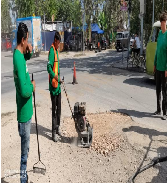
Bacheo; Calle osiris norte entre av ook-kot y lex-iu.
