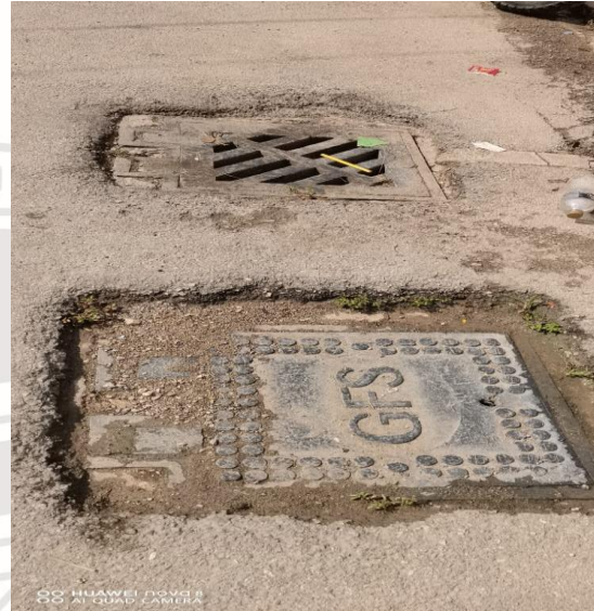
Limpeza de rejillas; Calle huracanes belulah entre la Calle huracanes Mitch
