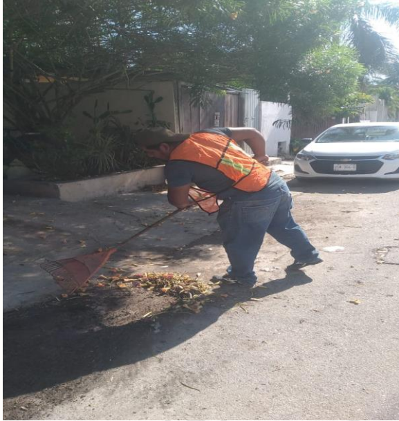
Limpeza de rejillas; Calle 2 bis oriente entre calle 11.
