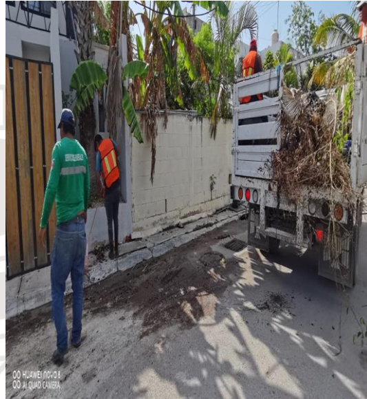
Limpeza de rejillas; Calle 15 entre calle 2 bis y calle 17
