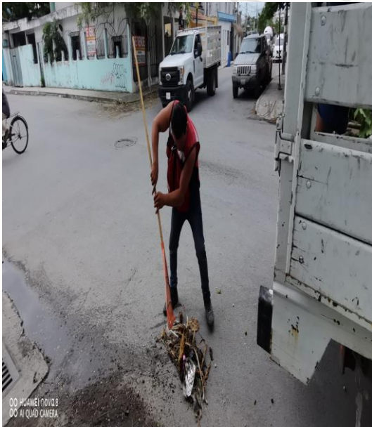
Limpeza De Rejillas: Calle 4 oriente entre la calle Orión norte y la calle centauro norte
