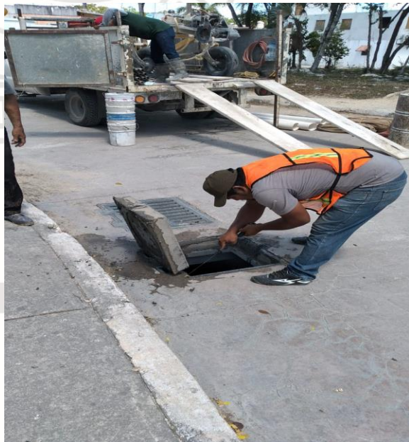
Desazolve de pozos; Calle bulevar entre palmas reina.
