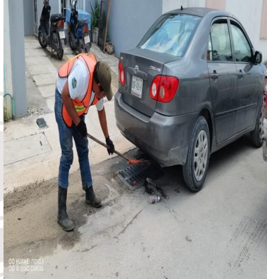
Limpeza De Rejillas: Calle palmas abanico entre la calle palmas guinea
