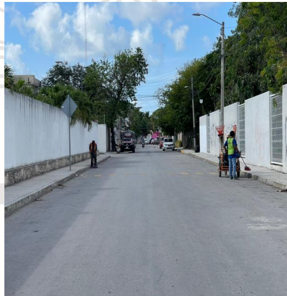
Limpieza de rejillas; Calle júpiter norte / 4 oriente y av ook- koot.
