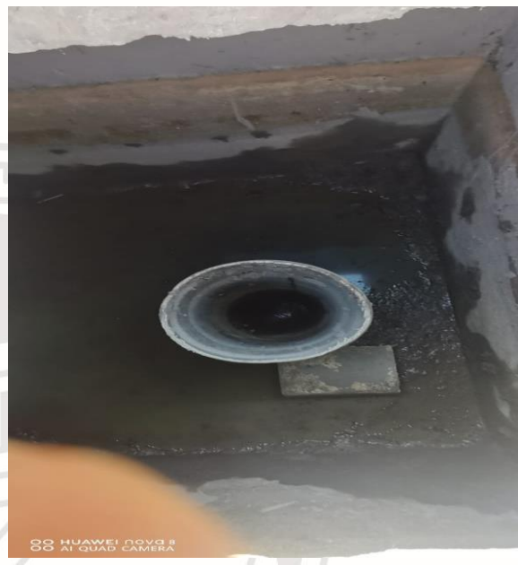
Limpeza de pozos; Calle tun-kul / júpiter norte y 4 oriente
