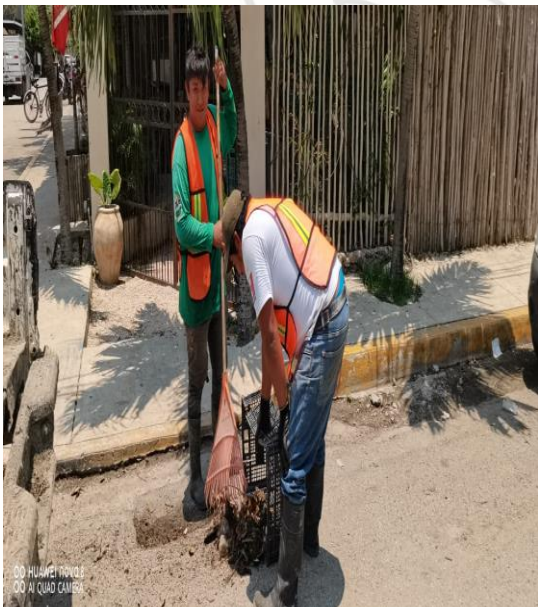
Limpeza De Rejillas: Calle Andromeda oriente entre la calle centauro sur y la avenida satélite
