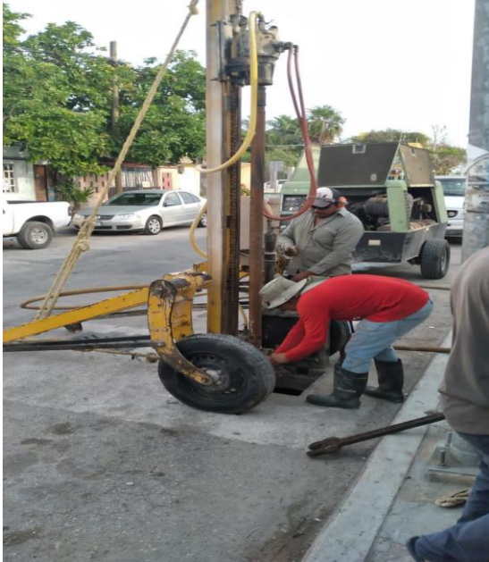
Desazolve de pozos; Calle alfa norte entre polar poniente.
