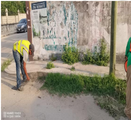
Limpieza de rejillas; Calle polar poniente entre calle júpiter norte y luna norte.
