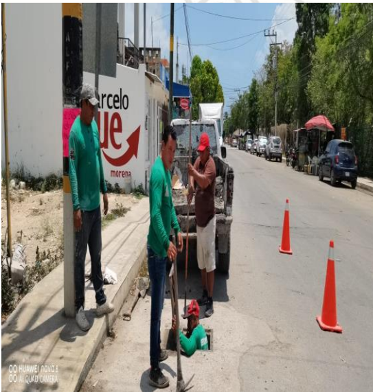
Limpeza de pozos; alle tun-kul / beta norte y 2 oriente.
