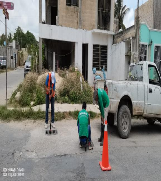
Limpieza de pozos; Calle osiris norte / 2 oriente.
