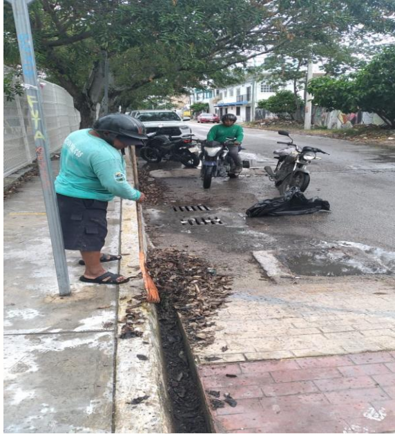
Limpeza de rejillas; Calle andromeda oriente / satélite.
