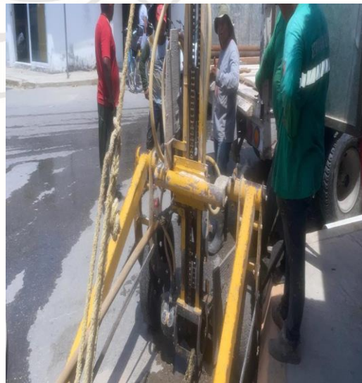
Desazolve de pozos; Calle mercurio poniente entre luna sur.
