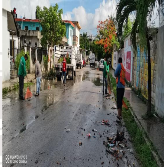
Limpeza De Rejillas: Calle géminis sur entre la calle gama oriente y calle neptuno oriente
