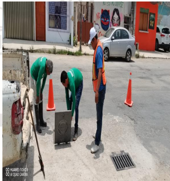
Limpeza de pozos; Calle tun-kul / omega y alfa norte
