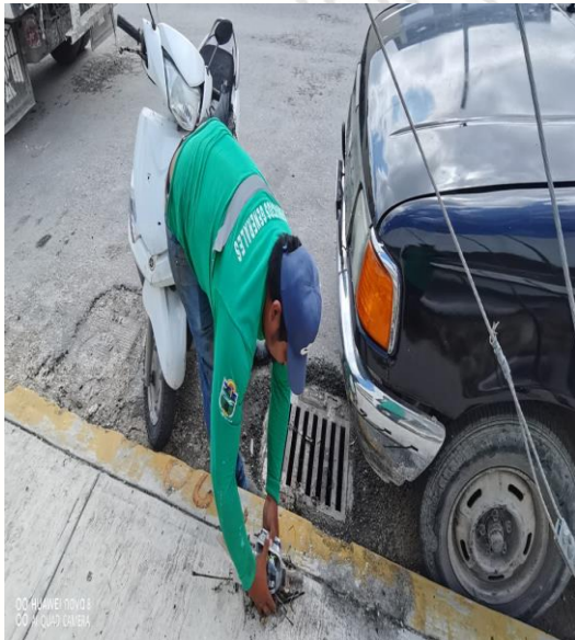
Limpeza de rejillas; Calle Rossana entre la Calle mitch y Calle Paulina
