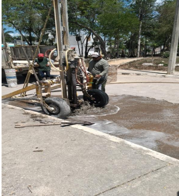
Desazolve de pozos; Calle reina entre palmas Tulum.
