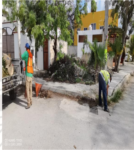
Limpieza de rejillas; Av la selva entre calle omm y chunyaxche.
