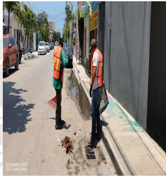
Limpeza de rejillas; Calle sol Oriente entre la calle centauro sur y la calle centauro sur
