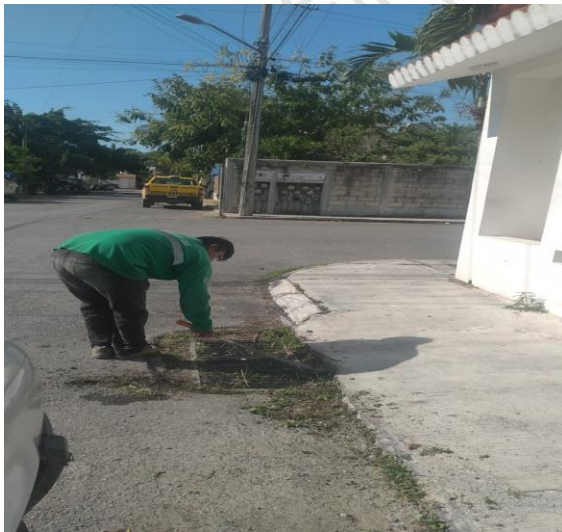
Limpieza de rejillas; Calle 4 oriente entre calle 15.
