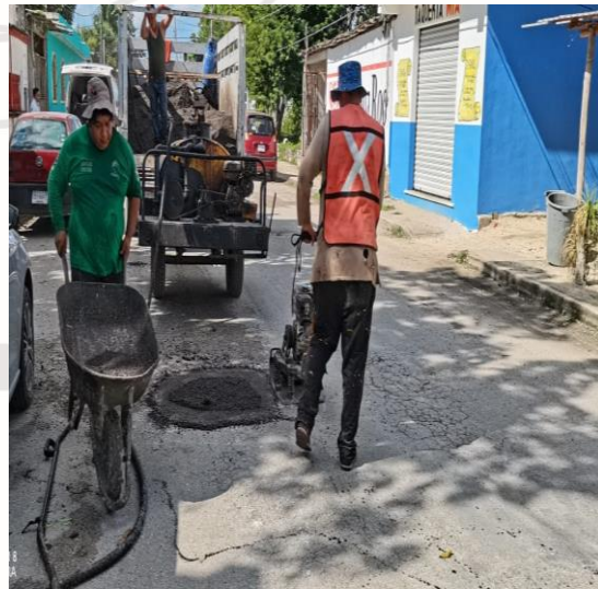
Bacheo; Calle sagitario entre júpiter y acuaria norte.
