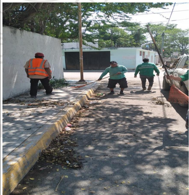
Limpeza de rejillas; calle pluton poniente entre alfa sur.
