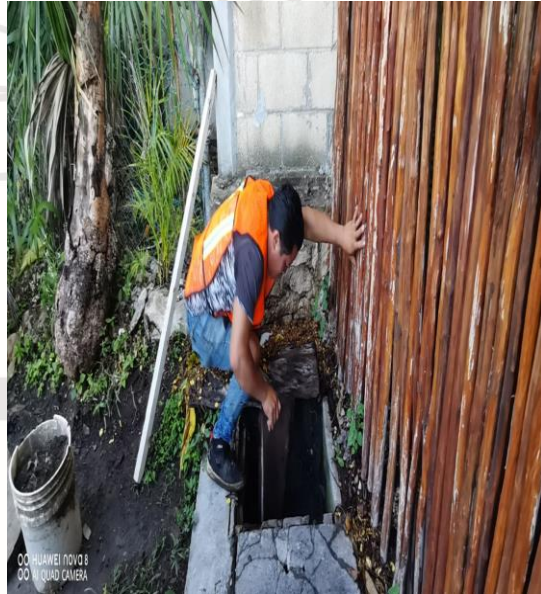
Limpeza De Rejillas: Calle 2 bis oriente entre la calle 3 sur y la calle 11
