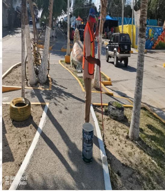
Pintura; Akumal Pueblo.
