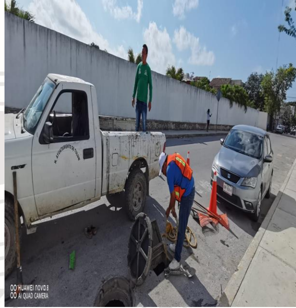
Limpeza de pozos; Calle júpiter norte / 4 oriente y tun-kul.
