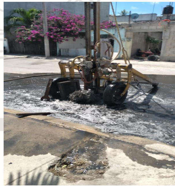
Desazolve de pozos; Calle palmas rapiz entre palmas guineas.
