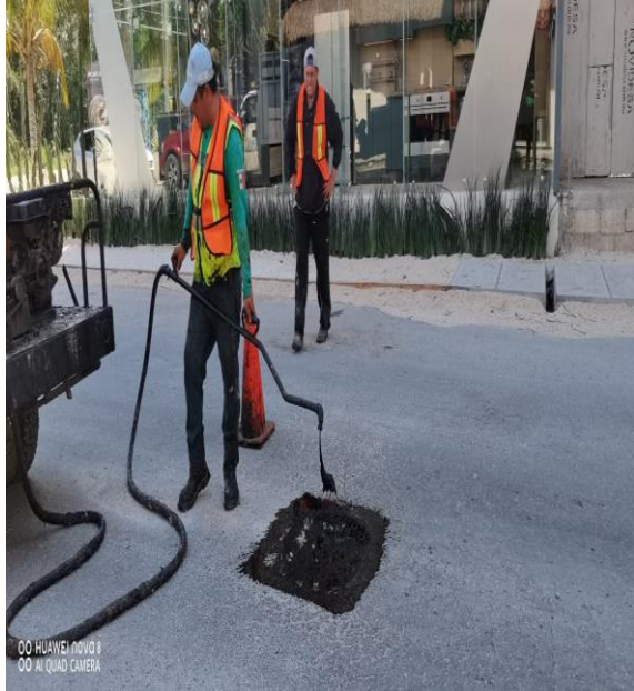
Bacheo; Calle Andrómeda oriente entre escorpión y av coba sur.
