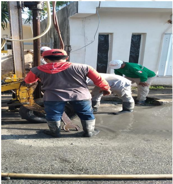
Desazolve de pozos; Calle sagitario oriente entre alfa norte.
