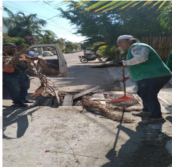
Limpeza de rejillas; Calle 5 entre calle 2 bis.
