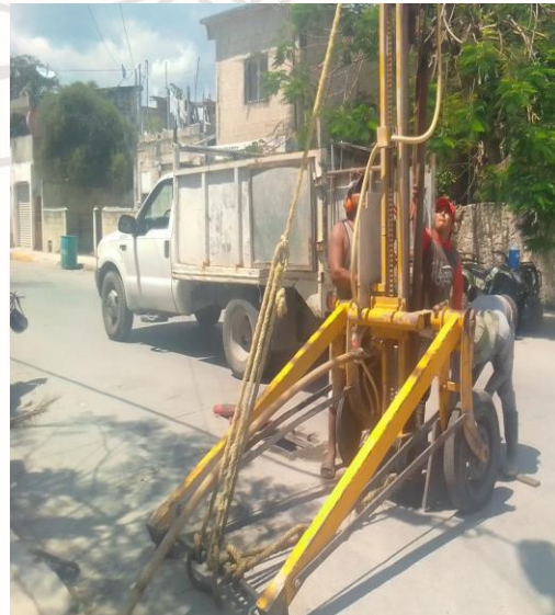
Desazolve de pozos; Calle mercurio poniente entre Kukulkán.
