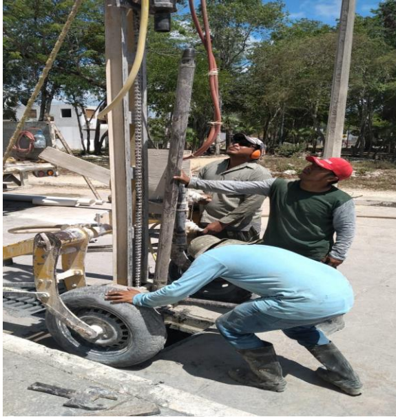
Desazolve de pozos; Calle palmas reina entre bulevar palmas.
