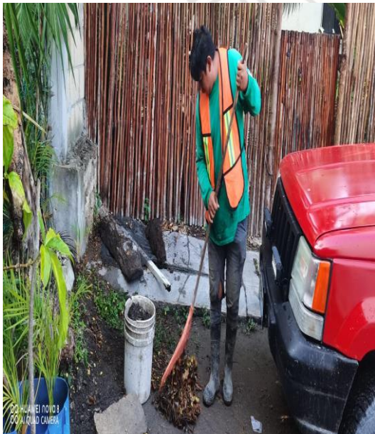
Limpeza De Rejillas: Calle 2 bis oriente entre la calle 3 sur y la calle 11
