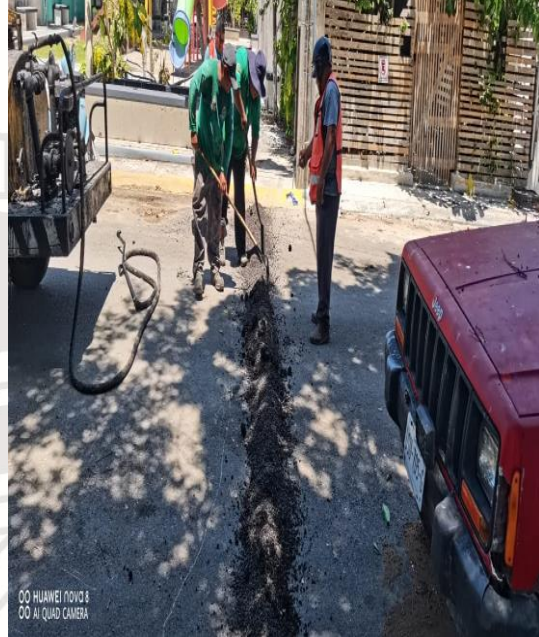
Bacheo; Calle 17 entre la calle 4 oriente y calle 2 bis oriente
