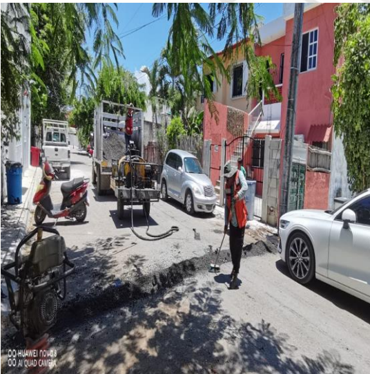
Bacheo; Calle 17 entre la calle 4 oriente y calle 2 bis oriente
