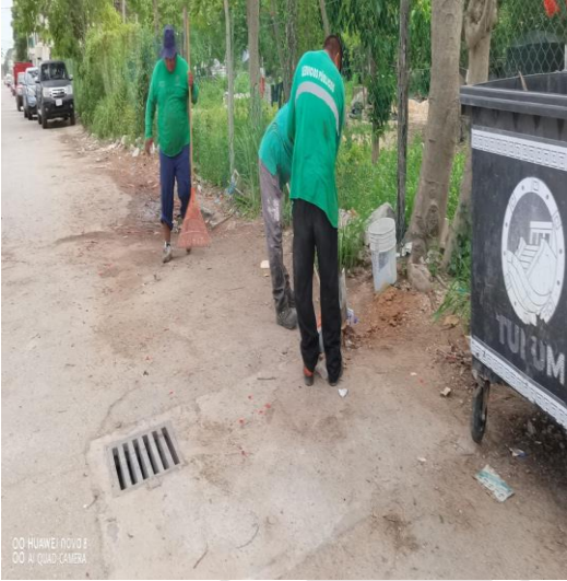
Limpeza De Rejillas: Calle polar poniente entre la calle centauro norte y la Av. satélite
