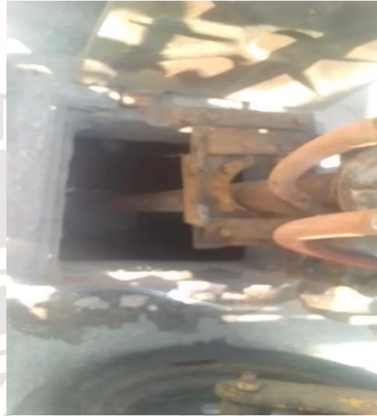
Desazolve de pozos; Calle saturnino sur entre Ontario poniente.
