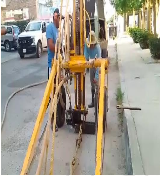
Desazolve de pozos; Calle júpiter entre Neptuno poniente.
