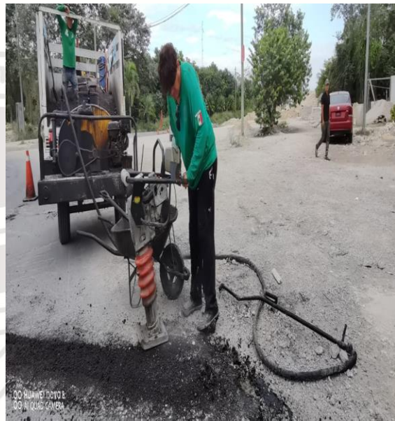
Bacheo; Calle 2 norte entre 10 norte.
