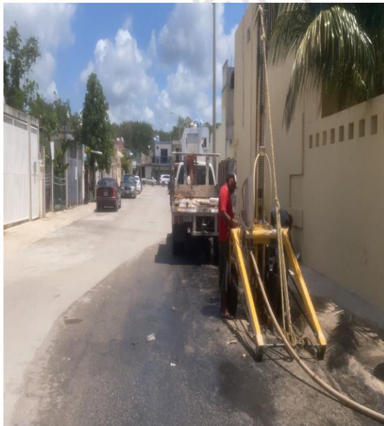
Desazolve de pozos; Calle guinea entre palmas rapiz.
