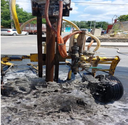
Desazolve de pozos; Calle 11 entre calle 4.
