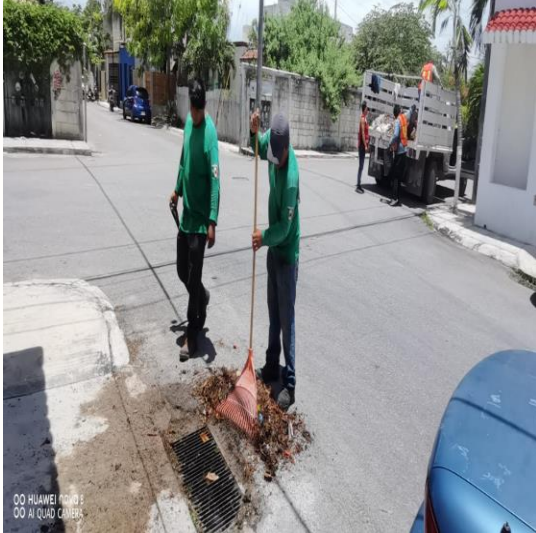
Limpeza De Rejillas: Calle 2 oriente entre la calle 11 y calle 13
