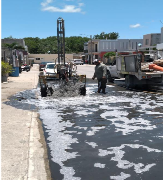
Desazolve de pozos; Calle palmas chat entre calle bulevar.
