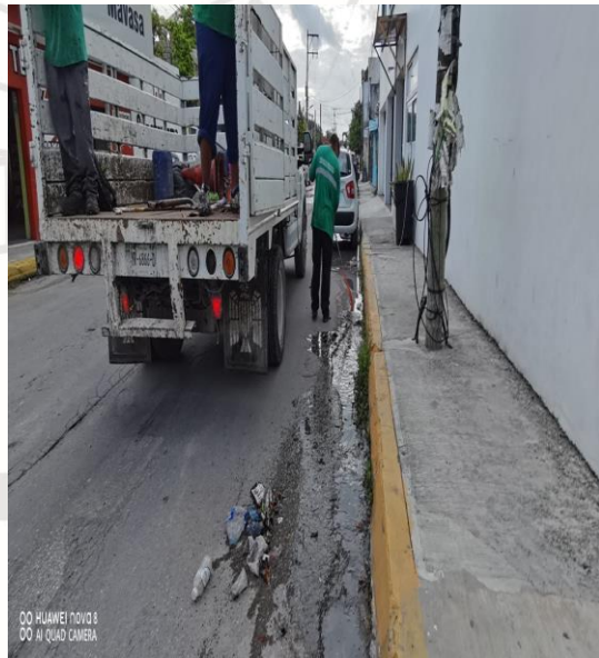
Limpeza De Rejillas: Calle polar poniente entre la calle Orión Norte y la calle centauro norte
