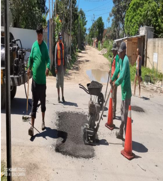
Bacheo; Calle mercurio oriente entre la calle beta sur y orión sur
