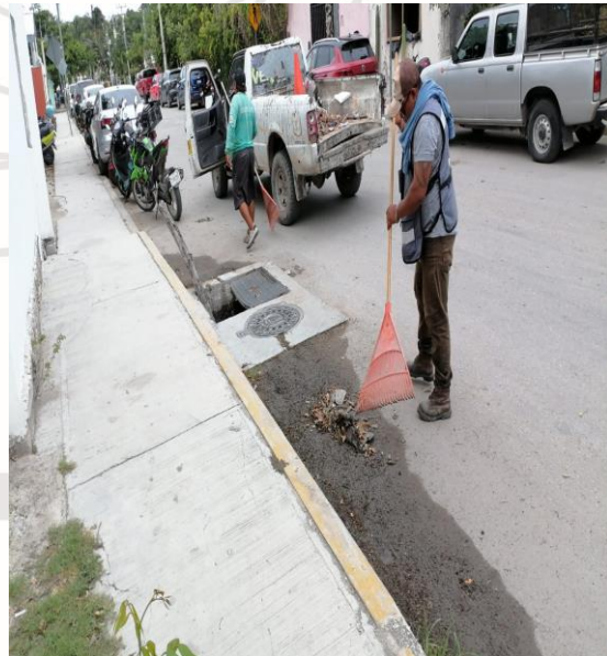
Limpeza De Rejillas: Calle libra sur y calle Andromeda oriente
