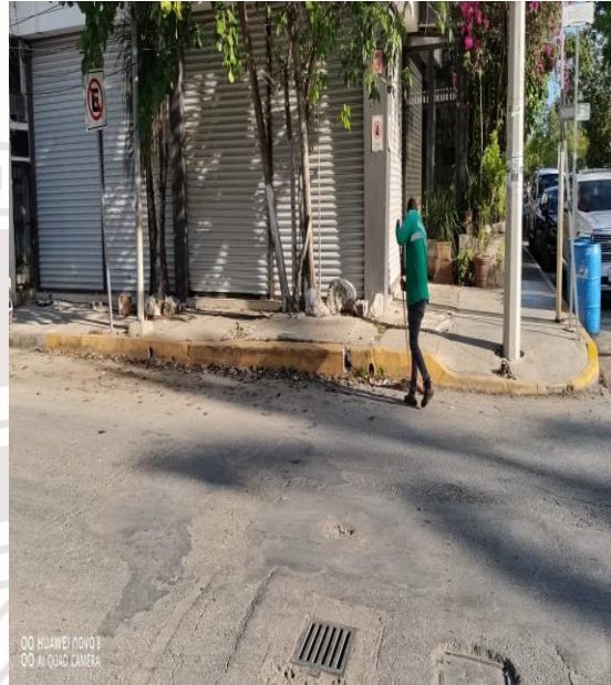
Limpieza de rejillas; Sagitario oriente entre av. satélite y centauro norte.
