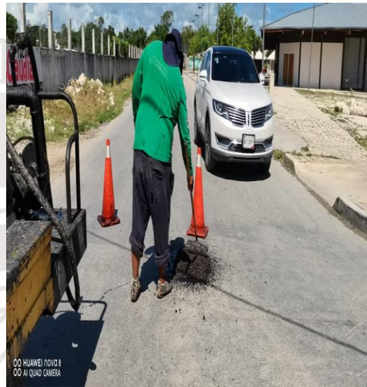
Bacheo; Calle mercurio poniente entre calle Osiris sur y calle beta sur
