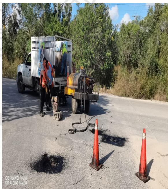
Bacheo; Av 1 entre tepescuintle y 4 oriente.
