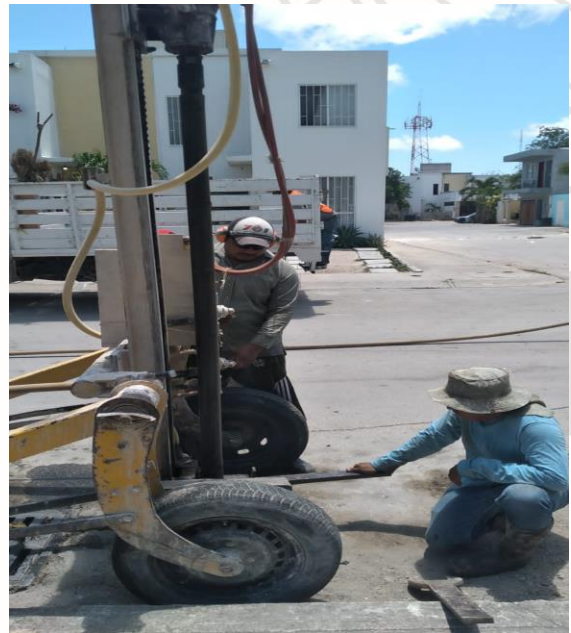
Desazolve de pozos; Calle palma kerpis entre boulevard palmas.
