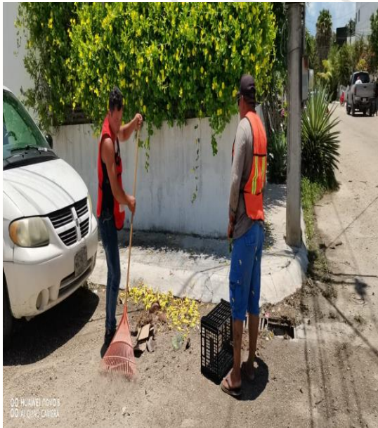
Limpeza De Rejillas: Calle 5 sur entre calle 2 oriente y calle 2 oriente
