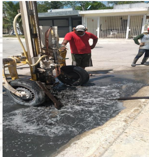
Desazolve de pozos; Calle guinea entre palmas rapiz.
