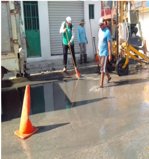
Desazolve de pozos; Calle sol poniente entre omega sur.
