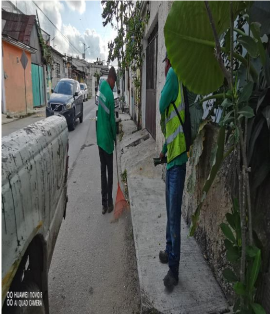
Limpieza de rejillas; Calle sagitario oriente entre calle orión norte y calle beta norte.
