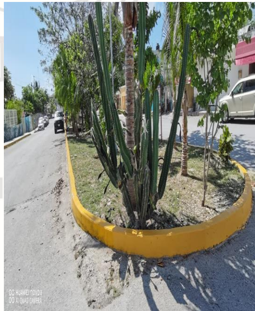
Pintura; Akumal Pueblo.
