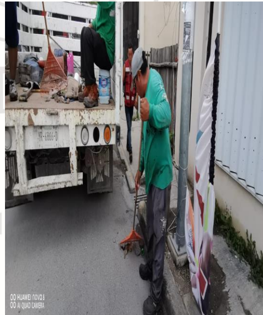
Limpeza De Rejillas: Calle sagitario oriente entre la calle beta norte y la calle Osiris
