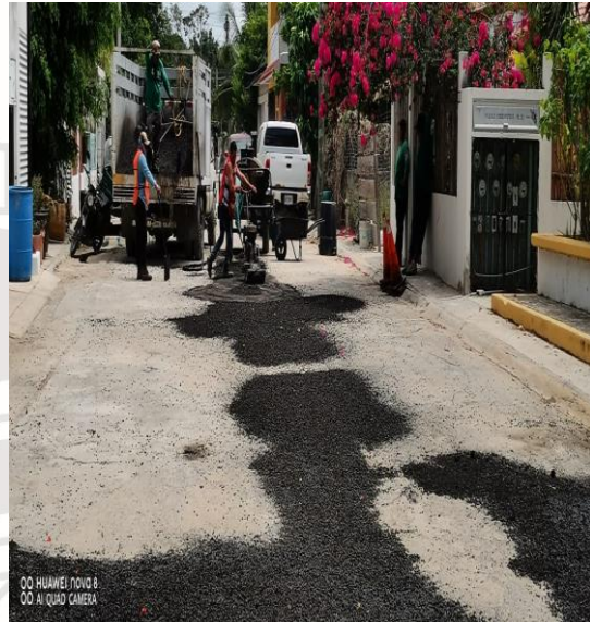
Bacheo; Fraccionamiento Villas Tulum. Calle chemuyil entre la calle 4 oriente y la calle 17
