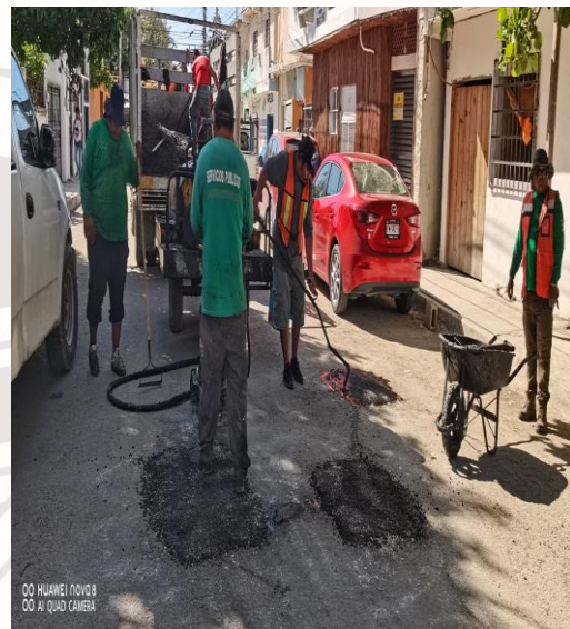
Bacheo; Calle mercurio poniente entre la calle acuario sur y Júpiter sur.
