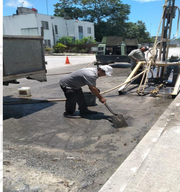
Desazolve de pozos; Calle palmas chat entre calle bulevar.
