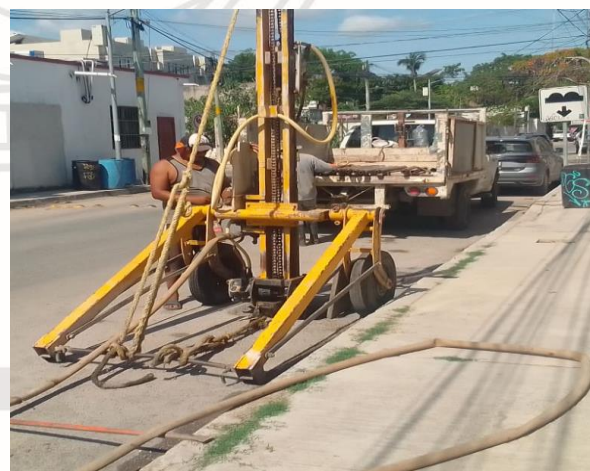
Desazolve de pozos; Calle 7 entre 2 bis oriente.
