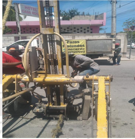
Desazolve de pozos; Calle acuario sur entre sol poniente.
