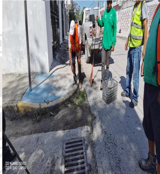
Limpieza de rejillas; Calle asteroides oriente entre calle centauro sur y Órion sur.
