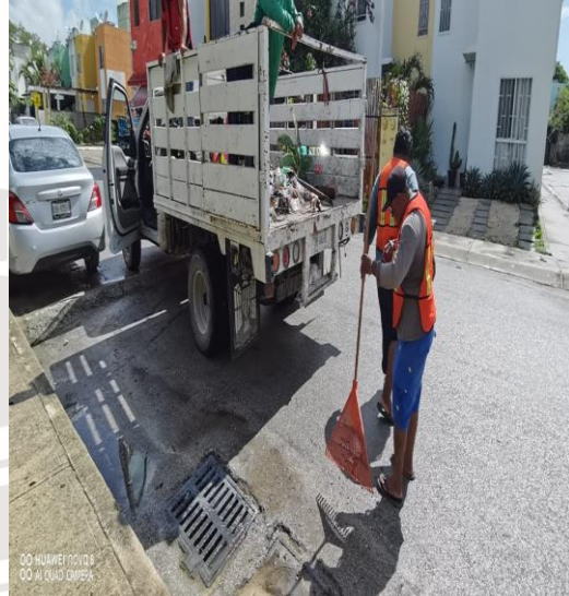
Limpeza De Rejillas: Calle palmas Tulum entre la calle baru
