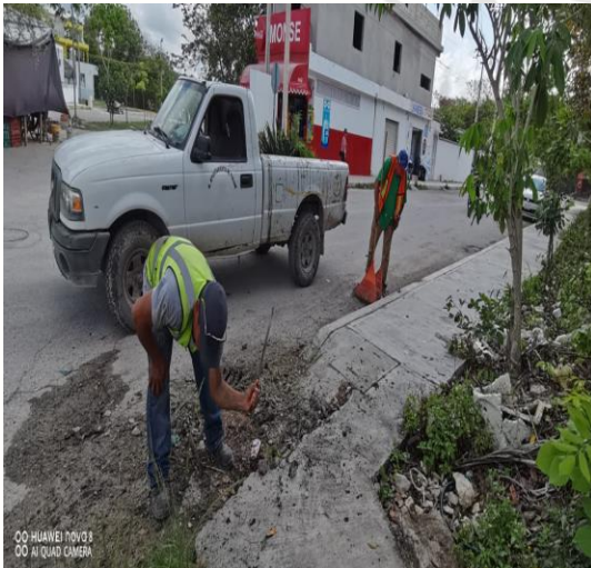
Limpieza de rejillas; Calle guut entre calle tumben-ha y caalche.
