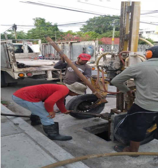
Desazolve de pozos; Calle polar poniente / osiris norte.
