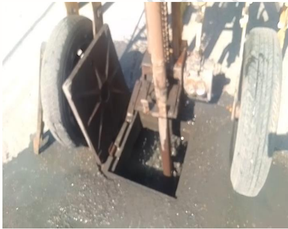
Desazolve de pozos; Calle 7 entre 2 bis oriente.
