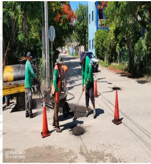
Bacheo; Calle mercurio poniente entre la calle Luna poniente y alfa sur
