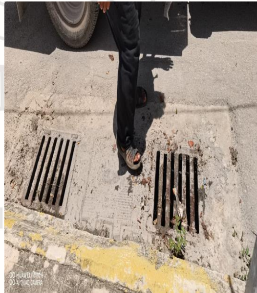
Limpeza De Rejillas: Calle 4 oriente y la calle géminis norte
