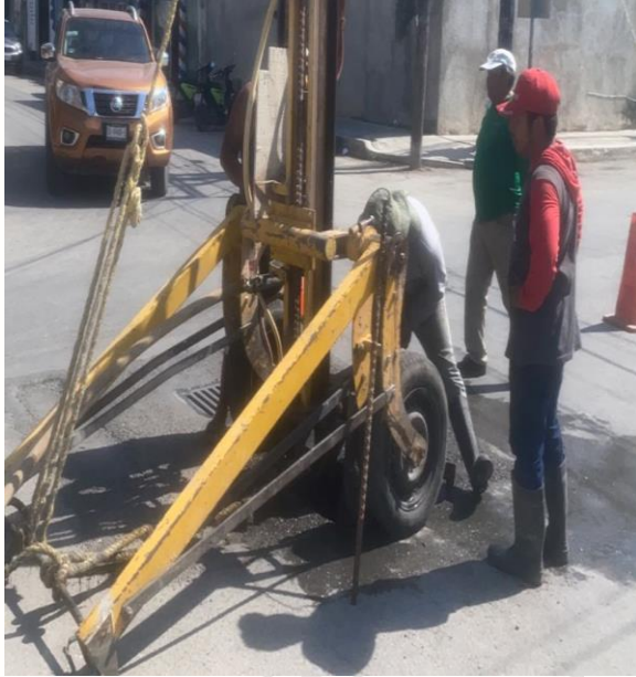
Desazolve de pozos; Calle 9 entre 2 bis oriente.
