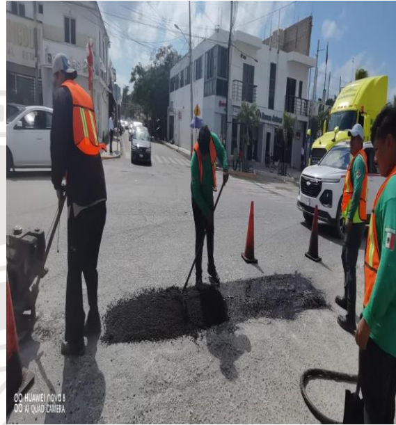
Bacheo; Av Tulum entre av kulkan.
