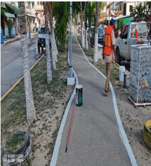
Pintura; Akumal Pueblo.
