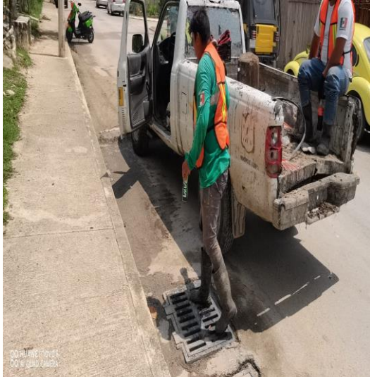
Limpeza De Rejillas: Calle palmas ostil entre calle palmas baru
