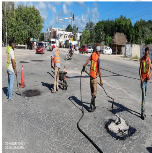
Bacheo; Av. coba entre calle polar oriente y sagitario oriente.
