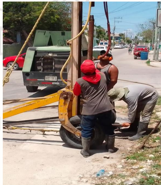
Desazolve de pozos; Calle 16 sur entre 7 sur.
