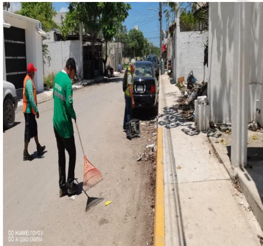
Limpieza de rejillas; Calle golondrina entre calle chanchen y av kukulkan.
