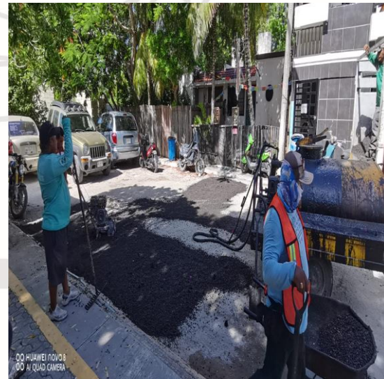
Bacheo; Fraccionamiento Villas Tulum. Calle chemuyil entre la calle 4 oriente y la calle 17
