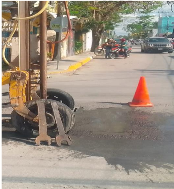
Desazolve de pozos; Calle júpiter norte entre 2 oriente.
