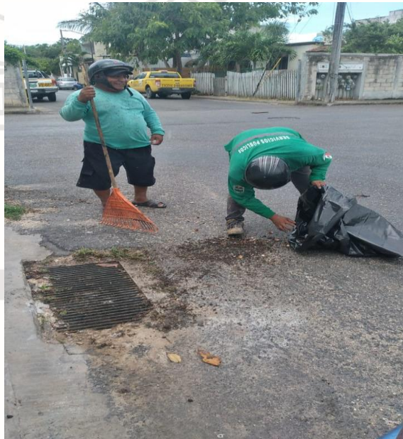
Limpeza de rejillas; Calle 2 bis / calle 11.
