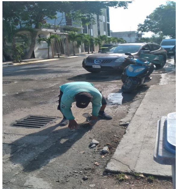
Limpieza de rejillas; Calle escorpión entre calle 4 poniente.
