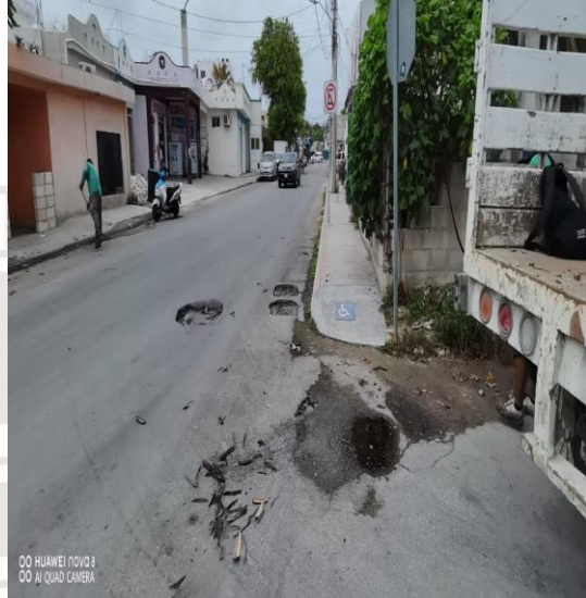
Limpeza De Rejillas: Calle sagitario oriente y la calle acuario norte y la calle zazil-ha
