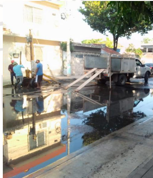
Desazolve de pozos; Calle júpiter sur entre av tulum.
