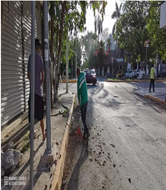
Limpieza de rejillas; Sagitario oriente entre av. satélite y centauro norte.
