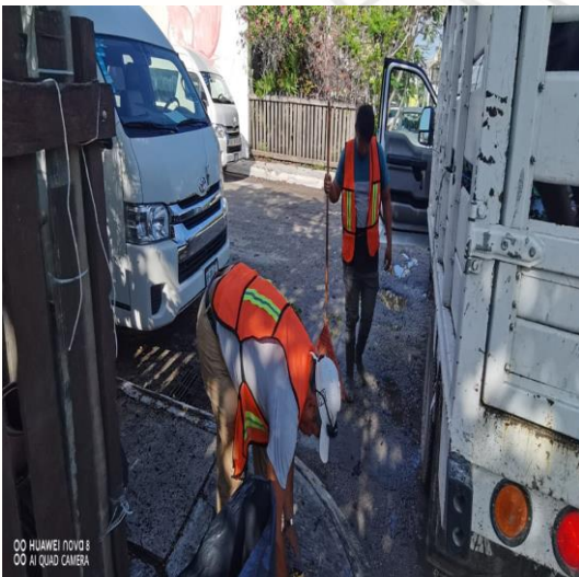
Limpeza de rejillas; Calle 5 sur entre la calle 2 oriente y la calle 2 a bis oriente
