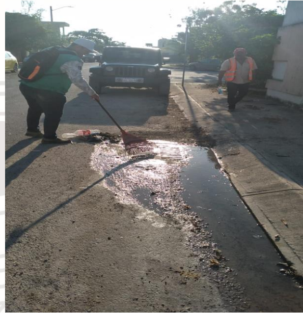
Limpieza de rejillas; Calle palma chat entre calle palmas bulevar.
