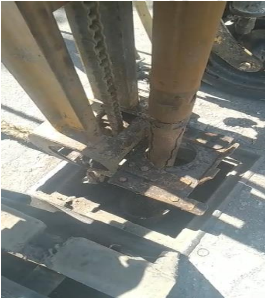
Desazolve de pozos; Calle acuario entre av tulum.
