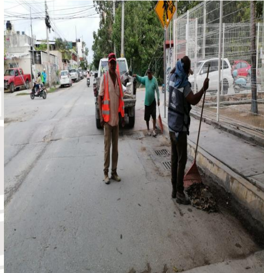
Limpeza De Rejillas: Calle sol oriente y calle libra sur
