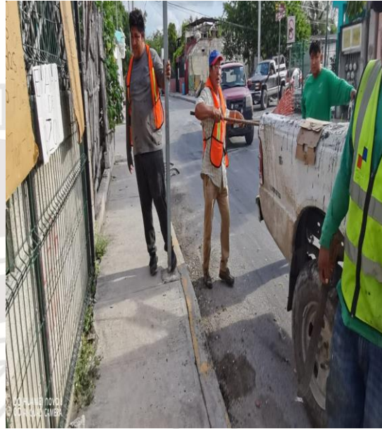
Limpeza de rejillas; Calle acuario norte entre calle polar poniente y calle sagitario poniente.
