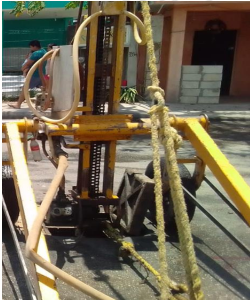
Desazolve de pozos; Calle tun-kul entre alfa norte.
