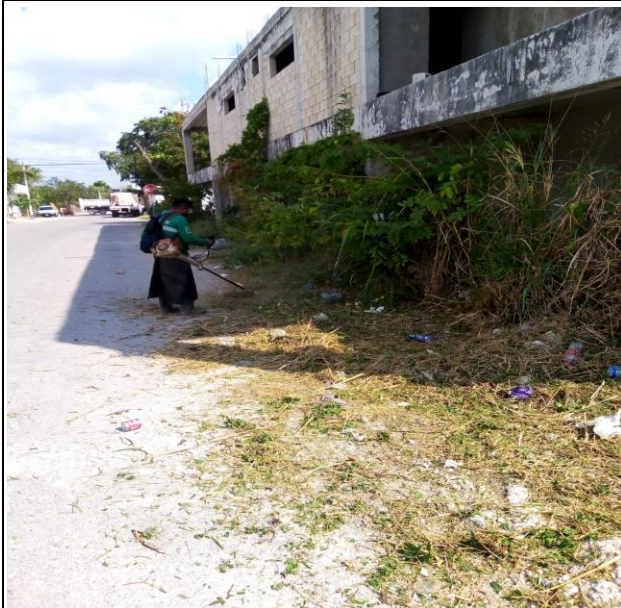
PODA DE MALEZA; CALLE OMEGA ENTRE CALLE TUN-K'UL Y CALLE OOK-K'OT.
