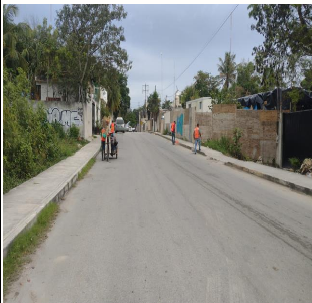
CALLE POLAR PONIENTE ENTRE CALLE ACUARIO NORTE Y CALLE ALFA NORTE; SECTOR NO. 02.
