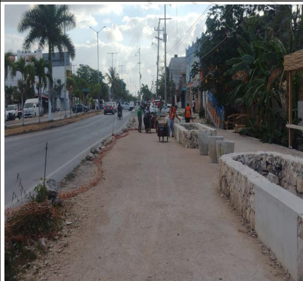
LATERAL IZQUIERDO AV. TULUM ENTRE CALLE ACUARIO Y CALLE PALENQUE LADO SUR.
