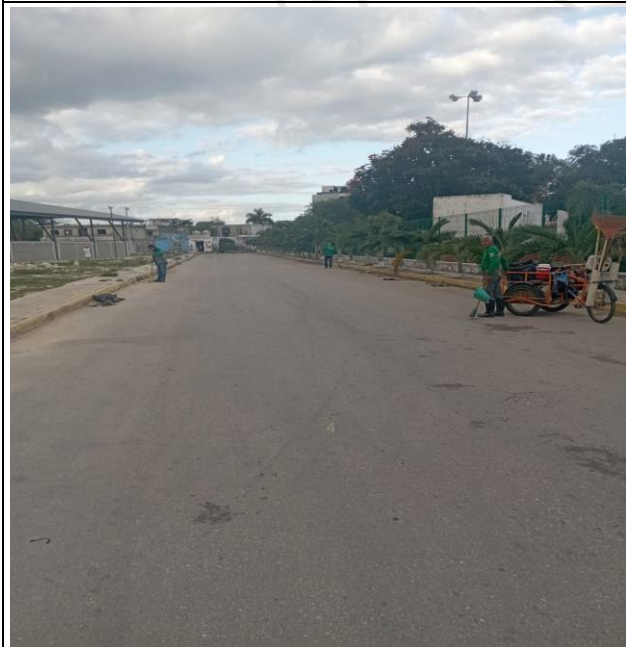
CALLE GAMA ORIENTE ENTRE OSIRIS SUR Y CALLE ALFA SUR.
