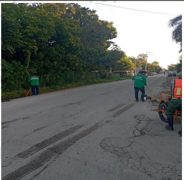
CALLE 2 PONIENTE ENTRE CALLE ALFA NORTE Y CALLE ACUARIO NORTE; SECTOR NO. 02.
