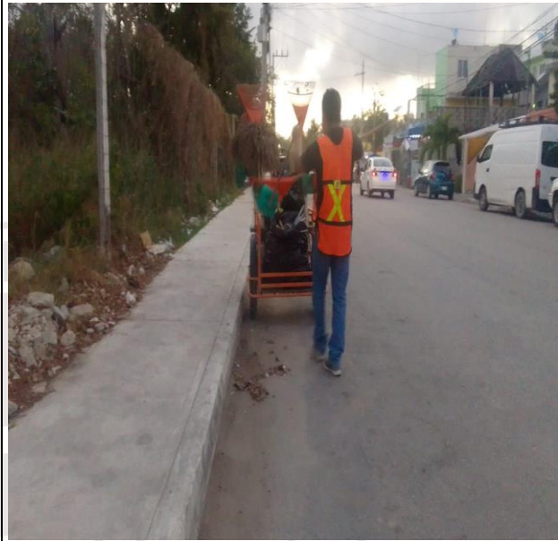
CALLE TUN-K'UL ENTRE AV. SATÉLITE NORTE Y JÚPITER NORTE; SECTOR NO. 02
