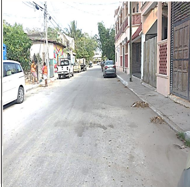
CALLE LUNA PONIENTE ENTRE MERCURIO P Y CALLE ACUARIO; SECTOR NO. 01
