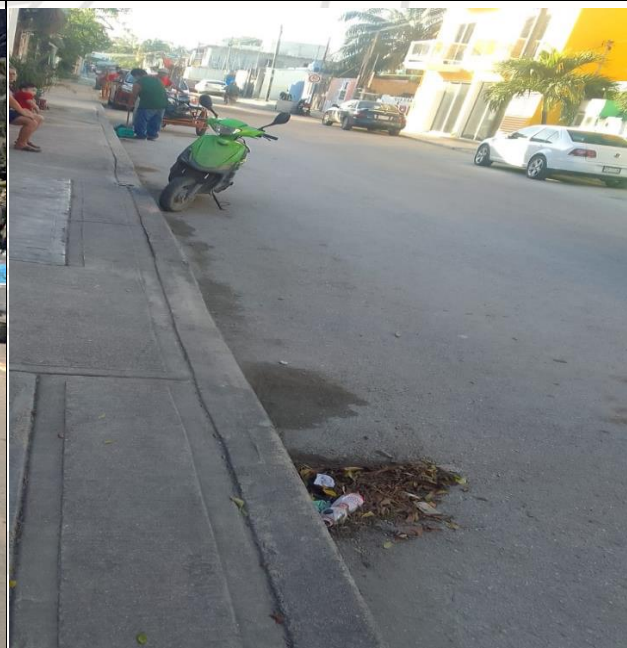
CALLE NEPTUNO ENTRE CALLE OMEGA Y CALLE JÚPITER SUR; SECTOR NO. 01
