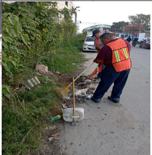
CALLE OMEGA NORTE ENTRE CALLE TUN-K'UL Y AV. OOK-K'OT.
