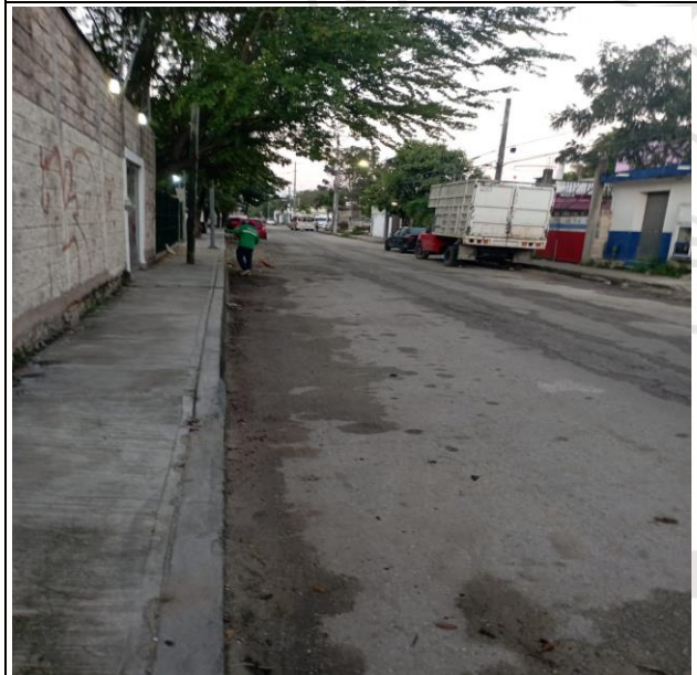
CALLE SAGITARIO NORTE ENTRE CALLE ALFA Y CALLE ACUARIO NORTE; SECTOR NO. 02.
