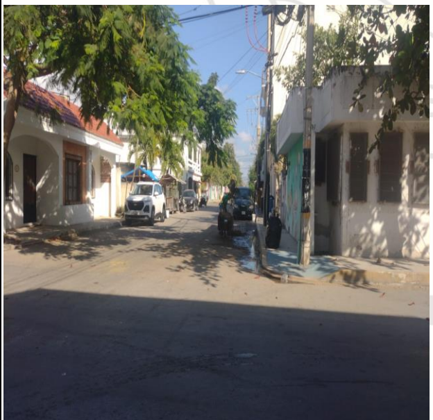
CALLE NEPTUNO ENTRE AV. OSIRIS Y AV. SATÉLITE SUR; SECTOR NO. 04.
