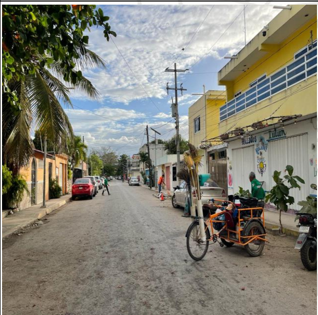
CALLE ANDRÓMEDA ORIENTE ENTRE AV. OSIRIS SUR Y AV. SÁTELITE SUR; SECTOR NO. 04
