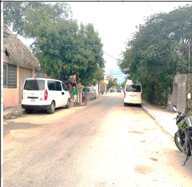
CALLE ASTEROIDES ENTRE CALLE OSIRIS SUR Y AV. SATÉLITE SUR, SECTOR NO. 04
