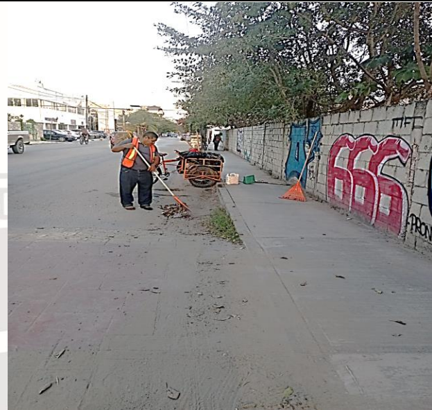
CALLE TUNKUL ENTRE CALLE ALFA NORTE Y CALLE BETA NORTE.
