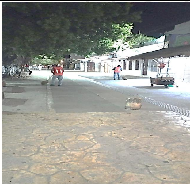
AV. TULUM LATERAL IZQUIERDO DE LA AV. SATÉLITE SUR A LA ACUARIO SUR (REFERENCIA DEL SUBWAY AL SCOTIABANK).
