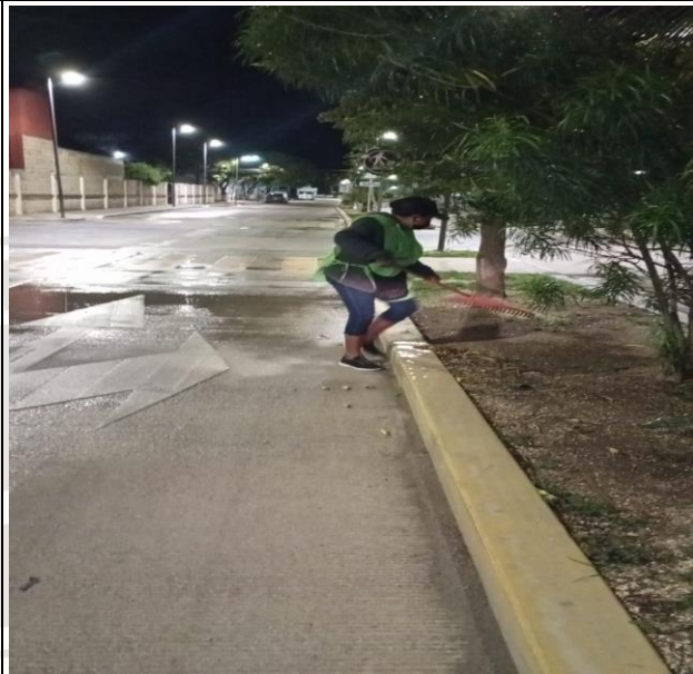
AV. OSIRIS ENTRE AV. TULUM Y MERCURIO PONIENTE.
