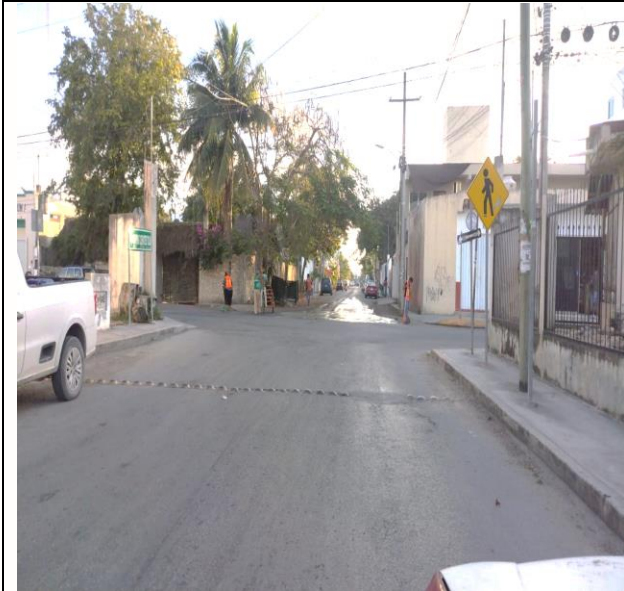
CALLE POLAR PONIENTE ENTRE CALLE ACUARIO ENORTE Y AV. SATÉLITE NORTE, SECTOR NO. 2
