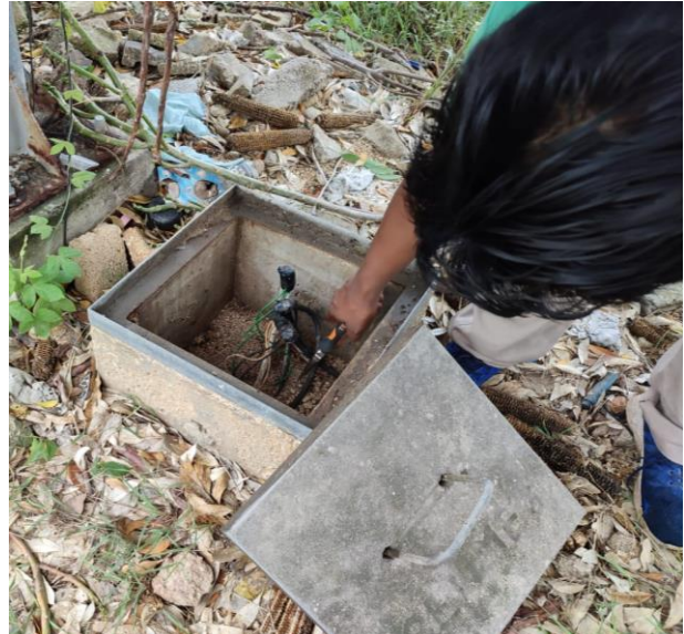
REHABILITACIÓN DE LÍNEAS DE ALUMBRADO PÚBLICO; COL. TUMBEN KAA, AV. 1 Y AV. YOTDZONOT.
