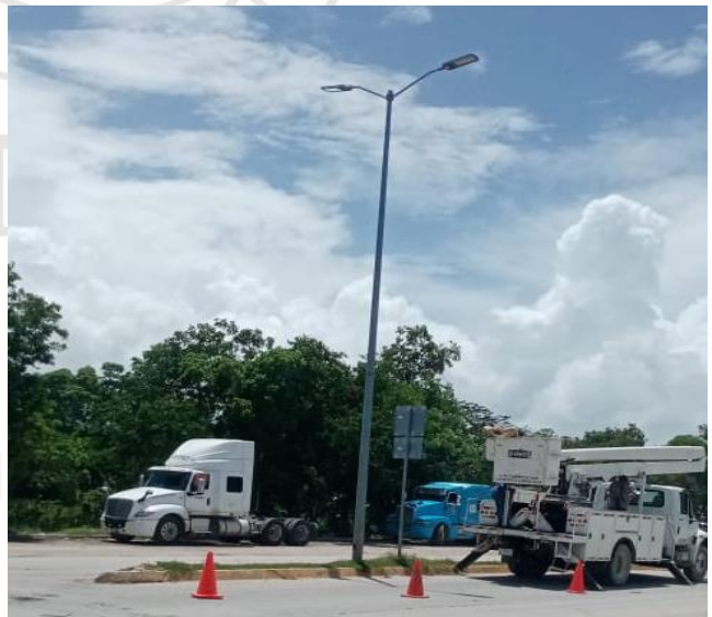
CAMBIO DE LUMINARIA OBSOLETA POR NUEVO TIPO LED; COL. CENTRO, AV. COBA ENTRE AV. TULUM Y CALLE OOK- K'OT.
