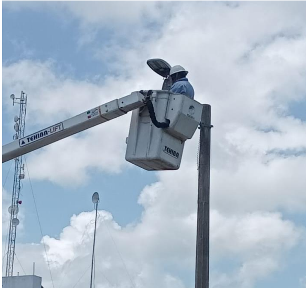
REHABILITACIÓN DE FOTOCELDA; COL. EJIDO, AV. KUKULKAN Y CALLE COCODRILO.
