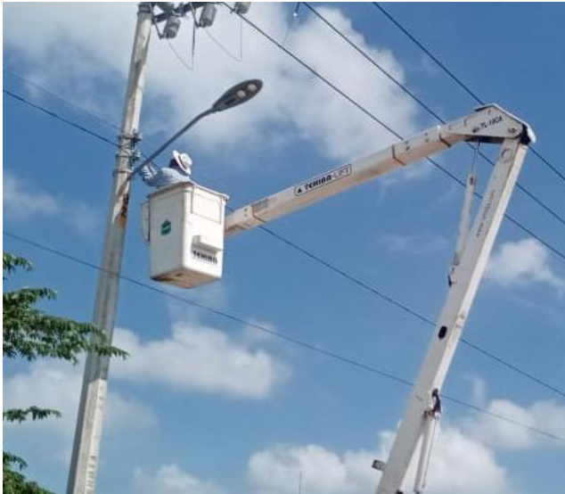
REHABILITACIÓN DE LUMINARIA; COL. CRISTAL.
