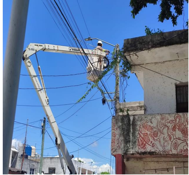
REHABILITACIÓN DE LÍNEAS DE ALUMBRADO PÚBLICO; POBLADO DE CHEMUYIL.
