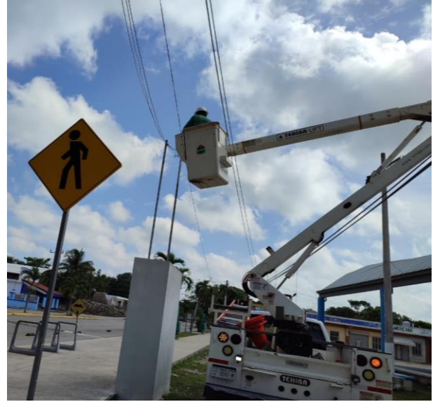
REHABILITACIÓN DE LUMINARIA; POBLADO DE COBA.
