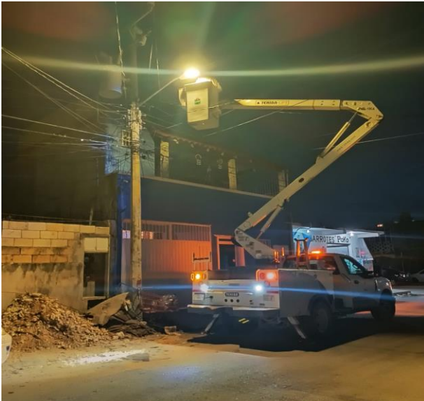
REHABILITACIÓN DE LUMINARIA; COL. MAYAPAX, CALLE KII'S ENTRE AV. SATELITE Y CALLE CENTAURO.
