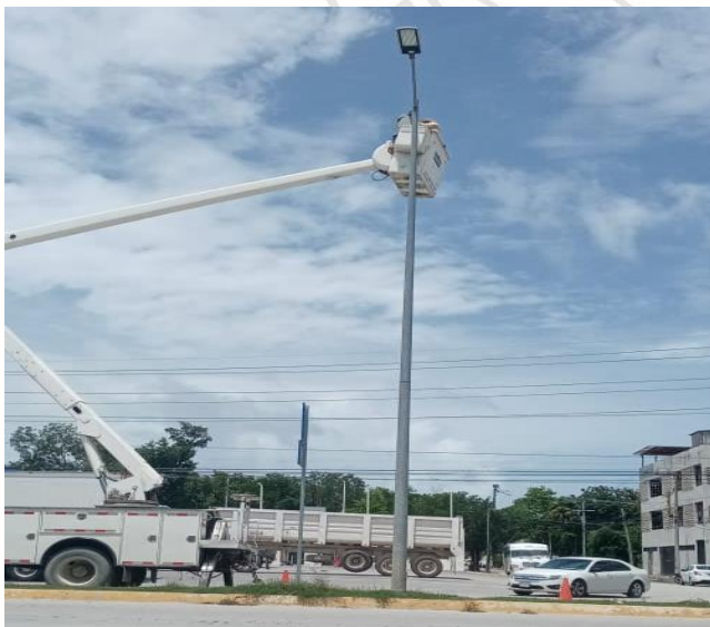
CAMBIO DE LUMINARIA OBSOLETA POR NUEVO TIPO LED; COL. CENTRO, AV. COBA ENTRE AV. TULUM Y CALLE OOK- K'OT.
