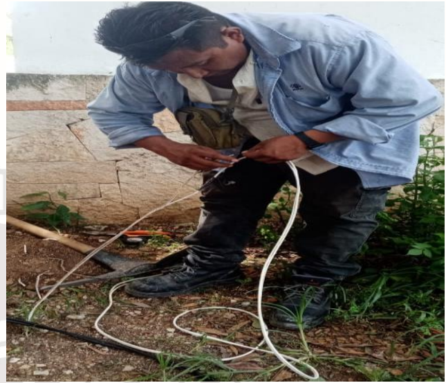
REHABILITACIÓN DE LÍNEAS DE ALUMBRADO PÚBLICO; PARQUE LA CROC, COL. LAKIN, CALLE GAMA ENTRE AV. SATELITE SUR.
