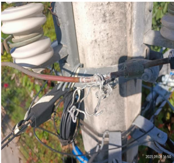
REHABILITACIÓN DE LÍNEAS DE ALUMBRADO PÚBLICO; POBLADO DE MANUEL ANTONIO AY.
