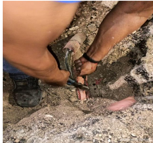
REHABILITACIÓN DE LÍNEAS DE ALUMBRADO PÚBLICO; COL. TUMBEN KAA, CALLE 13 ENTRE AV. 28 Y AV. LA SELVA.
