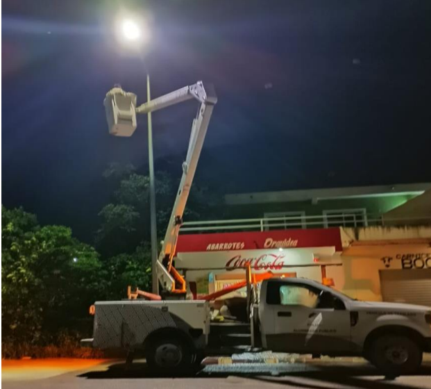
CAMBIO DE LUMINARIA OBSOLETA POR NUEVO TIPO LED; COL. YA'AX TULUM, EN VARIOS PUNTOS.
