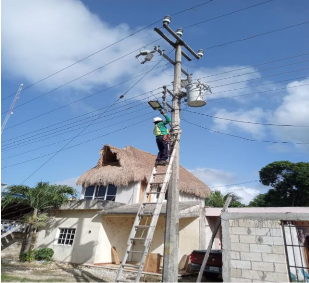
REHABILITACIÓN DE LUMINARIA; POBLADO DE MANUEL ANTONIO AY.
