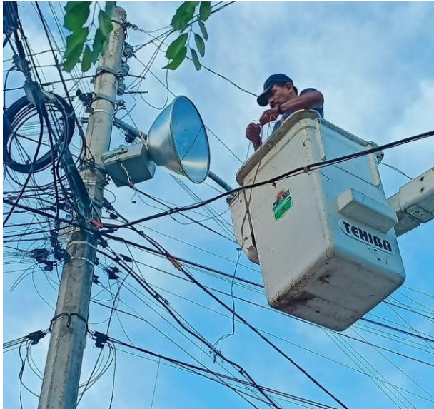
REHABILITACIÓN DE REFLECTOR; COL. CENTRO, CALLE LUNA PTE CON CALLE ONTARIO.
