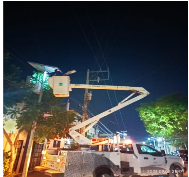
CAMBIO DE LUMINARIA OBSOLETA POR NUEVOS TIPO LED; COL. CENTRO, CALLE 2 OTE ENTRE CALLE JUPITER NTE Y OMEGA NTE.
