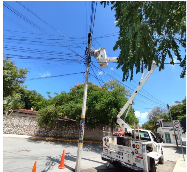
REHABILITACIÓN DE LUMINARIA; CANCHA MAYA, CALLE LUNA SUR ENTRE CALLE ONTARIO Y ACUARIO.
