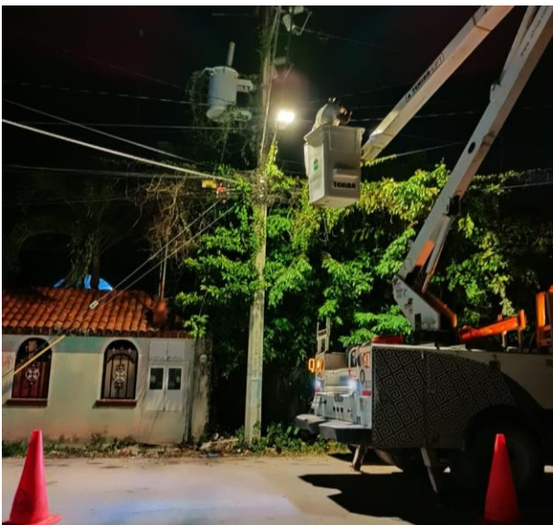
REHABILITACIÓN DE LÍNEAS DE ALUMBRADO PÚBLICO; COL. EJIDO, CALLE VENADO ENTRE AV. SIAN KAN Y AV. LA SELVA.
