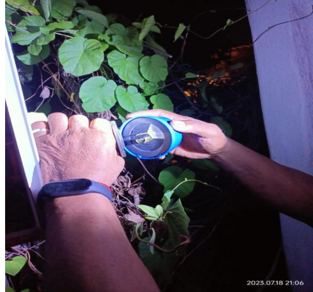
REHABILITACIÓN DE FOTOCELDA; FRACCIONAMIENTO VILLAS TULUM.
