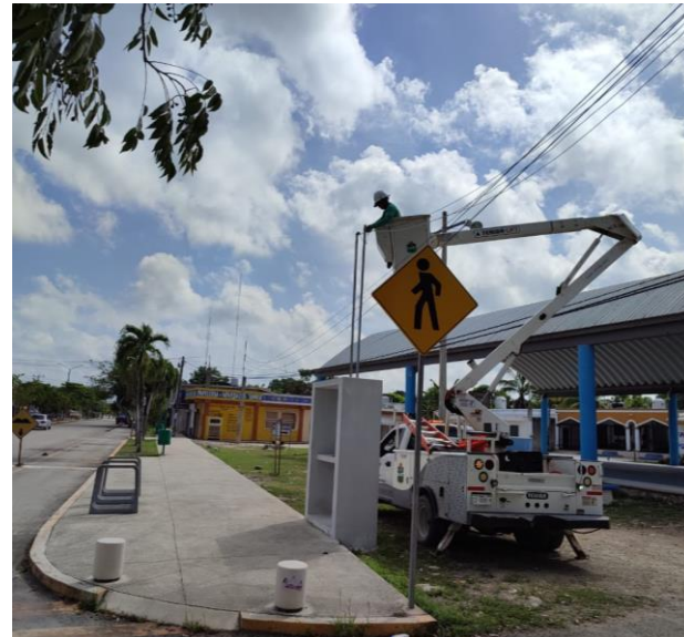
REHABILITACIÓN DE LUMINARIA; POBLADO DE COBA.
