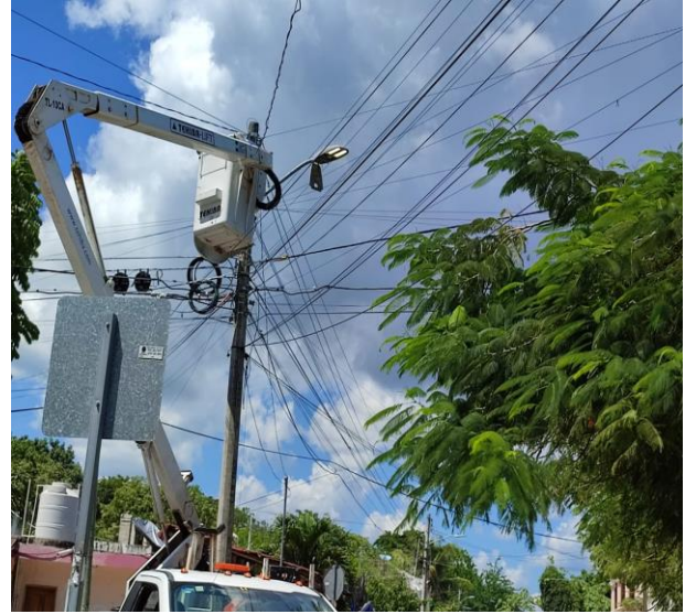
REHABILITACION DE FOTOCELDA; CANCHA MAYA, CALLE LUNA SUR ENTRE CALLE ARIES SUR Y ACUARIO.
