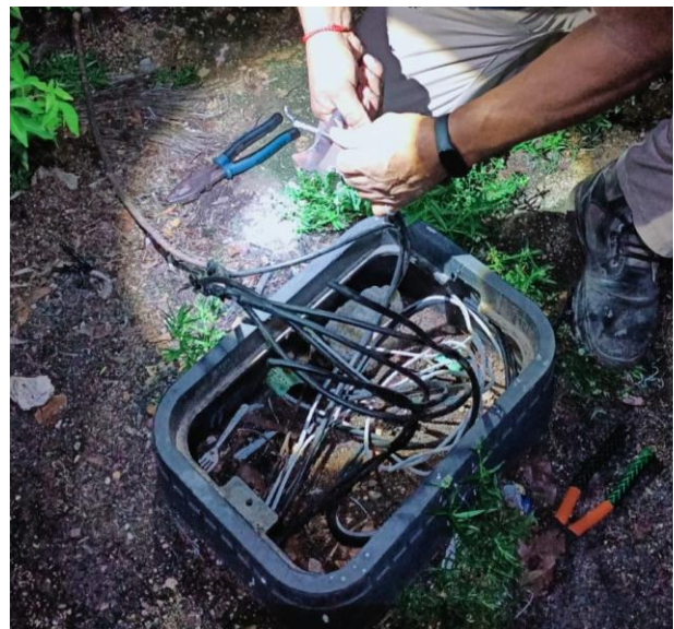
REHABILITACIÓN DE LÍNEAS DE ALUMBRADO PÚBLICO; COL. CENTRO, EN LA UNIDAD DEPORTIVA.
