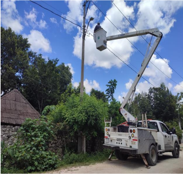
CAMBIO DE LUMINARIA OBSOLETA POR NUEVOS TIPO LED; POBLADO DE MACARIO GOMEZ.
