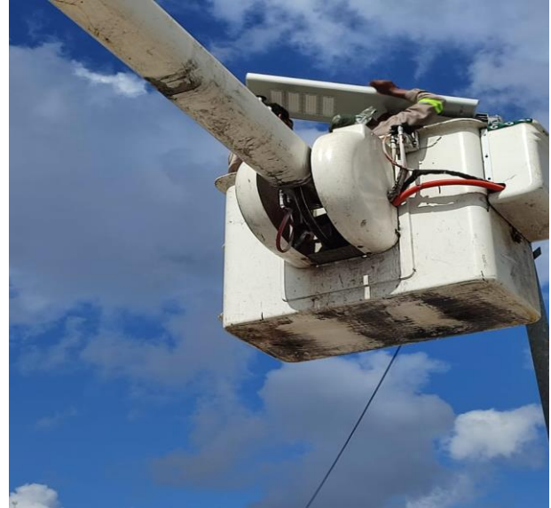
CAMBIO DE LUMINARIA OBSOLETA POR NUEVOS TIPO LED; COL. CENTRO, AV. TULUM ENTRE CALLE BETA Y AV. SATELITE.
