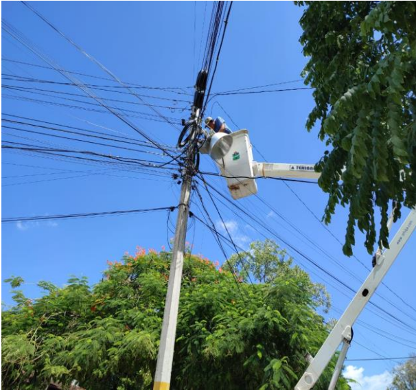
REHABILITACIÓN DE FOTOCELDA; CANCHA MAYA, CALLE LUNA SUR ENTRE CALLE ARIES SUR Y ACUARIO.
