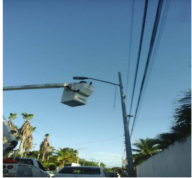
CAMBIO DE LUMINARIA OBSOLETA POR NUEVOS TIPO LED; COL. MAYAPAX, CALLE ALFA NTE ENTRE CALLE 4 OTE Y TUN-K'UL.
