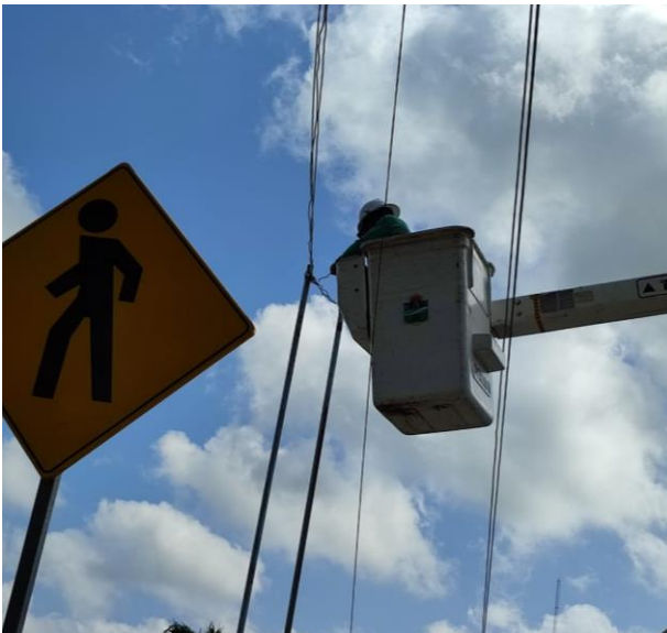
REHABILITACIÓN DE LUMINARIA; POBLADO DE COBA.
