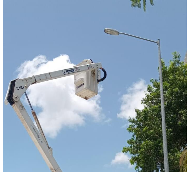
REHABILITACIÓN DE FOTOCELDA; COL. EJIDO, CALLE VENADO Y AV. LA SELVA.
