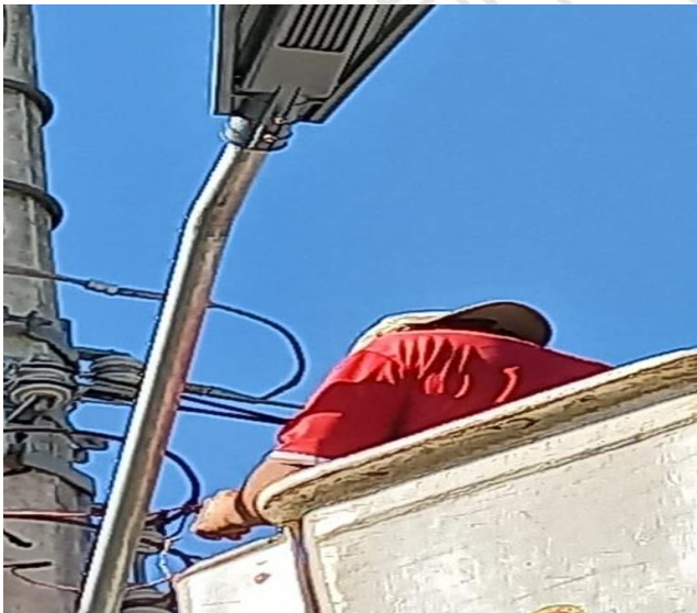
REHABILITACIÓN DE LÍNEAS DE ALUMBRADO PÚBLICO; COL. CRISTAL, EN LA AVENIDA PRINCIPAL.
