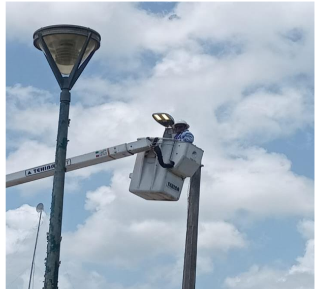
CAMBIO DE LUMINARIA OBSOLETA POR NUEVO TIPO LED; FRACCIONAMIENTO PALMAS PRIVADA, CALLE PALMA YATAY.
