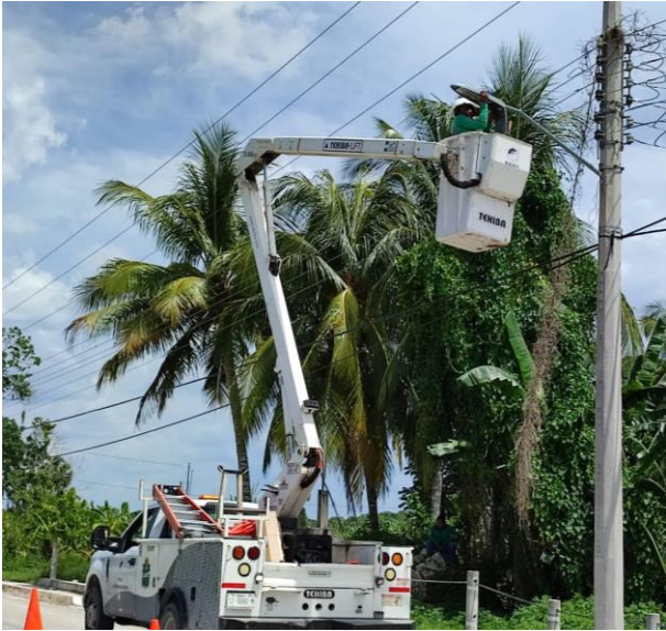
REHABILITACIÓN DE LUMINARIA; POBLADO DE COBA.
