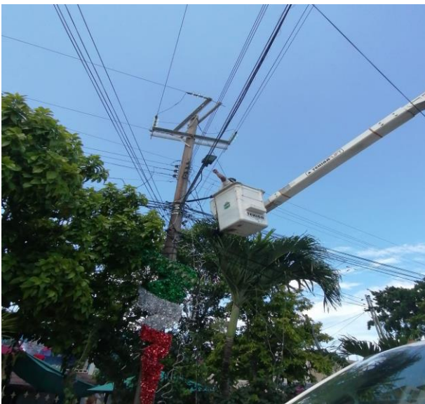
REHABILITACIÓN DE LUMINARIA; POBLADO DE CHEMUYIL.
