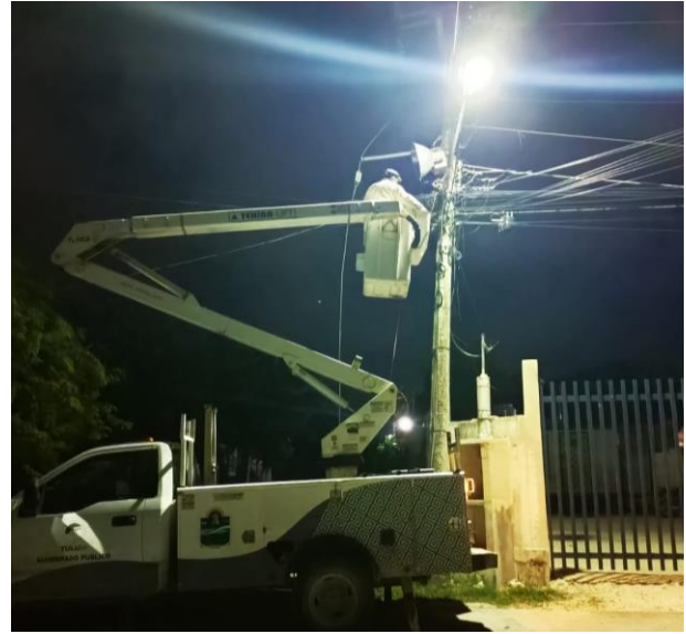
REHABILITACIÓN DE REFLECTOR; COL. EJIDO, CALLE AKUMAL CON ESQUINA CHICHEN ITZA.
