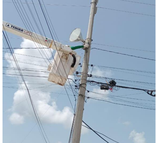
REHABILITACIÓN DE REFLECTOR; COL. TUMBEN KAA, CALLE 20 ENTRE CALLE 25 Y AV. 18.
