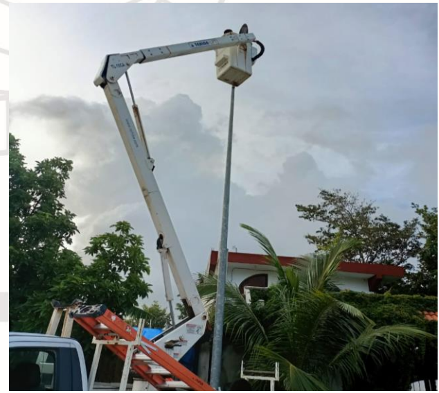
CAMBIO DE LUMINARIA OBSOLETA POR NUEVO TIPO LED; COL. YA'AX TULUM, EN VARIOS PUNTOS.
