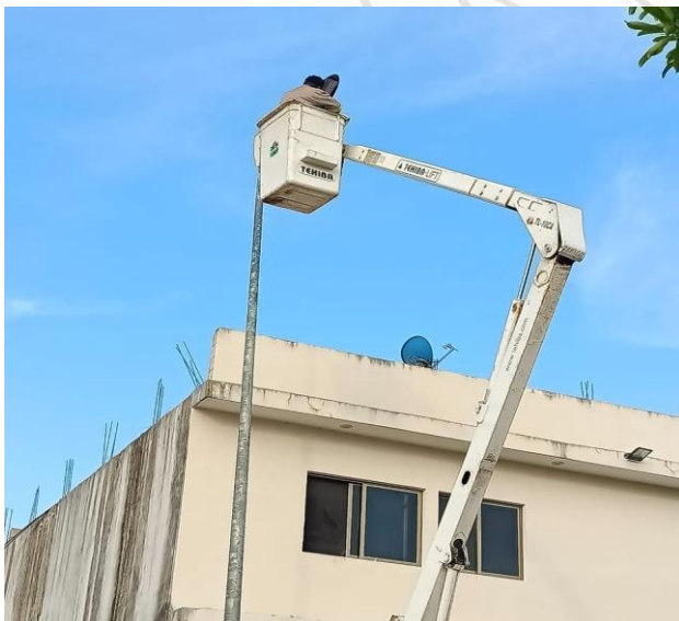
CAMBIO DE LUMINARIA OBSOLETA POR NUEVO TIPO LED; COL. YA'AX TULUM, EN VARIOS PUNTOS.
