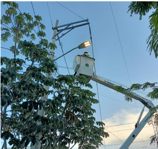
REHABILITACIÓN DE FOTOCELDA; COL. VELETA, CALLE COBA Y CALLE 8.
