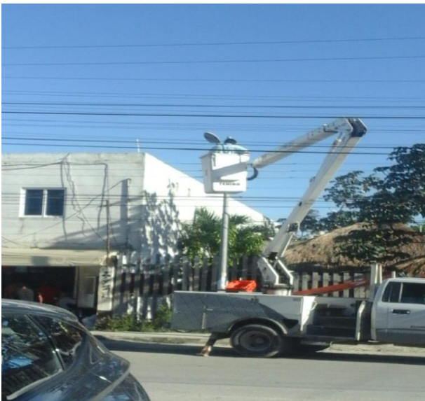
CAMBIO DE LUMINARIA OBSOLETA POR NUEVOS TIPO LED; COL MAYAPAX, CALLE ALFA NTE ENTRE CALLE LE'XIU Y TUN-K'UL.
