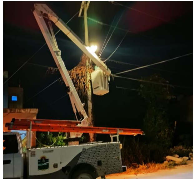
REHABILITACIÓN DE FOTOCELDA; COL. EJIDO, CALLE CODORNIZ ENTRE AV. SIAN KAN Y CHAN-CHEN.
