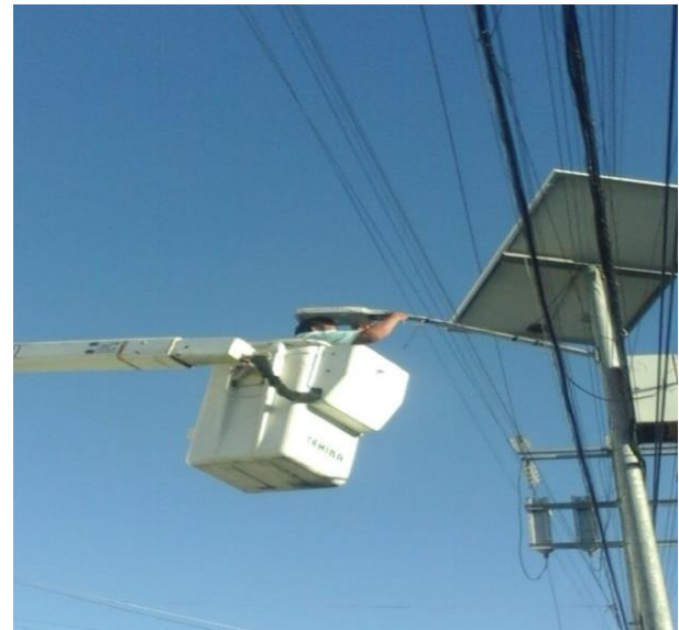
CAMBIO DE LUMINARIA OBSOLETA POR NUEVOS TIPO LED; COL. MAYAPAX, CALLE 4 OTE ENTRE ALFA NTE Y AURORA NTE.
