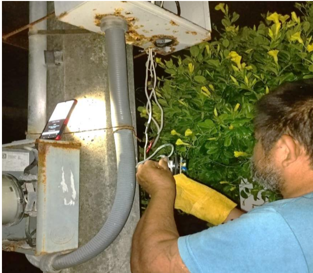
REHABILITACIÓN DE FOTOCELDA; SEGUNDA ETAPA DEL FRACCIONAMIENTO VILLAS TULUM.
