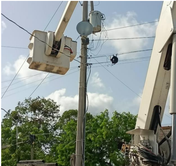
REHABILITACIÓN DE REFLECTOR; COL. TUMBEN KAA, CALLE FAISAN ENTRE CALLE 16 Y AV. 18.
