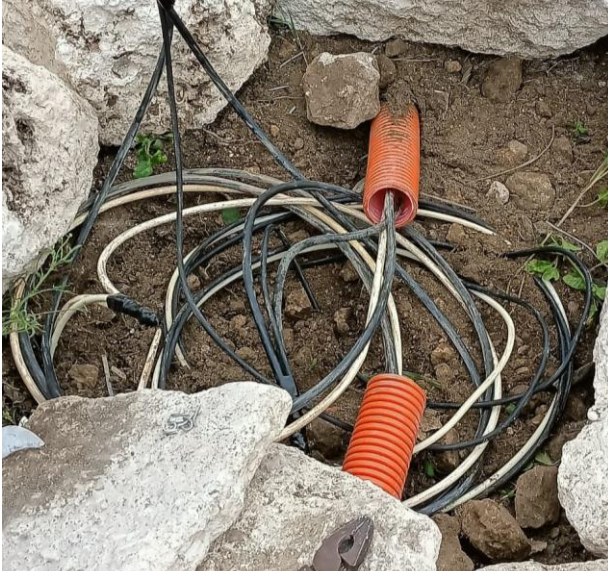
REHABILITACIÓN DE LÍNEAS DE ALUMBRADO PÚBLICO; COL. TUMBEN KAA, AV. LA SELVA ENTRE CALLE RIO DE LA CONCORDIA Y RIO OTATE.
