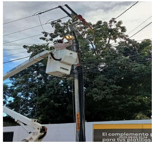
CAMBIO DE LUMINARIA OBSOLETA POR NUEVOS TIPO LED; COL. CENTRO, CALLE OSIRIS ENTRE CALLE SOL OTE Y ANDROMEDA.
