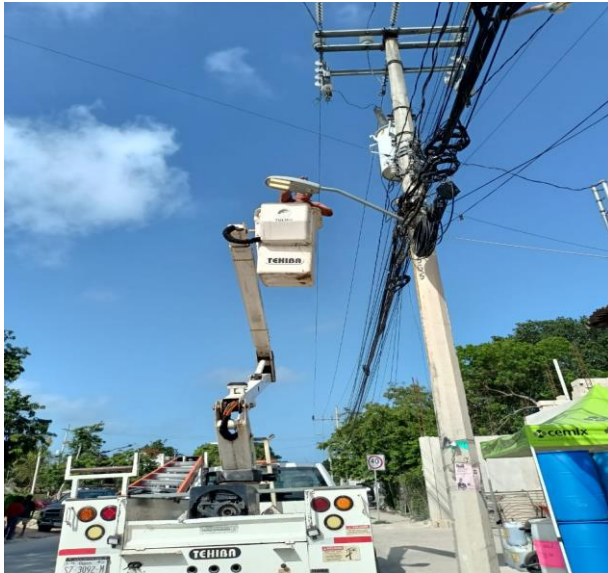
REHABILITACIÓN DE FOTOCELDA; CALLE OOK-K'OT.
