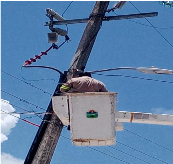
REHABILITACIÓN DE LÍNEAS DE ALUMBRADO PÚBLICO; POBLADO DE MACARIO GOMEZ, PARQUE CENTRAL.
