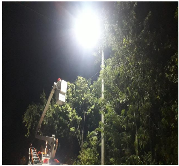
REHABILITACIÓN DE LUMINARIA; COL. TUMBEN KAA, AV. 28 ENTRE CALLE 27 Y 25.
