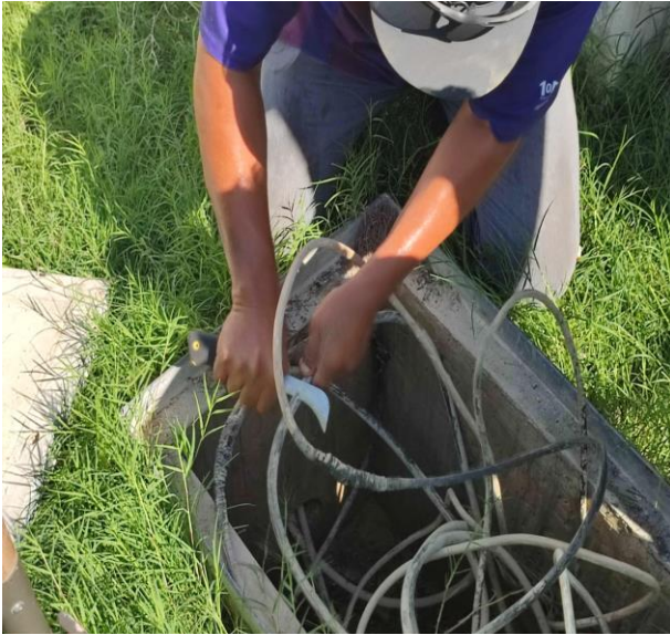
REHABILITACIÓN DE LÍNEAS DE ALUMBRADO PÚBLICO; POBLADO DE AKUMAL, CALLE PUNTA XEL-HA Y PUNTA VENADO.
