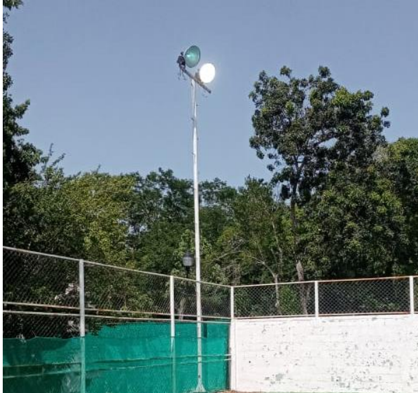
REHABILITACIÓN DE REFLECTOR; COL. CENTRO, EN LA UNIDAD DEPORTIVA.
