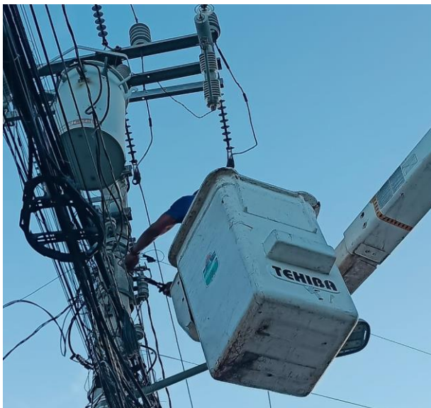
REHABILITACIÓN DE LÍNEAS DE ALUMBRADO PÚBLICO; COL. EJIDO, CALLE OOK-K'OT ENTRE CALLE JUPITER NTE Y ALFA NTE.
