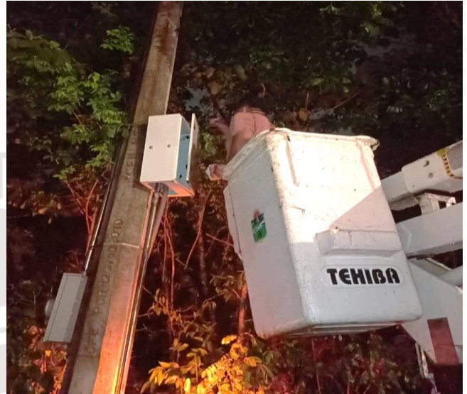
REHABILITACIÓN DE FOTOCELDA; COL. TUMBEN KAA, CALLE 12 ENTRE AV. 1 Y 2 FRENTE AL HOTEL IKER.
