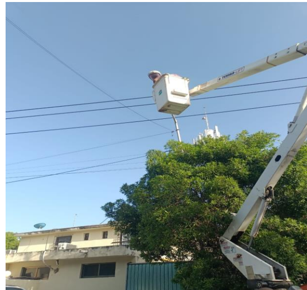
CAMBIO DE LUMINARIA OBSOLETA POR NUEVO TIPO LED; COL. TUMBEN KAA, LADO DE LA FUNERARIA VILLAFANIA Y RIOS.
