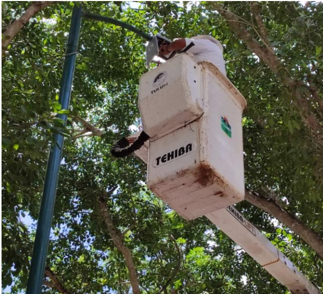
CAMBIO DE LUMINARIA OBSOLETA POR NUEVO TIPO LED; PARQUE LA CROC, COL. LAKIN, CALLE GAMA ENTRE AV. SATELITE SUR.
