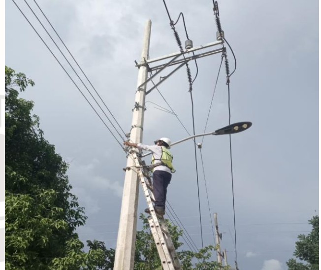
REHABILITACIÓN DE FOTOCELDA; POBLADO DE MANUEL ANTONIO AY.
