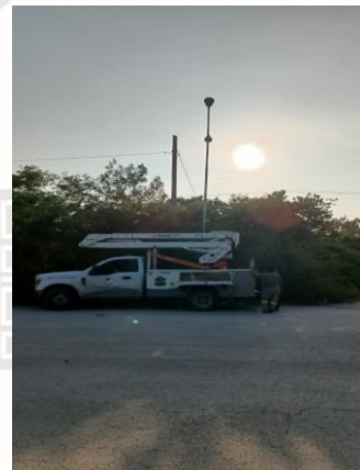
CAMBIO DE LUMINARIAS, COL. TUMBEN KAA, AV. 1 ENTRE CALLE RIO MEDELIN Y 4 NTE.
