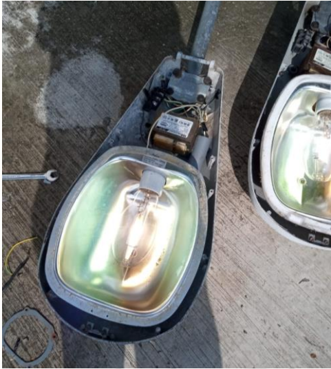
REHABILITACIÓN DE LUMINARIA, COL. CENTRO, CALLE SOL OTE ENTRE OMEGA SUR Y JUPITER SUR.
