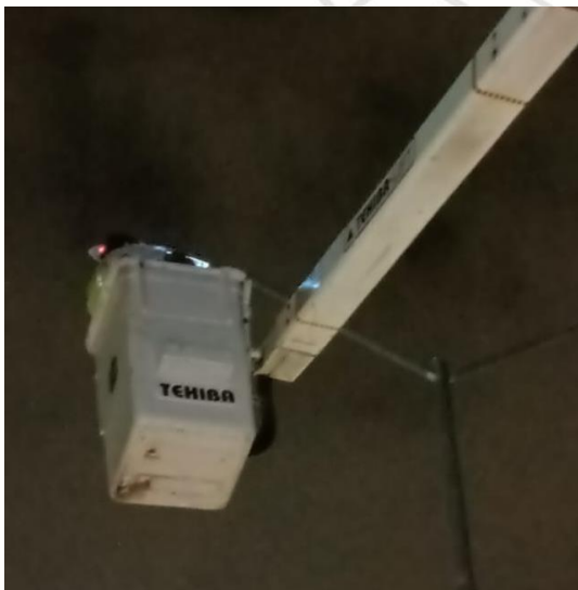
CAMBIO DE LUMINARIAS, COL. TUMBEN KAA, AV. 1.
