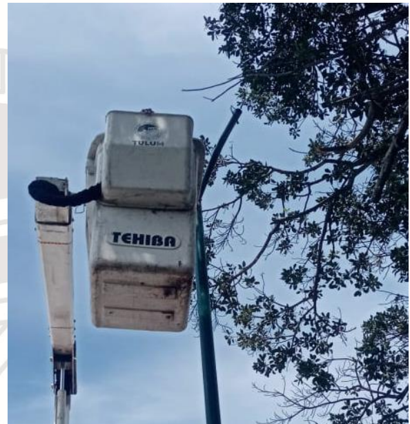
REHABILITACIÓN DE REFLECTOR, COL. CENTRO, EN LA CANCHA DE FUTBOL RAPIDO DE LA UNIDAD DEPORTIVA
