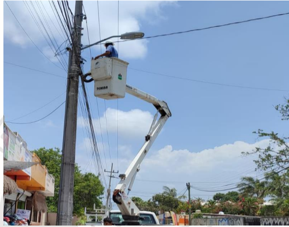
REHABILITACIÓN DE LÍNEAS DE ALUMBRADO PÚBLICO, COL. CENTRO, CALLE ALFA SUR CON ESQUINA SOL OTE.
