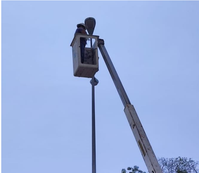
REHABILITACIÓN DE LÍNEAS DE ALUMBRADO PÚBLICO, POBLADO DE AKUMAL.
