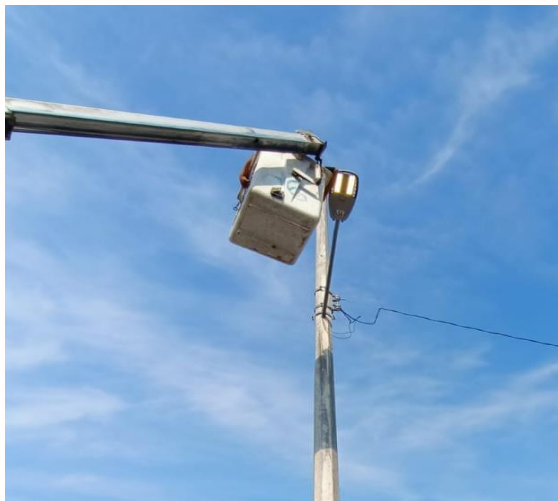
REHABILITACIÓN DE FOTOCELDA, COL. HURACANES, CALLE GEMINIS SUR Y ANDROMEDA OTE.
