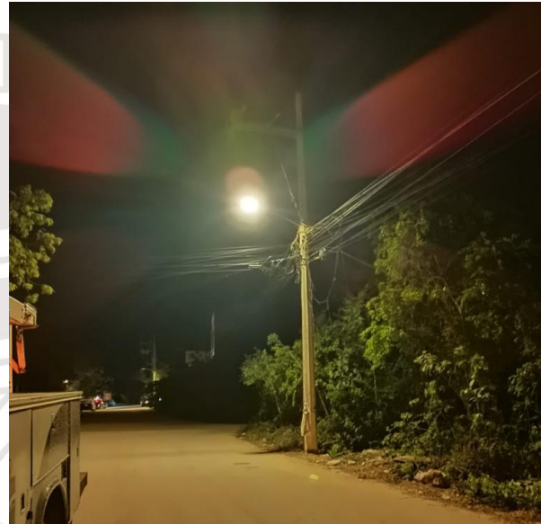
REHABILITACIÓN DE LUMINARIA, COL. LA VELETA, CALLE 16 SUR Y CALLE 13 OTE.
