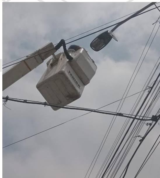
REHABILITACIÓN DE LÍNEAS DE ALUMBRADO PÚBLICO, COL. CENTRO, CALLE SAGITARIO Y ACUARIO.
