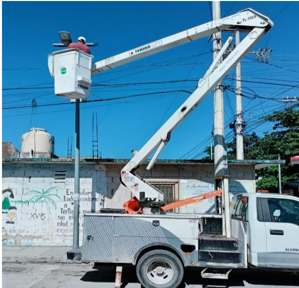
REHABILITACIÓN DE FOTOCELDA, COL. CENTRO, CALLE ALFA NTE ENTRE CALLE POLAR OTE Y SAGITARIO.
