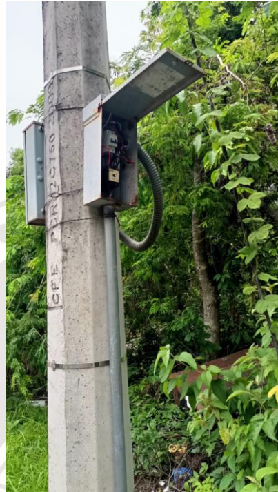
CAMBIO DE POSTES, FRACCIONAMIENTO VILLAS TULUM, CALLE 13 ENTRE CALLE 4 OTE Y 2 OTE.
