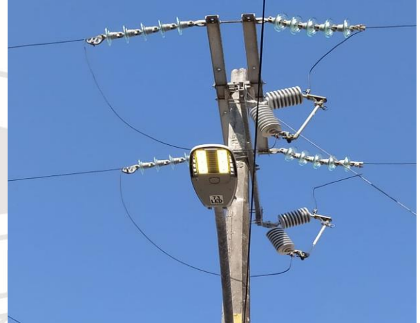
REHABILITACIÓN DE LÍNEAS DE ALUMBRADO PÚBLICO, FRACCIONAMIENTO VILLAS TULUM, CALLE AKUMAL Y XPU-HA.
