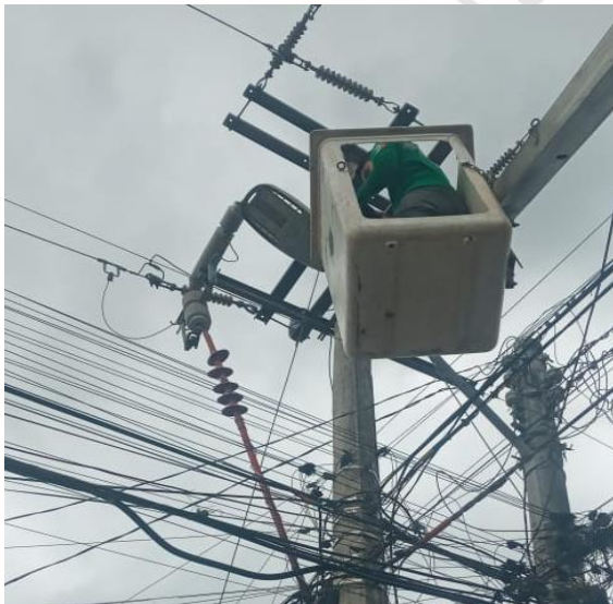
REHABILITACIÓN DE FOTOCELDA, COL. EJIDO NTE, CALLE LUNA PTE ENTRE AV. TULUM Y CALLE POLAR PTE.
