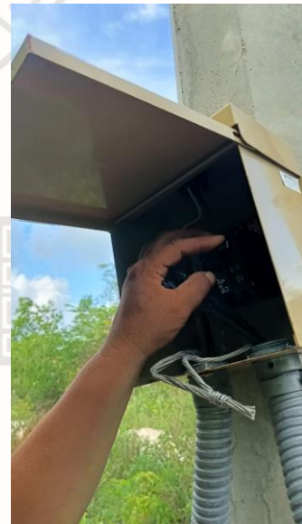
REHABILITACIÓN EN BANCO DE CONTROL, COL. CRISTAL.
