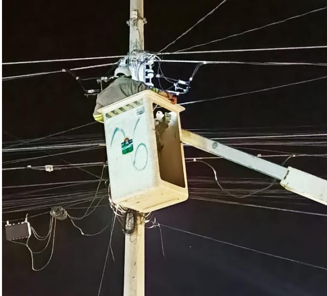
REHABILITACIÓN DE BASE DE FOTOCELDA DAÑADA, COL. CENTRO, CALLE ALFA SUR ENTRE CALLE GAMA OTE Y MERCURIO.
