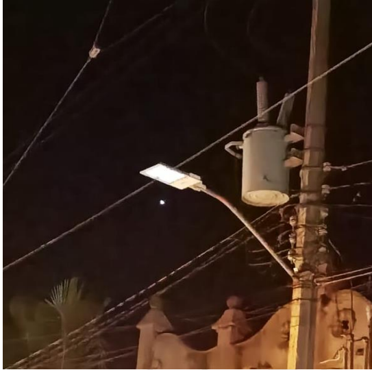
REHABILITACIÓN DE LUMINARIA, POBLADO DE MANUEL ANTONIO AY.
