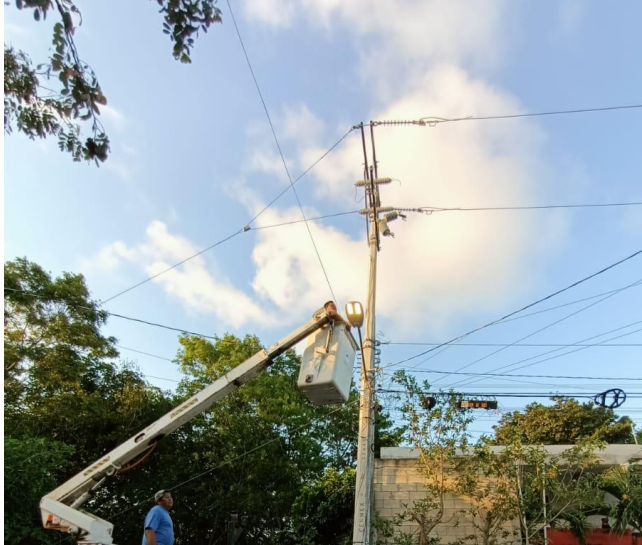
REHABILITACIÓN DE FOTOCELDA, COL. EJIDO, CALLE COCODRILO ENTRE AV. SIAN KAN Y AV. LA SELVA.
