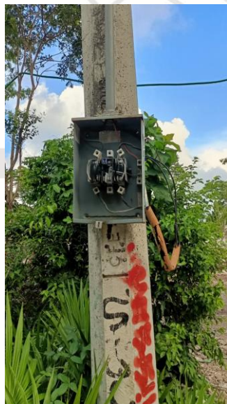
REHABILITACIÓN EN BANCO DE CONTROL, COL. EJIDO NTE, CALLE CHAN-CHEN ENTRE CALLE CANCUN Y ZAZIL-HA.
