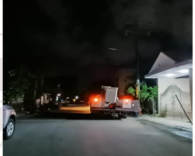
REHABILITACIÓN DE LÍNEAS DE ALUMBRADO PÚBLICO, FRACCIONAMIENTO VILLAS, CALLE 17 Y 2 BIS OTE.
