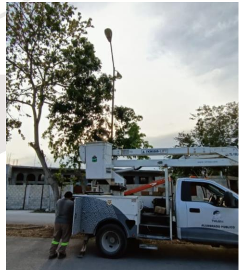
CAMBIO DE LUMINARIAS, COL. TUMBEN KAA, CALLE 28 ENTRE CALLE 25 Y 23.
