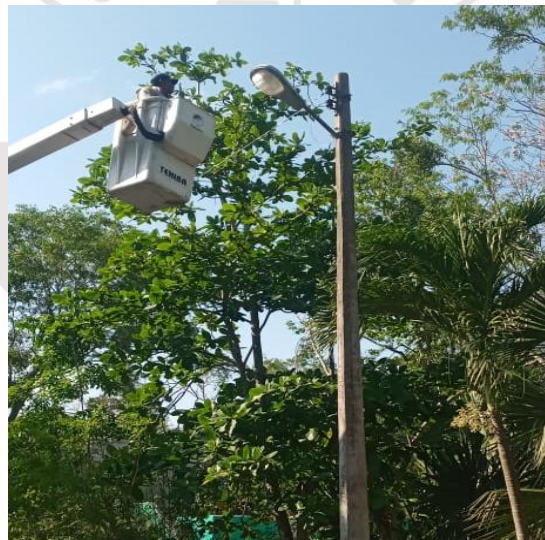
REHABILITACIÓN DE LUMINARIA, POBLADO DE MACARIO GOMEZ.
