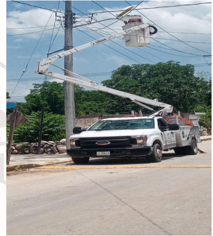
REHABILITACIÓN DE LUMINARIA, POBLADO DE CHAN CHEN 1.
