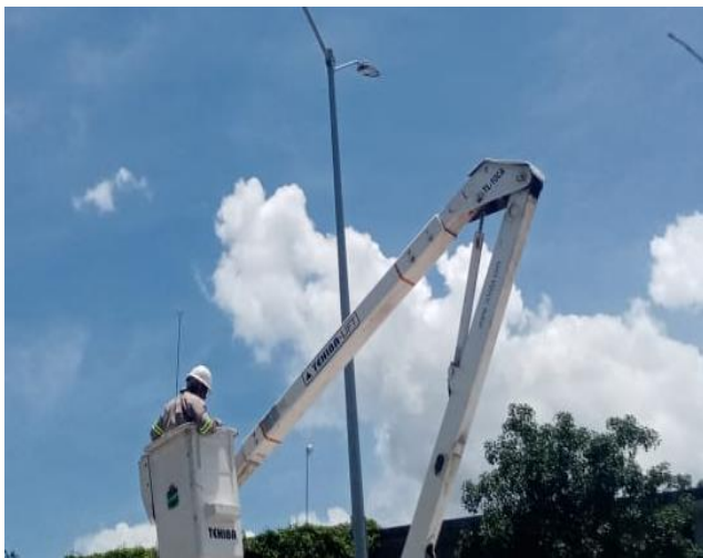
REHABILITACIÓN DE LÍNEAS DE ALUMBRADO PÚBLICO, COL. CRISTAL.
