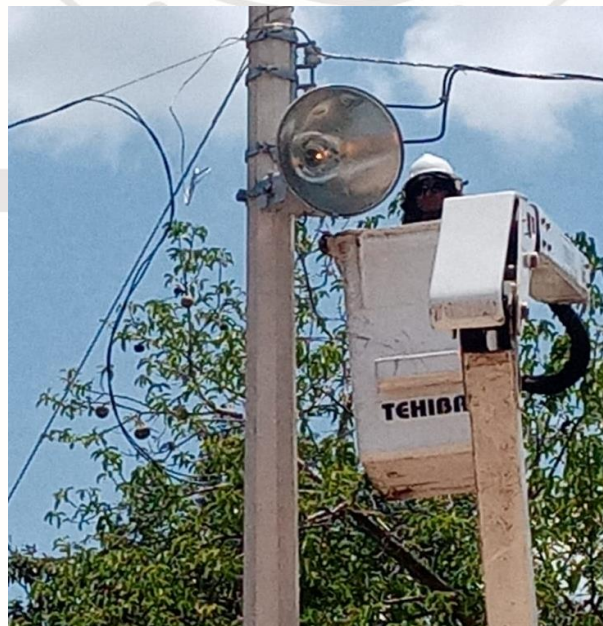
REHABILITACIÓN DE REFLECTOR, POBLADO DE CHANCHEN PALMAR.
