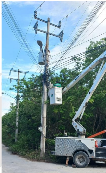
REHABILITACIÓN EN BANCO DE CONTROL, COL. TUMBEN KAA, CALLE XEL-HA Y CALLE 8.
