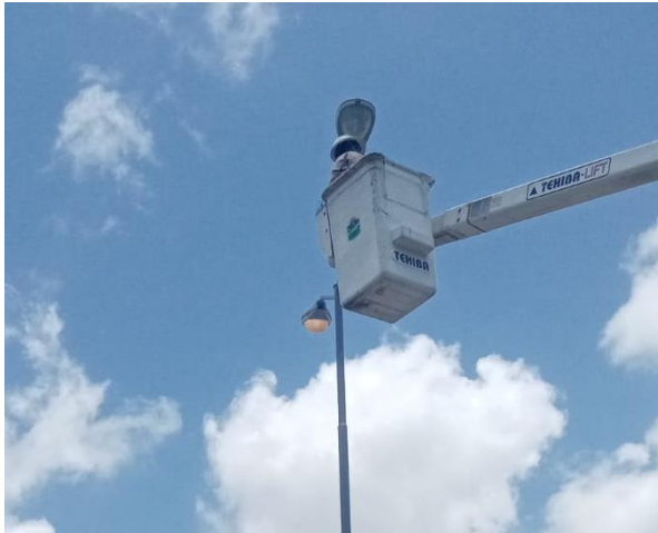
REHABILITACIÓN DE LUMINARIA, COL. TUMBEN KAA, AV. 28 ENTRE CALLE 17 Y TEPESCUILTE. (4)
