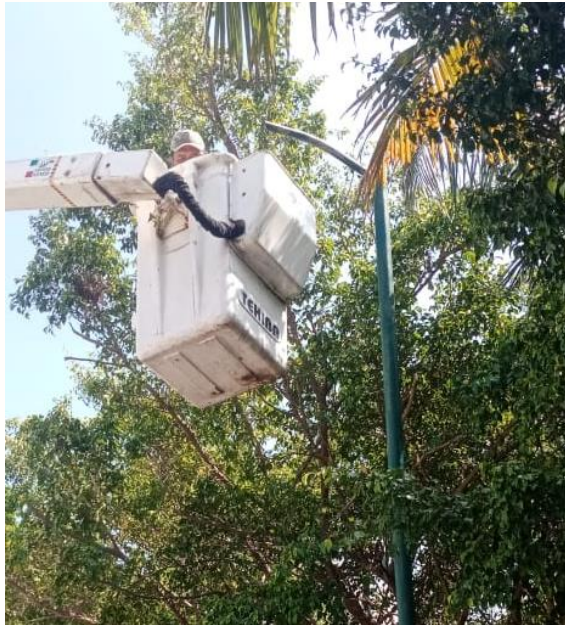
REHABILITACIÓN DE LUMINARIA, COL. CENTRO, CALLE JUPITER Y CALLE 2 OTE.
