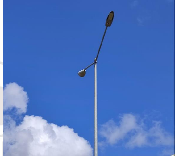
CAMBIO DE LUMINARIAS, COL. TUMBEN KAA, AV. 28 ENTRE CALLE 27 HASTA LA CALLE 25.
