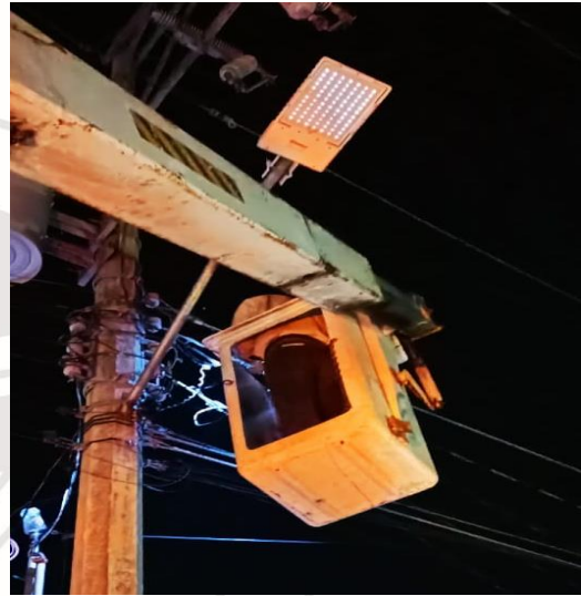
REHABILITACIÓN DE LUMINARIA, POBLADO DE MANUEL ANTONIO AY.
