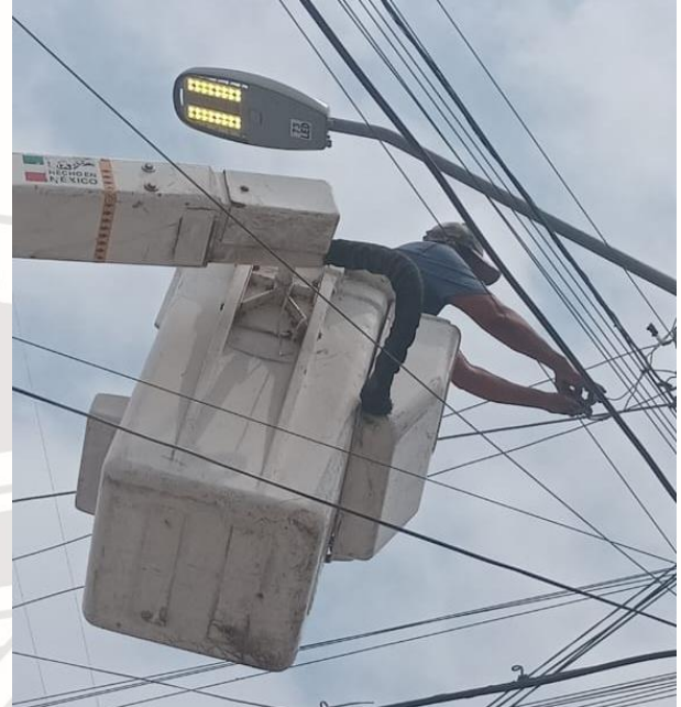
REHABILITACIÓN DE LÍNEAS DE ALUMBRADO PÚBLICO, COL. CENTRO, CALLE SAGITARIO ENTRE CALLE ALFA NTE Y JUPITER.
