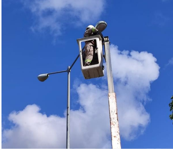
CAMBIO DE LUMINARIAS, COL. LA VELETA, AV. 5.
