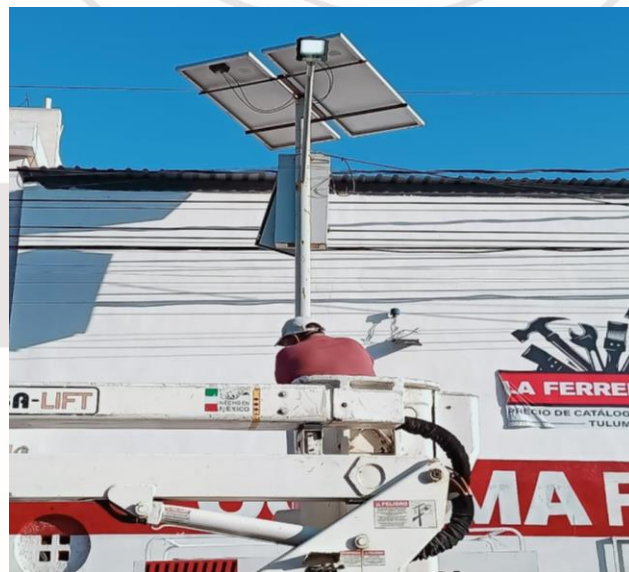
REHABILITACIÓN DE FOTOCELDA, COL. CENTRO, CALLE MERCURIO OTE ENTRE CALLE KUKULCAN Y SATURNO PTE.
