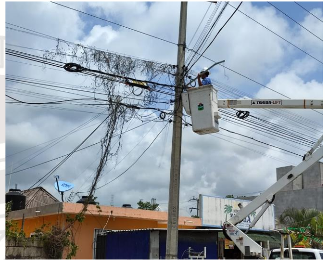
REHABILITACIÓN DE LUMINARIA, COL. YA'AX TULUM, CALLE LIRIO Y BUGAMBILIA.
