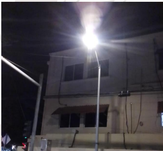
REHABILITACIÓN DE REFLECTOR, FRACCIONAMIENTO HURACANES, EN LA CANCHA DE USOS MÚLTIPLES.
