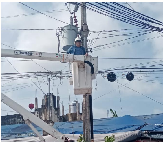
REHABILITACIÓN DE REFLECTOR, COL. CENTRO, EN LA CANCHA DE FUTBOL RAPIDO DE LA UNIDAD DEPORTIVA
