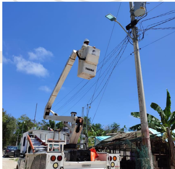
REHABILITACIÓN DE LUMINARIA, POBLADO DE AKUMAL, COL. TORTUGA.
