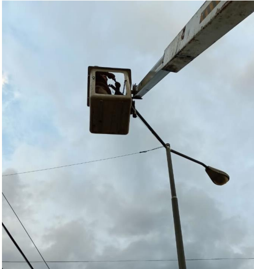
CAMBIO DE LUMINARIAS, COL. YA'AX TULUM, CALLE AZUCENA ENTRE CALLE BUGAMBILIAS Y ALCATRAZ.
