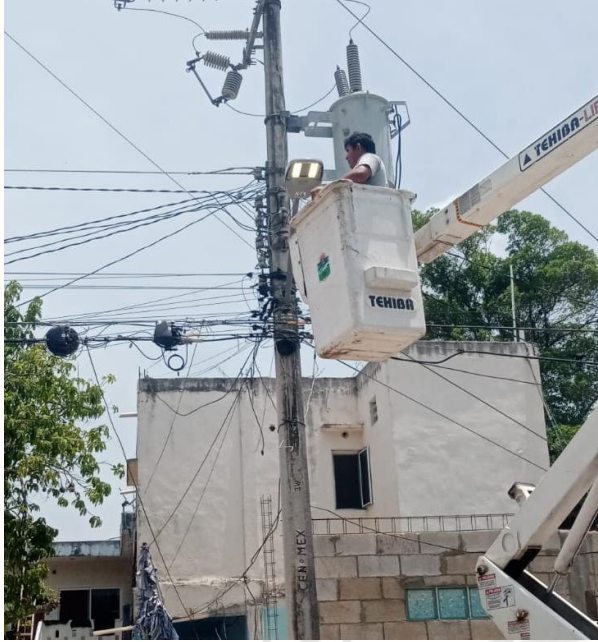
REHABILITACIÓN DE LÍNEAS DE ALUMBRADO PÚBLICO, COL. CENTRO, CALLE OSIRIS Y ALFA SUR.
