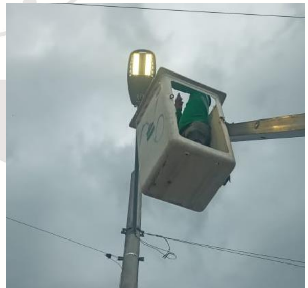
REHABILITACIÓN DE FOTOCELDA, COL. CENTRO, CALLE POLAR PTE ENTRE CALLE ACUARIO NTE Y JUPITER NTE.
