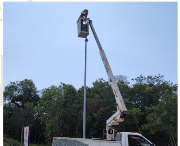
CAMBIO DE LUMINARIAS, COL. TUMBEN KAA, AV. 1 ENTRE CALLE 12 Y AV. 18.
