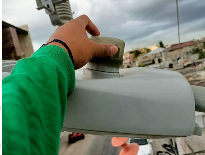
REHABILITACIÓN DE FOTOCELDA, COL. CENTRO, CALLE POLAR PTE ESQUINA CON CALLE CENTAURO.
