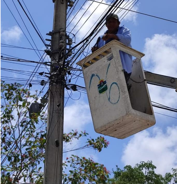
REHABILITACIÓN DE LÍNEAS DE ALUMBRADO PÚBLICO, COL. EJIDO, CALLE TAURO ENTRE CALLE CHUNYAXCHE Y CHAN-CHEN.
