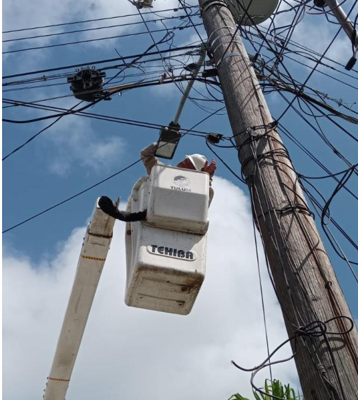
REHABILITACIÓN DE FOTOCELDA, COL. EJIDO, CALLE CHUN-YAXCHE.
