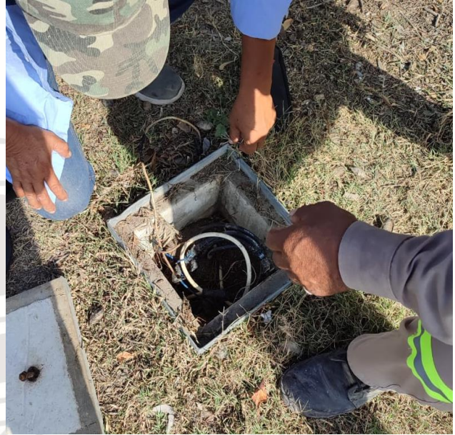
REHABILITACIÓN DE LÍNEAS DE ALUMBRADO PÚBLICO, COL. CENTRO, AV. SATELITE ESQUINA CON CALLE SOL.
