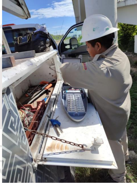
CAMBIO DE LUMINARIAS, POBLADO DE AKUMAL.
