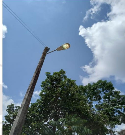
CAMBIO DE LUMINARIAS, COL. TUMBEN KAA, AV. 28 ENTRE CALLE 19 Y 17.
