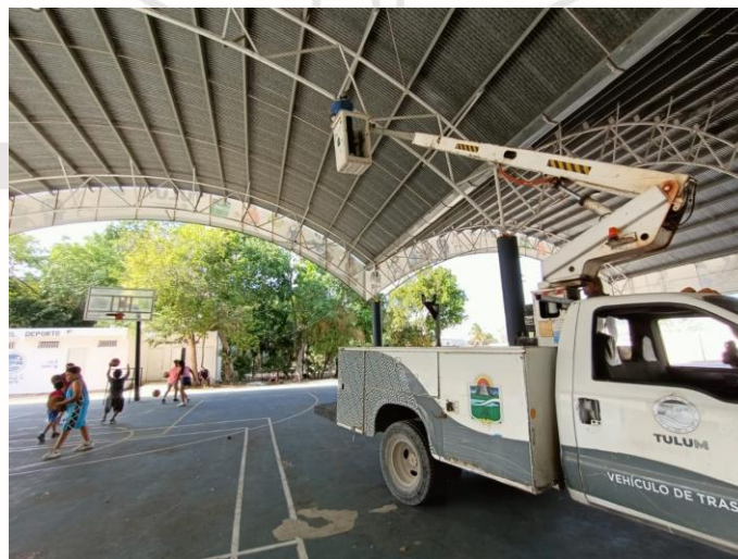
CAMBIO DE LUMINARIAS, DOMO DOBLE DE LA UNIDAD DEPORTIVA.
