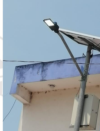
REHABILITACIÓN DE LÍNEAS DE ALUMBRADO PÚBLICO, COL. CENTRO, AV. OSIRIS NTE ENTRE CALLE POLAR Y AV. TULUM.
