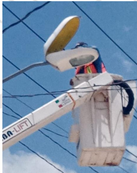
REHABILITACIÓN DE LÍNEAS DE ALUMBRADO PÚBLICO, COL. TUMBEN KAA, AV. 1 ENTRE CALLE 12 Y AV. 2.
