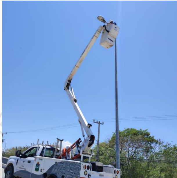
CAMBIO DE LUMINARIAS, POBLADO DE AKUMAL.
