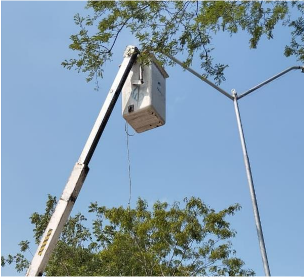
REHABILITACIÓN DE REFLECTOR, COL. CENTRO, DOMO DOBLE DE LA UNIDAD DEPORTIVA.
