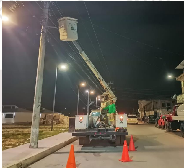
REHABILITACIÓN DE LÍNEAS DE ALUMBRADO PÚBLICO, COL. CENTRO, CALLE ALFA SUR ENTRE CALLE GAMA OTE Y MERCURIO.
