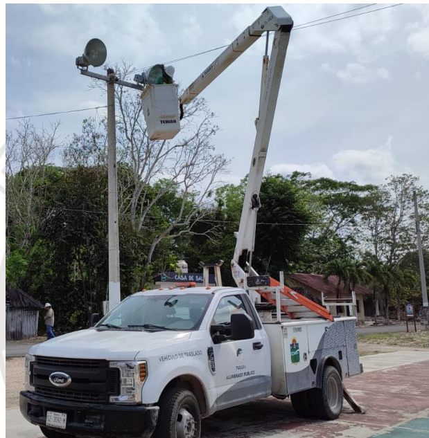
REHABILITACIÓN DE LUMINARIA, POBLADO DE YAAX CHE.
