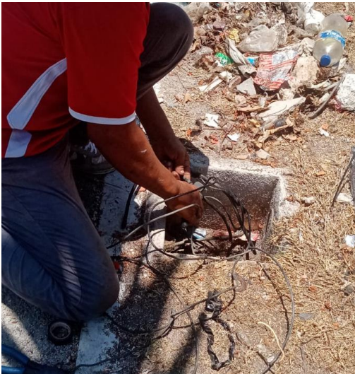
REHABILITACIÓN DE LUMINARIA, COL. TUMBEN KAA, CALLE TEPESCUTLE ENTRE AV. 1 Y CALLE YOTDZONOT.
