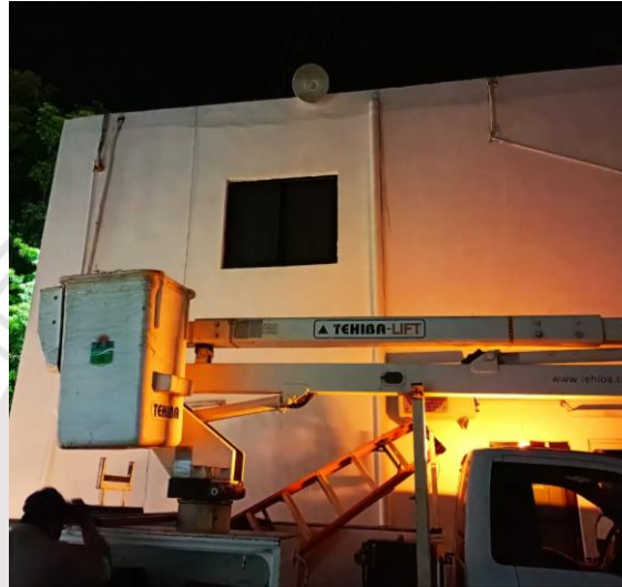
REHABILITACIÓN DE REFLECTOR, COL. CENTRO, CALLE ALFA SUR ENTRE AV. TULUM Y SOL OTE.
