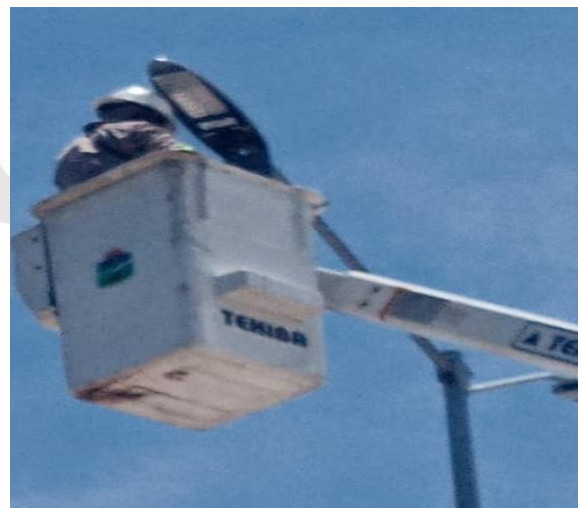
REHABILITACIÓN DE LÍNEAS DE ALUMBRADO PÚBLICO, COL. CRISTAL.
