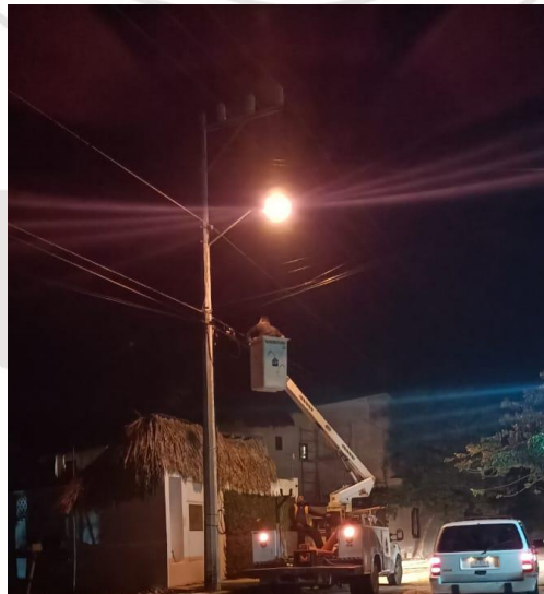
REHABILITACIÓN DE LÍNEAS DE ALUMBRADO PÚBLICO, COL. CENTRO, AV. OSIRIS ENTRE AV. TULUM Y CALLESOL EN EL PARQUE MUSEO DE LA CULTURA
