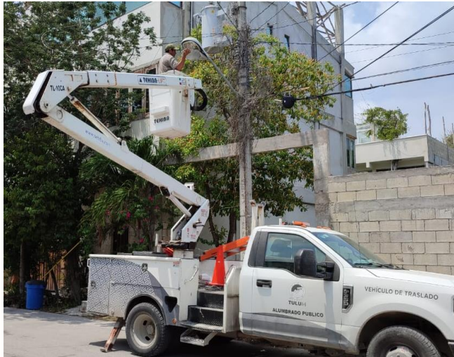
REHABILITACIÓN DE FOTOCELDA, COL. EJIDO, CALLE COCODRILO ENTRE CALLE CHUN- YAXCHE Y CHAN-CHEN.
