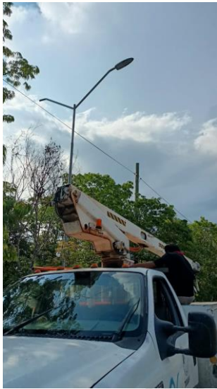
REHABILITACIÓN DE LUMINARIA, POBLADO DE MANUEL ANTONIO AY.
