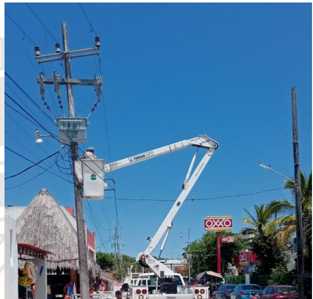
REHABILITACIÓN DE LÍNEAS DE ALUMBRADO PÚBLICO, COL. CRISTAL.
