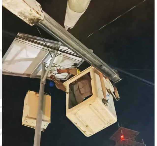
REHABILITACIÓN DE LÍNEAS DE ALUMBRADO PÚBLICO, COL. CENTRO, CALLE ALFA SUR ENTRE CALLE SOL OTE Y VENUS OTE.
