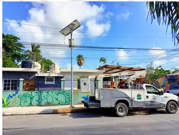
CAMBIO DE LUMINARIAS, COL. CENTRO, CALLE SOL OTE ENTRE BETA SUR Y OSIRIS SUR.
