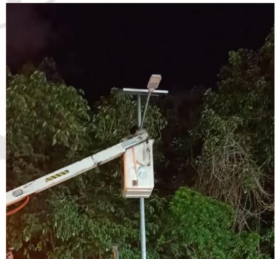
REHABILITACIÓN DE LÍNEAS DE ALUMBRADO PÚBLICO, FRACCIONAMIENTO PALMAS, CALLE PALMA ABANICO Y BULEVAR PALMAS TULUM.
