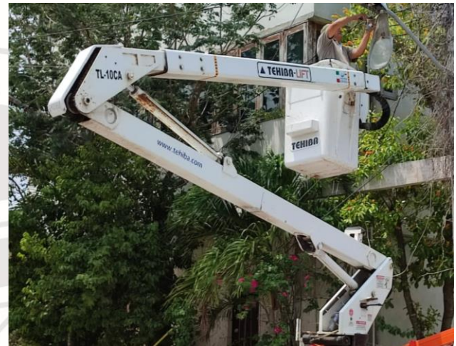
REHABILITACIÓN DE FOTOCELDA, COL. EJIDO, CALLE COCODRILO ENTRE CALLE CHUN- YAXCHE Y CHAN-CHEN.
