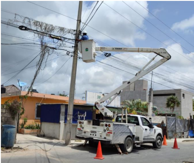
REHABILITACIÓN DE LUMINARIA, COL. CENTRO, AV. KUKULKAN ENTRE CALLE TAURO Y XCARET.
