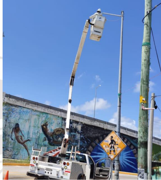
REHABILITACIÓN DE 12 LUMINARIAS, POBLADO DE AKUMAL.
