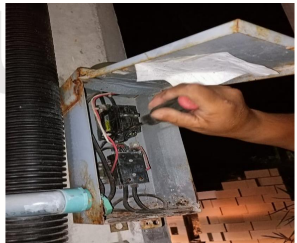
REHABILITACIÓN EN BANCO DE CONTROL, COL. TUMBEN KAA, CALLE MAYA BA 1 AM.
