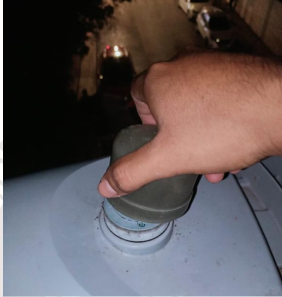
REHABILITACIÓN DE FOTOCELDA, COL. CENTRO SUR, CALLE ALFA SUR ENTRE CALLE SOL OTE Y VENUS OTE.
