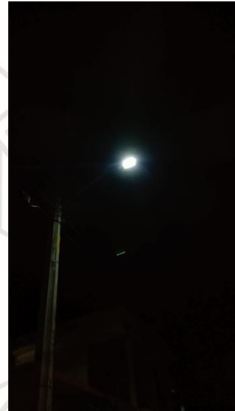
CAMBIO DE LUMINARIAS, COL. TUMBEN KAA, CALLE TEPESCUILTE ENTRE CALLE 12 Y AV. 2.
