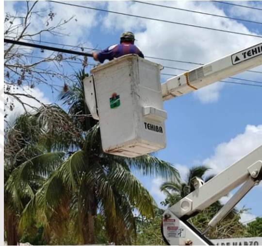
REHABILITACIÓN DE LÍNEAS DE ALUMBRADO PÚBLICO, POBLADO DE COBA.
