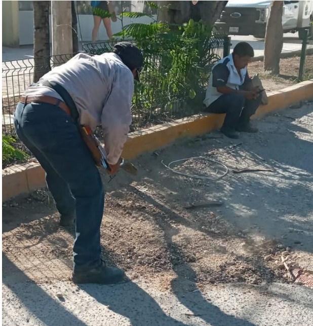
REHABILITACIÓN DE LÍNEAS DE ALUMBRADO PÚBLICO, ZONA ARQUEOLOGICA.
