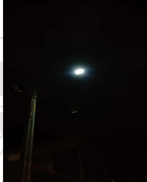
CAMBIO DE LUMINARIAS, COL. TUMBEN KAA, AV. 1 ENTRE RIO CINTALAPA Y RIO ROSARIO. (4)
