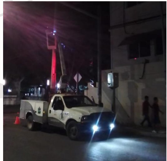
REHABILITACIÓN DE LUMINARIA, COL. TUMBEN KAA, CALLE TEPESCUTLE ENTRE AV. 1 Y CALLE YOTDZONOT.
