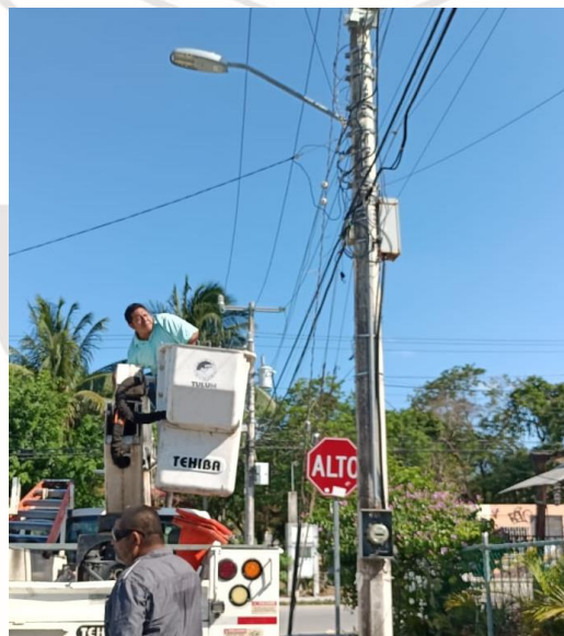
REHABILITACIÓN DE LÍNEAS DE ALUMBRADO PÚBLICO, COL. CENTRO, CALLE OSIRIS ENTRE AV. TULUM Y CALLE SOL.
