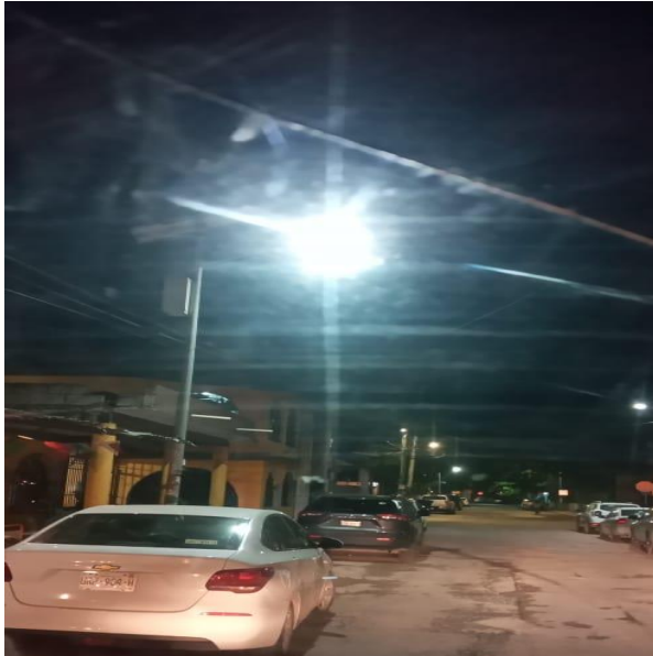
REHABILITACIÓN DE LÍNEAS DE ALUMBRADO PÚBLICO, COL. LA VELETA
