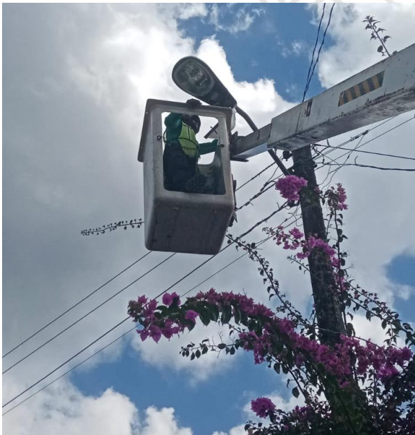
REHABILITACIÓN DE FOTOCELDA, SABCAB MUCUY
