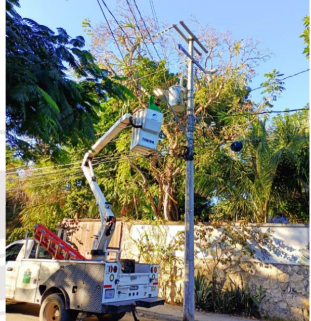
REHABILITACIÓN EN BANCO DE CONTROL, COL CENTRO
