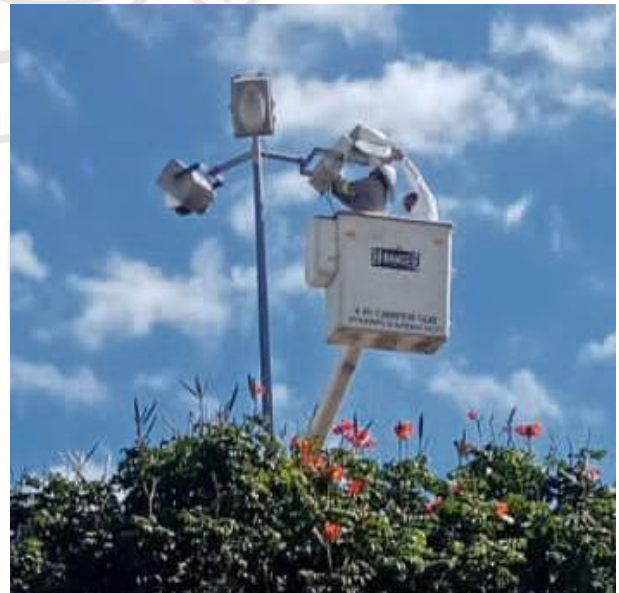
REHABILITACIÓN DE LUMINARIA, COL. CENTRO, CALLE NEPTUNO/ OSIRIS Y ALFA
