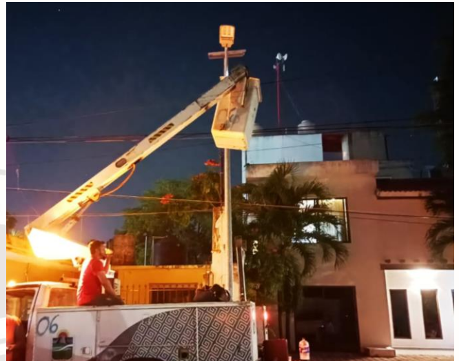
CAMBIO DE LUMINARIAS, COL. CENTRO
