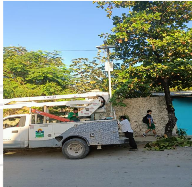
REHABILITACIÓN DE LUMINARIA, QUE SE ENCONTRABA FUERA DE SERVICIO, COL. CENTRO, CALLE OSIRIS NTE / SAGITARIO OTE
