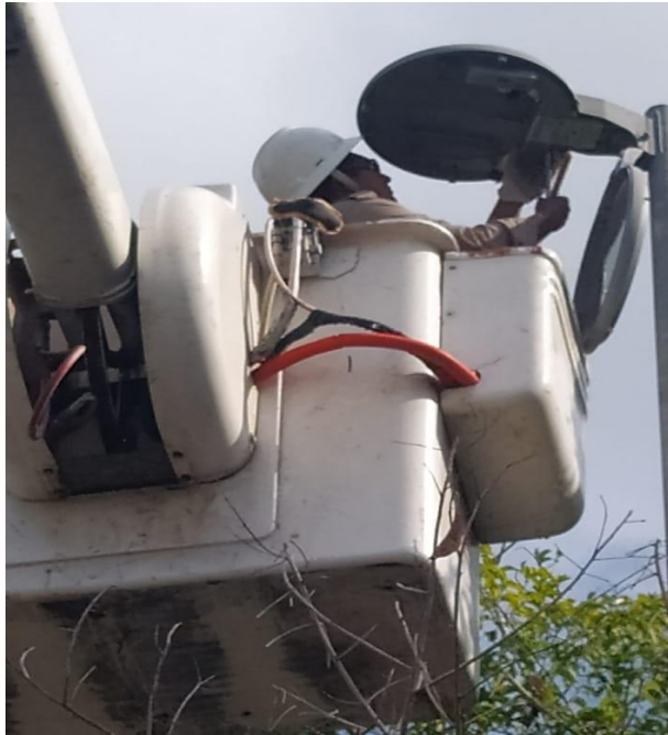
REHABILITACIÓN DE LUMINARIA, FRACCIONAMIENTO ALDEA ZAMA EN LA AVENIDA PRINCIPAL
