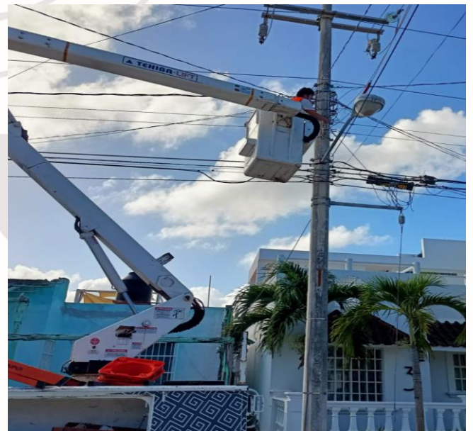
REHABILITACIÓN DE LÍNEAS DE ALUMBRADO PÚBLICO, CHAN CHEMUYIL
