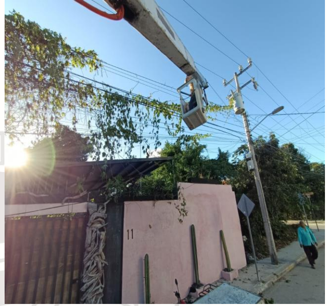
RECONEXIÓN DE LINEA ÁEREA, QUE SE ENCONTRABA SULFATADA, COL. CENTRO, CALLE JUPITER / CALLE 4
