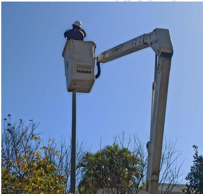
REHABILITACIÓN DE LUMINARIA, ALDEA ZAMA
