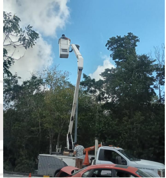
REHABILITACIÓN DE LÍNEAS DE ALUMBRADO PÚBLICO, FRACCIONAMIENTO VILLAS TULUM
