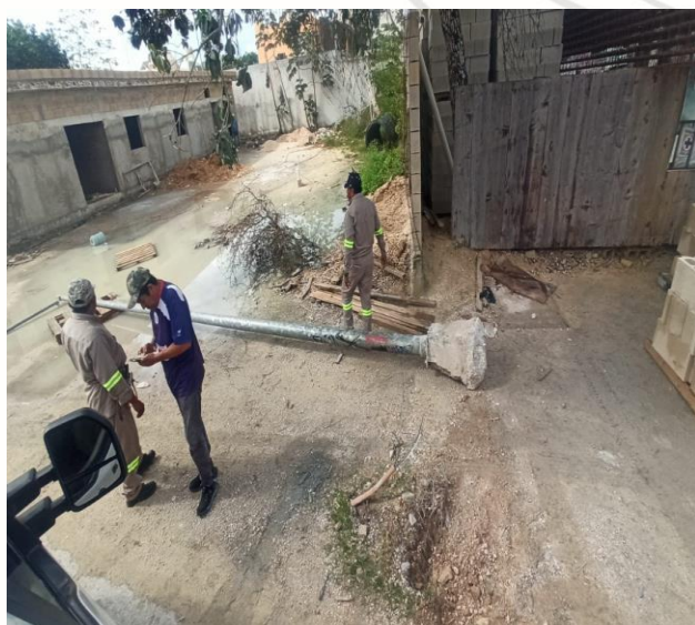
RETIRO DE POSTE DE ALUMBRADO, QUE SE ENCONTRABA CHOCADO, COL. XULKA, 5 AV / CALLE BIS NTE
