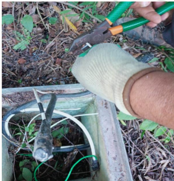
REHABILITACIÓN DE LÍNEAS DE ALUMBRADO PÚBLICO, COL. EJIDO
