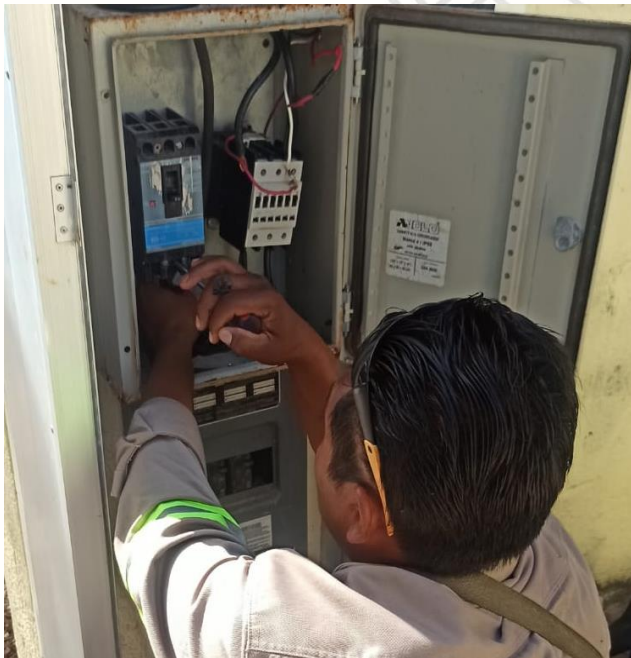
CAMBIO DE CONTACTOR QUEMADO, RUINAS, CARRETERA TULUM- PLAYA DEL CARMEN
