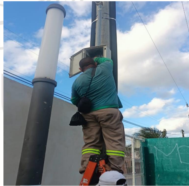
REHABILITACIÓN DE LÍNEAS DE ALUMBRADO PÚBLICO, UNIDAD DEPORTIVA
