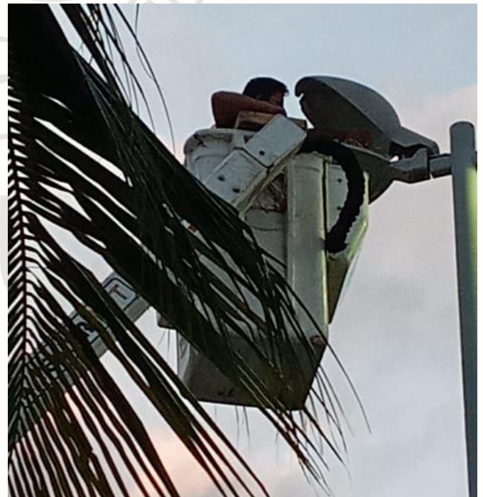
REHABILITACIÓN DE LUMINARIA, LA VELETA
