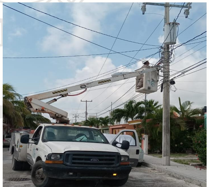
REHABILITACIÓN DE LUMINARIA, AKUMAL
