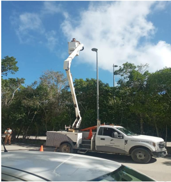
REHABILITACIÓN DE LÍNEAS DE ALUMBRADO PÚBLICO, FRACCIONAMIENTO LAS PALMAS
