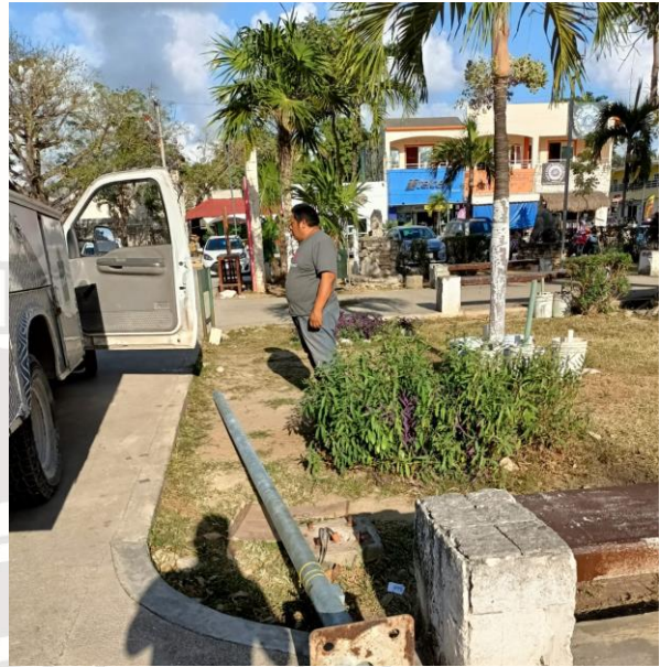
CAMBIO DE POSTES, COL. CENTRO
