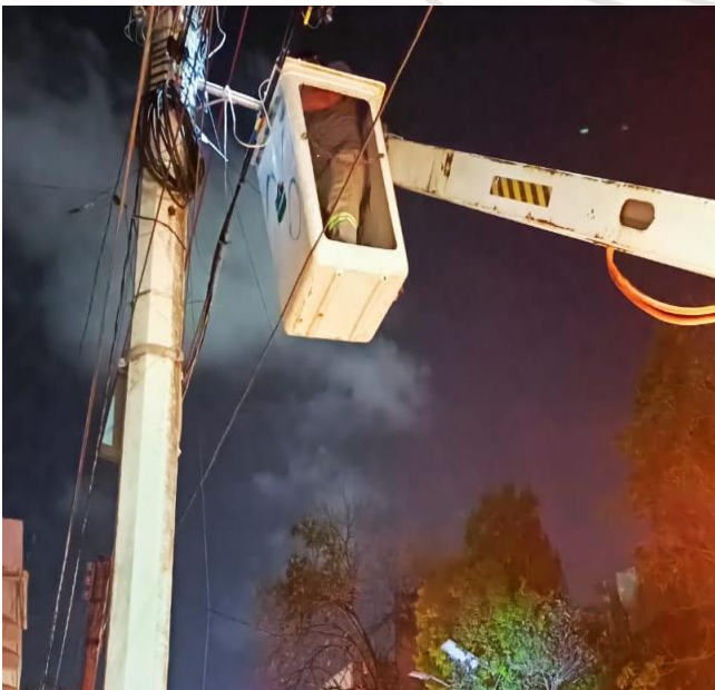
CAMBIO DE LUMINARIAS, COL. CENTRO
