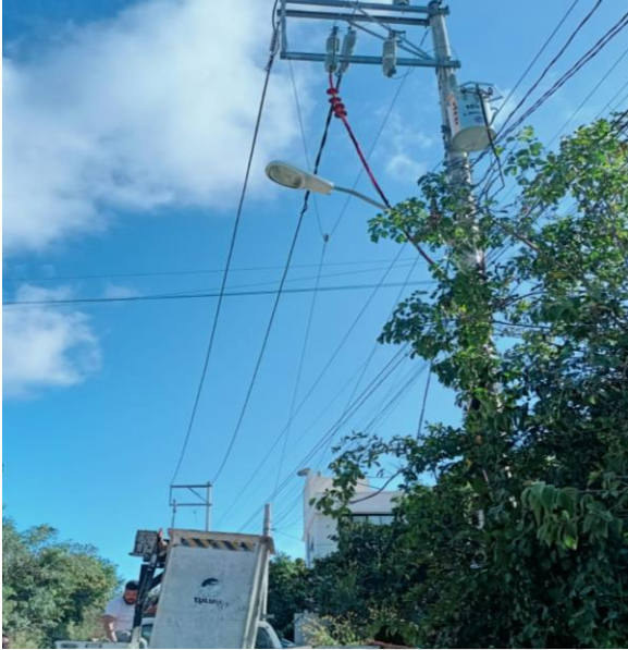
REHABILITACIÓN DE LUMINARIA, YA'AX TULUM
