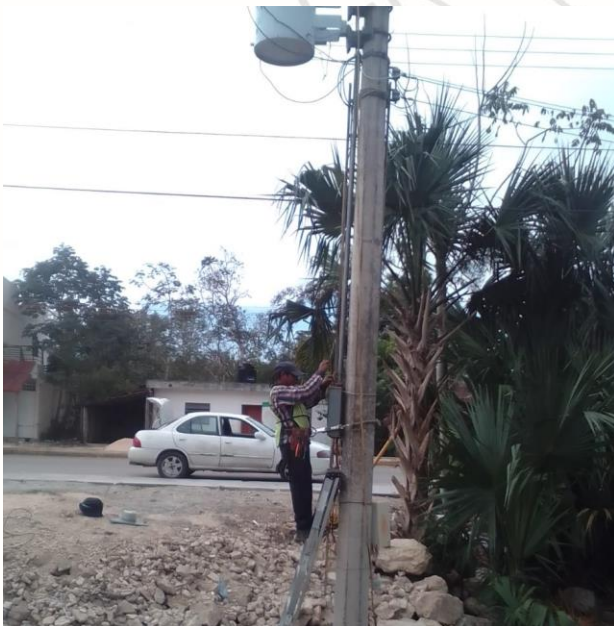
REHABILITACIÓN EN BANCO DE CONTROL, MACARIO GOMEZ
