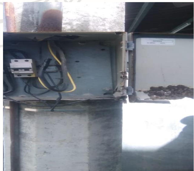
REHABILITACIÓN DE CONTACTOR, COL. MAYA PAX, CALLE TUNKUL / OMEGA NTE Y ALFA
