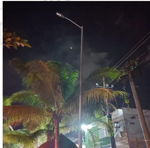
REHABILITACIÓN DE LUMINARIA, COL. CROC, AV. COBA SUR/ MERCURIO OTE Y SOL OTE.
