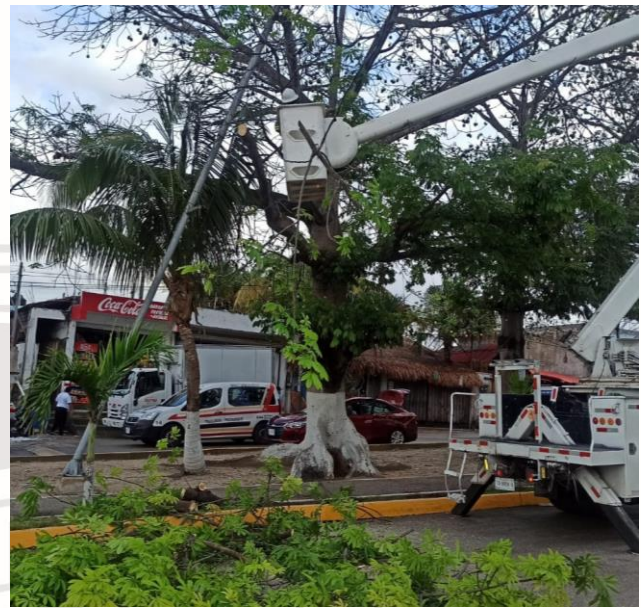
CAMBIO DE POSTE DAÑADO, AKUMAL POBLADO, AV. GONZALO GUERRERO.
