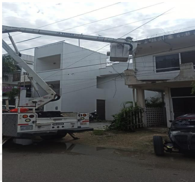
RECONEXIÓN DE LINEA ÁREA, QUE SE ENCONTRABA CON CORTO CIRCUITO, COL. MAYA PAX, CALLE ORION / CALLE LE'XIU
