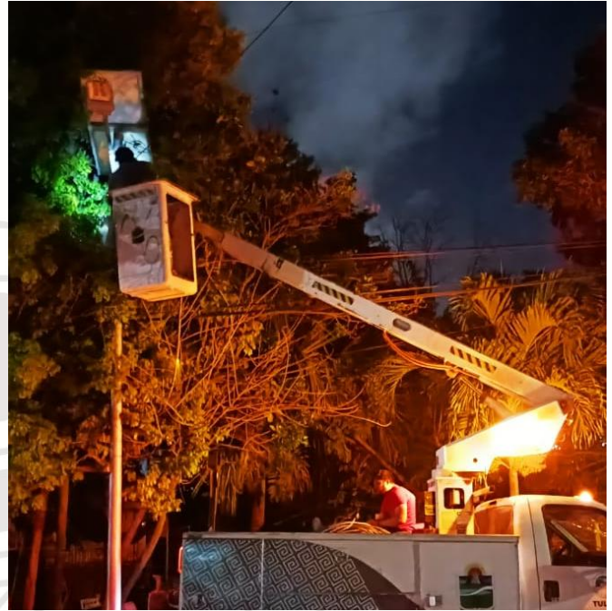
CAMBIO DE LUMINARIAS, COL. CENTRO
