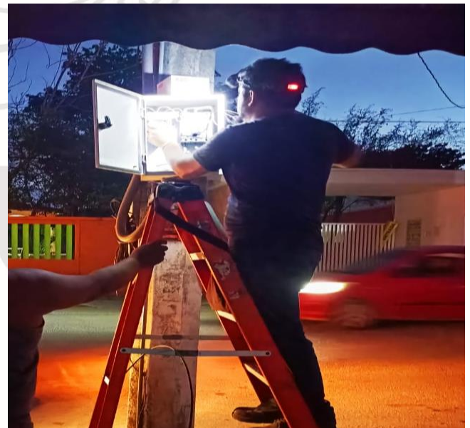
REHABILITACIÓN EN BANCO DE CONTROL, COL. EJIDO
