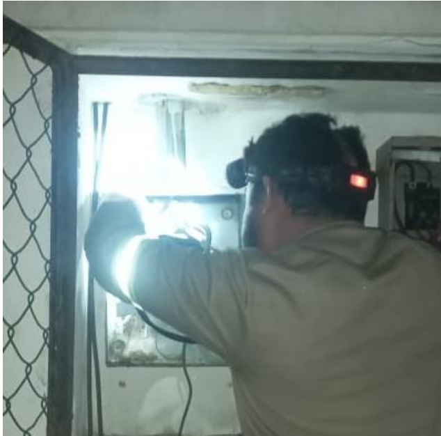
CAMBIO DE BASE DE MEDIDOR DAÑADO, PARQUE DE MACARIO GOMEZ
