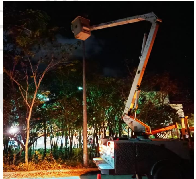
REHABILITACIÓN DE REFLECTOR, UNIDAD DEPORTIVA
