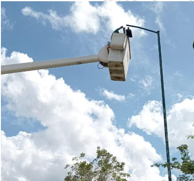
REHABILITACIÓN DE LUMINARIA, SAN JUAN
