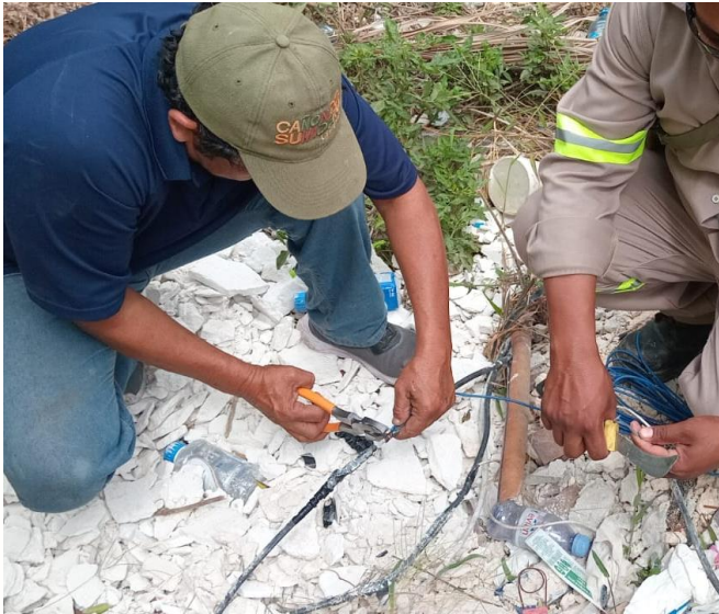
REHABILITACIÓN DE LÍNEAS DE ALUMBRADO PÚBLICO, FRACCIONAMIENTO XUL KAA
