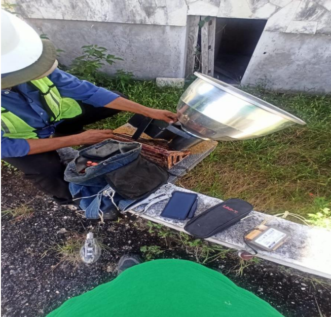
REHABILITACIÓN DE REFLECTOR, QUE SE ENCONTRABA FUERA DE SERVICIO, COBA
