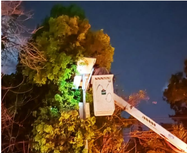
CAMBIO DE LUMINARIAS, COL. CENTRO
