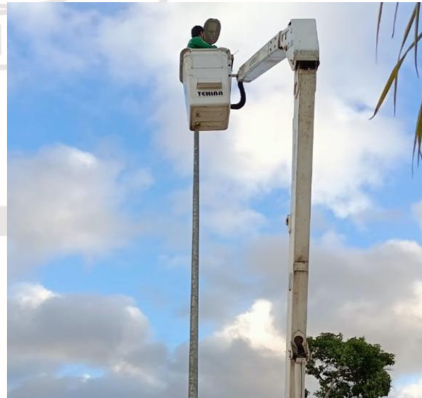
REHABILITACIÓN DE LUMINARIA, COL. YA'AX TULUM, CALLE BUGAMBILIA/ MARGARITA Y AZUCENA
