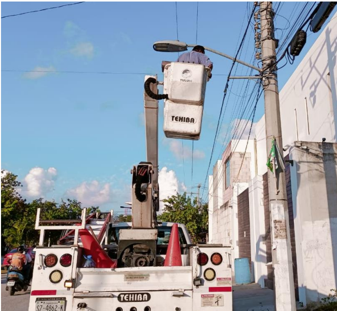
REHABILITACIÓN DE LUMINARIA, COL. TUMBEN KAA, AV. LA SELVA/ CALLE FAISAN Y AV. 5.
