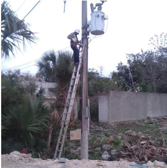
REHABILITACIÓN EN BANCO DE CONTROL, MANUEL ANTONIO AY
