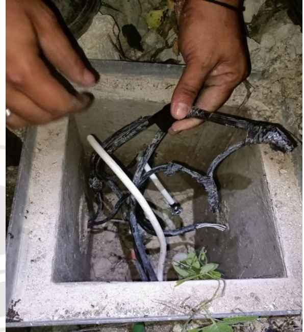
REHABILITACIÓN DE LÍNEAS DE ALUMBRADO PÚBLICO, FRACCIONAMIENTO YA'AX TULUM, CALLE ALCATRAS / MARGARITA Y AV 20
