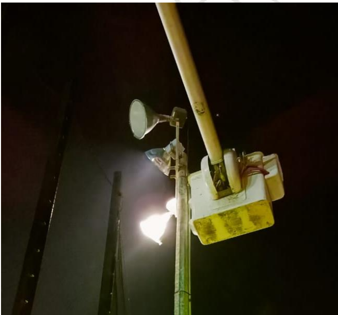
REHABILITACIÓN DE LUMINARIA, UNIDAD DEPORTIVA
