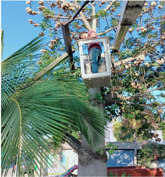
REHABILITACIÓN DE LÍNEAS DE ALUMBRADO PÚBLICO, COL. TUMBEN KAA
