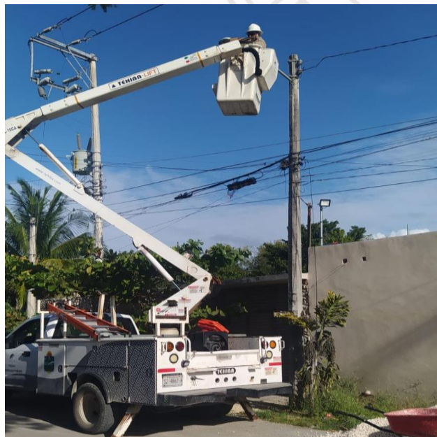
REHABILITACIÓN DE LUMINARIA, COL. EJIDO, CALLE TIGRE/AV.SIAN KAN Y AV. LA SELVA.
