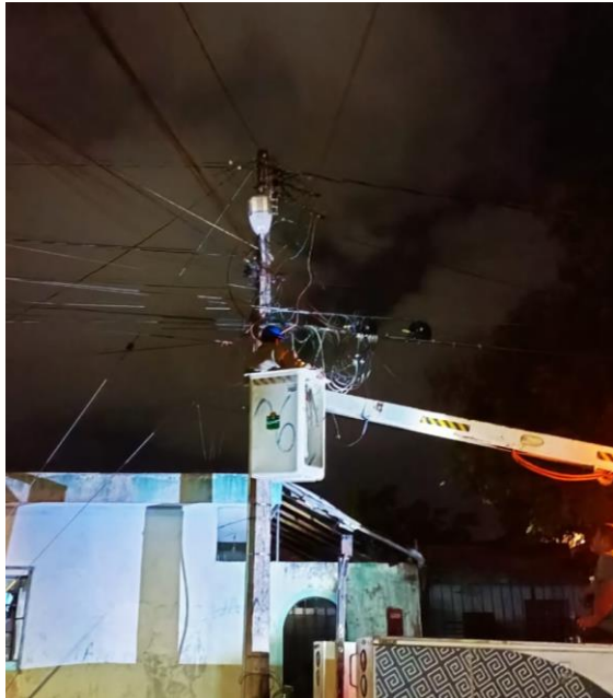
REHABILITACIÓN DE LUMINARIA, COL. TUMBEN KAA
