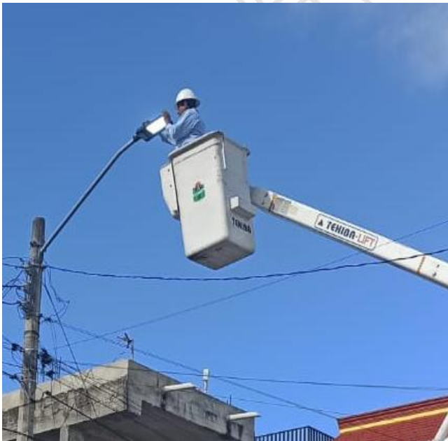
CAMBIO DE FOTOCELDA DAÑADA, AKUMAL
