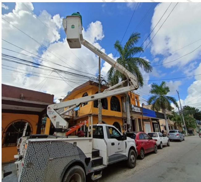
REHABILITACIÓN DE LUMINARIA, QUE SE ENCONTRABA FUERA DE SERVICIO, COL. CENTRO, CALLE OSIRIS NTE / AV TULUM
