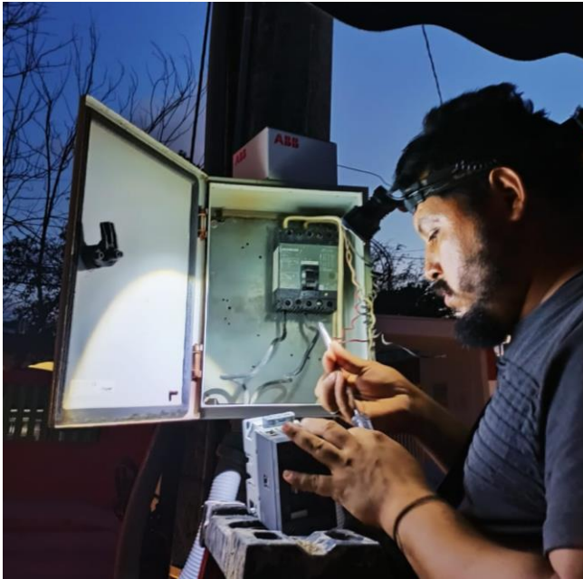
REHABILITACIÓN EN BANCO DE CONTROL, COL. EJIDO
