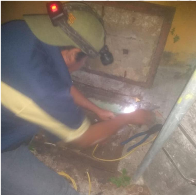
REHABILITACIÓN DE LÍNEAS DE ALUMBRADO PÚBLICO, FRACCIONAMIENTO VILLAS TULUM
