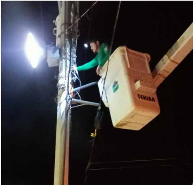
REHABILITACIÓN DE LÍNEAS DE ALUMBRADO PÚBLICO, RECONEXIÓN DE LÍNEAS AÉREAS SULFATADAS, COL. EJIDO, CALLE KUKULCAN/ VENADO Y TEJÓN
