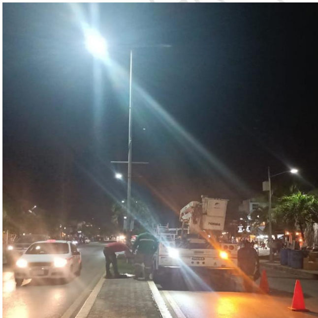
REHABILITACIÓN DE LUMINARIA, COL. CENTRO, AV. TULUM DE LA PALENQUE HASTA BOXITO
