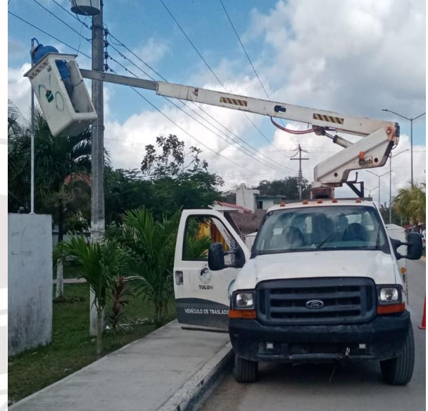
REHABILITACIÓN DE LÍNEAS DE ALUMBRADO PÚBLICO, MACARIO GOMEZ
