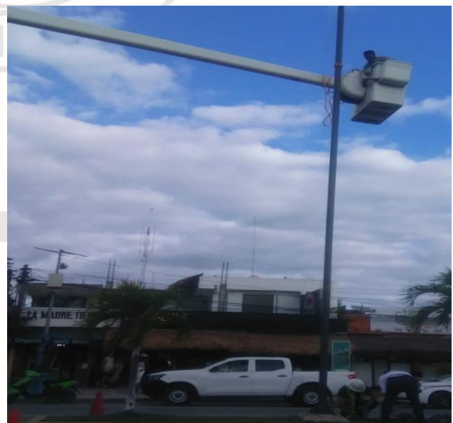
CAMBIO DE POSTE DE METAL, COL.CENTRO, AV TULUM / CENTAURO
