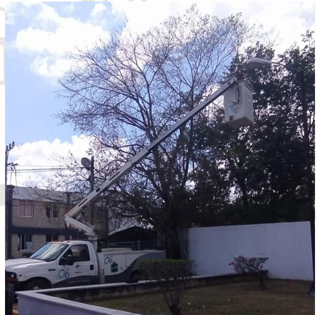
REHABILITACIÓN DE LUMINARIA, COL. MAYA PAX, CALLE TUN-K'UL/ BETA Y OSIRIS.
