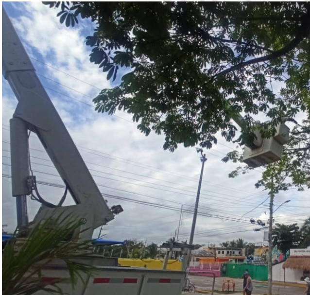
RECONEXIÓN DE LÍNEAS AÉREAS SULFATADAS, AKUMAL POBLADO, AV. GONZALO GUERRERO.
