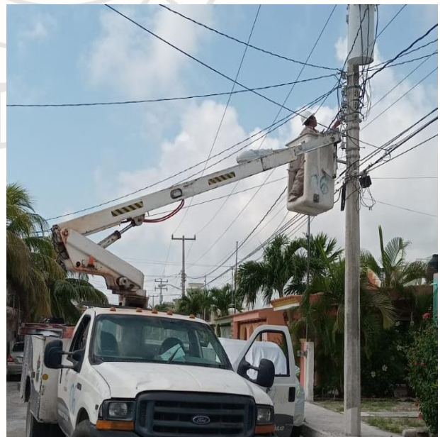
REHABILITACIÓN DE LÍNEAS DE ALUMBRADO PÚBLICO, CHAN CHEMUYIL
