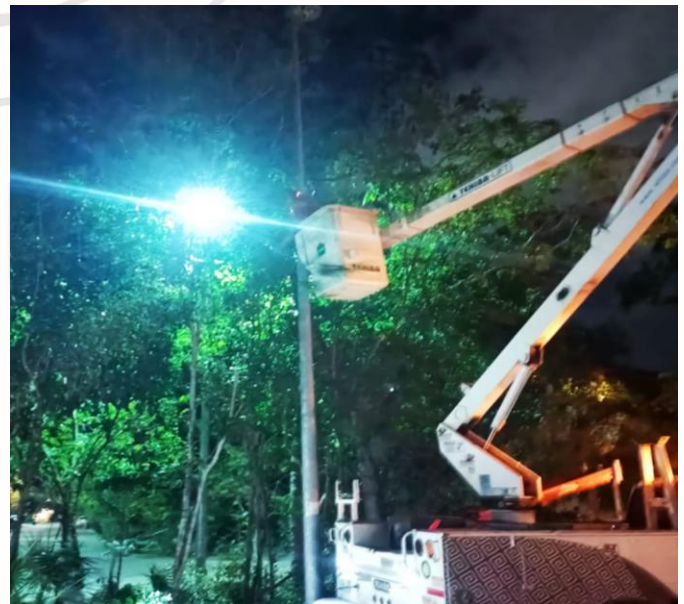
REHABILITACIÓN DE BASE DE FOTOCELDA Y FOTOCELDA, FRACCIONAMIENTO VILLAS TULUM 52
