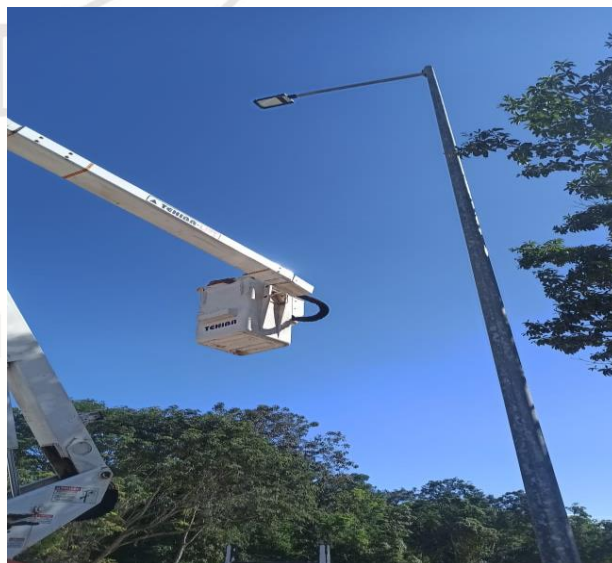
REHABILITACIÓN DE LUMINARIA, QUE SE ENCONTRABA FUERA DE SERVICIO, COL. XULKA, 5 AV / CALLE BIS NTE
