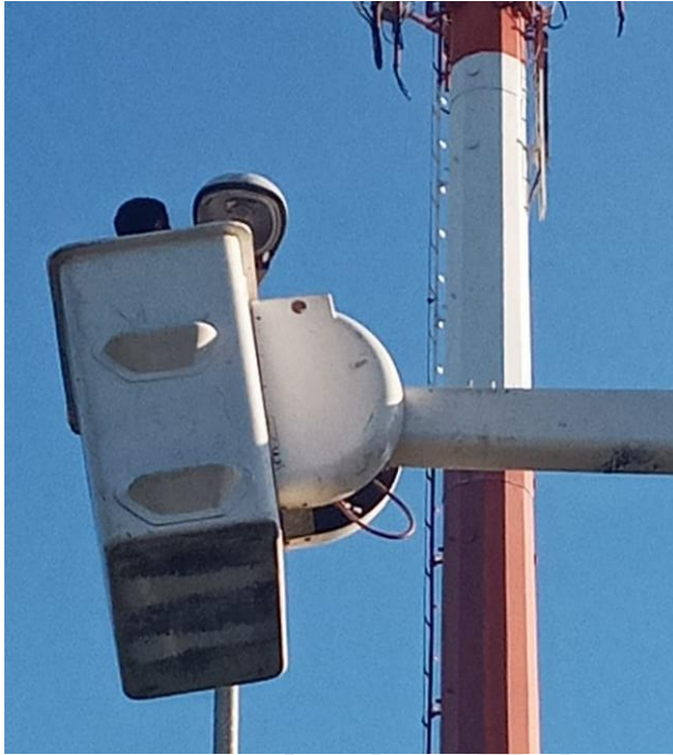
CAMBIO DE BALASTO Y FOCO A LUMINARIA, COL. YA'AX TULUM
