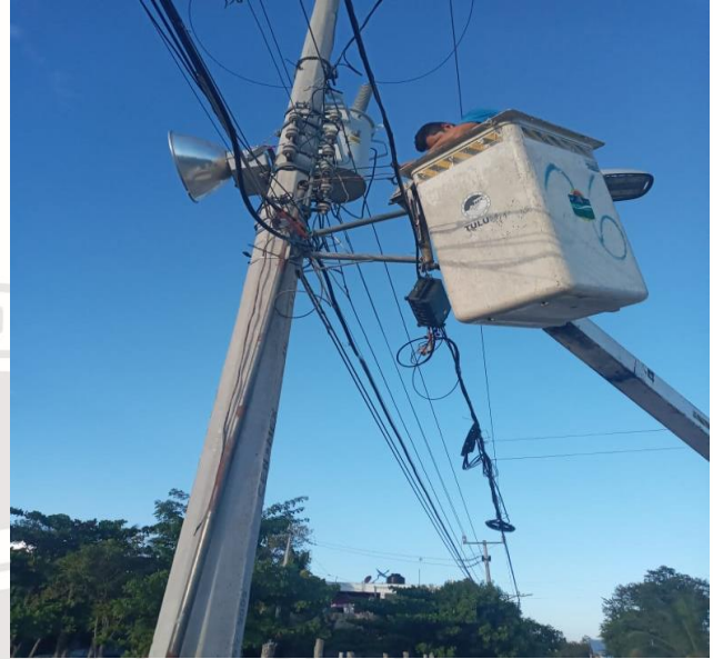
RECONEXIÓN DE LINEA ÁREA, QUE SE ENCONTRABA CON CORTO CIRCUITO, COL. EJIDO, CALLE KUKULKAN / VENADO
