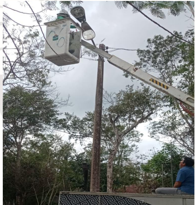
REHABILITACIÓN DE FOTOCELDA, COL. LA VELETA
