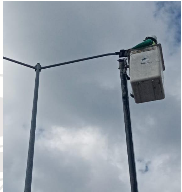
REHABILITACIÓN DE FOTOCELDA, SAN JUAN
