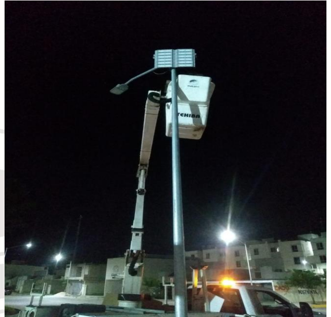
INSTALACIÓN DE REFLECTOR, FRACCIONAMIENTO ALDEA TULUM, CALLE RUBI
