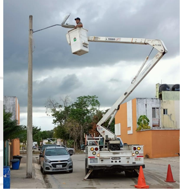
REHABILITACIÓN DE LUMINARIA, FRACCIONAMIENTO LAS PALMAS.
