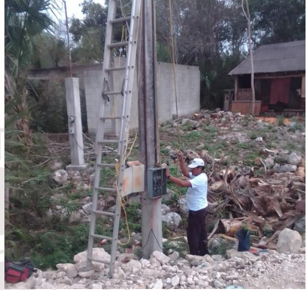
REHABILITACIÓN EN BANCO DE CONTROL, COBA
