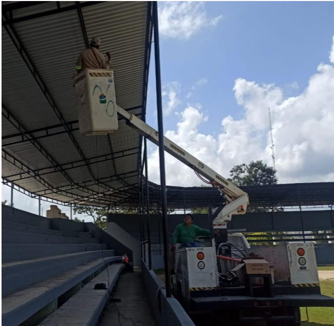
REHABILITACIÓN DE BASE DE FOTOCELDA Y FOTOCELDA, COL. CENTRO EN LA UNIDAD DEPORTIVA
