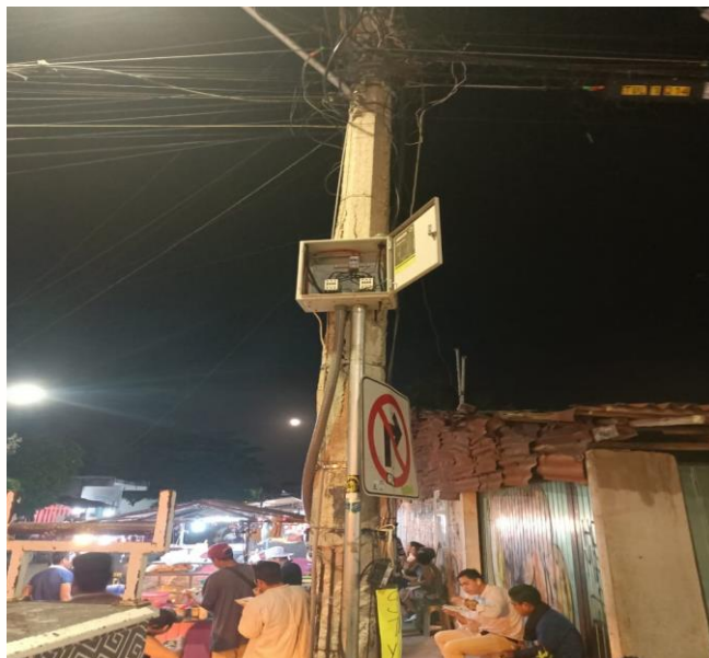
REHABILITACIÓN DE FOTOCELDA, QUE SE ENCONTRABA FUERA DE SERVICIO, COL. CENTRO, CALLE OSIRIS SUR / SOL OTE
