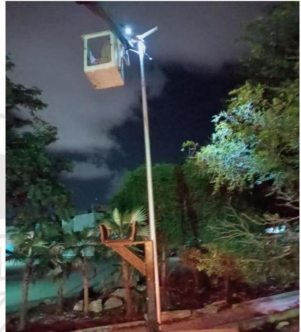
RECONEXIÓN DE LÍNEAS AÉREAS SULFATADAS, FRACCIONAMIENTO PALMAS EN LA CANCHA DE USOS MÚLTIPLES.
