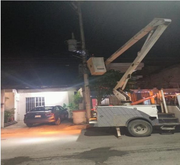
REHABILITACIÓN DE LUMINARIA, QUE SE ENCONTRABA FUERA DE SERVICIO, COL. CENTRO, CALLE 4 OTE / AV SATELITE NTE
