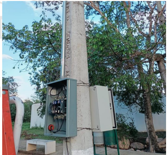
REHABILITACIÓN EN BANCO DE CONTROL, FRACCIONAMIENTO ALDEA ZAMA
