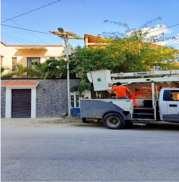
REHABILITACIÓN DE LUMINARIA, QUE SE ENCONTRABA FUERA DE SERVICIO, VELETA, CALLE PALENQUE / 7 OTE
