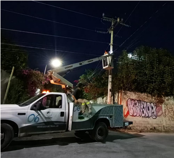
REHABILITACIÓN DE BASE DE FOTOCELDA Y FOTOCELDA, COL. EJIDO
