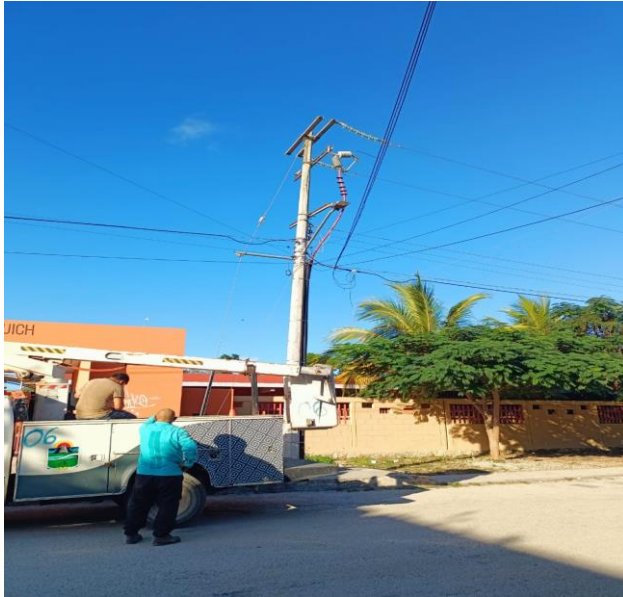
RECONEXIÓN DE LINEA ÁEREA, QUE SE ENCONTRABA SULFATADA, COL. TUMBENKAA, CALLE 23 / AV 28
