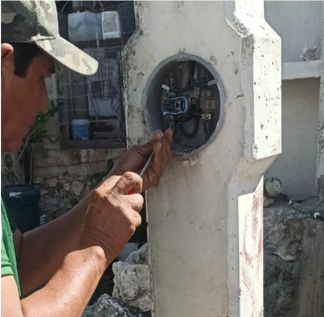
CAMBIO DE BASE DE MEDIDOR DAÑADO, COL. TORTUGAS, AKUMAL PUEBLO
