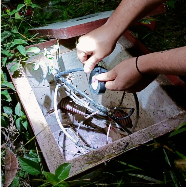
RECONEXIÓN DE LÍNEAS SUBTERRANEAS SULFATADAS, COL. CROC, AV. COBA SUR/ MERCURIO OTE Y SOL OTE.
