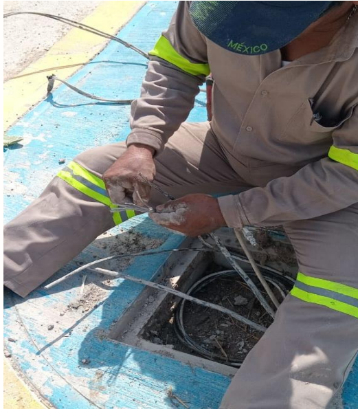
REHABILITACIÓN DE LÍNEAS DE ALUMBRADO PÚBLICO, COL. TUMBEN KAA
