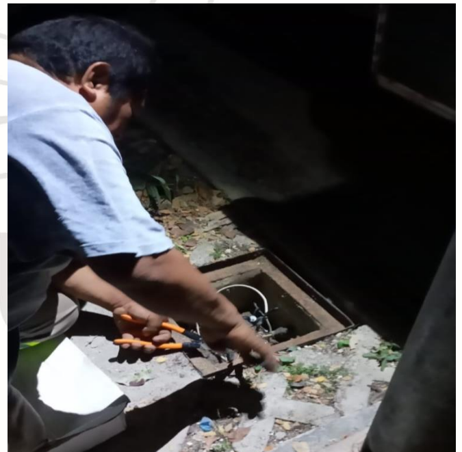
REHABILITACIÓN DE LÍNEAS DE ALUMBRADO PÚBLICO, AKUMAL
