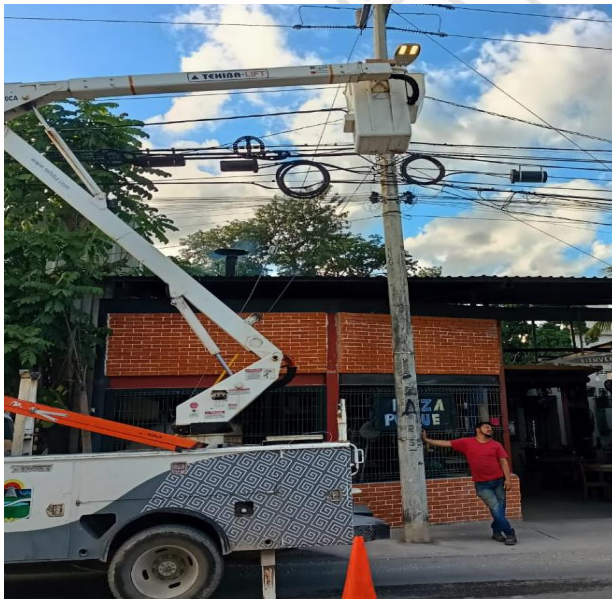
REHABILITACIÓN DE FOTOCELDA, COL. EJIDO, CALLE KUKULKAN/ TUMBEN- HA Y CHAC-MOOL
