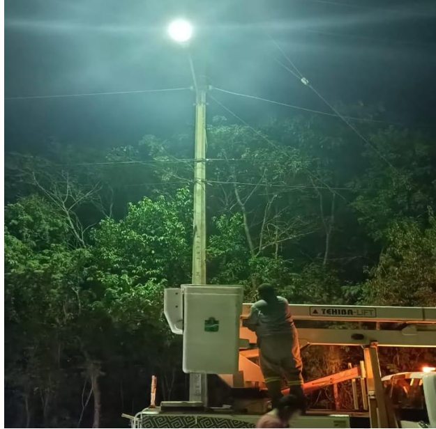
REHABILITACIÓN DE LUMINARIA, COL. TUMBEN KAA, CALLE RIO AGUA DULCE/ RIO CALIENTE Y RIO LA ESCALERA
