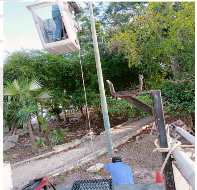
CAMBIO DE POSTE DAÑADO, FRACCIONAMIENTO PALMAS EN EL PARQUE
