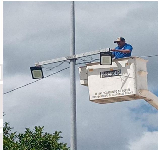
REHABILITACIÓN DE REFLECTOR, SABCAY MUCUY
