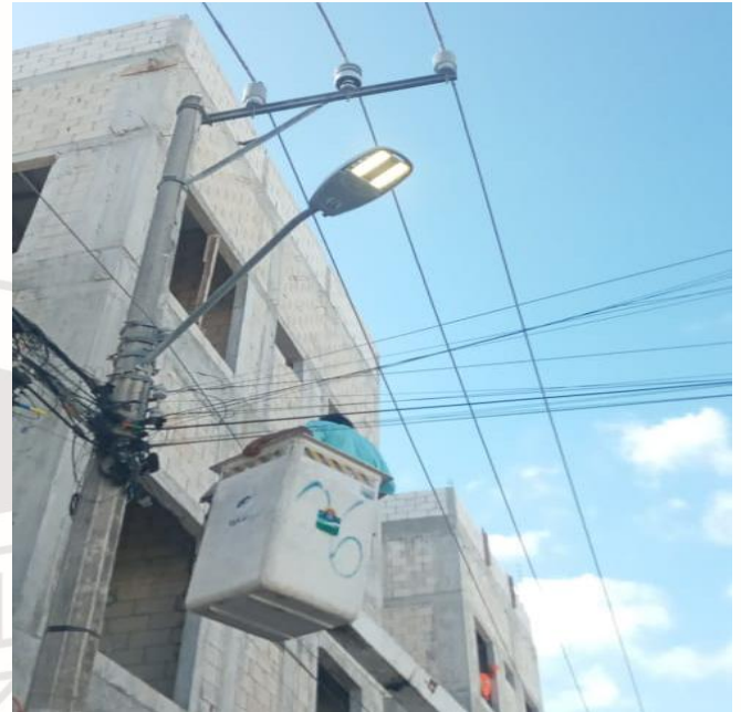
REHABILITACIÓN DE LUMINARIA, FRACCIONAMIENTO VILLAS TULUM
