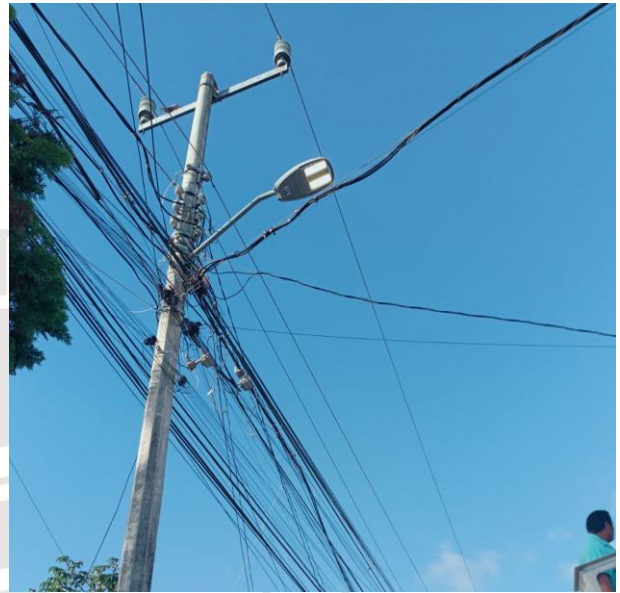
REHABILITACIÓN DE LUMINARIA, COL. CENTRO
