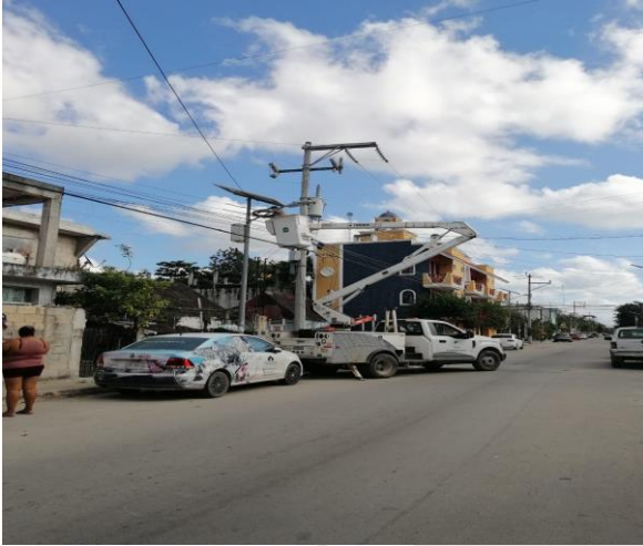
REHABILITACIÓN DE FOTOCELDA, QUE SE ENCONTRABA FUERA DE SERVICIO, COL. CENTRO, CALLE 2 / ORION
