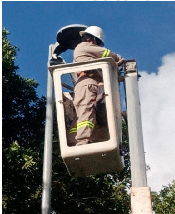
REHABILITACIÓN DE LUMINARIA, MACARIO GOMEZ
