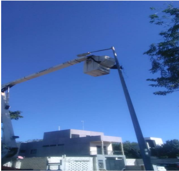
REHABILITACIÓN DE LUMINARIA, QUE SE ENCONTRABA FUERA DE SERVICIO, COL. YAAXTULUM, CALLE ALCATRAS / AZUCENA
