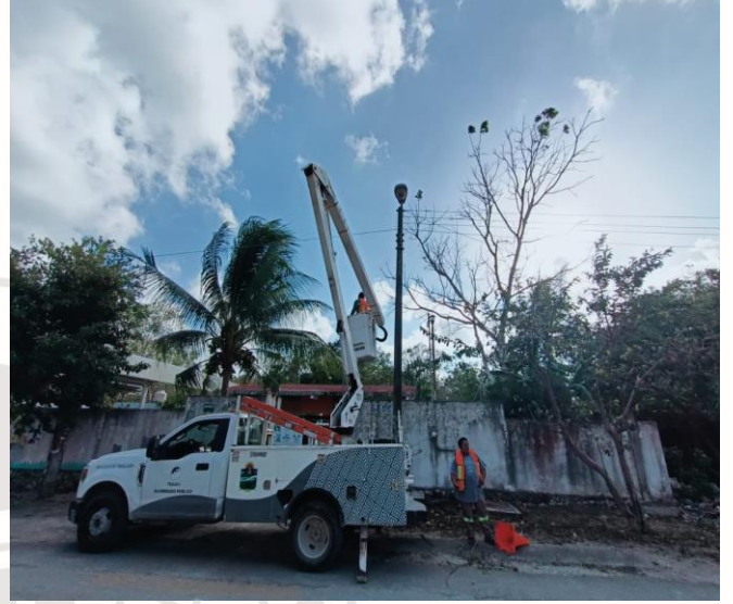
REHABILITACIÓN DE LÍNEAS DE ALUMBRADO PÚBLICO, MACARIO GOMEZ
