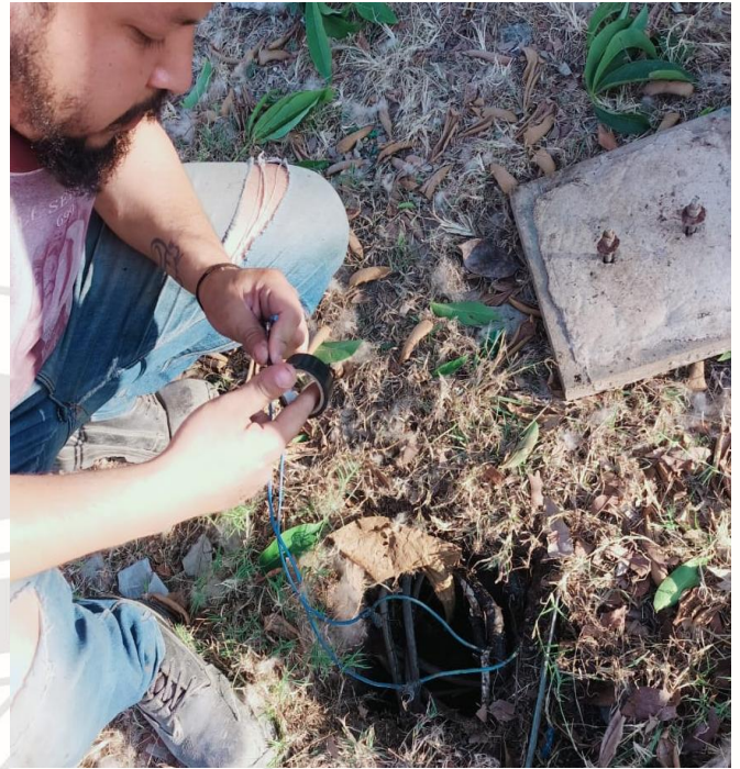
REHABILITACIÓN DE LÍNEAS DE ALUMBRADO PÚBLICO, COL. CENTRO
