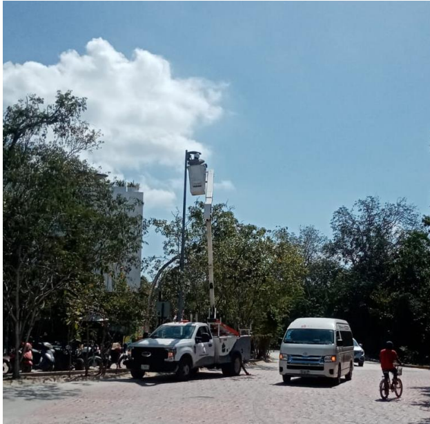
CAMBIO DE POSTES, FRACCIONAMIENTO ALDEA ZAMA
