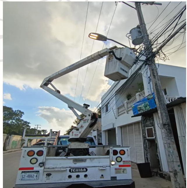
REHABILITACIÓN DE LUMINARIA, COL. EJIDO, CALLE KUKULCAN/ TUMBEN- HA Y CHAC-MOOL
