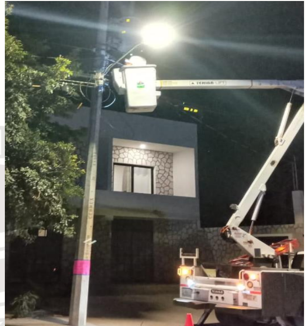
REHABILITACIÓN DE LUMINARIA, QUE SE ENCONTRABA FUERA DE SERVICIO, COL. YA'AX TULUM, CALLE 2 NTE BIS/ GLADIOLA Y 15 AV. NTE
