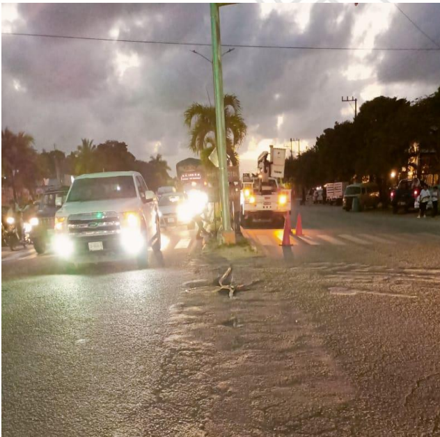
REHABILITACIÓN DE LUMINARIA, COL. CENTRO, AV. TULUM CON AV. KUKULCAN.
