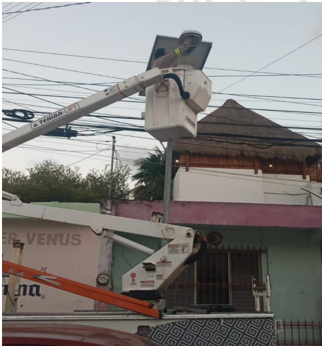
REHABILITACIÓN DE LUMINARIA, COL. CENTRO
