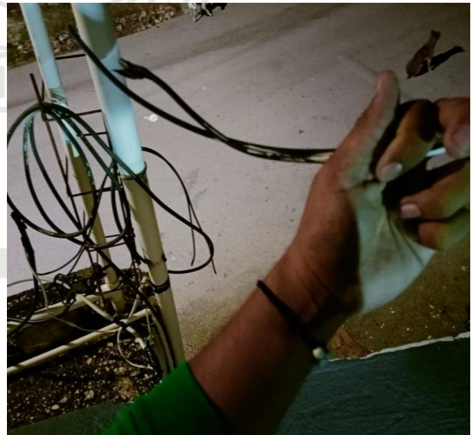
RECONEXIÓN DE LÍNEAS AÉREAS SULFATADAS, UNIDAD DEPORTIVA
