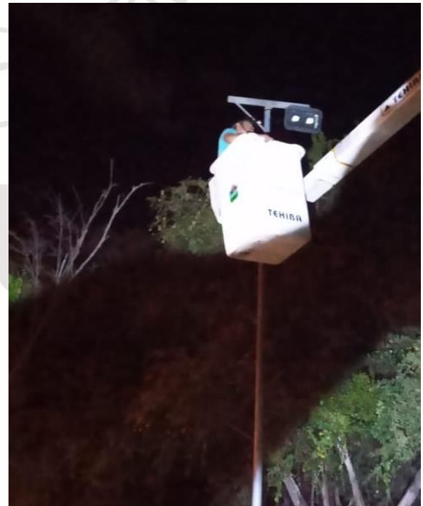
REHABILITACIÓN DE LUMINARIA, FRACCIONAMIENTO LAS PALMAS
