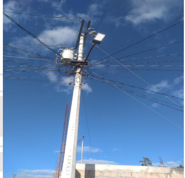
RECONEXIÓN DE LINEA ÁREA, QUE SE ENCONTRABA SULFATADO, AKUMAL
