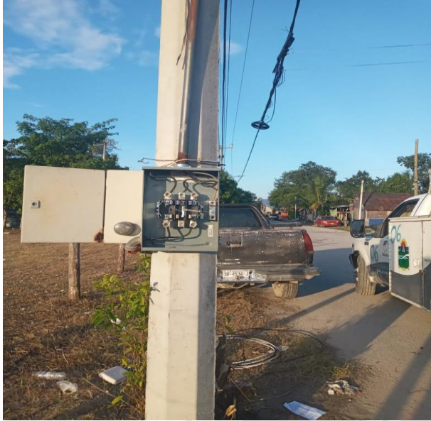
INSTALACIÓN DE BASE DE MEDIDOR, EL ANTERIOR SE ENCONTRABA EN MALAS CONDICIONES, COL. EJIDO, CALLE KUKULKAN / VENADO
