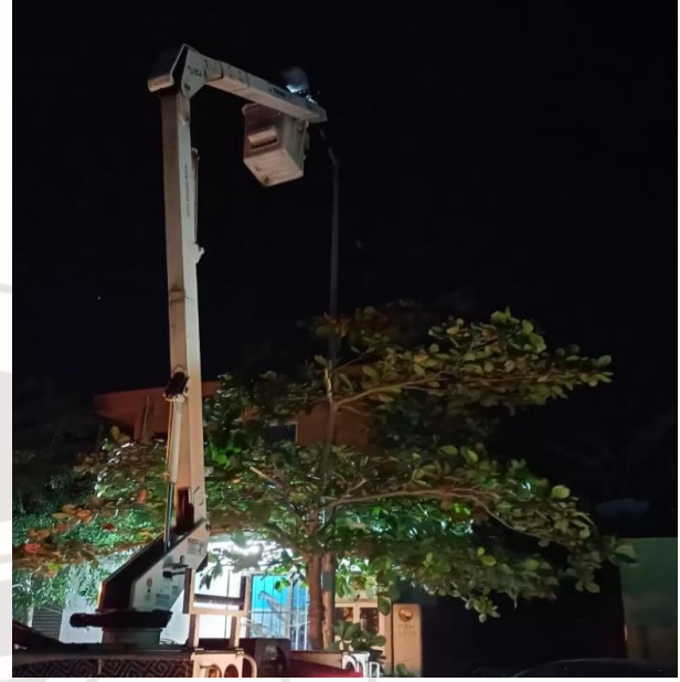
REHABILITACIÓN DE LUMINARIA, COL. YA'AX TULUM, CALLE TULIPANES/ MARGARITA Y AZUCENA
