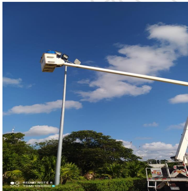
REHABILITACIÓN DE REFLECTOR TIPO LED, QUE SE ENCONTRABA FUERA DE SERVICIO, UNIDAD DEPORTIVA
