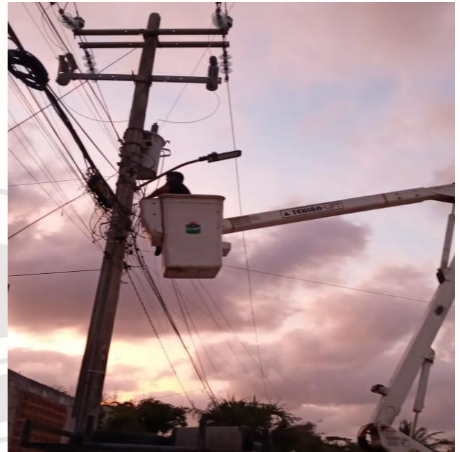
REHABILITACIÓN DE LUMINARIA, COL. CENTRO
