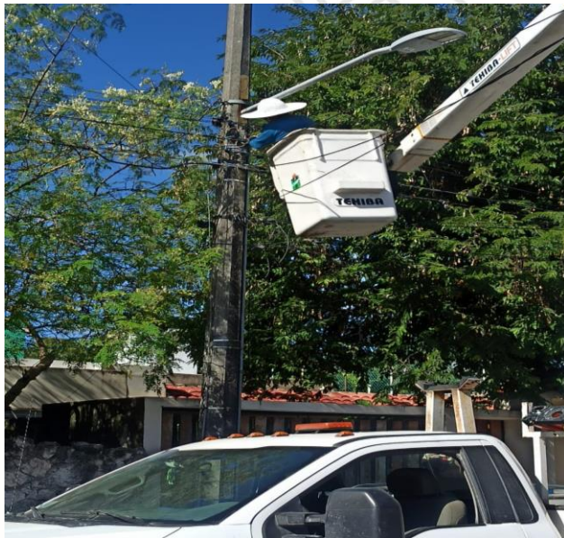
REHABILITACIÓN DE LÍNEAS DE ALUMBRADO PÚBLICO FRACCIONAMIENTO VILLAS TULUM, CALLE 17/ 4 OTE
