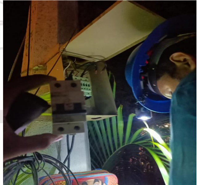
REHABILITACIÓN DE CONTACTOR, AV TULUM (FILTRO POLICIACO)
