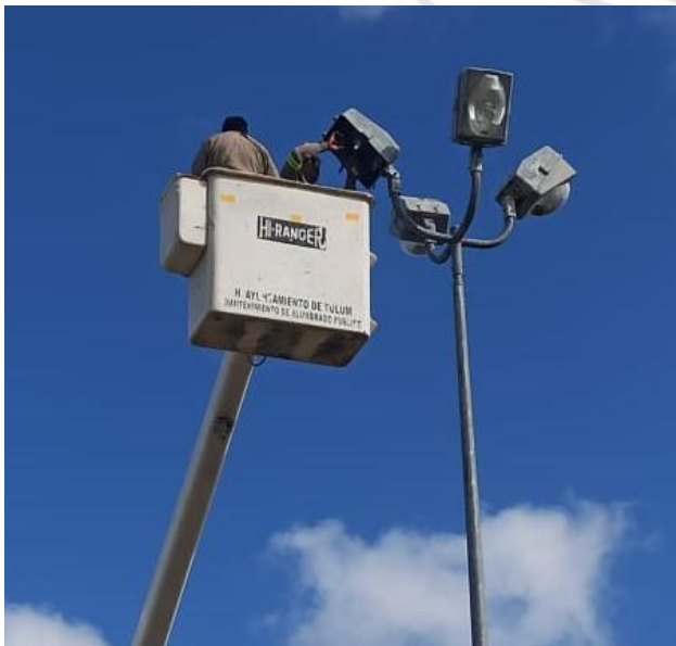
REHABILITACIÓN DE LUMINARIA, QUE SE ENCONTRABA FUERA DE SERVICIO, COBA
