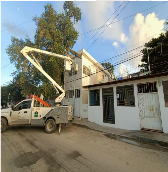
INSTALACIÓN DE BASE DE FOTOCELDA, COL. CENTRO, CALLE 2 / ORION
