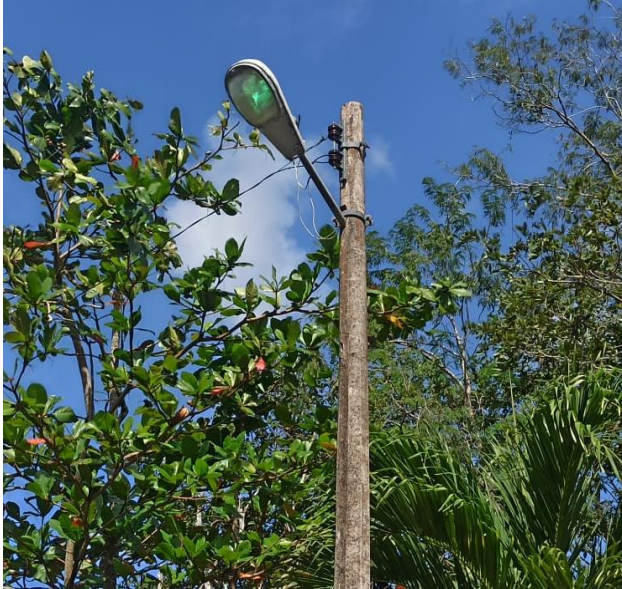
REHABILITACIÓN DE LUMINARIA, CHAN-CHEN 1
