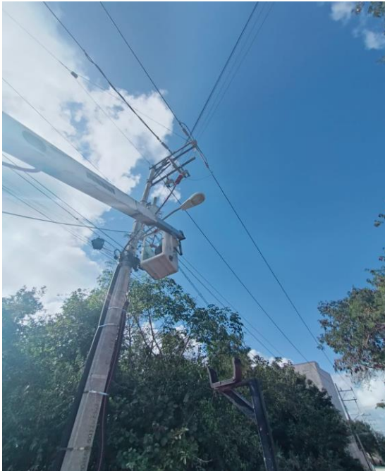
REHABILITACIÓN DE LUMINARIA, AKUMAL
