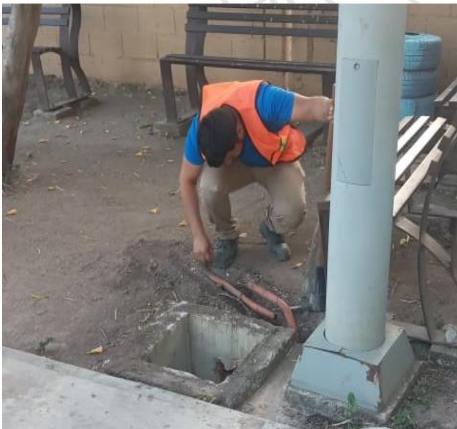
REHABILITACIÓN DE LÍNEAS DE ALUMBRADO PÚBLICO, COL. TUMBEN KAA
