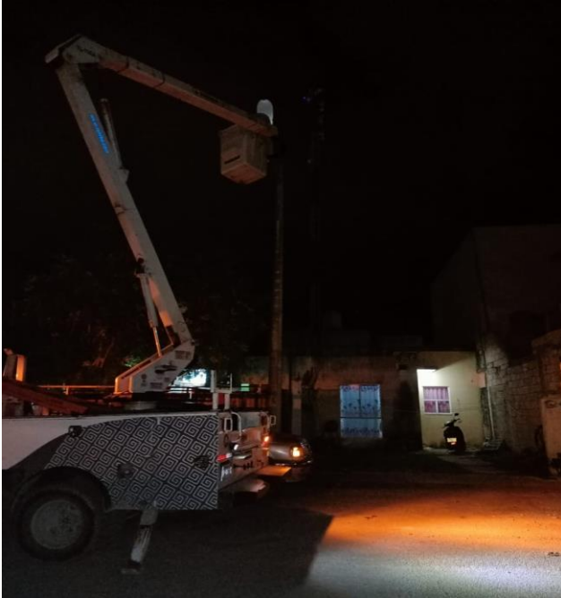
REHABILITACIÓN DE LUMINARIA, FRACCIONAMIENTO LAS PALMAS, CALLE PALMA REYNA / BULEVAR PALMAS
