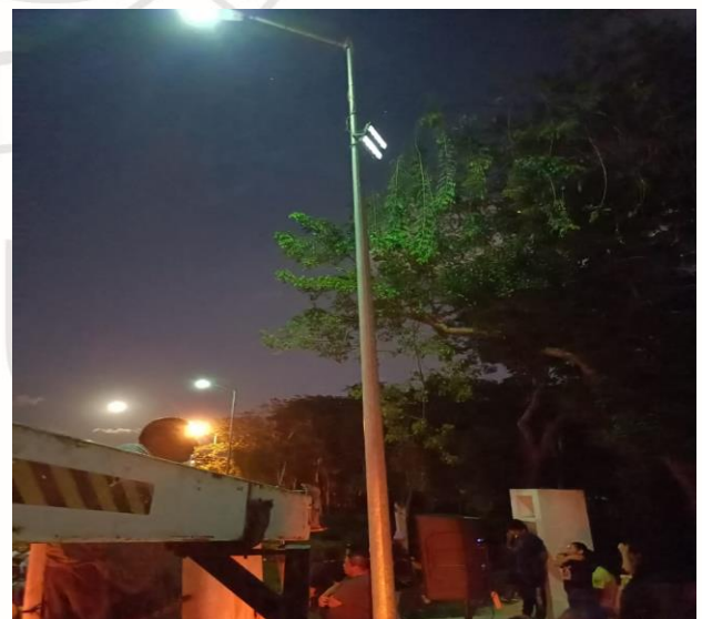
REHABILITACIÓN DE LAMPARA, QUE SE ENCONTRABA FUERA DE SERVICIO, COL. YAAXTULUM, CALLE ALCATRAS / AZUCENA
