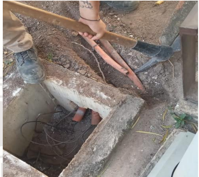
REHABILITACIÓN DE LÍNEAS DE ALUMBRADO PÚBLICO, COL. TUMBEN KAA
