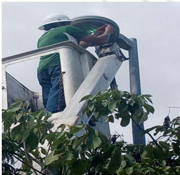
REHABILITACIÓN DE LUMINARIA, FRACCIONAMIENTO ALDEA ZAMA EN LA AVENIDA PRINCIPAL ENTRE CALLE KABA Y AVENIDA CONCEJO CIUDADANO
