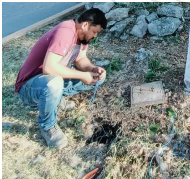
REHABILITACIÓN DE LÍNEAS DE ALUMBRADO PÚBLICO, AKUMAL
