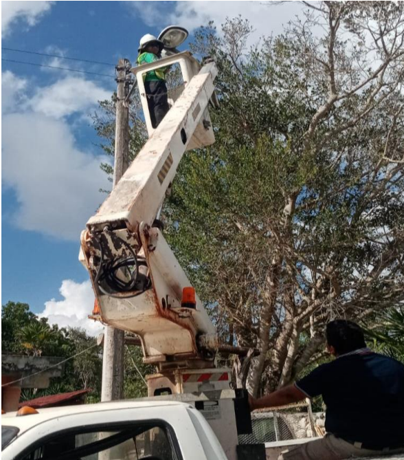
REHABILITACIÓN DE FOTOCELDA, COL. CRISTAL
