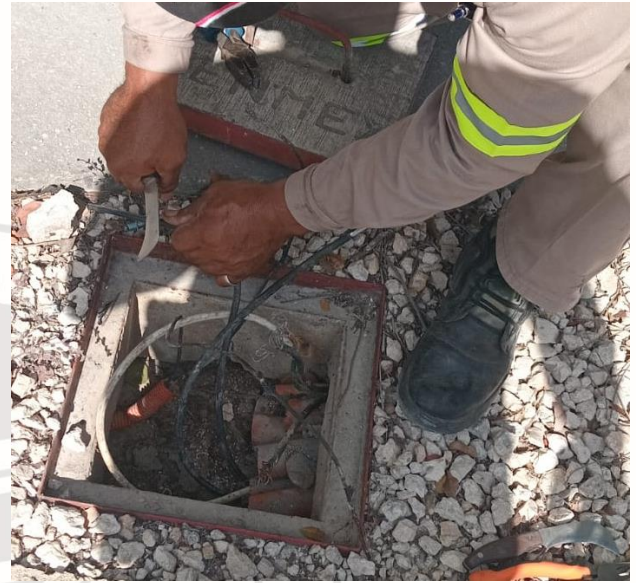
REHABILITACIÓN DE LÍNEAS DE ALUMBRADO PÚBLICO, FRACCIONAMIENTO ALDEA ZAMA
