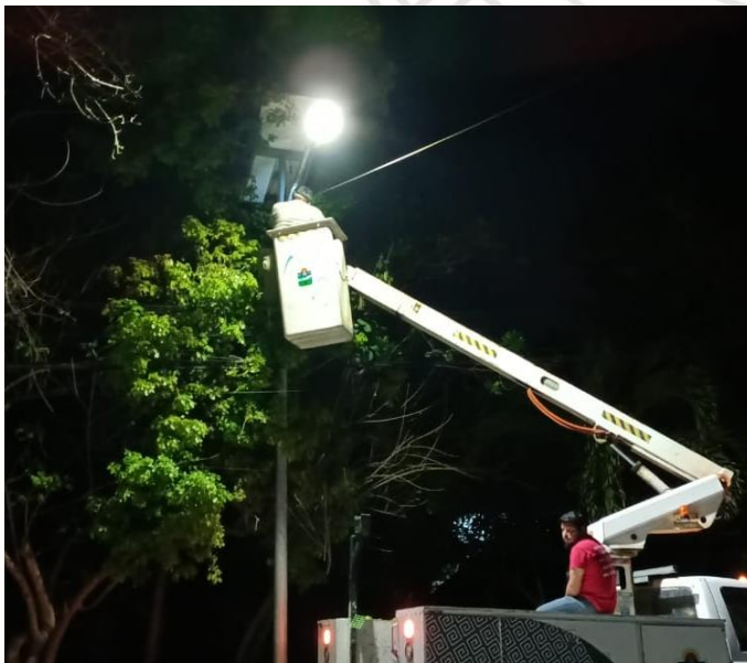
CAMBIO DE LUMINARIAS, COL. CENTRO
