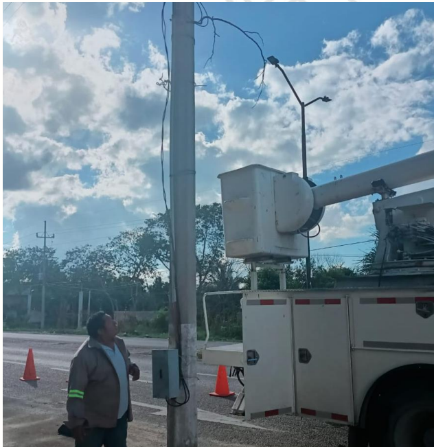
REHABILITACIÓN EN BANCO DE CONTROL, COL. TUMBEN KAA
