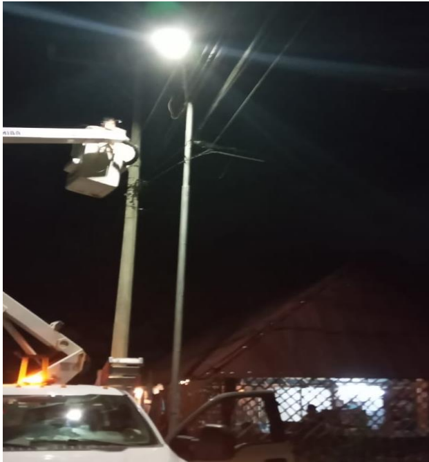
RECONEXIÓN DE LÍNEAS AÉREAS REVENTADAS COL. EJIDO, AV. LA SELVA/ CHAC-MOOL Y COCODRILO
