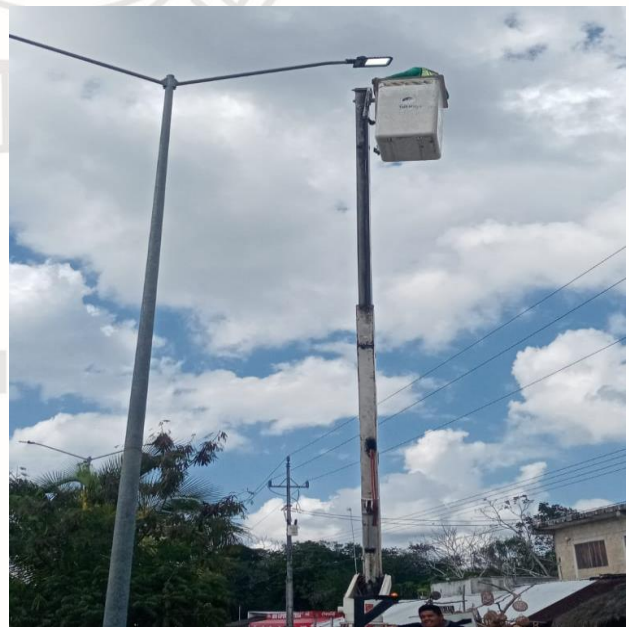
REHABILITACIÓN DE FOTOCELDA, FRACCIONAMIENTO VILLAS TULUM
