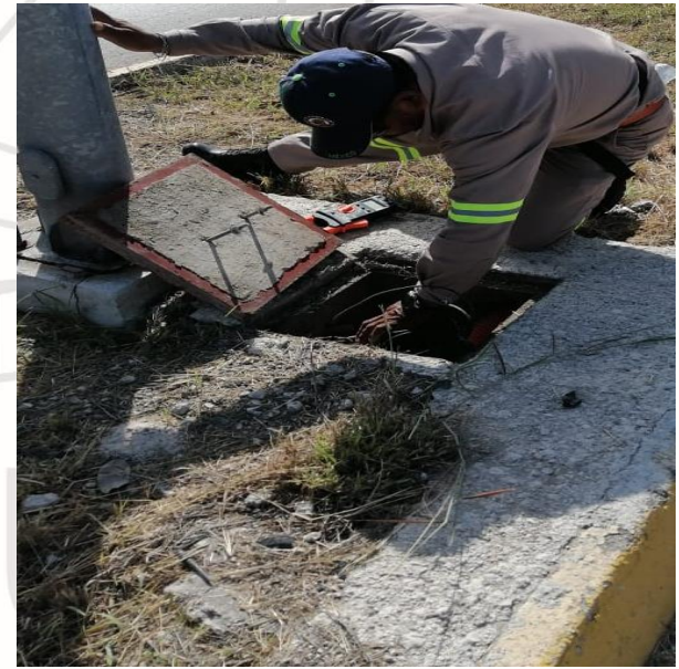
RECONEXIÓN DE LINEA SUBTERRANEA, QUE SE ENCONTRABA SULFATADA, COL. GUERRA DE CASTAS, CALLE BUBULEK / ESCORPION
