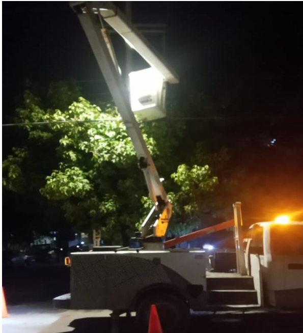
REHABILITACIÓN DE LÍNEAS DE ALUMBRADO PÚBLICO, COL. EJIDO, CALLE KUKULKAN / VENADO Y TEJON
