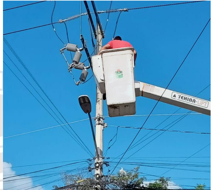
REHABILITACIÓN DE BASE DE FOTOCELDA Y FOTOCELDA, COL. MAYAPAX
