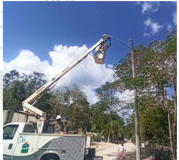
REHABILITACIÓN DE LUMINARIA, SABCAB MUCUY
