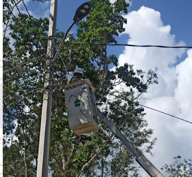
REHABILITACIÓN DE LUMINARIA, AV. 10 NTE / 2 NTE BIS EN LA GLORIETA
