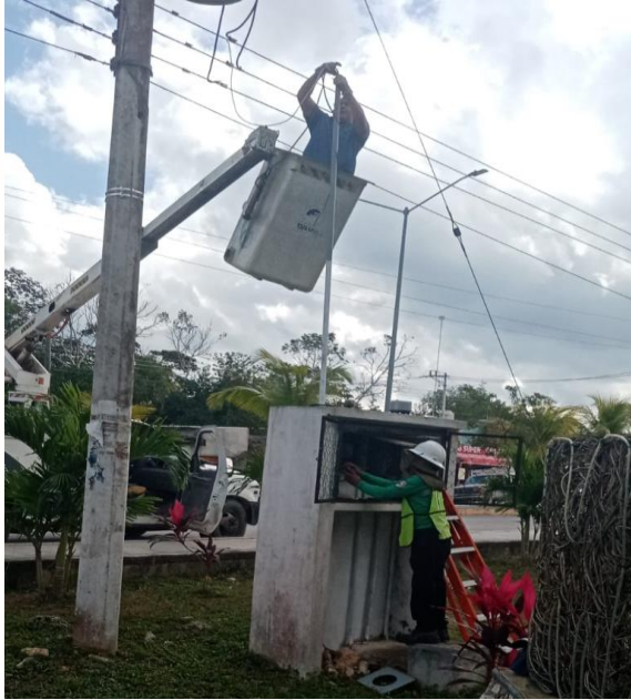
REHABILITACIÓN DE LÍNEAS DE ALUMBRADO PÚBLICO, CHAN CHEMUYIL
