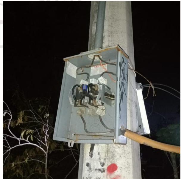
INSTALACIÓN DE BANCOS DE CONTROL, COBA
