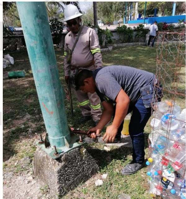
CAMBIO DE POSTES, MACARIO GOMEZ
