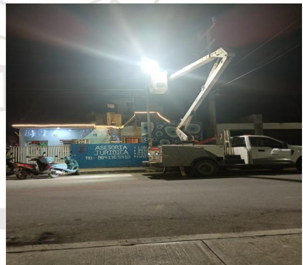
REHABILITACIÓN DE LUMINARIA, QUE SE ENCONTRABA FUERA DE SERVICIO, COL. CENTRO, CALLE 4 OTE / AV SATELITE NTE
