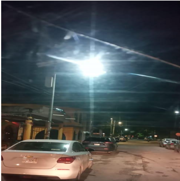
REHABILITACIÓN DE LUMINARIA, QUE SE ENCONTRABA FUERA DE SERVICIO, COL. CENTRO, CALLE OSIRIS NTE / AV TULUM
