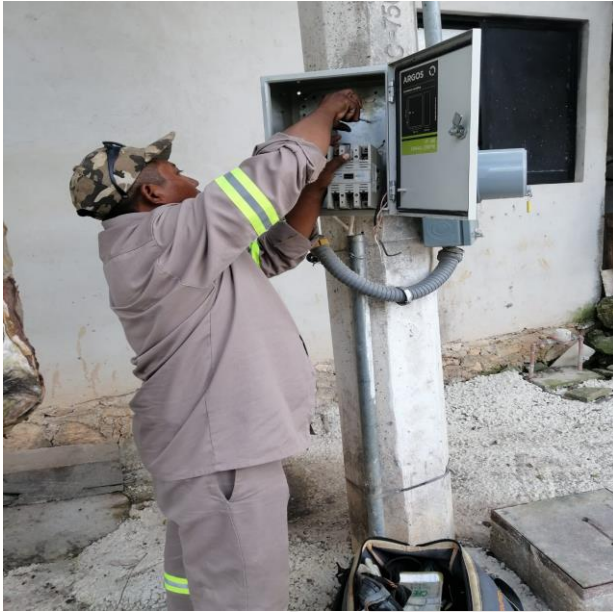
INSTALACIÓN DE CONTACTOR, COL. VELETA, CALLE 5 / AV HOLISTICA
