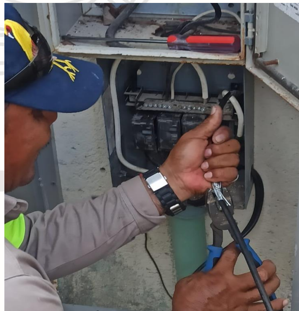
CAMBIO DE BREAK QUEMADO O CON FALLAS, RUINAS, CARRETERA TULUM- PLAYA DEL CARMEN
