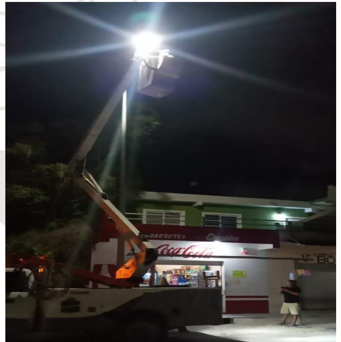
REHABILITACIÓN DE LUMINARIA, COL. YA'AX TULUM
