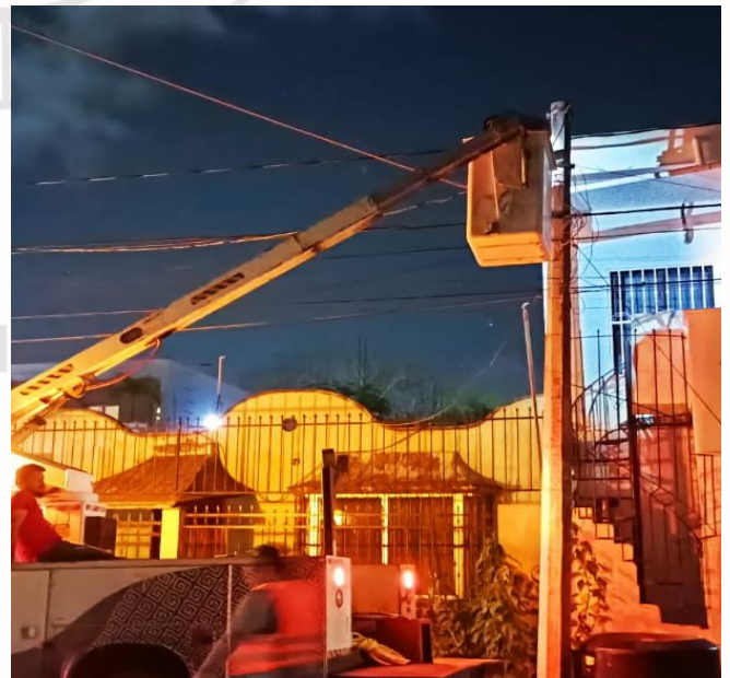
CAMBIO DE LUMINARIAS, COL. CENTRO
