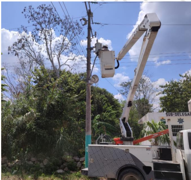
REHABILITACIÓN DE LUMINARIA, POBLADO DE YAXCHE
