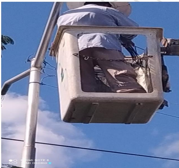
INSTALACIÓN DE CABLE ÁEREO, COL. TUMBENKAA, AV 1 / CALLE TEPESCUINTLE
