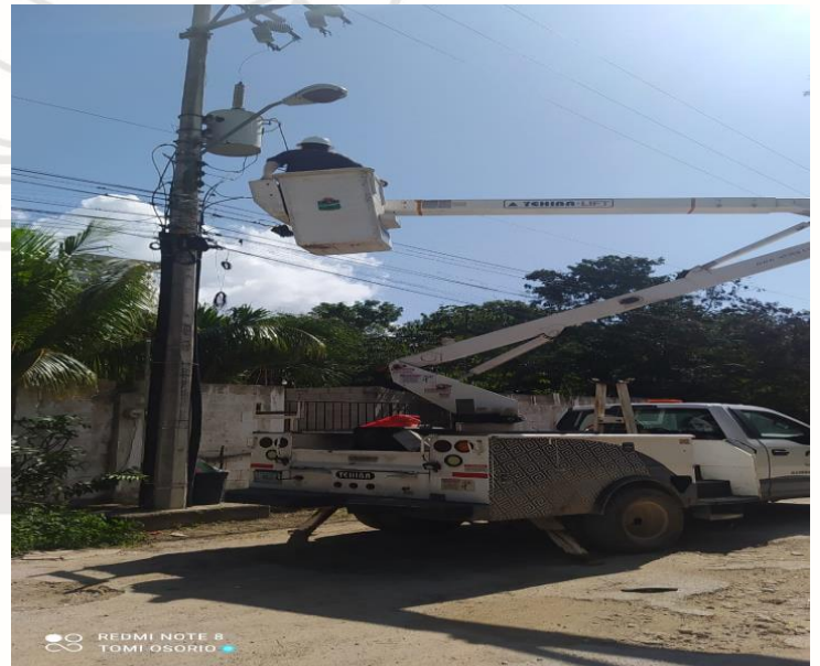
REHABILITACIÓN DE REFLECTOR, CHAN-CHEN 1
