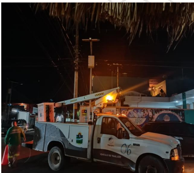
REHABILITACIÓN DE FOTOCELDA, QUE SE ENCONTRABA FUERA DE SERVICIO, COL. CENTRO, CALLE 2 OTE / ALFA NTE Y 4 OTE
