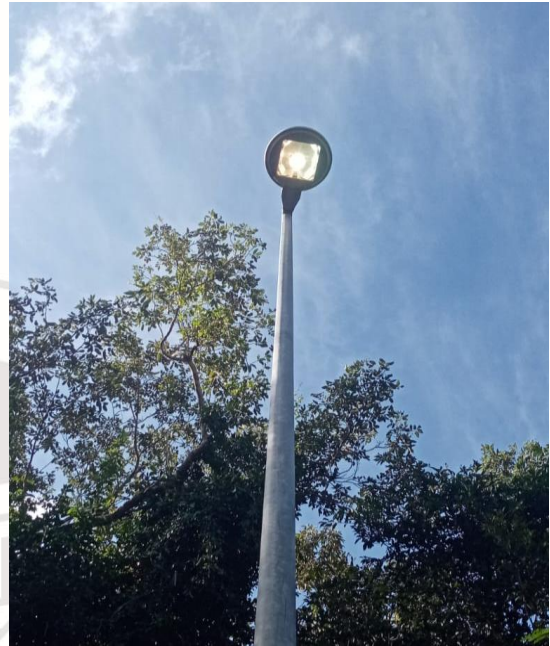
REHABILITACIÓN DE LUMINARIA, COL. EJIDO
