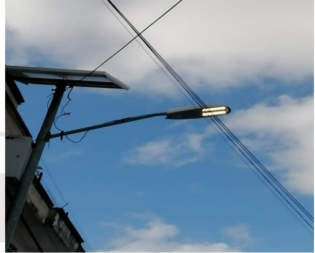
RECONEXIÓN DE LINEA ÁEREA, QUE SE ENCONTRABA SULFATADO, COL. CENTRO, CALLE 2 / ORION
