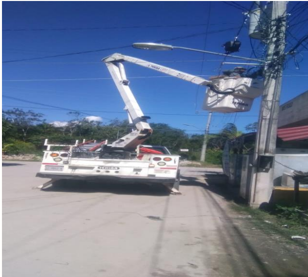
REHABILITACIÓN DE LUMINARIA, QUE SE ENCONTRABA FUERA DE SERVICIO, COL. XUL-KA, CALLE 2 NTE / SACXIKIN
