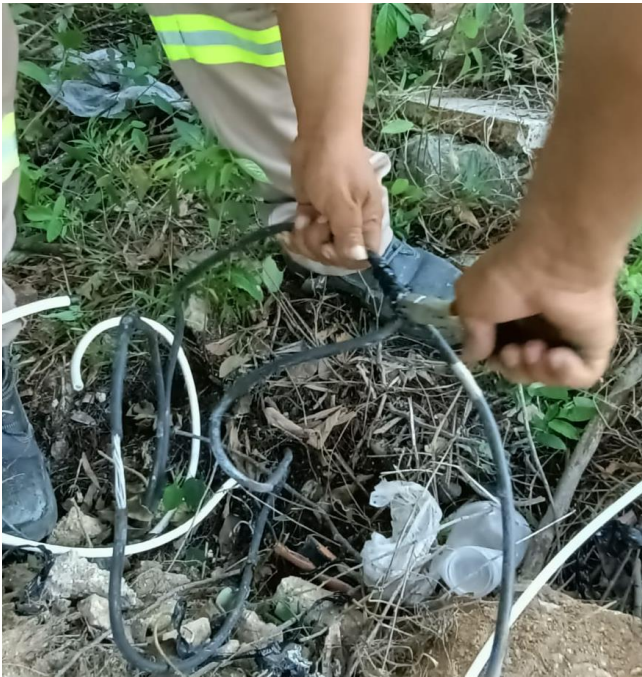
REHABILITACIÓN DE LÍNEAS DE ALUMBRADO PÚBLICO, FRACC. XUL KAA
