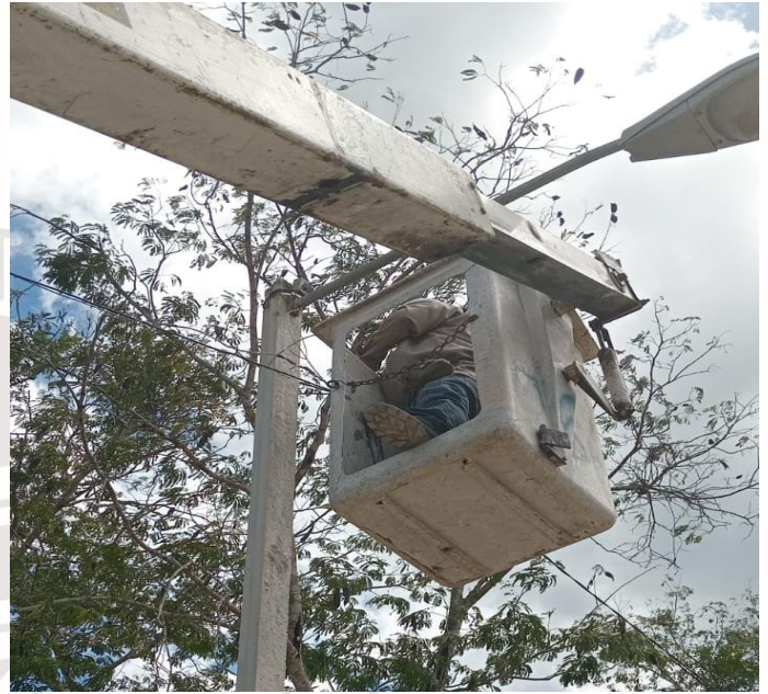
REHABILITACIÓN DE LUMINARIA, MACARIO GOMEZ
