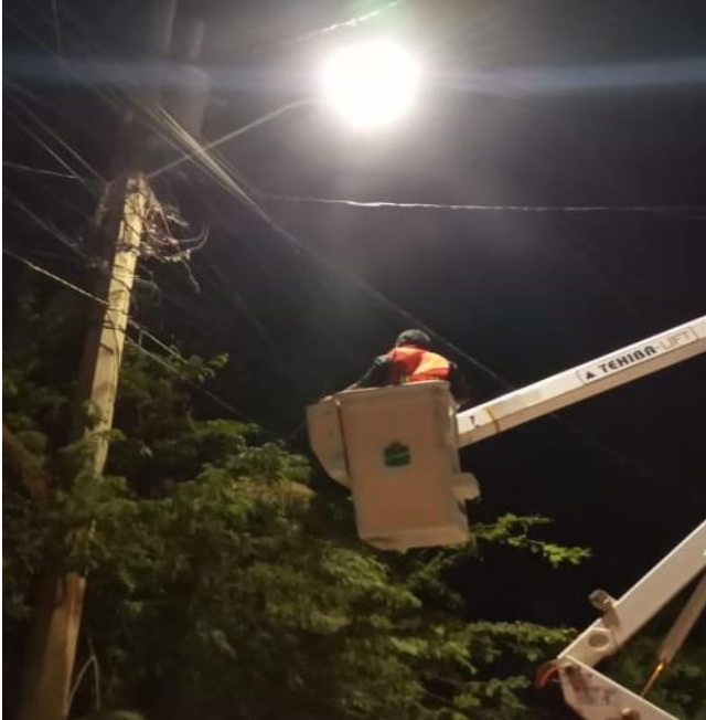
REHABILITACIÓN DE LUMINARIA, FRACCIONAMIENTO LAS PALMAS
