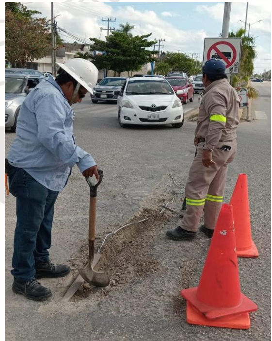
REHABILITACIÓN DE LÍNEAS DE ALUMBRADO PÚBLICO, COBA
