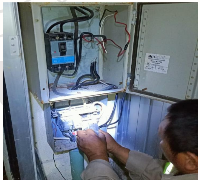
CAMBIO DE CONTACTOR QUEMADO, ZONA ARQUEOLOGICA
