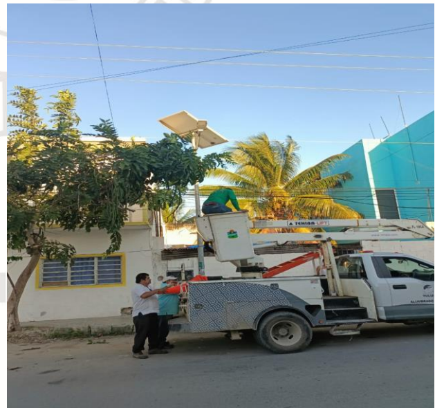
REHABILITACIÓN DE LUMINARIA, QUE SE ENCONTRABA FUERA DE SERVICIO, COL. CENTRO, CALLE ALFA NTE / 4 OTE Y SAGITARIO
