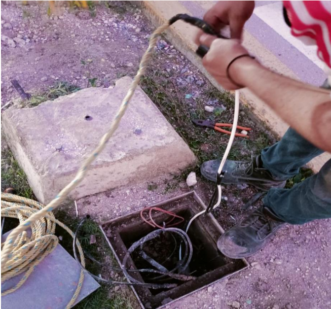
RECONEXIÓN DE LÍNEAS SUBTERRANEAS SULFATADAS, COL. CENTRO, AV. TULUM CON AV. KUKULCAN.
