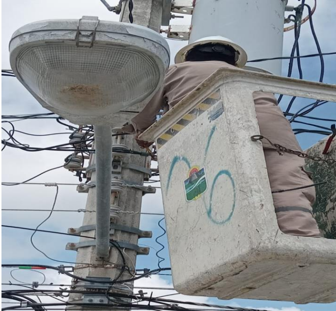
REHABILITACIÓN DE LUMINARIA, AKUMAL
