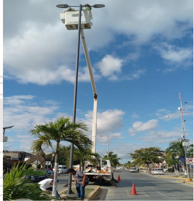
REHABILITACIÓN DE LUMINARIA, COL.CENTRO, AV. TULUM / CENTAURO
