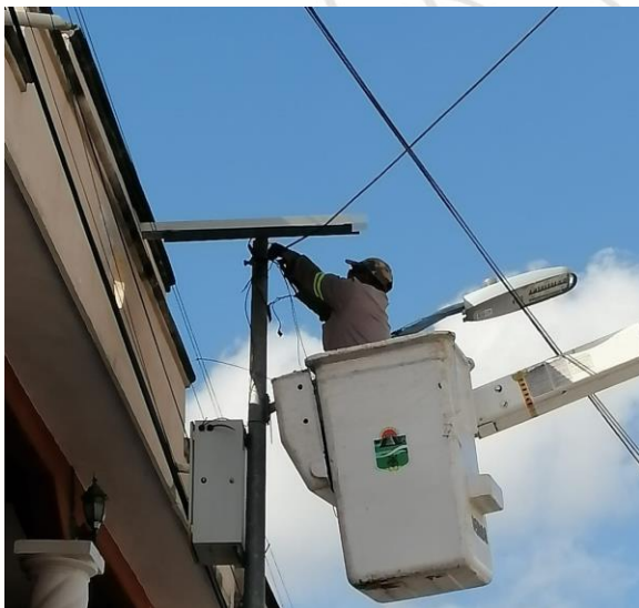
RECONEXIÓN DE LINEA SUBTERRANEA, QUE SE ENCONTRABA SULFATADA, COL. CENTRO, CALLE 4 OTE / ALFA NTE Y OMEGA NTE
