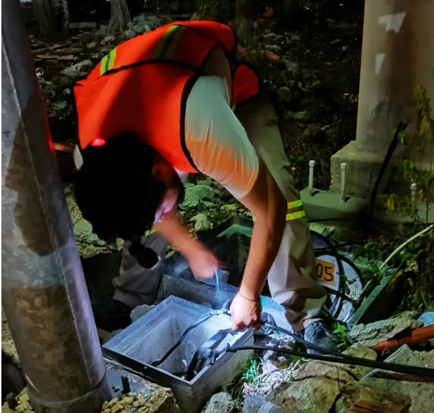
REHABILITACIÓN DE LÍNEAS DE ALUMBRADO PÚBLICO, COL. YA'AX TULUM
