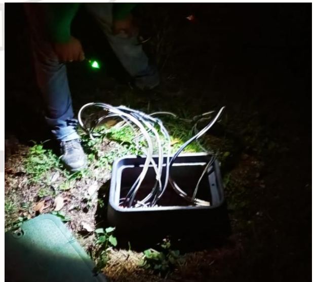
REHABILITACIÓN DE LÍNEAS DE ALUMBRADO PÚBLICO, COL CENTRO EN LA UNIDAD DEPORTIVA
