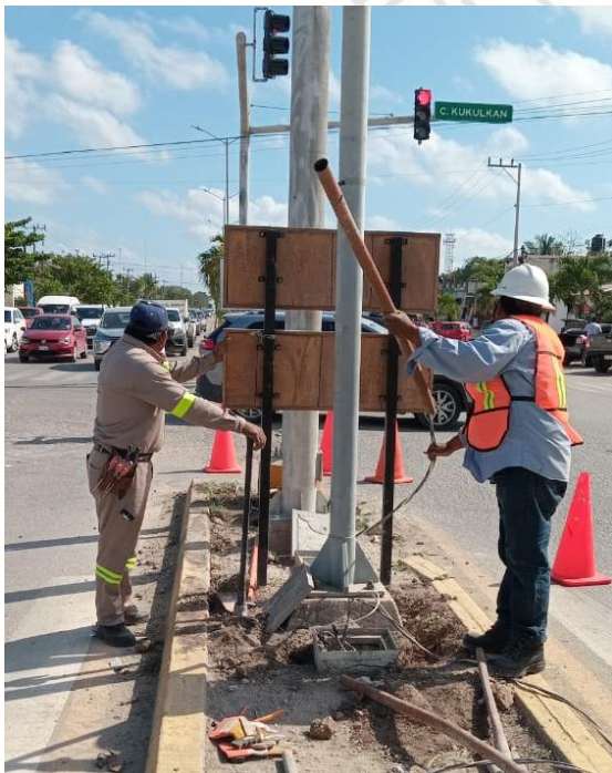
REHABILITACIÓN DE LÍNEAS DE ALUMBRADO PÚBLICO, COL. CENTRO
