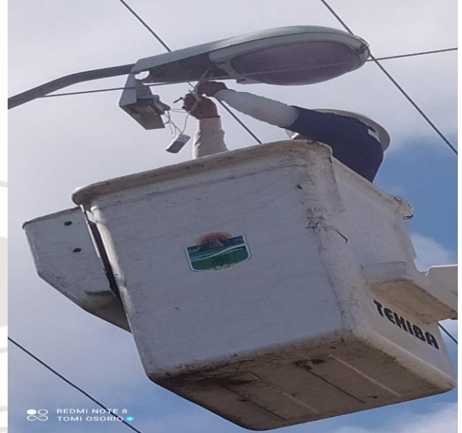
REHABILITACIÓN DE LAMPARA Y BALASTRO, QUE SE ENCONTRABA FUERA DE SERVICIO, COL. TUMBENKAA, CALLE RIO BASCA
