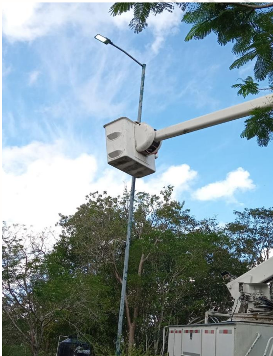
REHABILITACIÓN DE LUMINARIA, COBA
