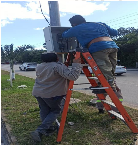
REHABILITACIÓN DE FOTOCELDA, COL. CENTRO, AV TULUM
