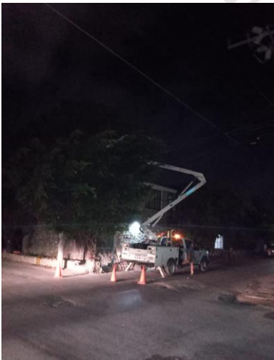
COL. CENTRO, C. ANDROMEDA / OSIRIS Y CENTAURO, REEMPLAZO DE LUMINARIAS OBSOLETAS POR LAMPARAS LED DE 100 W.
