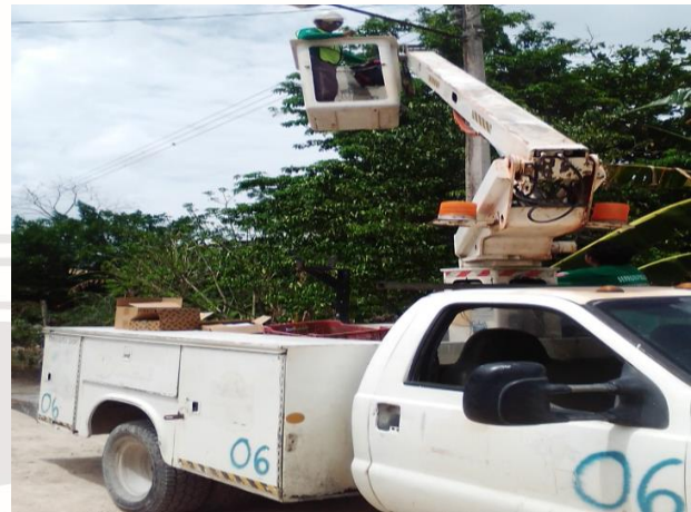
COL. MAYAPAX, C. OSIRIS Y TUNKUL, REEMPLAZO DE LUMINARIAS OBSOLETAS POR LAMPARAS LED DE 100.
