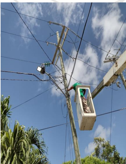
COL. CENTRO, C. GAMA OTE/ ORION SUR, RECONEXIÓN DE LINEAS REVENTADA PARA HABILITAR LAMPARAS
