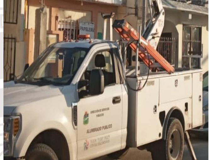
COL. YAAX TULUM. C. GLADIOLAS, REPARACION DE SISTEMA ELECTRICO DE LA GONDOLA 06
