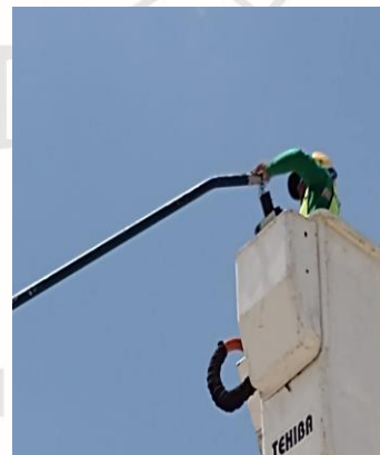
COL. CENTRO, C. ALFA NORTE / POLAR, RECONEXIÓN DE LINEAS A LAMPARA QUE ESTAN SULFATADAS
