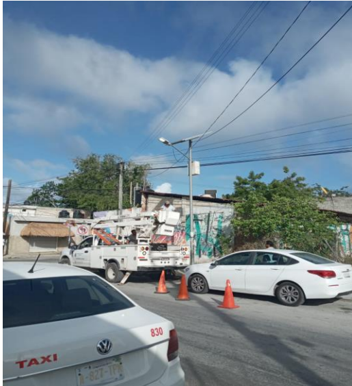
COL. CENTRO, C. ACUARIO PTE / 2 Y 4 PTE, SE REALIZA LA RECONEXIÓN DE LINEAS SUBTERRANEAS QUE PRESENTABA FALLA
