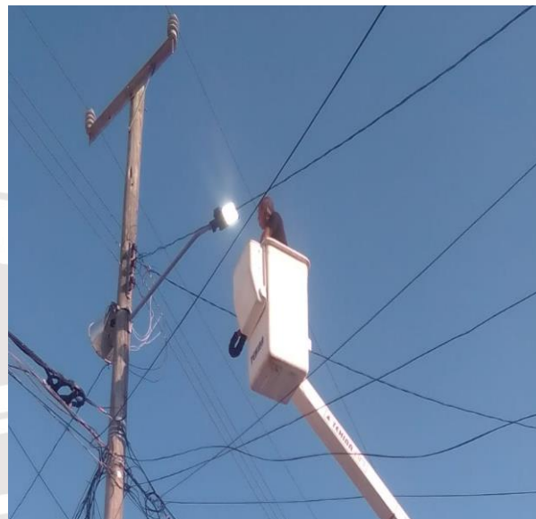
COL. CENTRO, C. PLUTON / ALFA Y OMEGA, REEMPLAZO DE LUMINARIAS QUEMADAS POR LAMPARAS LED DE 100 W.
