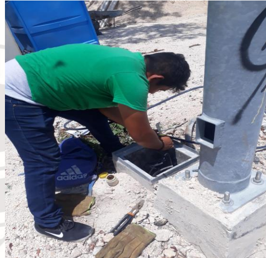
COL. EJIDO, C. 30 / C. 11 Y 09, SE REALIZA LA RECONEXIÓN DE LINEAS SUBTERRANEAS QUE PRESENTABA FALLA.
