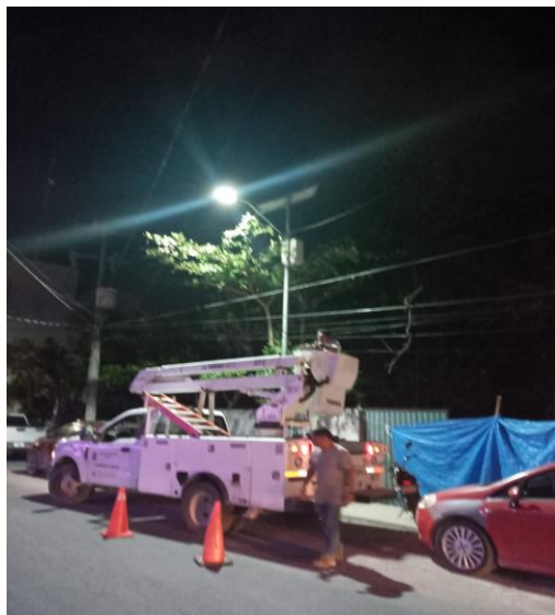
COL. CENTRO C. ALFA SUR Y SOL PTE, CAMBIO DE FOTOCELDA 220V
