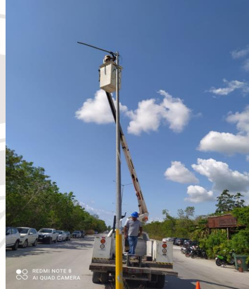
COL. LA VELETA, AV. 5, SE REHABILITA DE LAMPARA Y BALASTRO OV-15 (TIPO AM-175W Y BALASTRO AM-175W)
