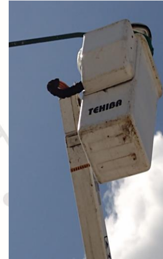
MANUEL ANTONIO HAY, REEMPLAZO DE LUMINARIAS OBSOLETAS POR LAMPARAS LED DE 100 W.
