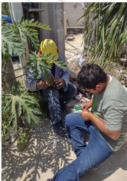
COL. YAAX TULUM, C. CLAVEL Y MARGARITA Y AZUCENA, SE REALIZA LA RECONEXIÓN DE LINEAS SUBTERRANEAS QUEMADAS.
