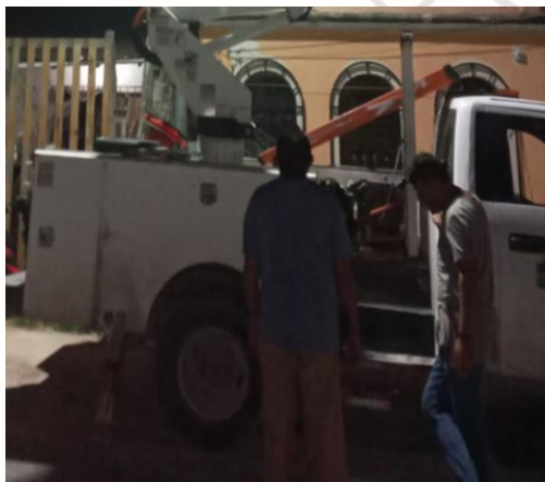
FRANCISCO UH MAY, SE REALIZA LA RECONEXIÓN DE LINEAS SUBTERRANEAS QUE ESTABA SULFATADA
