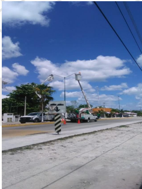
MANUEL ANTONIO HAY, REEMPLAZO DE LUMINARIAS OBSOLETAS POR LAMPARAS LED DE 100 W.
