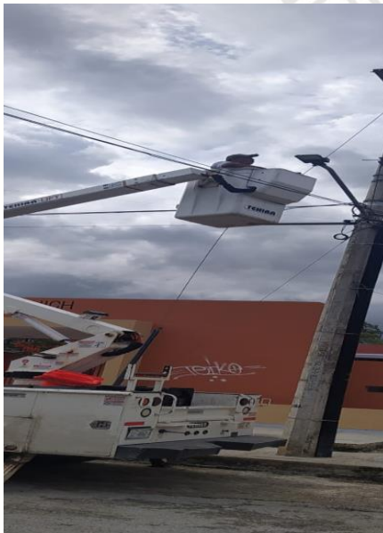
COL. MAYA PAX, C. JUPITER / TUNKUL, SE REALIZA LA RECONEXIÓN DE LINEAS AEREAS SULFATADAS.
