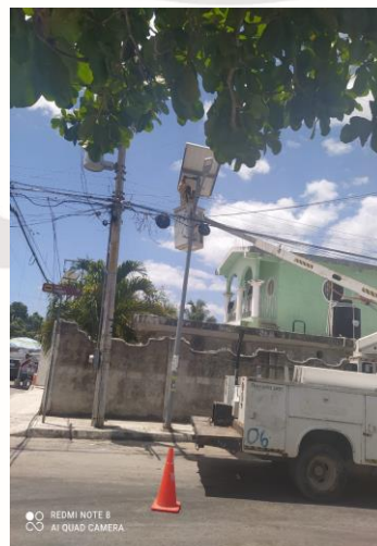
COL. CENTRO, C. 2 OTE / OSIRIS Y BETA, REEMPLAZO DE LUMINARIAS OBSOLETAS POR LAMPARAS LED DE 100 W.
