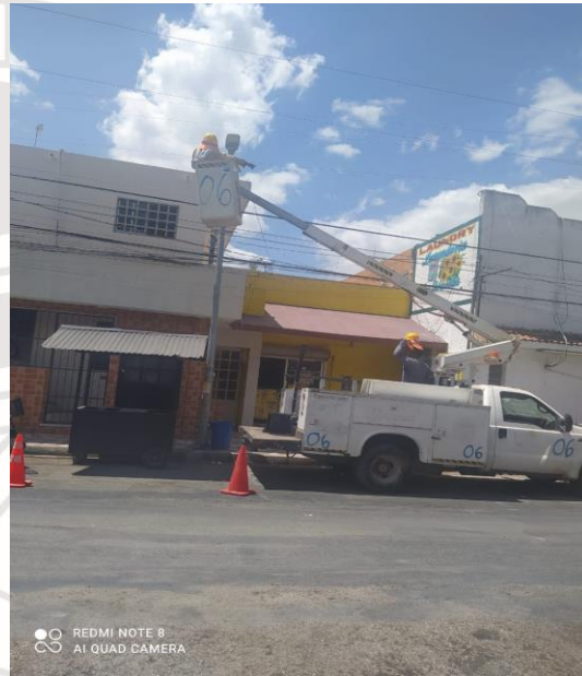
COL. CENTRO, C. 2 OTE / BETA Y ORION, REEMPLAZO DE LUMINARIAS OBSOLETAS POR LAMPARAS LED DE 100 W.
