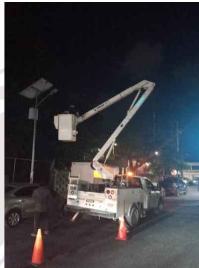
COL. CENTRO, C 40TE, AV. SATELITE Y ORION, REEMPLAZO DE LUMINARIAS QUEMADAS POR LAMPARAS LED DE 100 W.
