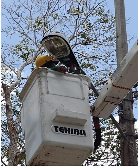
COL. XULKA, C.2 BIS Y JALEB, RECONEXIÓN DE LINEAS A LAMPARA QUE ESTAN SULFATADAS.
