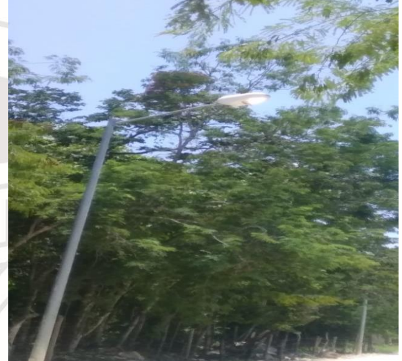
CICLOVIA, AV. SATELITE, PARQUE DOS AGUAS, UNIDAD DEPORTIVA, HOLISTICA, ETC, REALIZACIÓN DE RECORRIDO DE APAGADO DE SECTORES MANUALES
