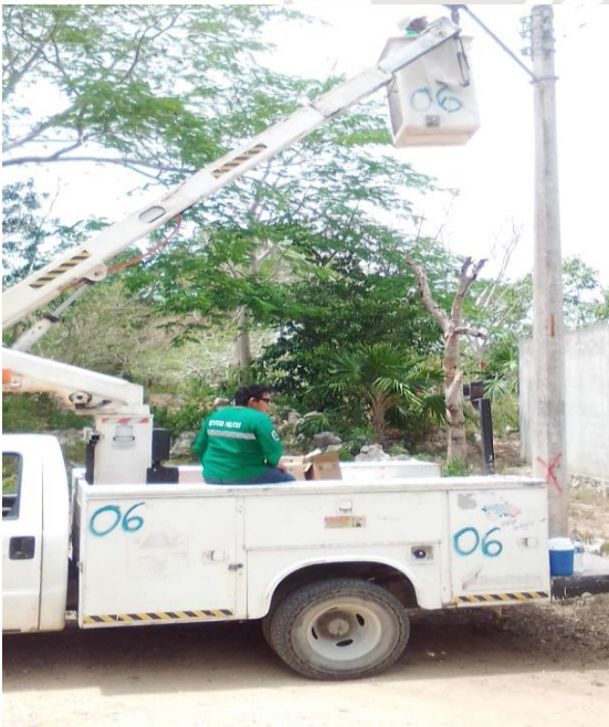
COL. MAYAPAX, C. ALFA NTE Y OKOOT, REEMPLAZO DE LUMINARIAS OBSOLETAS POR LAMPARAS LED DE 100 W.
