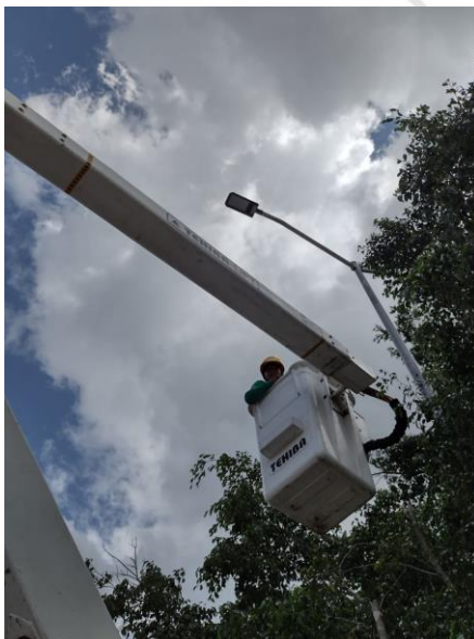
FRANCISCO UH MAY, REEMPLAZO DE LUMINARIAS OBSOLETAS POR LAMPARAS LED DE 100 W.
