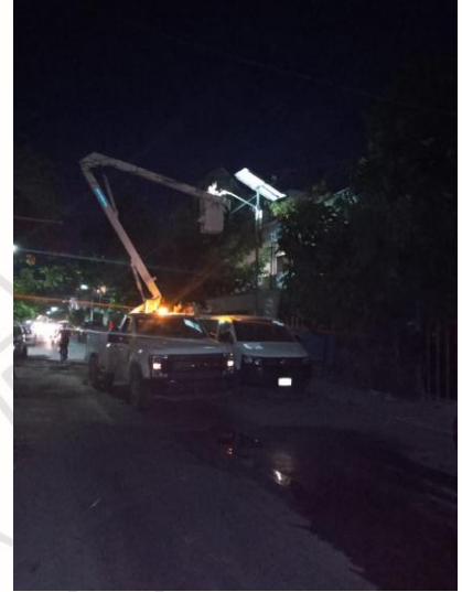
COL. CENTRO, C. SOL OTE Y BETA SUR, REEMPLAZO DE LUMINARIAS OBSOLETAS POR LAMPARAS LED DE 100 W.
