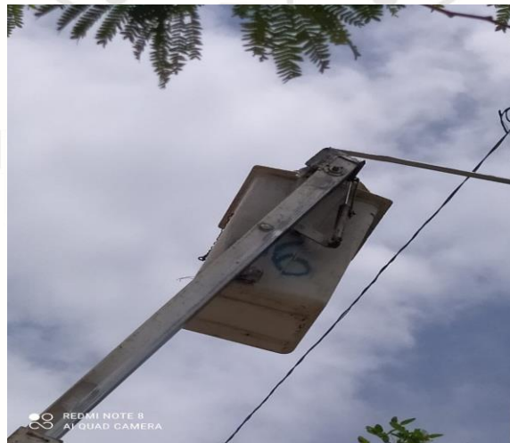
COL. MAYAPAX, C. OSIRIS / OKOOT Y TUNKUL, SE REHABILITA DE LAMPARA Y BALASTRO OV-15 (TIPO AM- 175W Y BALASTRO AM-175W).
