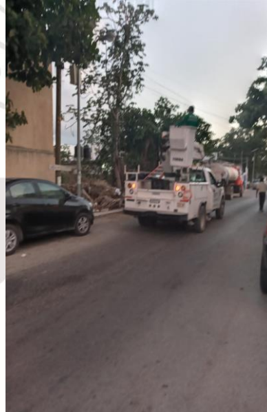
COL. VELETA, C. 14 Y 7, SE REALIZA LA RECONEXIÓN DE LINEAS AEREAS SULFATADAS.
