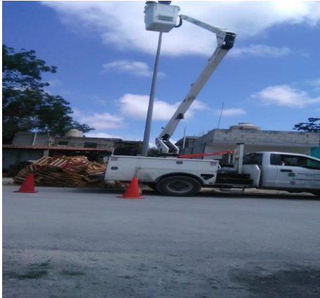
COL. YAAX TULUM, SE REHABILITA DE LAMPARA Y BALASTRO OV-15 (TIPO AM-175W Y BALASTRO AM-175W)
