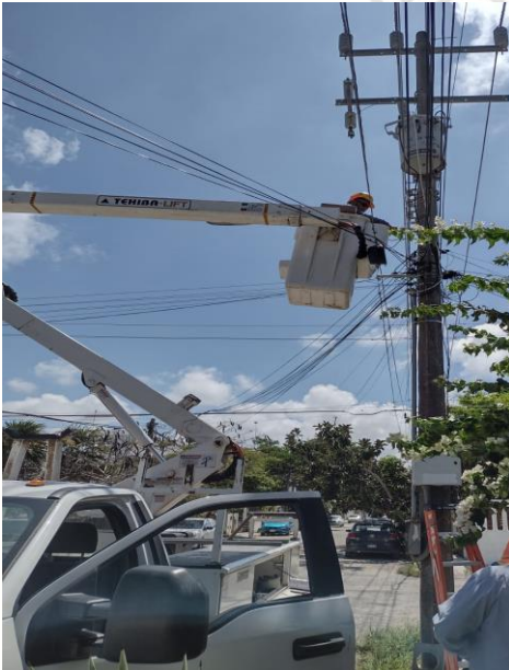
TUMBEN KA, C. NABAL/ C. 15 Y 17, SE REHABILITA DE LAMPARA Y BALASTRO OV-15 (TIPO AM-175W Y BALASTRO AM-175W)
