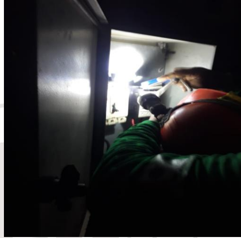
FRAC. VILLAS TULUM, SE INSTALA UN CONTACTOR EN BANCO DE CONTROLES.
