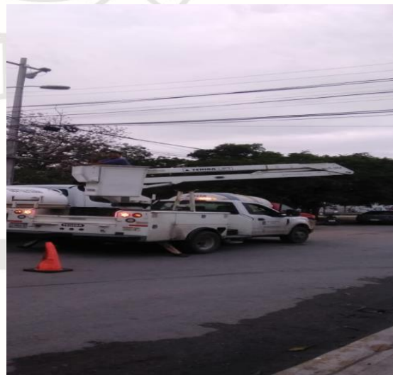
CICLOVIA, AV. SATELITE, PARQUE DOS AGUAS, UNIDAD DEPORTIVA, HOLISTICA, ETC, REALIZACIÓN DE RECORRIDO DE APAGADO DE SECTORES MANUALES.
