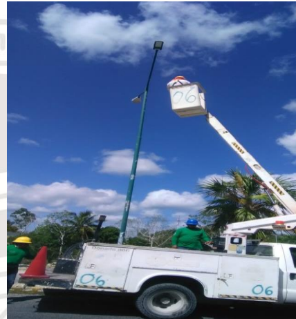
MANUEL ANTONIO HAY, REEMPLAZO DE LUMINARIAS OBSOLETAS POR LAMPARAS LED DE 100 W.
