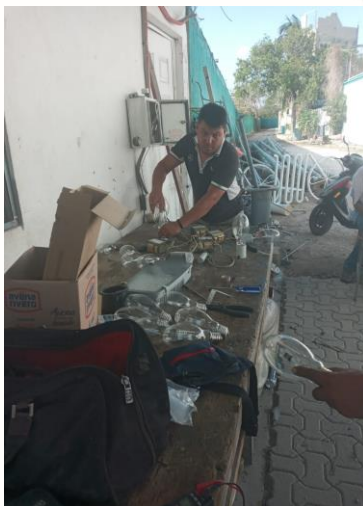
BODEGA, VERIFICACION DE MATERIALES EN BODEGA
