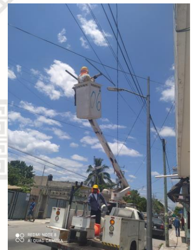
HOLISTICA, SE REHABILITA DE LAMPARA Y BALASTRO OV-15 (TIPO AM-175W Y BALASTRO AM-175W)
