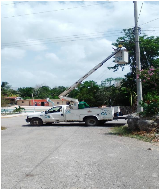
YALCHEN , SE REHABILITA DE LAMPARA Y BALASTRO OV-15 (TIPO AM-175W Y BALASTRO AM-175W).
