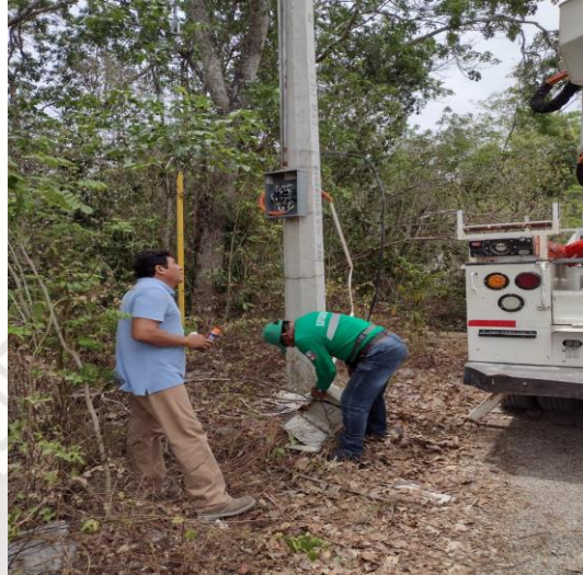
COL. TUBEN KA, C. RIO MINERO / ZANAPA Y ROSARIO, SE REHABILITO CENTRO DE CARGA INACCESIBLE.
