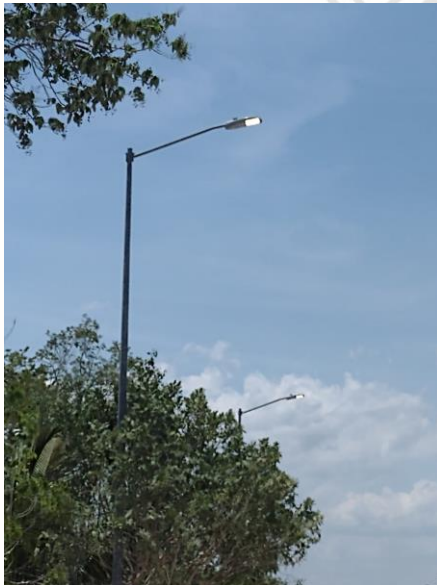
FRANCISCO UH MAY, SE INSTALO CONTACTOR QUE SE ENCONTRABA QUEMADO (CONTACTOR REUTILIZADO).
