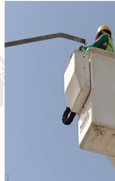
COL.YAAX TULUM, C. BUGAMBILIA, ETC, REEMPLAZO DE LUMINARIAS OBSOLETAS POR LAMPARAS LED DE 100 W.
