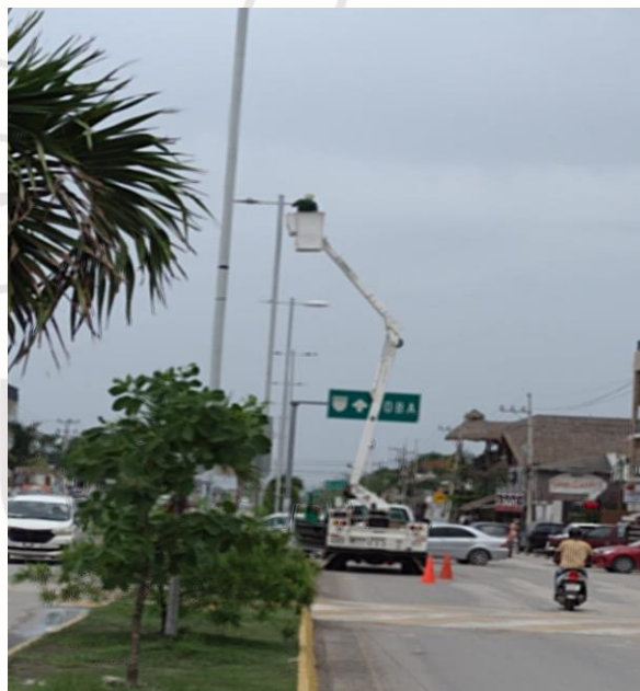
COL. CENTRO, C. SAGITARIO / SATELITE Y CENTAURO, REEMPLAZO DE LUMINARIAS QUEMADAS POR LAMPARAS LED DE 100 W.
