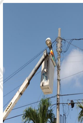
COL.CENTRO, C. ANDROMEDA / OSIRIS SUR, HOLISTICA, ETC, CAMBIO DE FOTOCELDA 220V
