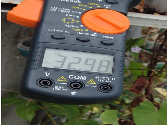
CICLOVIA, AV. SATELITE, PARQUE DOS AGUAS, UNIDAD DEPORTIVA, HOLISTICA, ETC, REALIZACIÓN DE RECORRIDO DE APAGADO DE SECTORES MANUALES
