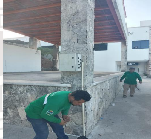
EXPLANADA DE PALACIO, INSTALACION DE GABINETE DE MULTICONTACTOS
