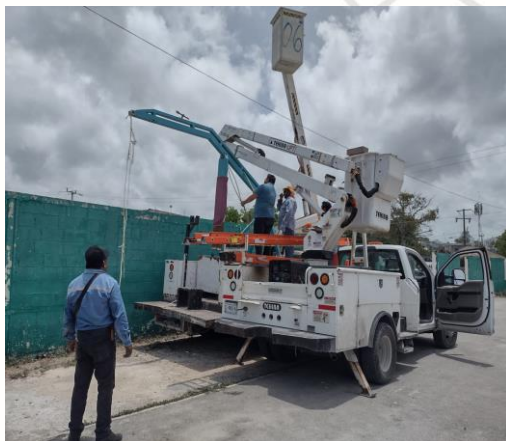
CICLOVIA, AV. SATELITE, PARQUE DOS AGUAS, UNIDAD DEPORTIVA, HOLISTICA, ETC, REALIZACIÓN DE RECORRIDO DE APAGADO DE SECTORES MANUALES.
