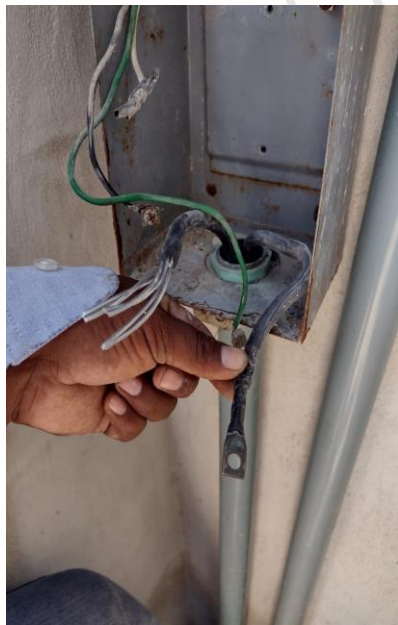
COL. TUBEN KA, / RIO ZANAPA Y MINERO, SE REALIZA LA RECONEXIÓN DE LINEAS SUBTERRANEAS QUE PRESENTABA FALLA.
