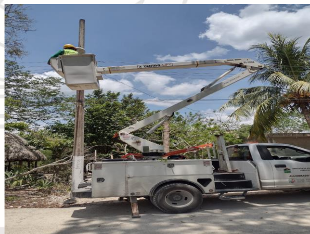
COL. CENTRO, C. ANDROMEDA Y OSIRIS, CAMBIO DE FOTOCELDA 220V
