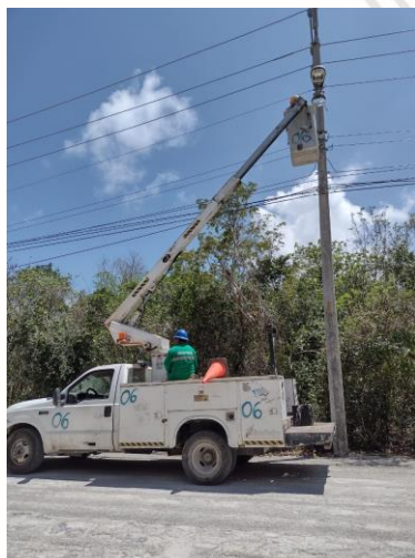
CHAN CHEMUYIL, SE REHABILITA DE LAMPARA Y BALASTRO OV-15 (TIPO AM-175W Y BALASTRO AM-175W)
