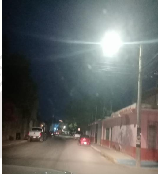
COL. CENTRO, C. SOL / ALFA Y OSIRIS, SE REHABILITA DE LAMPARA LED.
