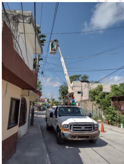
COL. TUBEN KA, C.21 / C.14 Y C.16, SE REHABILITA DE LAMPARA Y BALASTRO OV-15 (TIPO AM-175W Y BALASTRO AM-175W)
