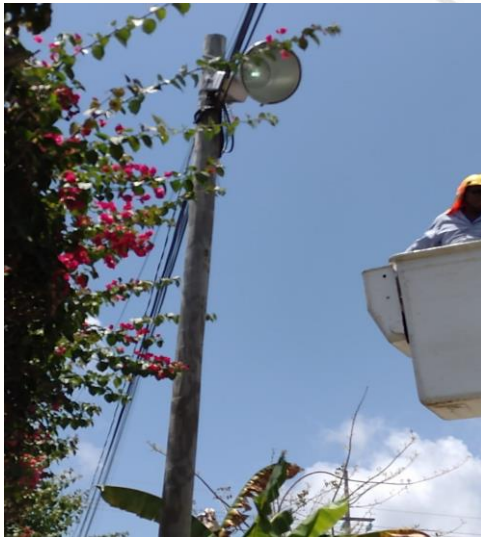
COL. CENTRO, C. SOL / OSIRIS Y ALFA, SE REHABILITAN 2 REFLECTORES (TIPO AM1,000W Y BALASTROS AM1,000W)
