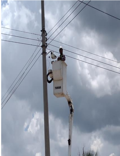
CICLOVIA, AV. SATELITE, PARQUE DOS AGUAS, UNIDAD DEPORTIVA, HOLISTICA, ETC, REALIZACIÓN DE RECORRIDO DE APAGADO DE SECTORES MANUALES
