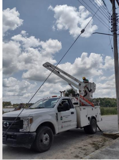
COBA, SE REHABILITA DE LAMPARA Y BALASTRO OV-15 (TIPO AM-175W Y BALASTRO AM-175W).
