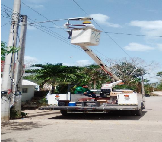
CHAN CHEN PALMAR , SE REHABILITA DE LAMPARA Y BALASTRO OV-15 (TIPO AM-175W Y BALASTRO AM-175W).
