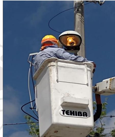
COL. CENTRO, AV. TULUM / C. OSIRIS Y ALFA SUR, SE REHABILITA DE LAMPARA Y BALASTRO OV-15 (TIPO AM-175W Y BALASTRO AM-175W)
