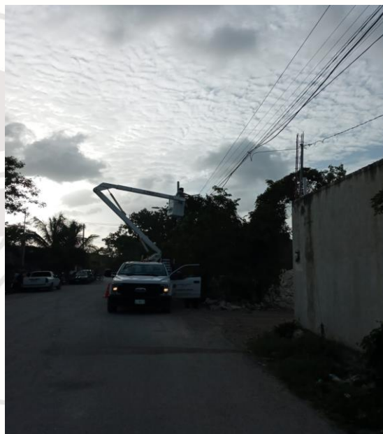
COL. TUBEN KA, C. MINERO ROSARIO Y ZANAPA, CAMBIO DE FOTOCELDA 220V A SECTOR.
