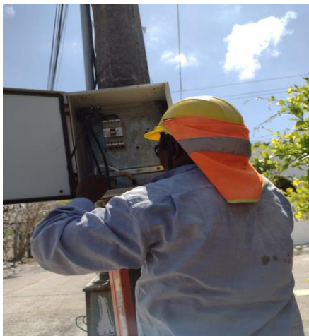
COL.CENTRO, C. PRIVADA / OMEGA, CAMBIO DE FOTOCELDA 220V
