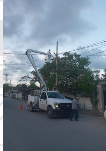
COL. VELETA, AV. TULUM, CAMBIO DE FOTOCELDA 220V
