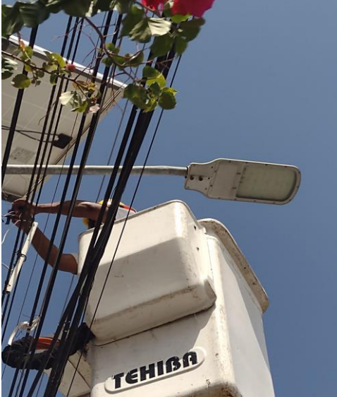
COL. CENTRO, C. OSIRIS Y SOL, REHABILITACION DE BREAK QUE ESTABA PROTEGIDO.
