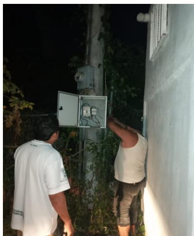
FRAC. VILLAS, CAMBIO DE FOTOCELDA 220V A SECTOR.
