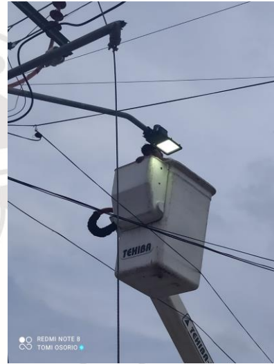
FRANCISCO UH MAY, REEMPLAZO DE LUMINARIAS OBSOLETAS POR LAMPARAS LED DE 100 W.
