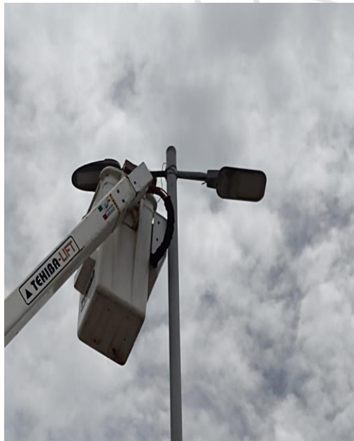
COL. CENTRO, C. OMEGA NTE / 4 Y 2 PTE., REEMPLAZO DE LUMINARIAS QUEMADAS POR LAMPARAS LED DE 100 W.
