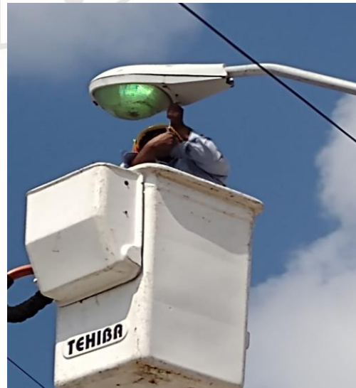
COL. TUBEN KA, C. FAISAN / 10 Y 12, SE REHABILITA DE LAMPARA Y BALASTRO OV-15 (TIPO AM-175W Y BALASTRO AM-175W)
