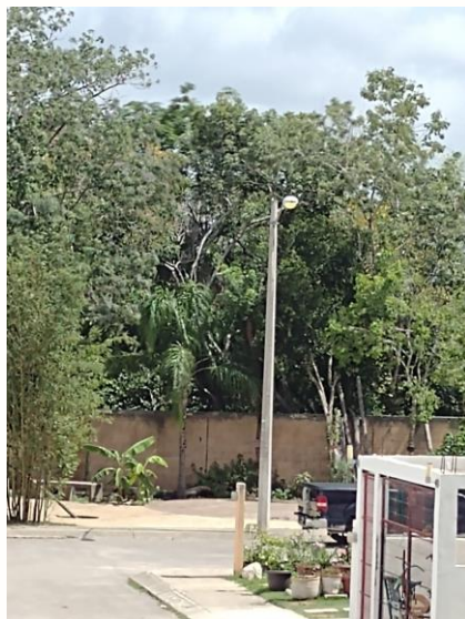
COL. VILLAS, YAAX TULUM / CICLOVIA Y 5TA AV, ETC, REALIZACIÓN DE RECORRIDO DE ENCENDIDO DE SECTORES MANUALES
