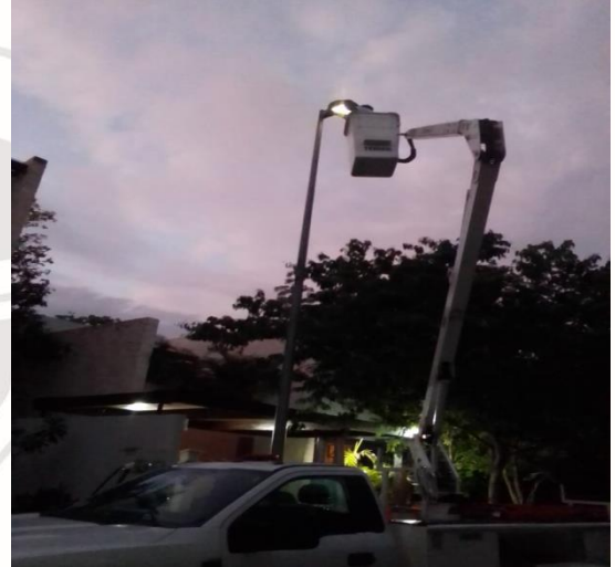
COL. CENTRO, AV TULUM, REHABILITACIÓN DE LAMPARA
