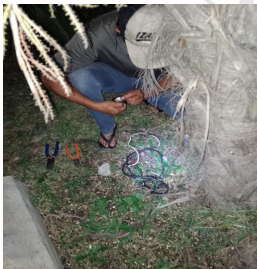
MANUEL ANTONIO AY. REHABILITACIÓN DE FOTOCELDA
