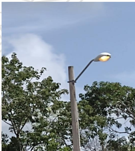
COL. VILLAS, YAAX TULUM / CICLOVIA Y 5TA AV, ETC, REALIZACIÓN DE RECORRIDO DE ENCENDIDO DE SECTORES MANUALES
