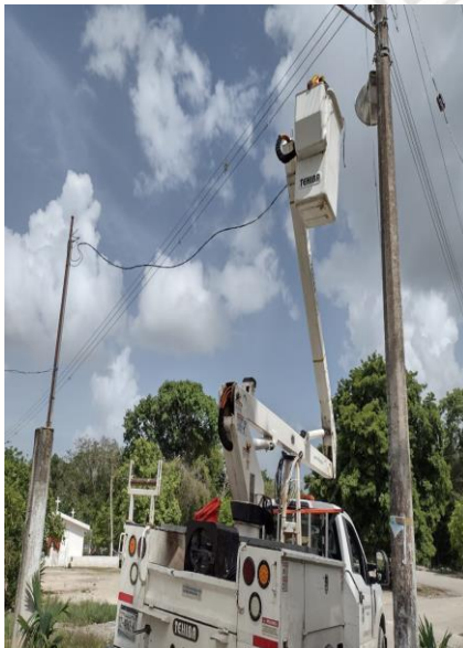
HONDZONOT, RECONEXIÓN DE LINEAS AEREAS EN CAMPO DE BEISBOL
