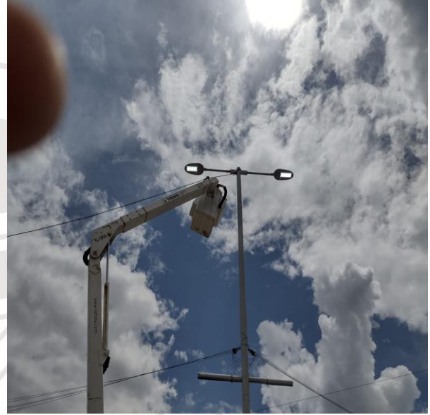
COL. CENTRO, AV TULUM Y BETA, REHABILITACIÓN DE LAMPARA TIPO LED-150W
