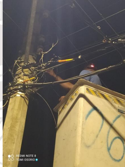
COL. CENTRO, AV TULUM Y CALLE GEMINIS, REHABILITACIÓN DE LAMPARA TIPO LED DE 100W
