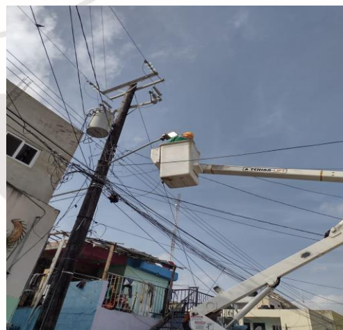
COL. TULUM / AV TULUM, AV COBA Y GEMINIS, REHABILITACIÓN DE LAMPARA TIPO LED-150W
