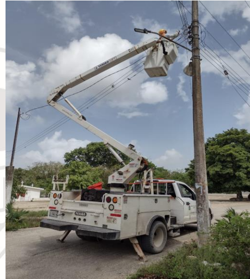
HONDZONOT, REHABILITACIÓN DE LAMPARA TIPO LED 100W
