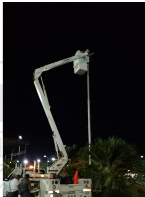
MANUEL ANTONIO AY. REHABILITACIÓN DE BASE DE FOTOCELDA
