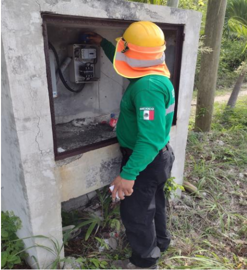
AKUMAL PUEBLO, REHABILITACIÓN DE BASE DE MEDIDOR
