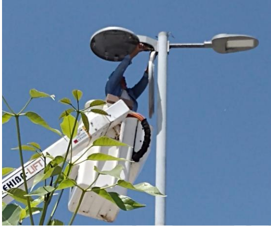
CASA DE LA CULTURA, REHABILITACIÓN DE LAMPARA
