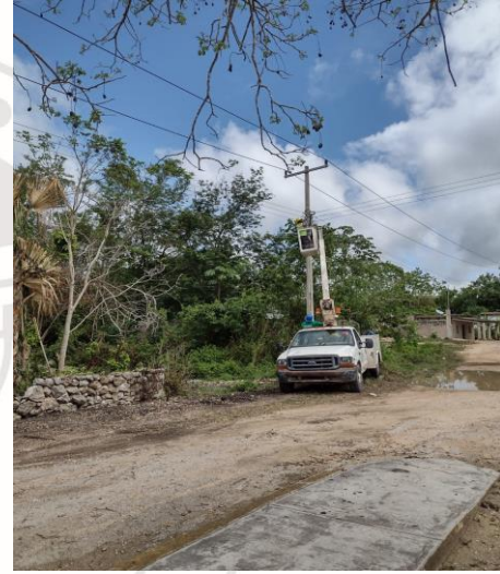
HONDZONOT, REHABILITACIÓN DE REFLECTOR TIPO LED.
