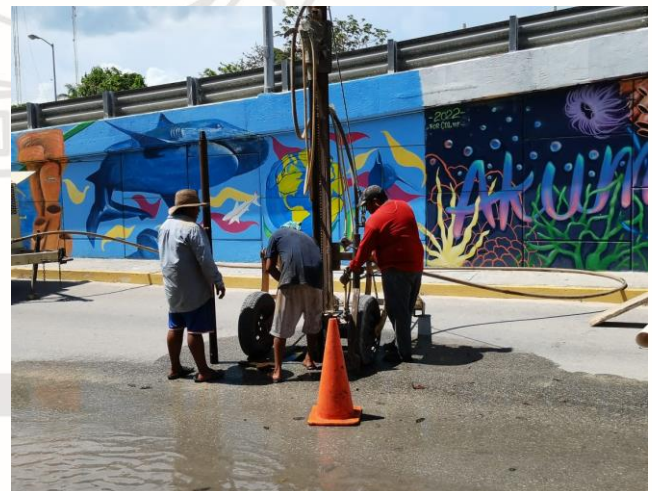
AV. GONZALO GUERRERO Y CARRETERA FEDERAL AKUMAL PUEBLO.
