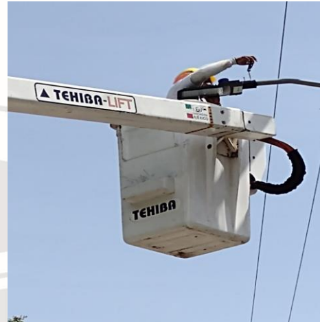
COL. TUMBENKA, REHABILITACIÓN DE LAMPARA TIPO LED 100W
