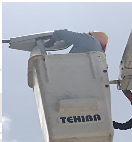
COL. YAAX TULUM, CALLE TULIPAN / AZUCENA Y MARGARITA, SE REHABILITA LAMPARA OV-15 (TIPO AM-175W Y BALATRO AM-175W)
