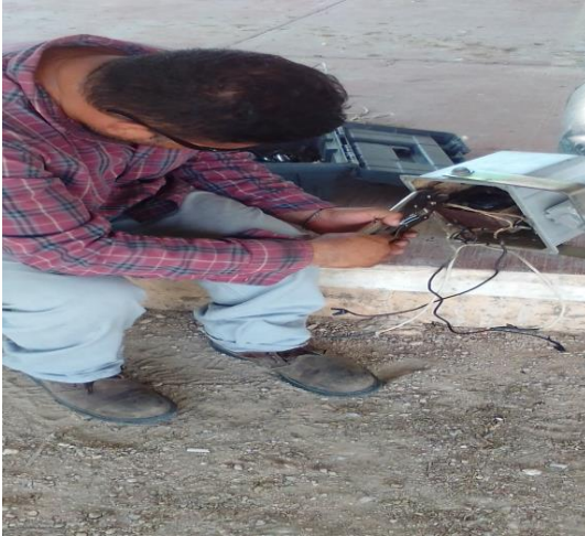
CHEMUYIL, REHABILITACIÓN DE FOTOCELDA DAÑADAS TIPO (220V)
