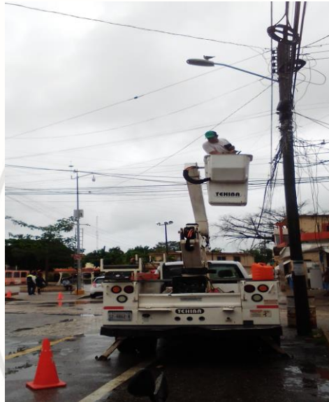
COL. CENTRO / ACUARIO SUR Y CALLE SOL PTE, APOYO PARA RECONEXIÓN DE ACOMETIDA DE CAMARAS C-5
