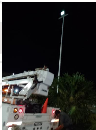
UNIDAD DEPORTIVA, SE COLOCA UNA PASTILLA DE 65APR, POR ENTREGA DE OBRA
