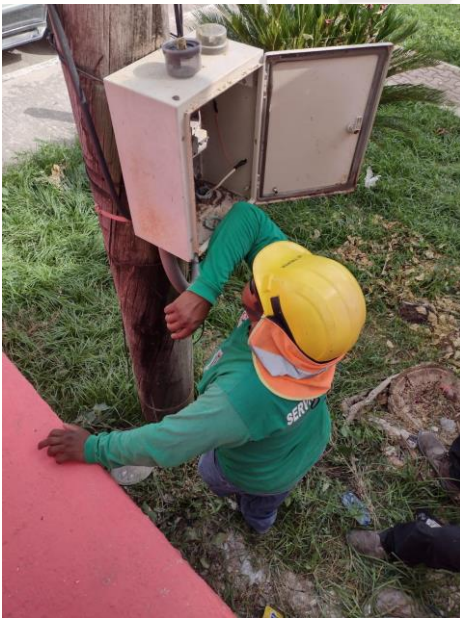
AKUMAL PUEBLO, RECONEXIÓN DE LINEAS SUBTERRANEAS DEL CALIBRE 6
