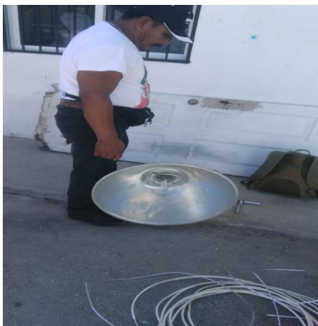
COL. CENTRO, CALLE CANCER Y SAGITARIO. REHABILITACIÓN DE REFLECTOR
