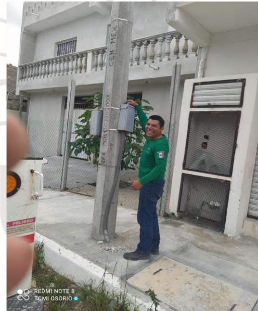
COL. TUMBENKA, RECONEXIÓN DE LINEAS SUBTERRANEAS.
