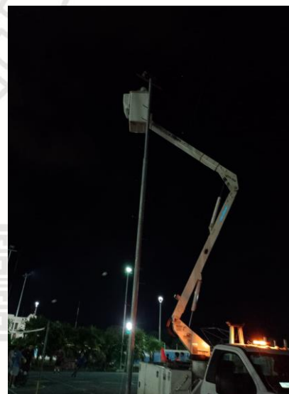
UNIDAD DEPORTIVA. REHABILITACIÓN DE LAMPARA Y BALASTRO TIPO (AM-175)
