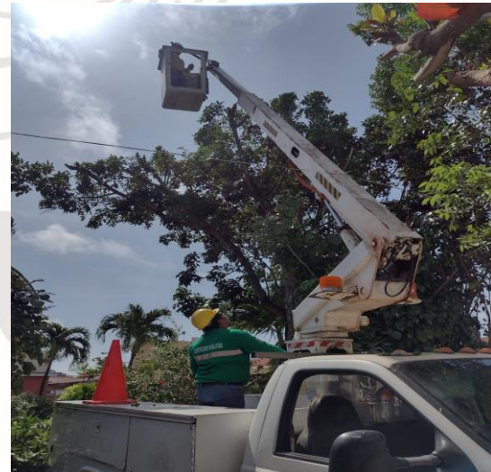
MANUEL ANTONIO AY, REHABILITACIÓN DE LAMPARA (AM-175 Y BALASTRO AM-175)
