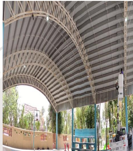
COL. TUMBENKA, AV 18 (PARQUE TUMBENKA), REHABILITACIÓN DE REFLECTOR TIPO LED DE 200W
