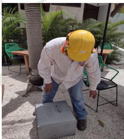
AV. TULUM / CICLOVIA Y AV COBA, RECONEXIÓN DE LINEAS SUBTERRANEAS
