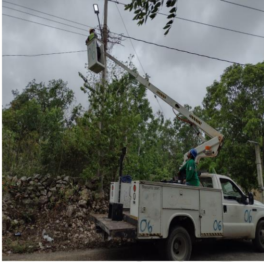
HONDZONOT, REHABILITACIÓN DE LAMPARA TIPO LED (100WTS).
