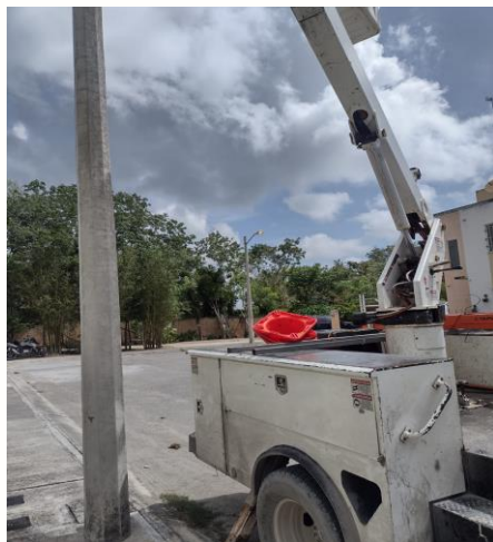
COL. LA VELETA, REHABILITACIÓN DE FOTOCELDAS QUE ESTABAN QUEMADOS
