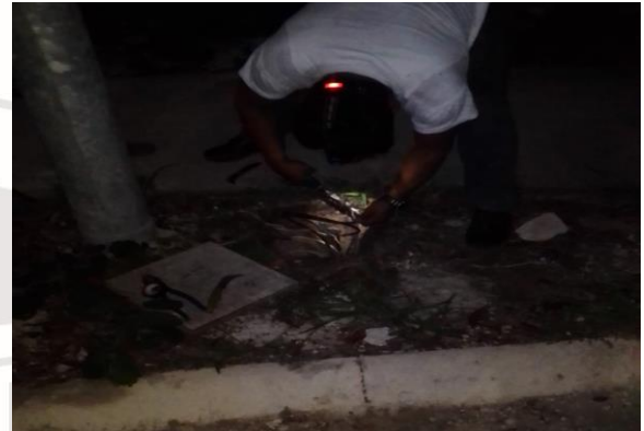
CHACMOL, KUKULKAN Y CHANCHEN. RECONEXIÓN DE LINEAS SUBTERRANEAS QUE SE ENCONTRABAN SULFATAS
