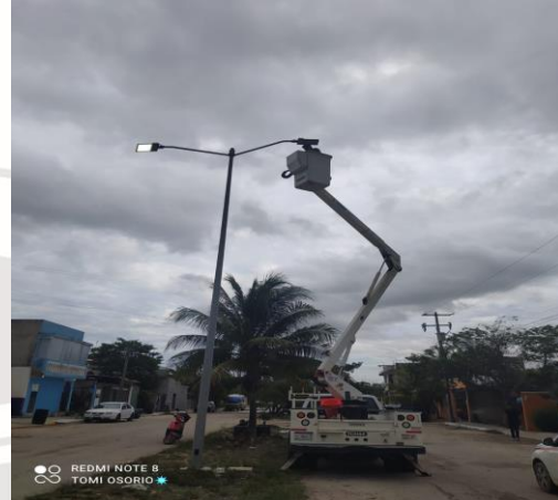
COL. TUMBENKA / AV. 18 Y CALLE FAISAN, SE REUBICARON LAMPARAS TIPO LED.
