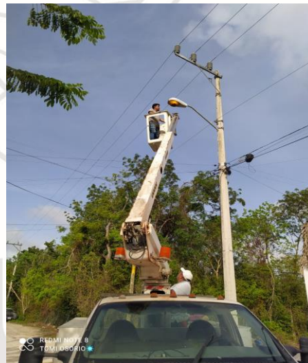
COL. TUMBENKA, REHABILITACIÓN DE LAMPARA TIPO OV-15 (AM-175)
