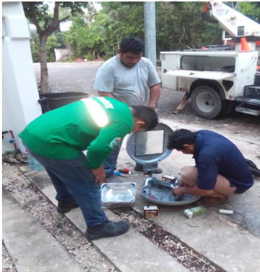
EJIDO, SIAN KAN, REHABILITACIÓN DE FOTOCELDA
