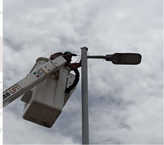
COL. CENTRO, AV TULUM Y AV SATELITE. REUBICACIÓN DE LAMPARA (LED-150)
