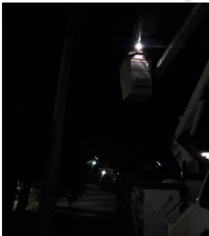
COL. CENTRO, ORION Y 2 OTE. REHABILITACIÓN DE LAMPARA TIPO AM-175.
