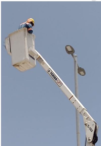
COL. VELETA, CALLE 7, REHABILITACIÓN DE LAMPARA TIPO LED-150W
