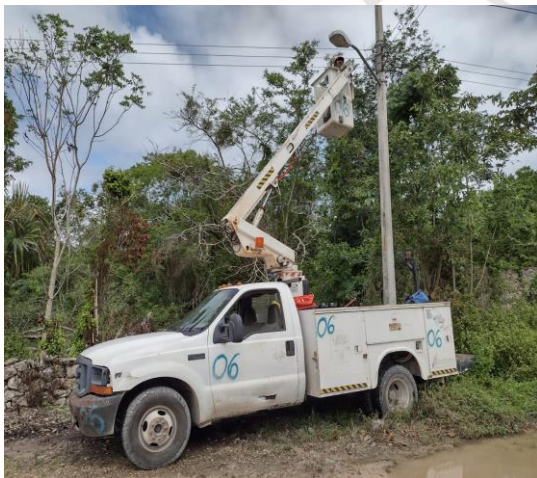
HONDZONOT, REHABILITACIÓN DE LAMPARA Y BALASTRO TIPO OV-15 (AM-175W Y BALASTRO TIPO AM-175W).
