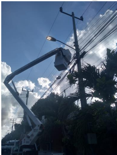
COL TUMBENKA, CALLE 17 /- AV 18. REHABILITACIÓN DE LAMPARA DE 150W
