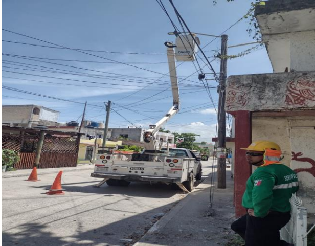
COL. CENTRO, HOLISTICA, CICLOVIA, AV SATELITE, UNIDAD DEPORTIVA, ETC, REALIZACIÓN DE RECORRIDO DE ENCENDIDO DE SECTORES MANUALES
