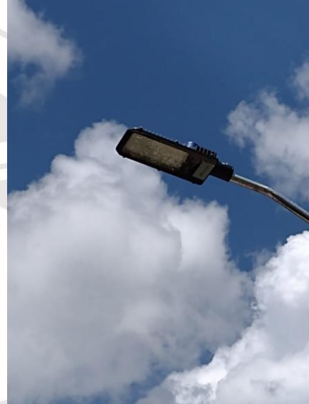
UNIDAD DEPORTIVA, REHABILITACIÓN DE LAMPARA TIPO LED-100W
