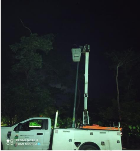
COL. CENTRO, AV TULUM Y AV SATELITE, REHABILITACIÓN DE LAMPARAS TIPO LED- 150W
