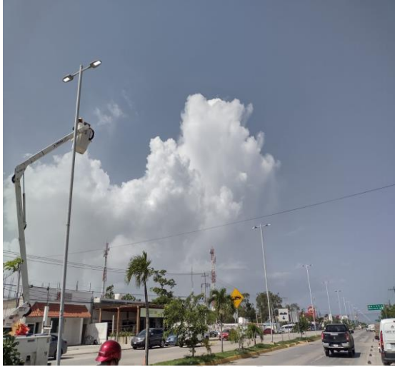
COL. CENTRO, AV TULUM / CALLE LIBRA Y ESCORPION, REHABILITACIÓN DE LAMPARA TIPO LED-150W
