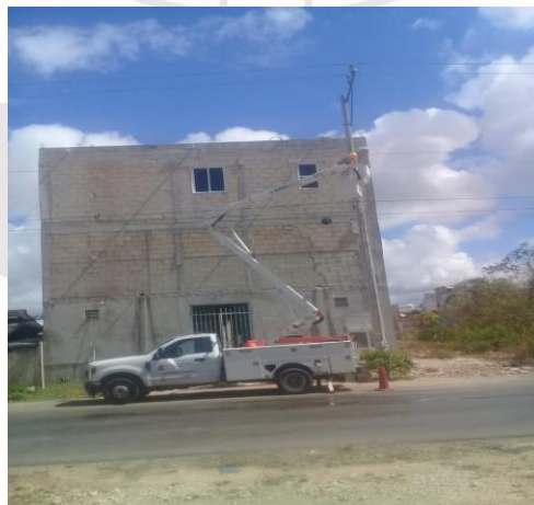
CICLOVIA, AV. SATELITE SUR, PARQUE 2 AGUAS, UNIDAD DEPORTIVA, AV 5 SUR, ETC, REALIZACIÓN DE RECORRIDO DE APAGADO DE SECTORES MANUALES
