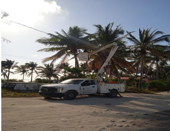
PUNTA ALLEN, SE REHABILITA LAMPARA OV-15 (TIPO AM-175W Y BALATRO AM-175W)
