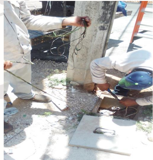
AKUMAL , RECONEXION DE LINEAS SUBTERRANEAS QUE PROVOCAN CORTO CIRCUITO
