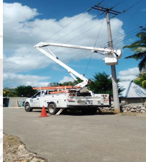
SAN SILVERIO, SE REHABILITA LAMPARA OV-15 OBSOLETAS, CON LAMPARA LED DE 100 WATTS
