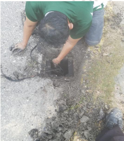
COL. YAAX TULUM , RECONEXION DE LINEAS SUBTERRANEAS QUE ESTABA DAÑADO
