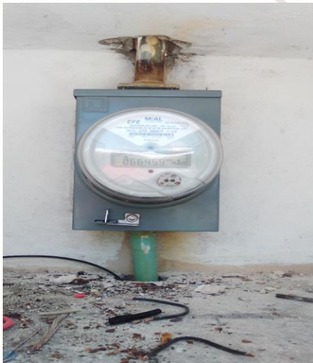
AKUMAL , SE REHABILITA MEDIDOR DAÑADO CAMBIANDO BASE Y CENTRO DE CARGA
