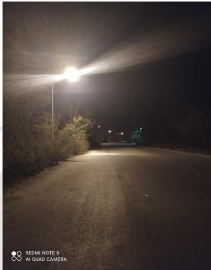
COL. YAAX TULUM, CALLE TULIPAN / AZUCENA Y MARGARITA, SE REHABILITA LAMPARA OV-15 (TIPO AM-175W Y BALATRO AM-175W)
