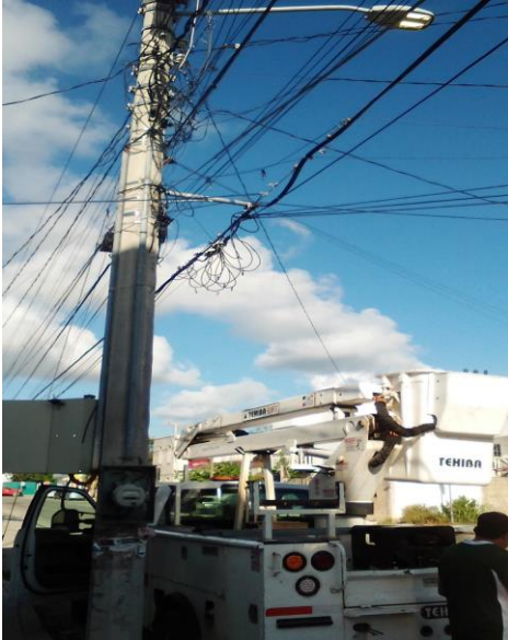
COL. MAYA PAX, C. TUNKUL / ALFA NTE., ETC, RECONEXION DE LINEAS AEREAS QUE PROVOCABAN CORTO CIRCUITO
