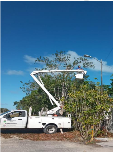
COL. TUBEM KA, REHABILITACIÓN DE LAMPARA OV-15 OBSOLETAS, CON LAMPARA LED DE 100 WATTS.
