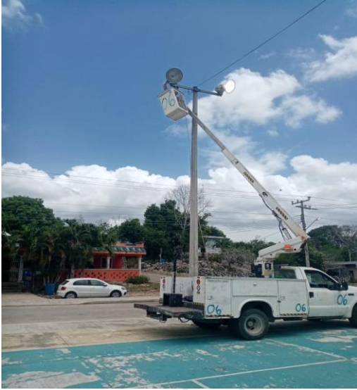
SAN SILVERIO, SE REHABILITAE REFLECTOR DE 1000 WATTS
