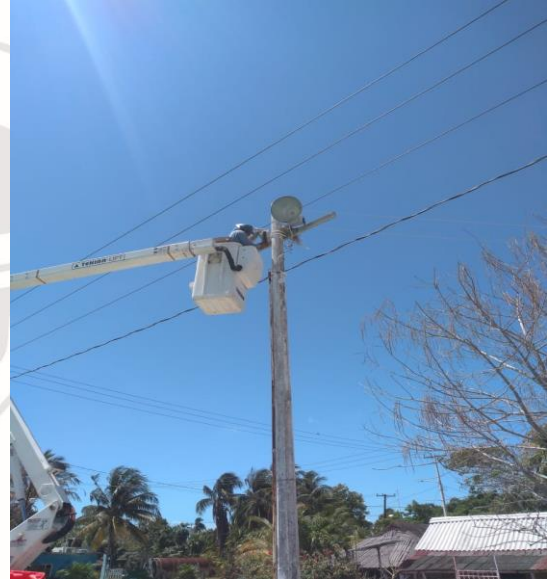
PUNTA ALLEN, SE REHABILITAN REFLECTORES (TIPO AM1,000W Y BALASTROS AM1,000W)
