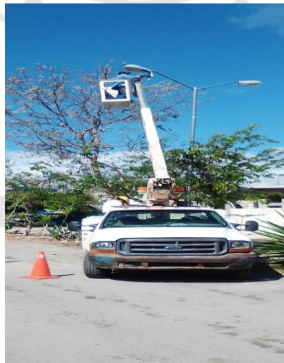
AV. TULUM, SE REHABILITA LAMPARAS Y BALASTROS OV-15 (TIPO AM-175W Y BALASTRO AM-175W).
