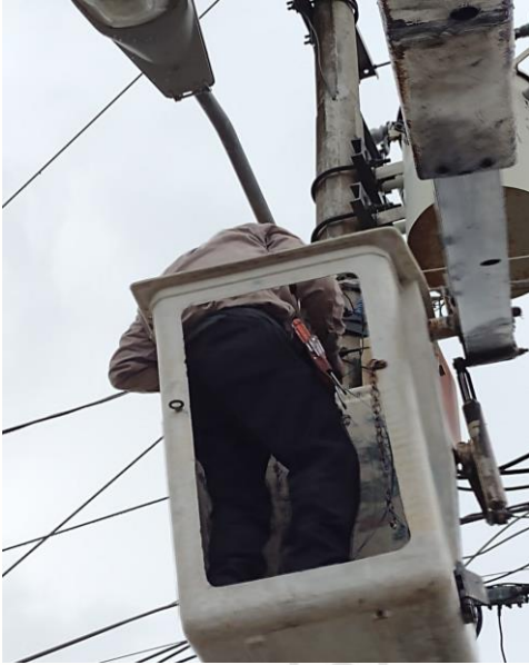
COL. CENTRO, AV. TULUM / ALFA Y JUPITER, REHABILITACIÓN DE LAMPARA OV-15 OBSOLETAS, CON LAMPARA LED DE 100 WATTS
