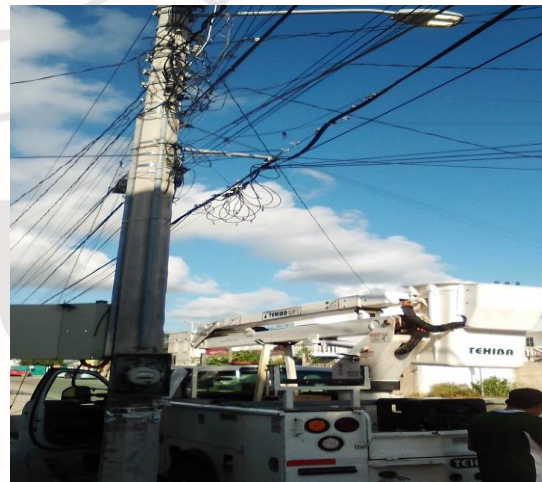
MANUEL ANTONIO AY, REHABILITACIÓN DE LAMPARA SOL (TIPO AM-1000W Y BALASTRO AM- 1000W)
