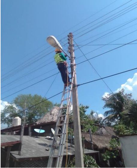
FRAC. GUERRA DE CASTA C. BUBULEK / ESCORPION, SE REHABILITAN LINEAS REVENTADAS
