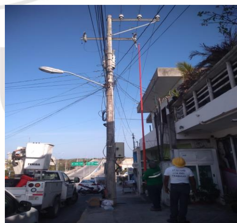
AKUMAL PUEBLO, REHABILITACION DE FUSIBLE QUEMADO DE 5 AMP
