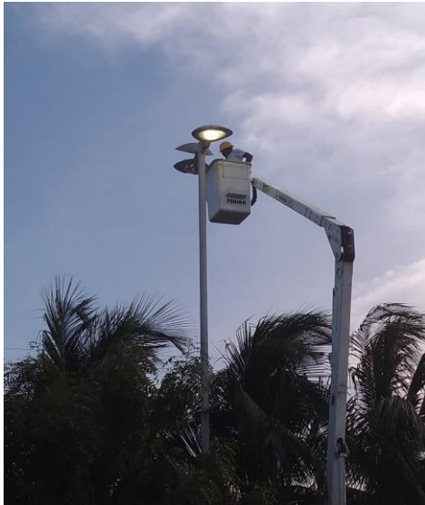
CICLOVIA, AV. SATELITE SUR, PARQUE 2 AGUAS, UNIDAD DEPORTIVA, AV 5 SUR, ETC, REALIZACIÓN DE RECORRIDO DE APAGADO DE SECTORES MANUALES.
