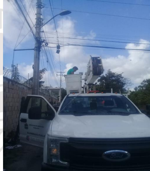
COL. CENTRO C.2 OTE/ ORION, REHABILITACIÓN DE LAMPARA OV-15 OBSOLETAS, CON LAMPARA LED DE 100 WATTS
