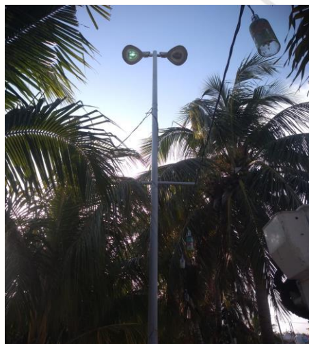
COL. TUMBEN KA, CALLE 18 / FAISAN, RECONEXIÓN DE LINEAS AEREAS AL MEDIDOR PARA ACTIVAR REFLECTORES
