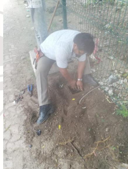
COL. LAKIN, AV. COBA SUR / CICLOVIA, ETC, RECONEXION DE LINEAS SUBTERRANEAS SULFATADAS
