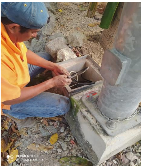
LA-KIN, CALLE NEPTUNO / AV. SATELITE, RECONEXIÓN DE LINEAS SULFATADAS A LAMPARA DE 30MTS UNIPOLAR CALIBRE 10
