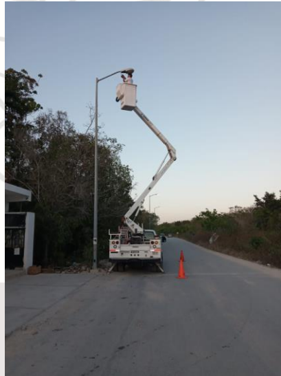
TUMBEN KAA, AVENIDA LA SELVA, REHABILITACIÓN DE LAMPARA OV-15 (TIPO AM-175W Y BALASTRO AM-175W)
