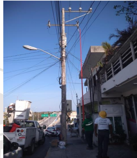
AKUMAL PUEBLO , SE REHABILITA DE LAMPARA Y BALASTRO OV-15 (TIPO AM-175W Y BALASTRO AM-175W)
