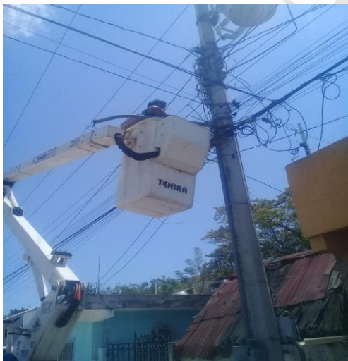
COL. EJIDO, C. CHUN YAXCHE / FAISAN, RECONEXIÓN DE LINEAS AEREAS DAÑADAS
