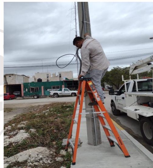
TUBEN KA. AV 1 / AV. 18, RECONEXION DE LINEAS AEREAS SULFATADAS, CON CABLE TIPO ALUMINIO.
