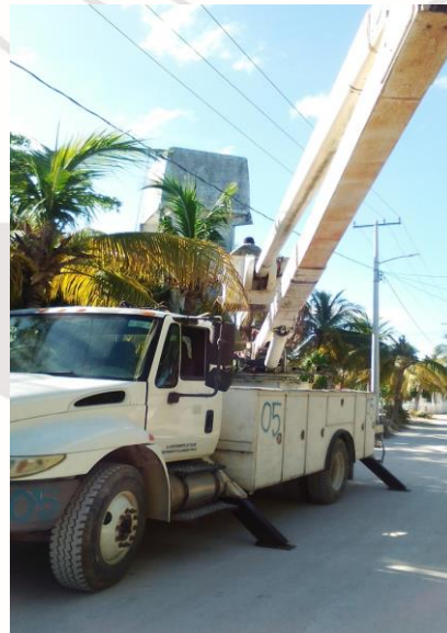
PUNTA ALLEN, SE REHABILITAN REFLECTORES (TIPO AM1,000W)
