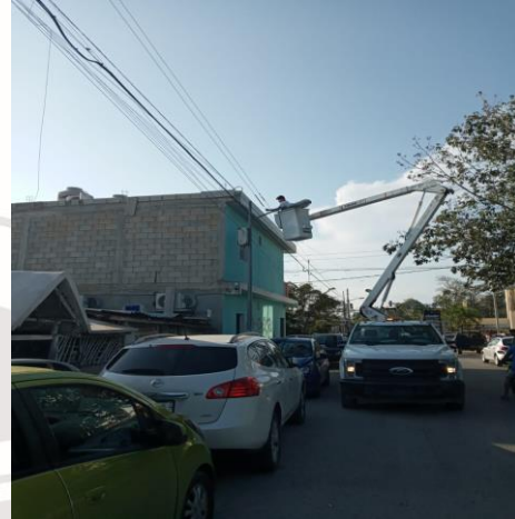
COL. MAYAPAX, RECONEXION DE LINEAS AREAS DAÑADOS
