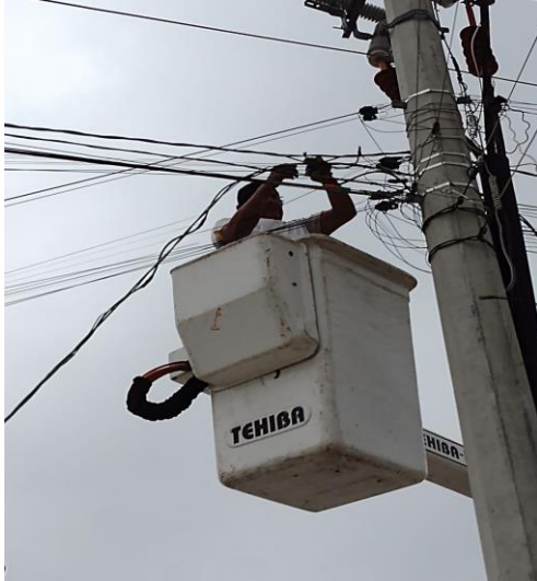
CHAN CHEMUYIL , RECONEXIÓN DE LINEAS AERÉAS QUE SE ENCONTRABAN REVENTADOS
