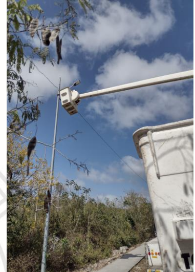
COL. YAAX TULUM, CALLE AZUCENA / TULIPAN Y CLAVEL, SE REHABILITA LAMPARA OV-15 (TIPO AM-175W Y BALATRO AM-175W)
