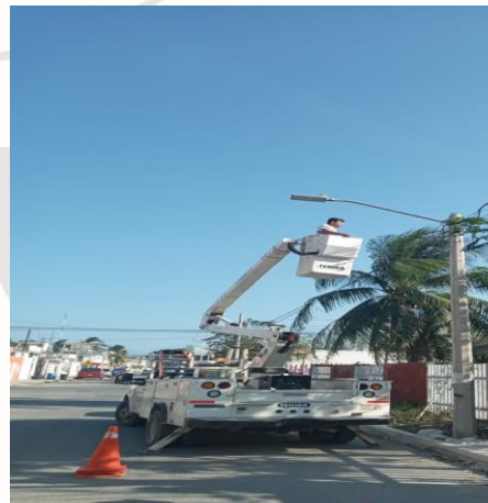
COL. YAAX TULUM, C. LIRIO / 20 NTE., REHABILITACIÓN DE LAMPARA OV-15 (TIPO AM- 175W Y BALASTRO AM-175W)
