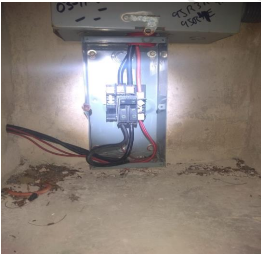
COL. LAKIN, AV. COBA SUR, SE REHABILITO UN BREAK DE 50 AMPERES QUE SE ENCONTRO QUEMADO POR UNO DE 100 AMPERES
