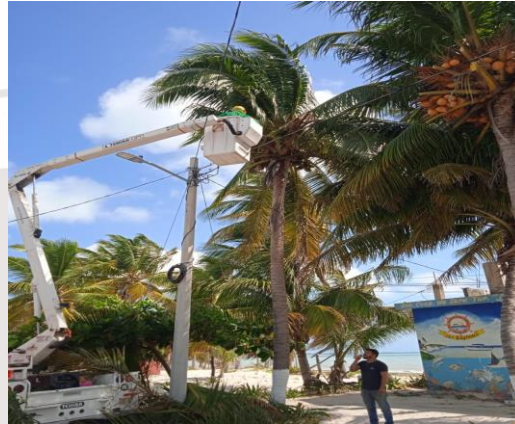
PUNTA ALLEN, SE REHABILITA LAMPARA LED DE 73WTS CON FOTOCELDA 220V
