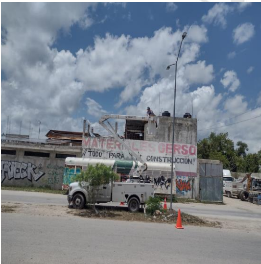
COL. TUBEN KA / AV. YODZOOT, REHABILITACIÓN DE LAMPARA OV-15 OBSOLETAS, CON LAMPARA LED DE 100 WATTS
