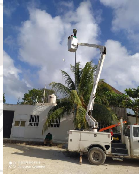
LA-KIN, CALLE NEPTUNO / AV. SATELITE, SE REHABILITO LAMPARA LED DE 73WTS CON FOTOCELDA 220V
