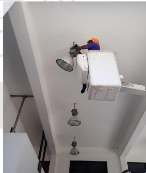
BOMBEROS , REHABILITACIÓN DE LAMPARA OV-15 (TIPO AM-175W Y BALASTRO AM-175W)
