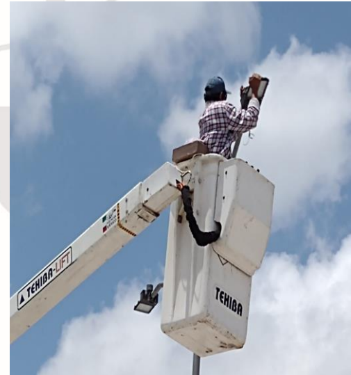
COL. TUBEN KA, AV. 2, AV.18 Y AV.20, REHABILITACIÓN DE LAMPARA OV-15
