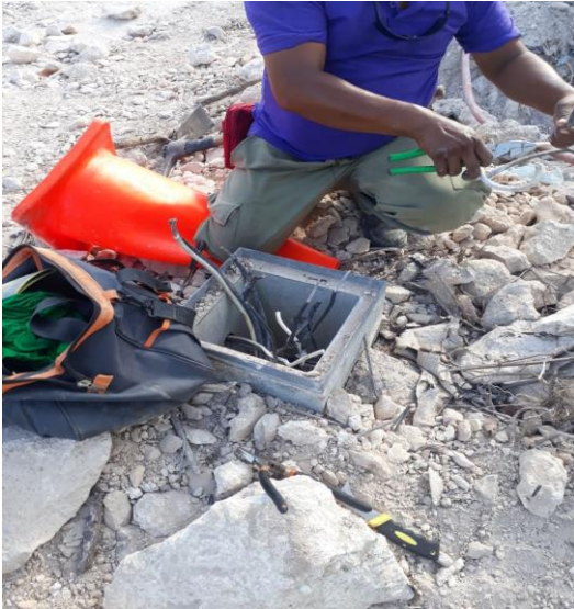
MANUEL ANTONIO AY , RECONEXION DE LINEAS AREAS QUE SE REVENTO POR LA LLUVIA
