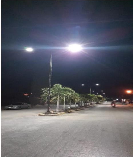
COBA , REHABILITACIÓN DE LAMPARA Y BALASTRO OV-15 (TIPO AM-175W Y BALASTRO AM-175W)
