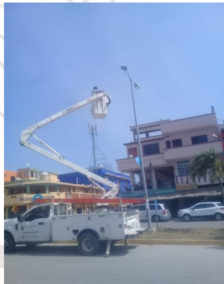
AKUMAL PUEBLO , SE REHABILITA DE LAMPARA OV-15 (TIPO AM-175W Y BALASTRO AM-175W)
