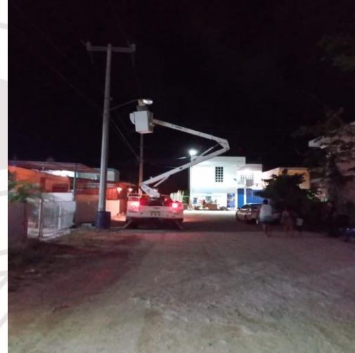
COL. TUBEN KA / AV. 2, REHABILITACIÓN DE LAMPARA OV-15 OBSOLETAS, CON LAMPARA LED DE 100 WATTS.
