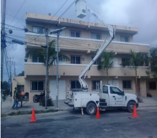
COL. CENTRO, CALLE OSIRIS NTE / POLAR NTE Y SAGITARIO, SE REHABILITA LAMPARA DAÑADA DE DRAIVERS POR LED DE 73W
