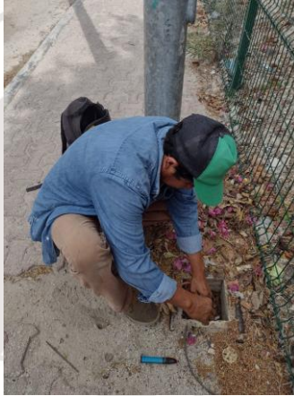
AKUMAL PUEBLO, CICLO VIA, 5 AV, SE REALIZA LA RECONEXIÓN DE LINEAS SUBTERRANEAS QUE SE ENCONTRABAN QUEMADAS
