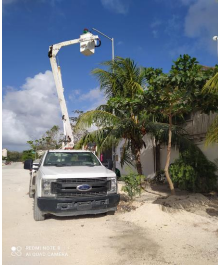
COL. TUMBENKA, CALLE 20 / 23 Y FAISAN, SE REHABILITA LAMPARA OV-15 (TIPO AM-175W Y BALATRO AM-175W)
