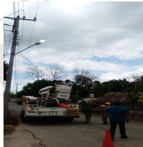
COL. EJIDO, C. CHUN YAXCHE / FAISAN, REHABILITACIÓN DE LAMPARA OV-15 (TIPO AM-175W Y BALASTRO AM-175W)
