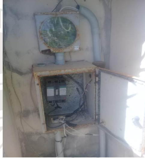
AKUMAL, REHABILITACIÓN DE CAMBIO BASE DE MEDIDOR
