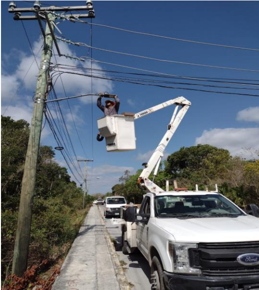
CHEMUYIL, REHABILITACIÓN DE LAMPARA Y BALASTROS OV-15 OBSOLETAS
