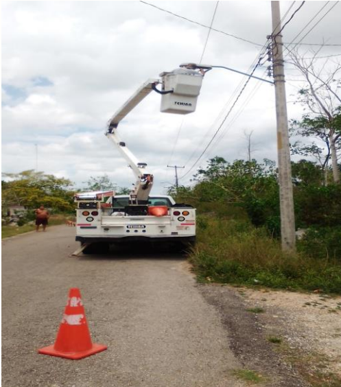
SAN SILVERIO, SE REHABILITACIÓN DE LAMPARA OV-15 (TIPO AM-175W Y BALASTRO AM-175W)
