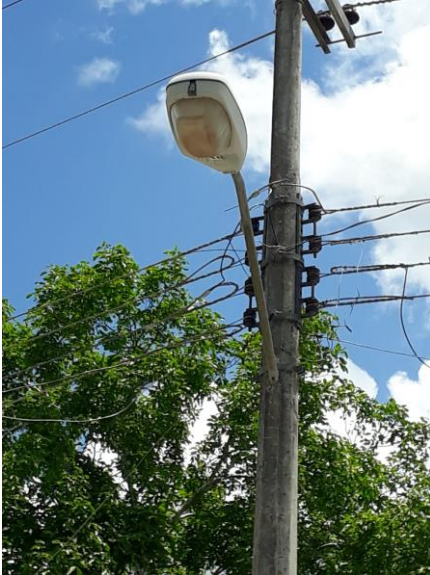
COL. CENTRO, C. BETA / SAGITARIO, SE REHABILITA LAMPARA Y BALASTRO OV-15 (TIPO
