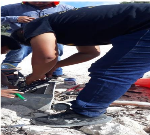
COL. CENTRO, C. AVENIDA COBA RUMBO A LA PLAYA, RECONEXION DE LINEAS SUBTERRANEAS.
