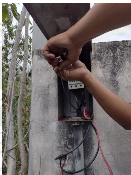
AV. COBA, CICLOVIA RUMBO A LA PLAYA, SE INSTALA UN INTERRUPTOR DE 50 AMPERES
