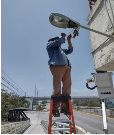
AKUMAL PUEBLO, CICLO VIA, 5 AV, SE REHABILITA LAMPARA OV-15 (TIPO AM-175W Y BALATRO AM-175W)
