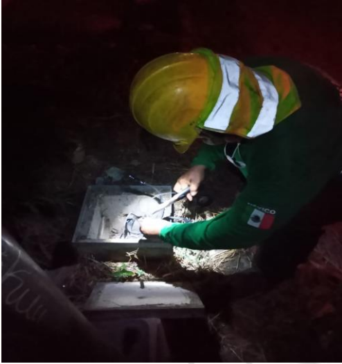
AKUMAL, RECONEXION DE LINEA SUBTERRANEAS.
