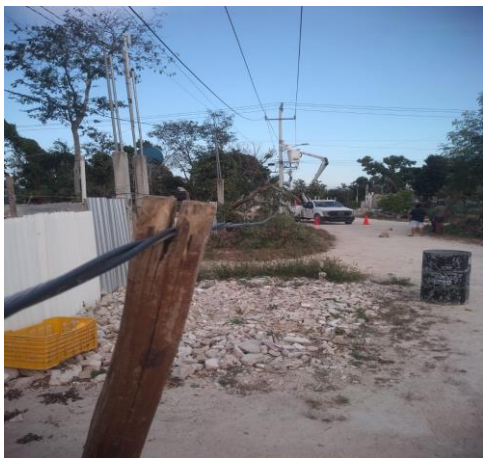
TULUM CENTRO, AV SATELITE, SE CAMBIO DE FOTOCELDA 220V
