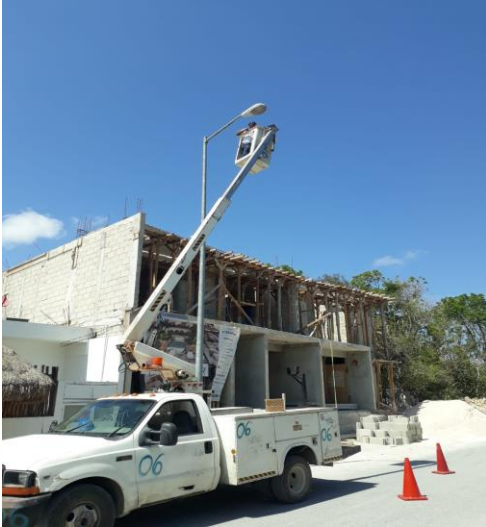
YAAX TULUM, AV. LA SELVA / C. 15 AV. NORTE, REHABILITACIÓN DE LAMPARA OV-15 (TIPO AM-175W Y BALASTRO AM-175W)
