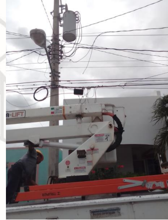
COL. YAAX TULUM, AV SATELITE, UNIDAD DEPORTIVA, ETC, CICLO VIA, REALIZACIÓN DE RECORRIDO PARA EL ENCENDIDO DE SECTORES MANUALES QUE SE ENCONTRABAN QUEMADAS.
