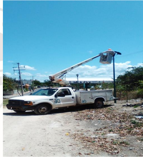
AKUMAL , REHABILITACIÓN DE LAMPARA OV-15 OBSOLETAS, SE CAMBIO CON UNA LAMPARA LED DE 150 WATTS
