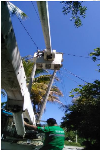
PUNTA ALLEN, SE REHABILITAN LAMPARAS (TIPO AM175W Y BALASTROS TIPO AM175W Y FOTOCELDAS)
