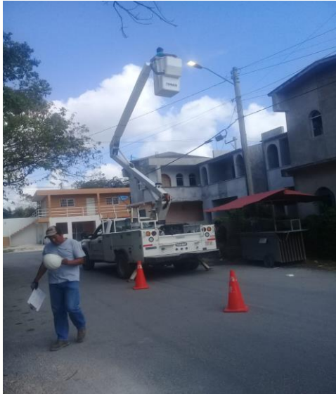
COL. CENTRO C.4 OTE/ ORION, REHABILITACIÓN DE LAMPARA OV-15 OBSOLETAS, CON LAMPARA LED DE 100 WATTS
