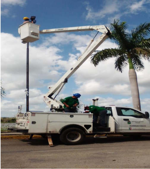
COBA, REHABILITACIÓN DE LAMPARA OV-15 DE 100WT
