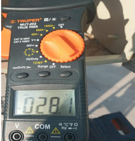
SEGURIDAD PUBLICA, RECONEXION DE LINEAS AEREA QUE PROVOCABAN CORTO CIRCUITO
