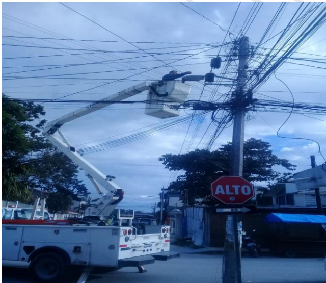
Luminarias apagadas de noche y cambio de fotoceldas dañadas en la colonia Lankin calle Gama con Beta Sur y Neptuno Ote.
