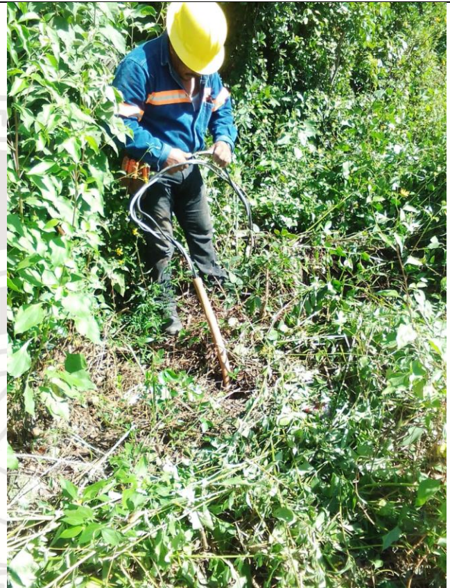
Reconexión de líneas sulfatadas en la colonia Xulka, Sacxiquin-Tzub.
