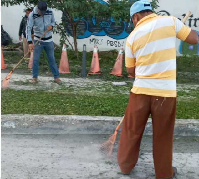
Barrido y limpieza realizada en Av. Tulum ciclovía lateral izquierdo
