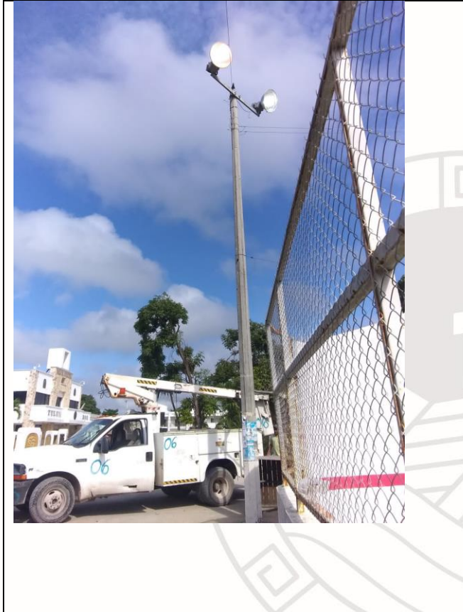
Reparación de reflectores de 1000 watts en cancha de fútbol del parque 2 aguas.
