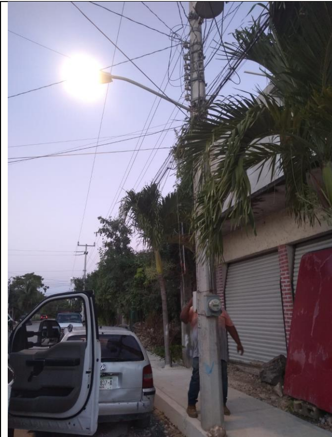
Cambio de fotocelda en la colonia Ejido en calle Sian Kaan entre Golondrinas y Gallinolas.
