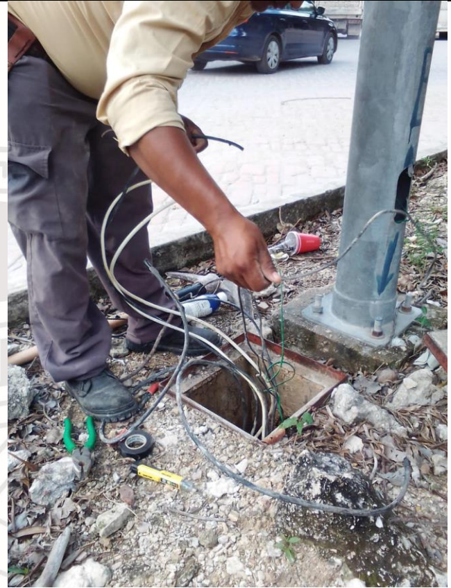
Reparación de líneas subterráneas sulfatadas en la col. Aldea Zama Av. Principal.
