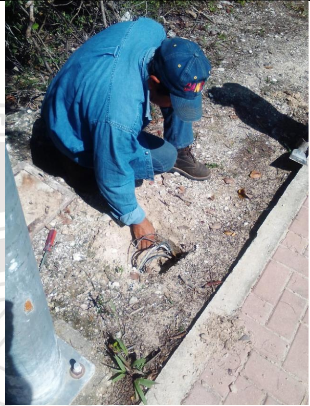
Reparación de líneas subterráneas sulfatadas en Aldea Zama Av. Principal.
