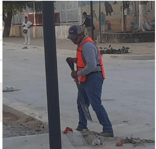
Barrido y limpieza realizada en Av. Osiris
