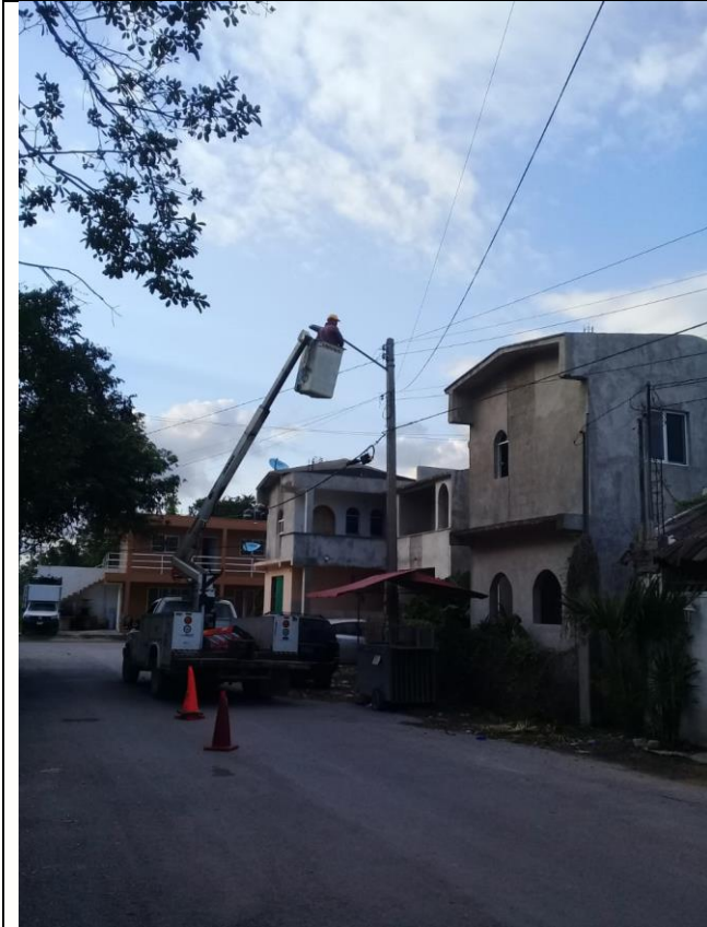
Cambio de fotocelda dañada y reconexión de líneas sulfatadas en la colonia Ejido calle Cocodrilo y Boca Paila.
