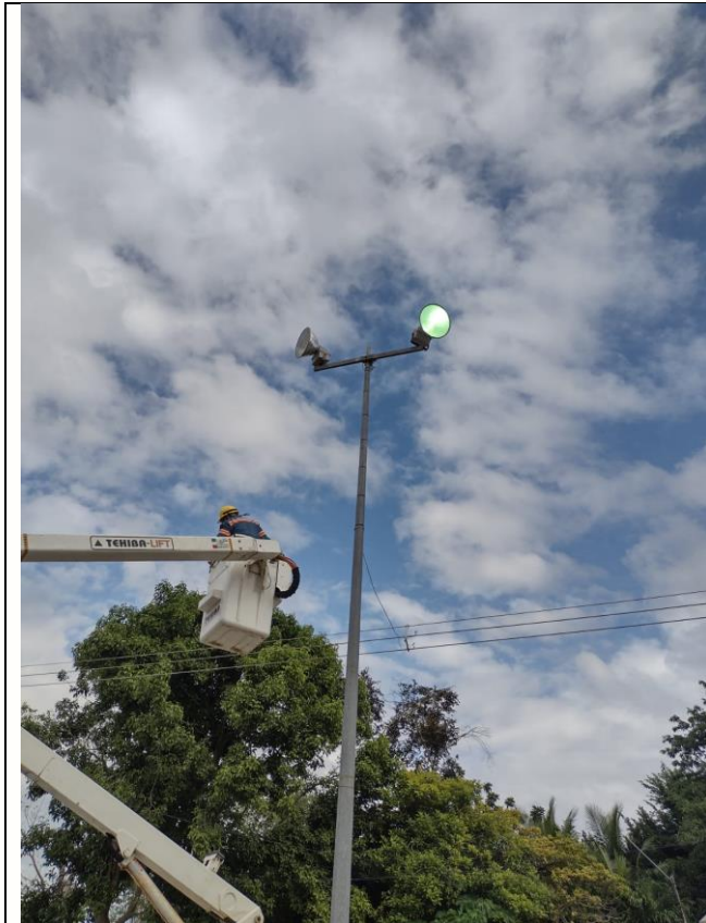
Se reparo los reflectores tipo sol del centro de la comunidad de San Juan.
