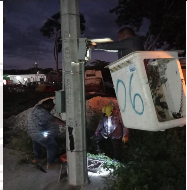
Rehabilitación de sector porque se encontraba quemado; se realizó el servicio se reconexión de líneas principales del y reparación de corto en break y contactor.
