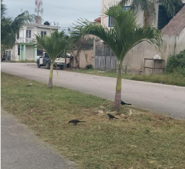
Barrido y limpieza realizada en calle Puut colonia Tumben ka
