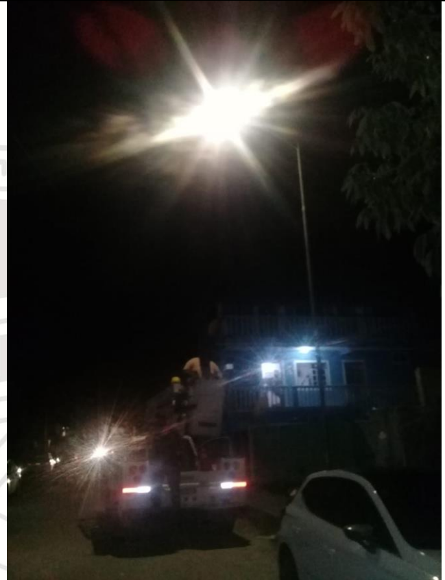
Rehabilitación de luminarias tipo Ov15 en la colonia Tumben Ka, calle Jabón y Oom con Jabín.
