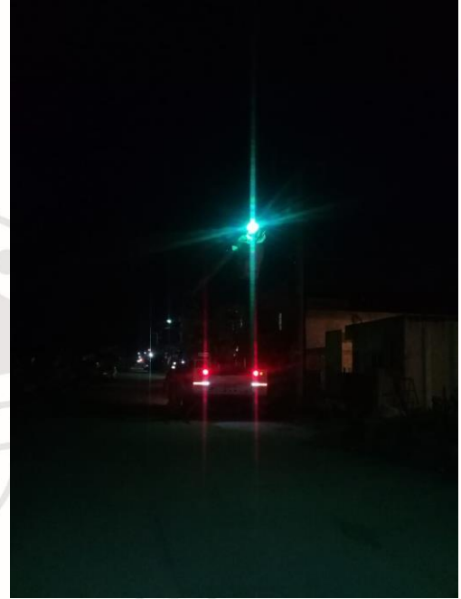
AKUMAL / AV. PRINCIPAL, REHABILITACIÓN DE LAMPARA TIPO SOL AM-1,000W CON BALASTRO TIPO AM-1.000W
