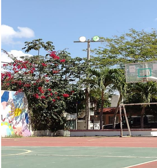
COL. VILLAS TULUM, CALLE 13 Y 4 ORIENTE, REHABILITACIÓN DE REFLECTOR TIPO AM- 400W
