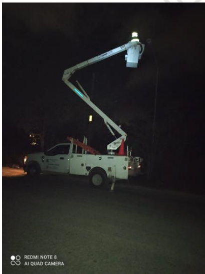
COL. TUMBENKA, CALLE 17 / 26, SE REHABILITAN LAMPARA TIPO OV-15 (TIPO AM-175)
