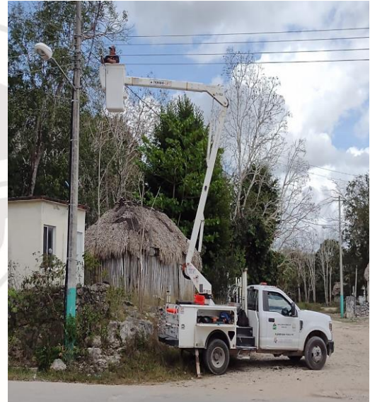
YAXCHE , REHABILITACIÓN DE LAMPARAS (FOCOS TIPO AM-175W, BALASTROS TIPO AM- 175W) (BASES DE FOTOCELDA Y FOTOCELDA DE 220V)
