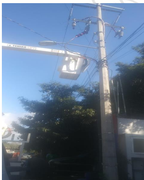
COL. HURACANES, CALLE LIBRA / SOL, SE REHABILITAN LINEAS PARA COMPLEMENTAR RED DE ALUMBRADO Y ACTIVAR LUMINARIA APAGADA. LINEA REUTILIZABLE DE 50MTRS UNI-POLAR CALIBRE 8 COBRE
