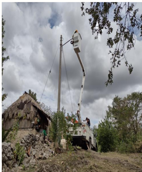
CHANCHEN PALMAR, SE REHABILITAN LAMPARAS OV-15 (FOCOS TIPO AM-175W Y BALASTROS TIPO AM-175W, FOCOS TIPO AM-1000W, BALASTROS TIPO AM.1000W), (FOTOCELDAS 220V Y BASES PARA FOTOCELDA)
