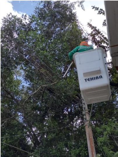
COMUNIDAD DE COBA , SE REHABILITO LAMPARA TIPO OV-15, MAS UNA BASE PARA FOTOCELDA Y FOTOCELDA 220V
