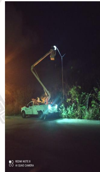
COL. TUMBENKA, AV 1 / 29, SE REHABILITAN LAMPARA TIPO OV-15 (TIPO VS-100W)
