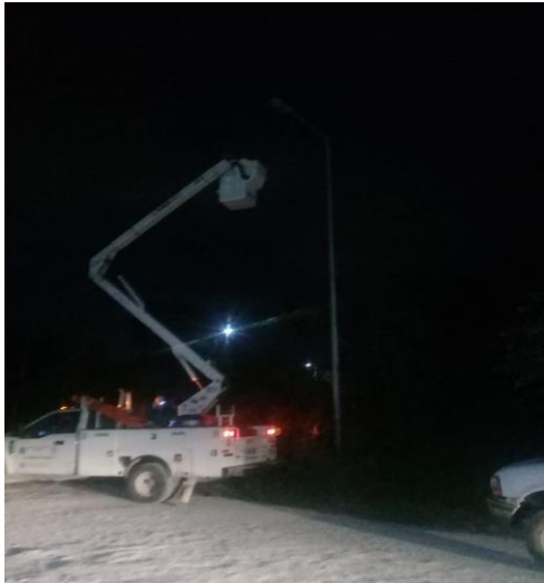
COL. TUMBENKA, YAÁX TULUM, REHABILITACIÓN DE LAMPARAS TIPO OV-15 (AM-175W, BALASTRO TIPO AM-175W)
