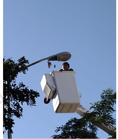
COL. CENTRO, CALLE SAGITARIO / OSIRIS, REHABILITACIÓN DE LAMPARA QUEMADA POR UNA LED DE 73W, MÁS UNA FOTOCELDA DE 220
