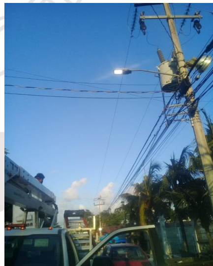
COL. CENTRO AL INTERIOR DE LA UNIDAD DEPORTIVA, COJUDEQ, REHABILITACIÓN DE LINEAS SUBTERRANEAS Y SE TENCIONA CABLE AEREO PARA ACTIVACIÓN DE REFLECTORES DE LA COJUIDFO
