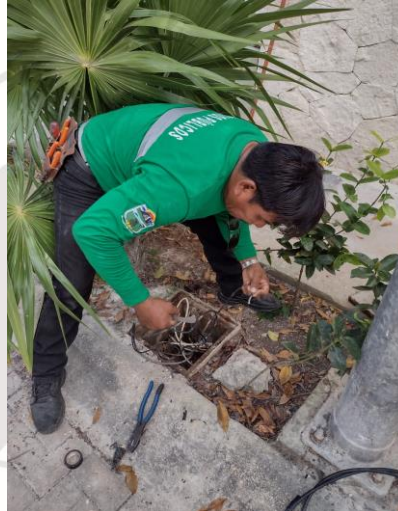
COL. ALDEA ZAMA, REHABILITACIÓN DE LAMPARA TIPO OVN (FOCOS TIPO AM-175W Y BALASTRO AM-175W)
