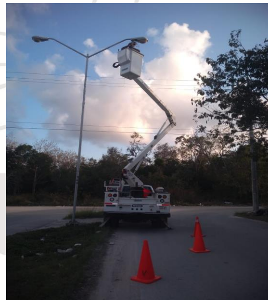
COL. TUMBENKA, AV YODZONOT / 29 Y 27, REHABILITACIÓN DE LAMPARA OV-15 TIPO AM-175W Y BALASTRO TIPO AM-175W Y CAMBIO DE CARCASA
