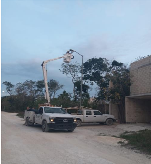
COL. YAAX TULUM, REHABILITACIÓN DE LAMPARAS (SE CAMBIO FOCOS TIPO AM-175W, Y BALASTROS AM-175W)
