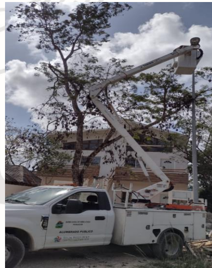
COL. EJIDO, CALLE SIAN KAA / 11 Y 9, REHABILITACIÓN DE FOTOCELDA 220
