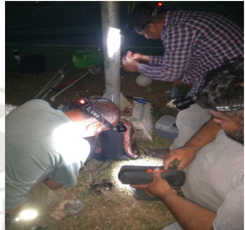
COL. EJIDO, CALLE INTERIOR / UNIDAD DEPORTIVA Y SECUNDARIA CANUL, SE REALIZO LA REPARACIÓN DE LAMPARAS (AM-250W Y BALASTROS AM-250W)
