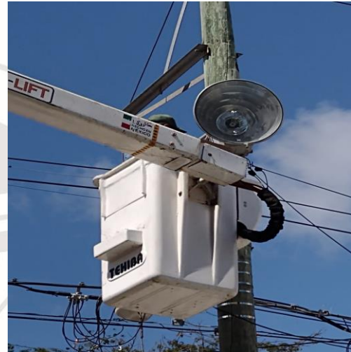
CHEMUYIL, REHABILITACIÓN DE REFLECTOR (AM-1,000W, BALASTROS TIPO AM-1,000W)
