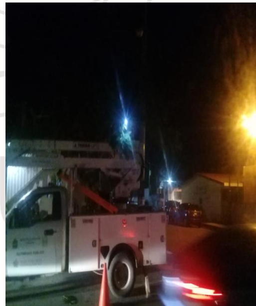
COL. CENTRO, CALLE OSIRIS NTE / 2 OTE Y 4 OTE, REHABILITACIÓN DE LAMPARA TIPO LED OV-15 (AM- 175W Y BALASTRO AM-175W)
