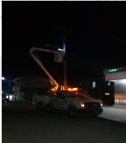
AKUMAL, REHABILITACIÓN DE LAMPARAS (SE USARON FOCOS TIPO AM-175W Y BALASTROS TIPO AM-175W. UNA FOTOCELDA 220V)
