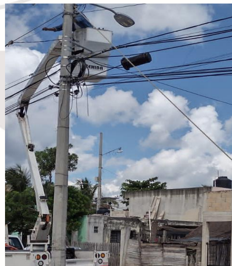
COL. YAX TULUM, CALLE VIOLETA / AV. 15 NTE, (LAMPARA) SE REPARA LAMPARA OV-15, FOCO AM-175W.
