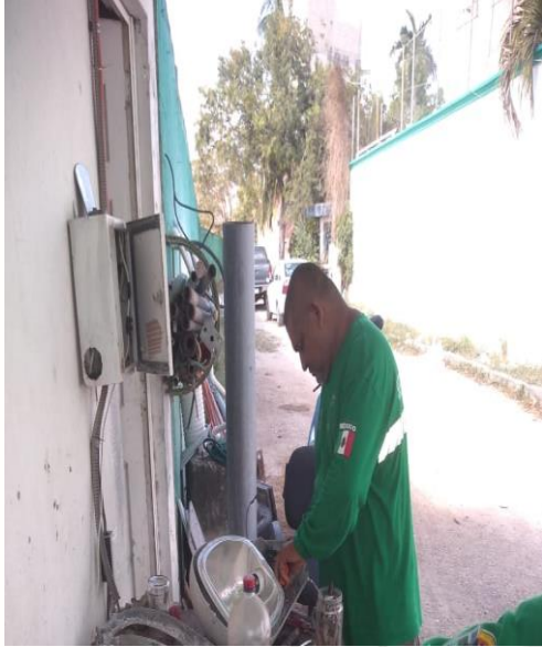
BODEGA DE ALUMBRADO , SE REALIZO LA LIMPIEZA Y MANTENIMIENTO A LAMPARA
