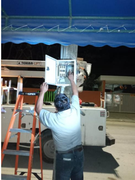
COL. VILLAS TULUM, YAAX TULUM, CICLOVIA, AV 5, REALIZACIÓN DE RECORRIDO DE ENCENDIDO DE SECTORES MANUALES
