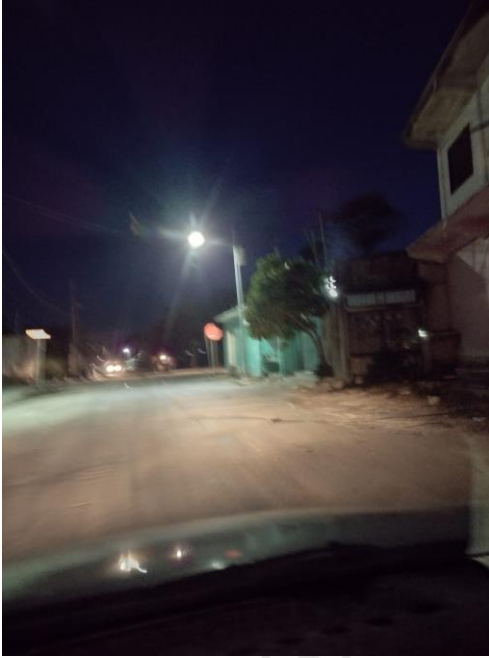
COL. CENTRO, CALLE ALFA SUR / NEPTUNO Y MERCURIO, SE REHABILITA LAMPARA LED SOLAR, MODIFICADAS EN DOS MINI SECTORES
