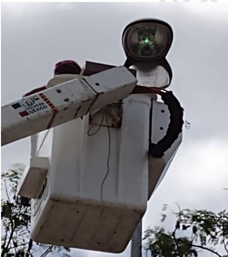
COL. YAAX TULUM, REHABILITACIÓN DE LAMPARA (SE CAMBIO FOCOS TIPO AM- 175W, Y BALASTROS AM-175W)
