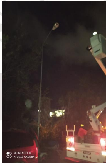
COL. TUMBENKA, CALLE 26 / 15, SE REHABILITAN LAMPARA TIPO OV-15 (TIPO AM-175)
