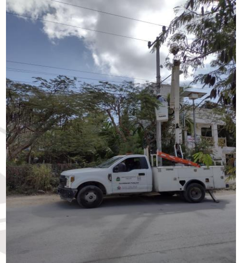
COL. YAX TULUM, CALLE MARGARITA / ORQUIDEA Y 4 NTE, REHABILITACIÓN DE LAMPARA OV-15, FOCOS (TIPO AM-175W Y 6BALASTROS TIPO AM-175W)
