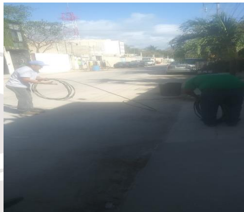
COL. VELETA, CALLE ASUNCIÓN / 7 Y 5, SE REHABILITAN LINEAS PARA FOCO LED DE 73W, CABLE REUTILIZADO DE 6MTRS UNI-POLAR CALIBRE 10
