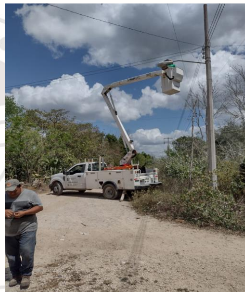
ZONA MAYA (SAN JUAN DE DIOS), SE REHABILITAN LAMPARAS OV-15 (AM-175W Y BALASTROS AM-175W) (BASE PARA FOTOCELDA Y FOTOCELDA 220V) M-175W, MÁS FOTOCELDA 220V)
