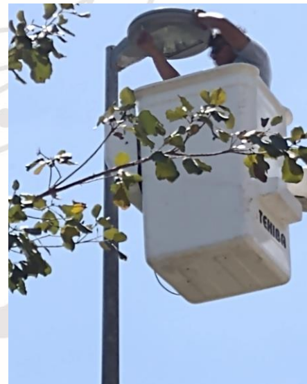
COL. TUMBENKA, AV. LA SELVA / GOLONDRINA Y FAISAN, REHABILITACIÓN DE LAMPARA (TIPO OV-15 CON FOCOS AM-175W Y BALASTROS AM-175W)
