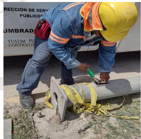
COL. CENTRO, CALLE MERCURIO / SATURNO PONIENTE, MANTENIMIENTO DE FOTOCELDA NUEVA 220V Y UNA BASE DE FOTOCELDA
