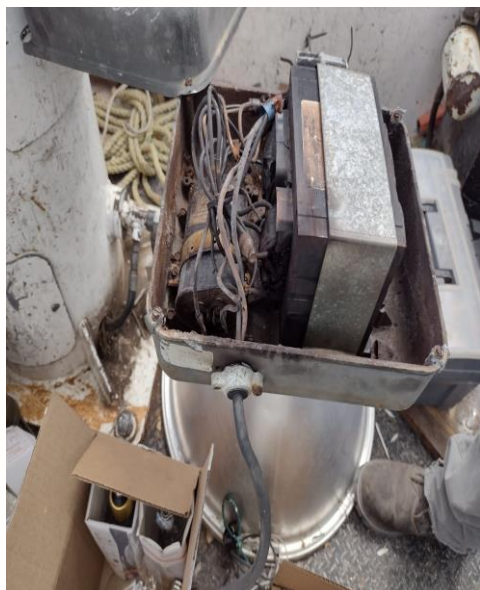
ZONA MAYA (SAN JUAN DE DIOS), REHABILITACIÓN DE REFLECTORES TIPO AM-1,000W
