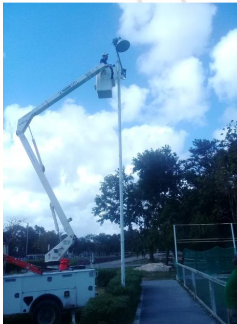
UNIDAD DEPORTIVA (CANCHA DE TENIS), REHABILITACIÓN DE LAMPARAS (AM-1,000W Y BALASTRO AM-1,000W)
