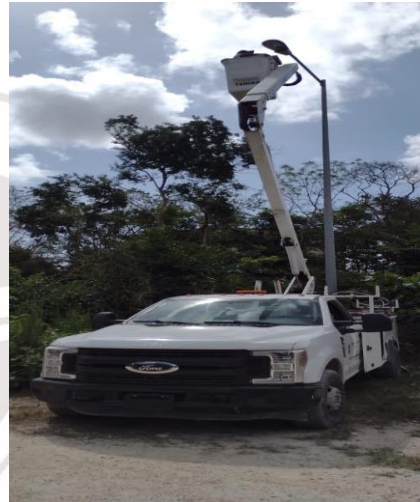
FRACCIONAMIENTO LAS PALMAS, CALLE PALMA NAVIDAD / BULEVARD, REHABILITACIÓN DE LAMPARA (SE CAMBIO FOCO TIPO AM-175W, Y BALASTROS AM-175W
