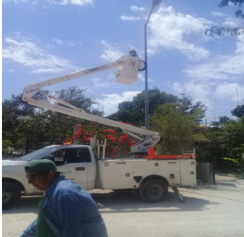
COL. YAAX TULUM, REHABILITACIÓN DE LAMPARAS (SE CAMBIO FOCOS TIPO AM-175W, Y BALASTROS AM-175W)
