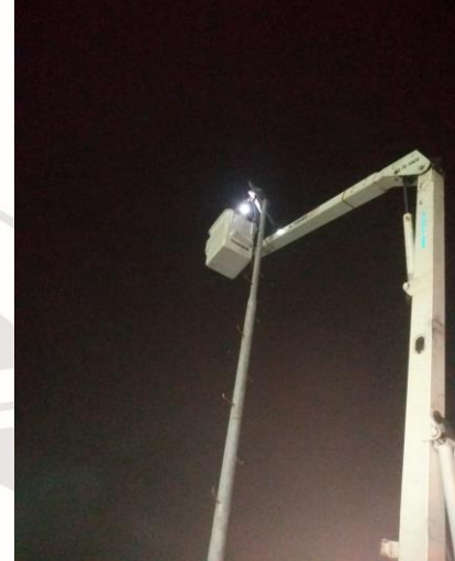
COMUNIDAD DE COBA , SE COLOCO UN REFLECTOR AM-1,000W, PARA LA ILUMINACIÓN DEL ESTACIONAMIENTO DE LAS RUINAS
