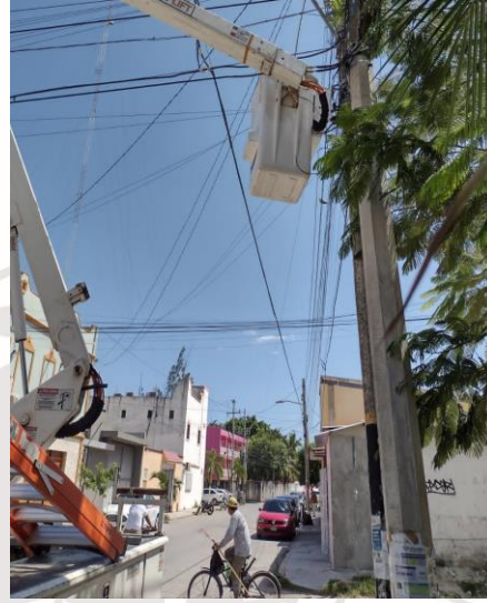
COL. CENTRO, CALLE SOL / CENTAURO Y ORIÓN, SE REHABILITA LAMPARA OV-15 (TIPO AM-175W Y BALATRO AM-175W)
