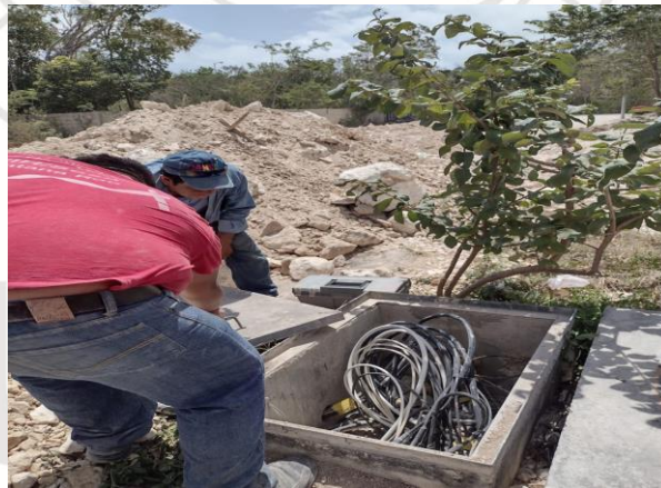
MANUEL ANTONIO AY, RECONEXIÓN DE LINEAS, YA QUE SE ENCONTRO CORTO CIRCUITO
