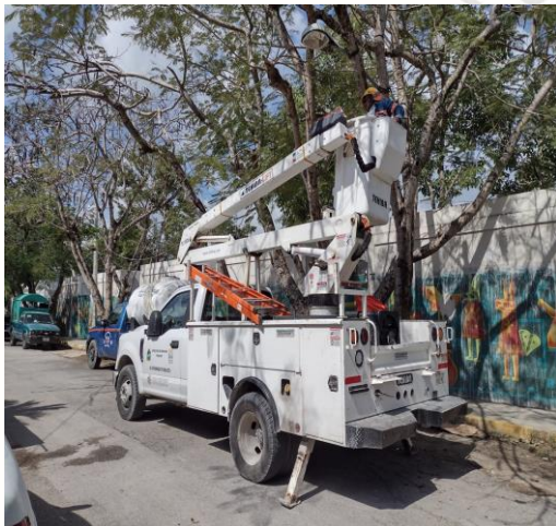
COL. CENTRO, CALLE ACUARIO / SATURNO Y SATURNO, SE REHABILITO LAMPARA OV-15, SE ÚTILIZO FOCO TIPO AM-175 Y BALASTRO TIPO AM-175
