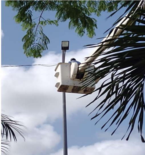
COL. YAAX TULUM, SE REHABILITO LAMPARAS (TIPO AM-175W Y BALASTROS TIPO AM-175W)
