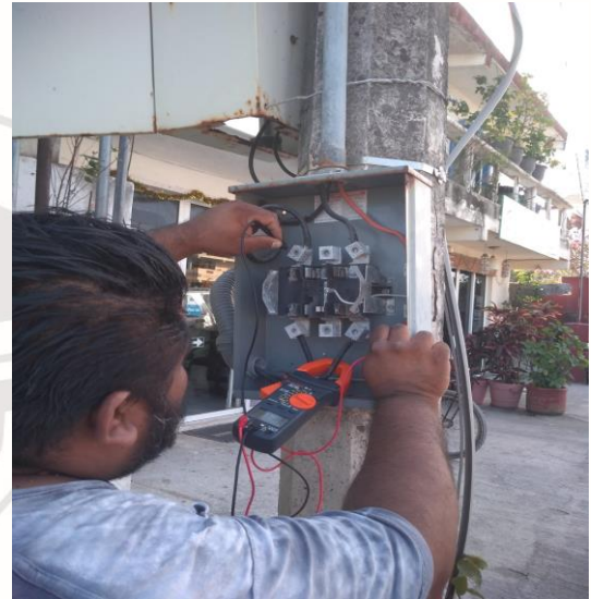
AKUMAL , SE ACTIVA SECTOR, CAMBIANDO FUSIBLE EN TRANSFORMADOR (3 KVA)
