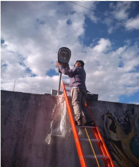
COL. VILLAS TULUM, CALLE 17 / CHEMUYIL, INTALACIÓN DE LAMPARAS REUTILIZADAS OV-15, AGREGANDO (AM-250W Y BALASTROS AM-250W)
