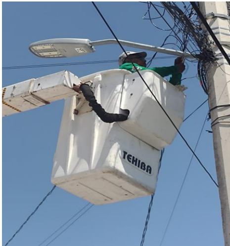
COL. LAKIM, CALLE GAMA OTE / ORION SUR Y CENTAURO SUR, MANTENIMIENTO DE LAMPARA DE 73W CON RECONEXIÓN DE LINEA SULFATADA
