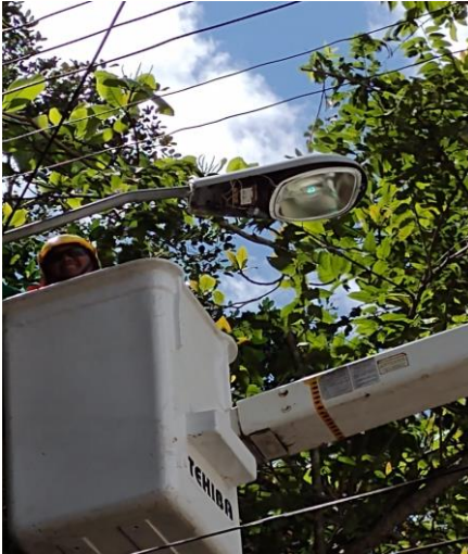
COMUNIDAD DE COBA , SE REPARA LAMPARA OV-15 (SE UTILIZARON FOCOS DE AM-175W, BASES DE FOTO CELDA Y FOTOCELDA DE 220V)
