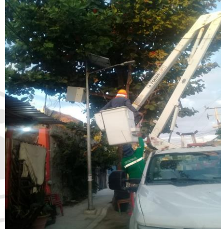
COL. CENTRO, CALLE SOL / CENTAURO, REALIZACIÓN DE RETIRO DE GABINETE METALICO PARA ACOMULADORES EN PANELES SOLARES.
