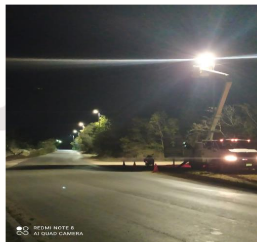
ZONA MAYA (SAN JUAN DE DIOS), SE REHABILITAN LAMPARAS OV-15 (AM-175W Y BALASTROS AM-175W) (BASE PARA FOTOCELDA Y FOTOCELDA 220V) M-175W, MÁS FOTOCELDA 220V)
