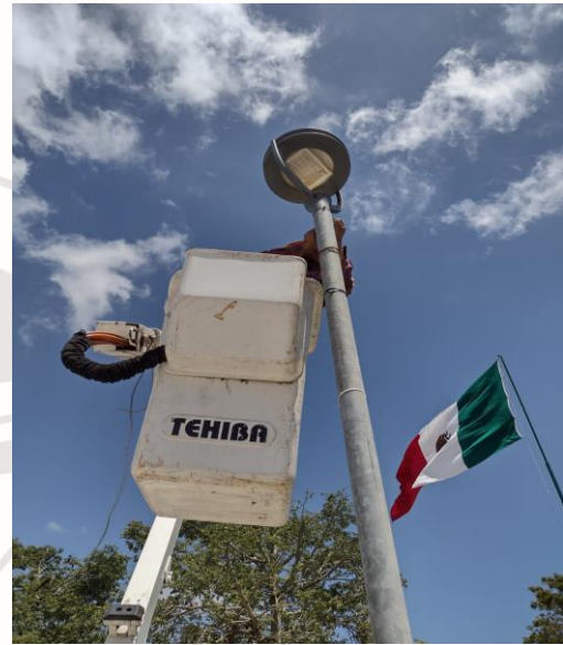
COL. CENTRO, AV OSIRIS / SOL Y AV TULUM , REHABILITACIÓN DE LAMPARAS (SE CAMBIARON FOCOS TIPO AM-250W, Y BALASTROS AM-250W)
