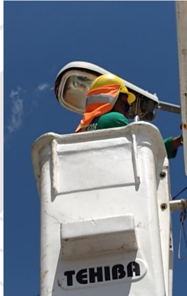
COBA, REHABILITACIÓN DE LAMPARAS (SE CAMBIARON FOCOS TIPO AM-175W, Y BALASTROS AM-175W, MÁS FOTOCELDAS 220V)
