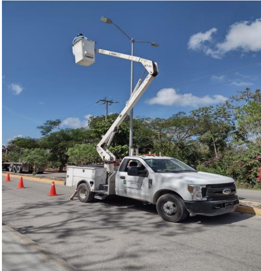
MACARIO GÓMEZ, REHABILITACIÓN DE LAMPARAS OV-15 (FOCO TIPO AM-175W, BALASTROS TIPO AM-175W, FOCOCELDA 220V, UNA BASE DE FOTOCELDA) (50 MTS DE CABLE CALIBRE 12)
