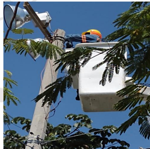
COL. VILLAS TULUM, YAX TULUM, CICLO VIA, 5 AV, REALIZACIÓN DE RECORRIDO DE ENCENDIDO DE SECTORES MANUALES
