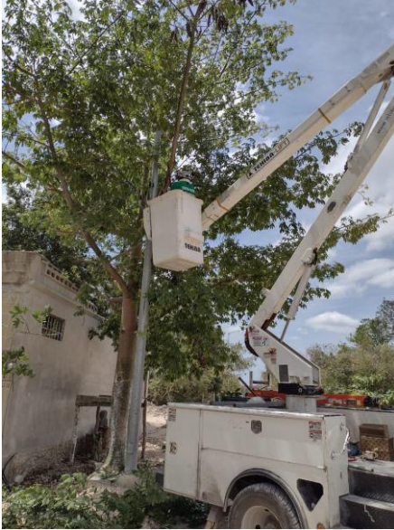
CICLOVIA, AV SATELITE, PARQUE DOS AGUAS, DEPORTIVO Y HOLISTICA, REALIZACIÓN DE RECORRIDO DE ENCENDIDO DE SECTORES MANUALES
