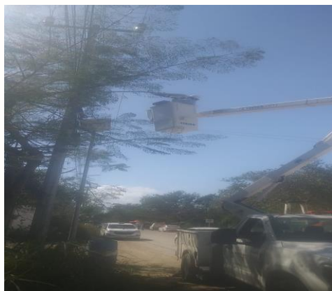
COL. VELETA, CALLE 12 / 7 Y 5, REHABILITACIÓN DE LAMPARAS OV-15, UTILIZANDO FOCOS TIPO AM-175W Y BALASTROS TIPO AM-175W MÁS UNA BASE PARA FOTOCELDA Y FOTOCELDA 220W
