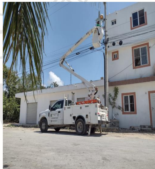
COL. TUMBENKA, CALLE 12 / 33, MANTENIMIENTO DE FOTOCELDA NUEVA 220V
