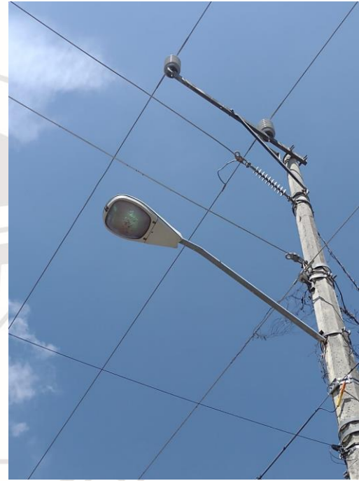
CICLOVIA, AV. SATELITE, PARQUE 2 AGUAS, UNIDAD DEPORTIVA Y 5 AV SUR, REALIZACIÓN DE RECORRIDO DE ENCENDIDO DE SECTORES MANUALES
