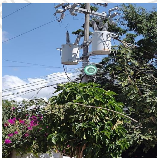
COL. CENTRO, CALLE SATELITE / NEPTUNO OTE, REALIZACIÓN DE RECORRIDO DE ENCENDIDO DE SECTORES MANUALES
