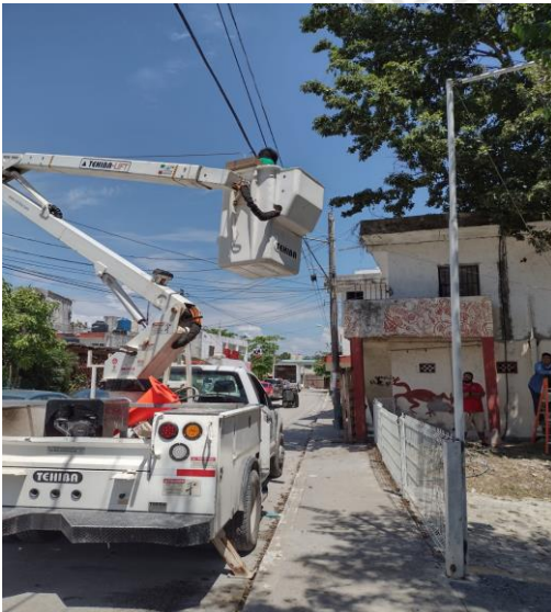
CHEMUYIL , SE RECONECTARON LINEAS AEREAS REVENTADAS (20 MTS UNIPOLAR CALIBRE 12)
