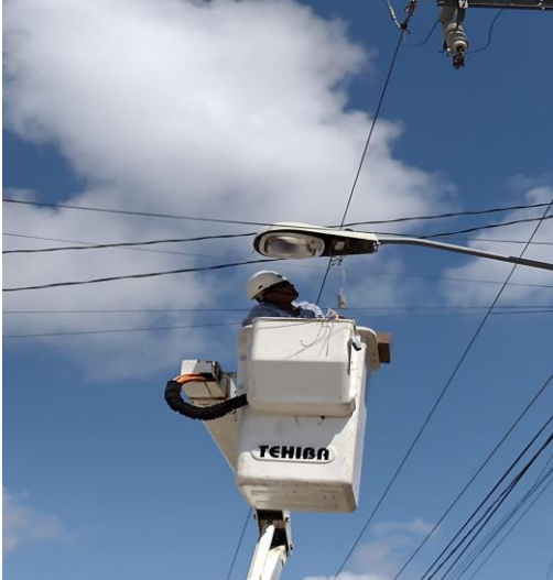
COL. TUMBENKA, CALLE 19 / YODZONOT, REHABILITACIÓN DE LAMPARA OV-15, (TIPO AM-175W Y BALASTRO TIPO AM-175W)
