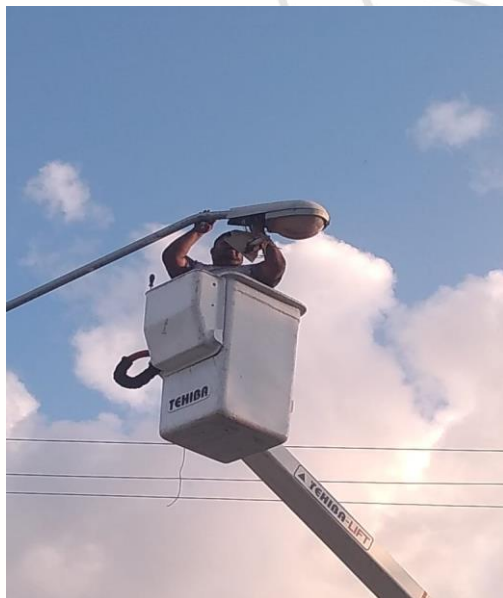
COL. TUMBENKA, CALLE 29 / AV YODZONOT Y AV 1, REHABILITACIÓN DE LAMPARA TIPO AM-175W Y BALASTRO TIPO AM-175W
