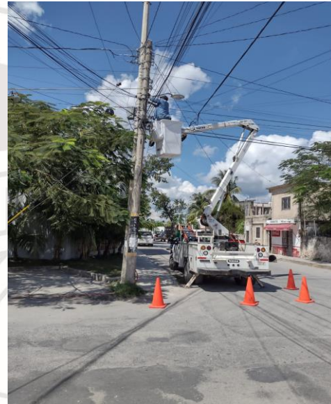
COL. CENTRO, CALLE ACUARIO / SOL Y MERCURIO SE UTILIZO FOCO DE AM-1000W, FOCO DE AM-400W Y BALASTRO DE AM-1000W. SE CAMBIO UNA CARCASA DE 400 WTS POR UNA DE 1,000 WTS.
