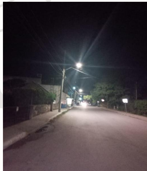
COL. VILLAS TULUM, YAAX TULUM, CICLOVIA, AV 5, ETC REALIZACIÓN DE RECORRIDO DE ENCENDIDO DE SECTORES MANUALES
