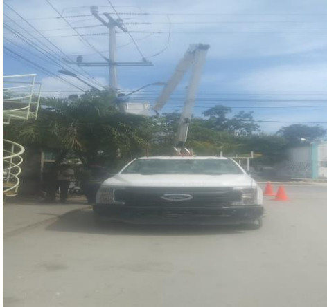
COL. LAKIM, CALLE NEPTUNO OTE / SOL OTE Y ANDROMEDA, REALIZACIÓN DE PODA DE ARBOLES PARA LIBRANSA DE LUMINARIAS TIPO COLONIAL
