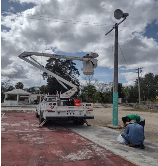
YAXCHE , REHABILITACIÓN DE REFLECTORES (REFLECTORES TIPO AM-1,000W Y BALASTROS TIPO AM-1,000W)
