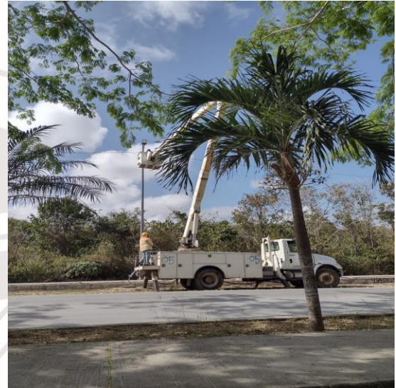
COL. FRACCIONAMIENTO LAS PALMAS, AV LA SELVA / AV 10 NTE, REHABILITACIÓN DE LAMPARAS (TIPO LED DE 100W, BRAZOS PARA LAMPARA TIPO OV-15) (TIPO AM-175)
