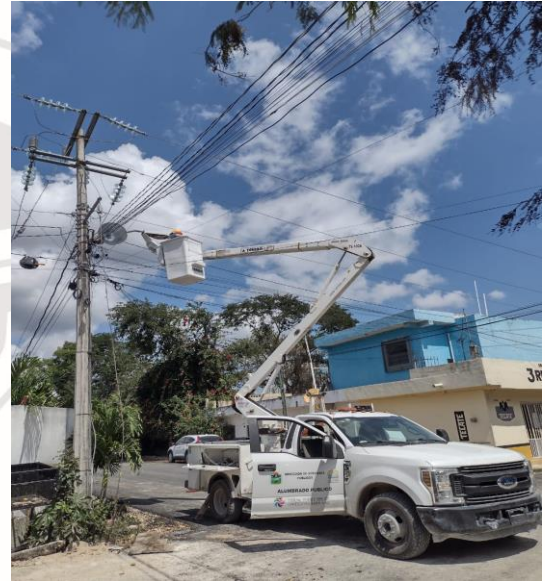
COL. CENTRO / BOD. DE ALUMBRADO, REHABILITACIÓN DE REFLECTOR TIPO AM- 1,000W CON BALASTRO REUTILIZADO
