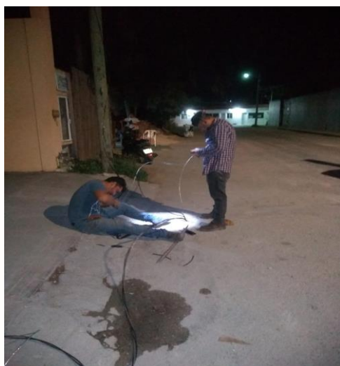
COL. CENTRO, C. SAGITARIO / ACUARIO NTE, RECONEXIÓN DE LINEAS BAJANTE EN CORTO CIRCUITO
