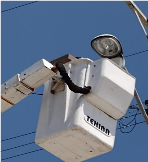
CHEMUYIL , REHABILITACIÓN DE LAMPARAS (SE CAMBIARON FOCOS TIPO AM-175W, BALASTROS TIPO AM-175W, UNO TIPO AN-1,000W, UN BALASTRO AM-1,000W) (BASES PARA FOTOCELDA Y FOTOCELDA 220V)
