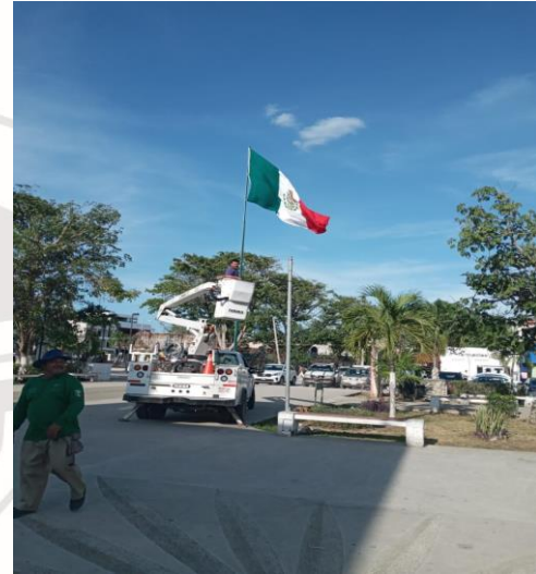
COL. CENTRO, ESPLANADA (PALACIO MUNICIPAL), SE REALIZO LA MODIFICACIÓN E INSTALACIÓN DE LAMPARA (TIPO COLONIAL AM-175W Y BALASTROS AM-175W) (20 MTS DE CABLE REUTILIZABLE)
