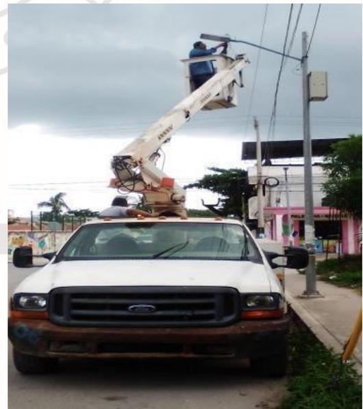
Se reemplazan luminarias quemadas por leds nuevas de 70 watts en calle Osiris Nte entre calle 4 Ote y calle Tunkul.
