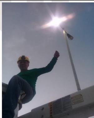
Cambio de luminarias por luminarias tipo led de 150w en la Av. Tulum con Av. Cobá.
