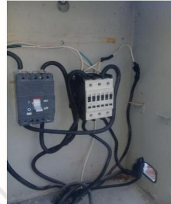
Se cambia interruptor dañado de la marca bticino por uno de 100 amp se cambia los puentes del contactor al break por el calibre #4 colonia centro Av. Satélite y Venus Ote.
