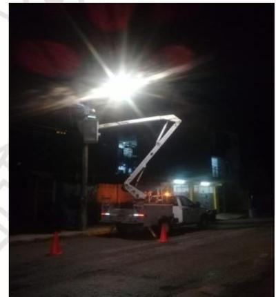
Reconexión de línea sulfatada de luminaria led de 73w en la colonia Maya Pax calle Tun Kul con Orion Nte.
