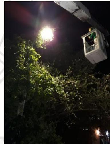
Reconexión de líneas principales sulfatadas de luminarias tipo led de 73w y poda en la colonia la Croc calle Gama Ote entre Géminis Sur.
