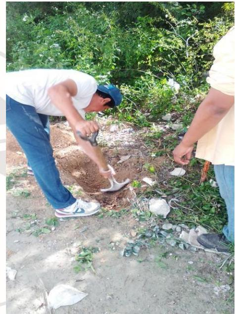
Se revisa, ubica y repara corto circuito en líneas subterráneas. Se instala cables y tubería nueva. Kuuk entre Kooh y 2 Nre Bis. Col Xulka.
