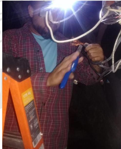
Se detectó sector apagado en Cancha Maya, el contactor no activaba quedando manual y se cambió una luminaria de 1000w en la colonia Centro calle Acuario entre Júpiter Sur
