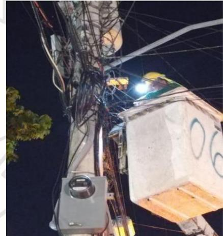
Reconexión de líneas sulfatada en luminaria tipo led de 73w colonia Centro calle Alfa Sur y Av. Tulum.
