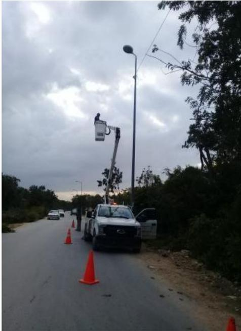
Cambios de luminaria a tipo led de 150w en la colonia Yax Tulum con Av. La Selva con 10 Nte Bis y la 15 Nte.
