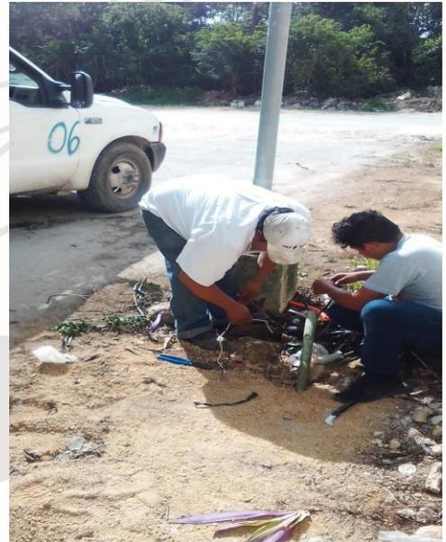
Reparación de líneas subterráneas reventadas por maquinaria y se le instala registro.
