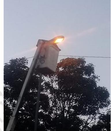
Cambio de fotocelda dañada y reposición de luminaria en la Av. La Selva con calle 28.
