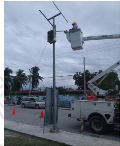
Se reemplazan lámparas quemadas por lámparas leds nuevas en colonia Centro entre Beta y Osiris Nte.
