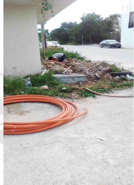
Se reemplazan líneas subterráneas dañadas, se le coloca poliducto nuevo y se activan luminarias apagadas. Calle 20-A entre calle 25 y calle 27 de la col Tumben Ka.
