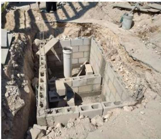
Fig. 1. Muro de block y castillos
