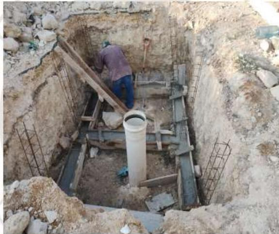
Fig 1. Colado de cadena de desplante y anclado de Armex
